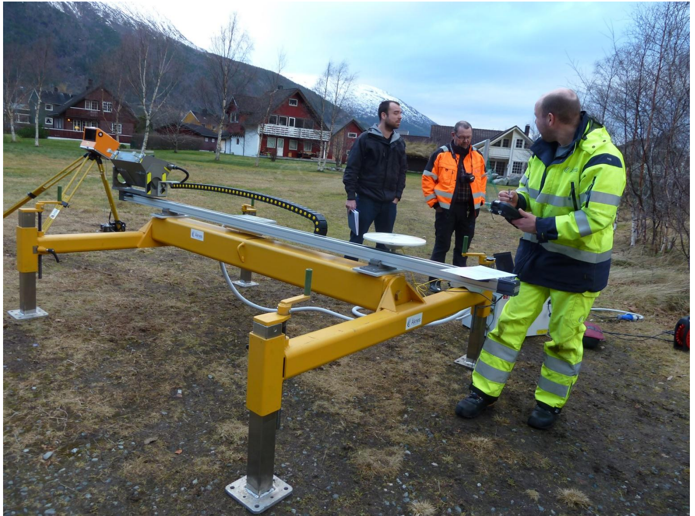
FIGUR 3 STÅLFUNDAMENT, SOM SKAL BRUKES TIL AKUTTMÅLINGER. POSISJON OG RETNING BLIR MÅLT MED DIFFERENSIAL GPS. LASERSKANNEREN (ORANSJE) STÅR PÅ TREFOT VED SIDEN AV RADAREN.
