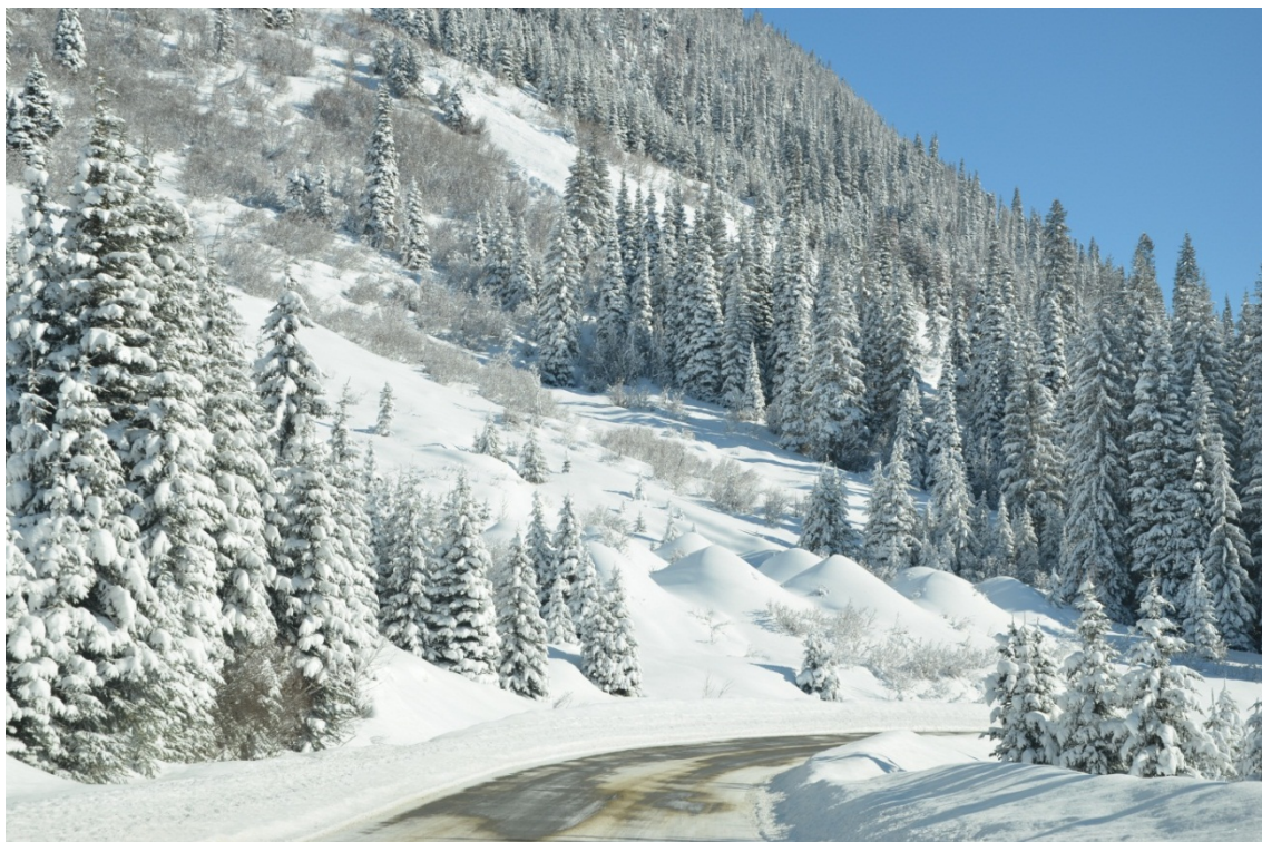
Figur 13 Kjegler som permanent sikringstiltak i utløpsområdet til et skredløp (Foto: Tore Humstad)
