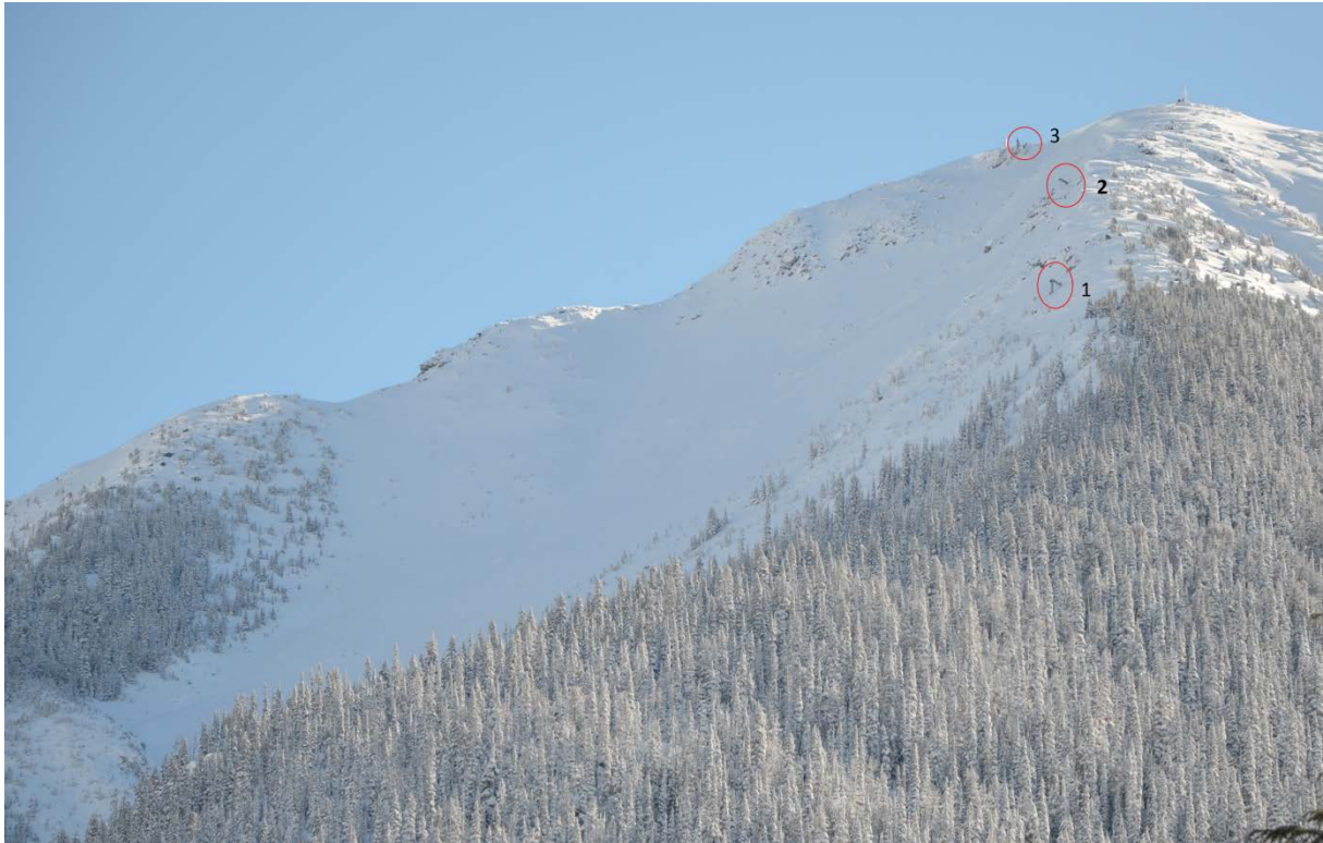
Figur 9 Det finnes 3 gassrør installert i dette løснеområdet. Dagen før dette bilde ble tatt ble det forsøkt å sprengne ned skred fra dette løснеområdet uten at de store skredene løsnet. Det ble sprengt fra gassrørene i rekkefølgen 1, 2 og 3. Bilde er tatt fra et skredløp ved Duffey Lake. (Foto: Tore Humstad)
