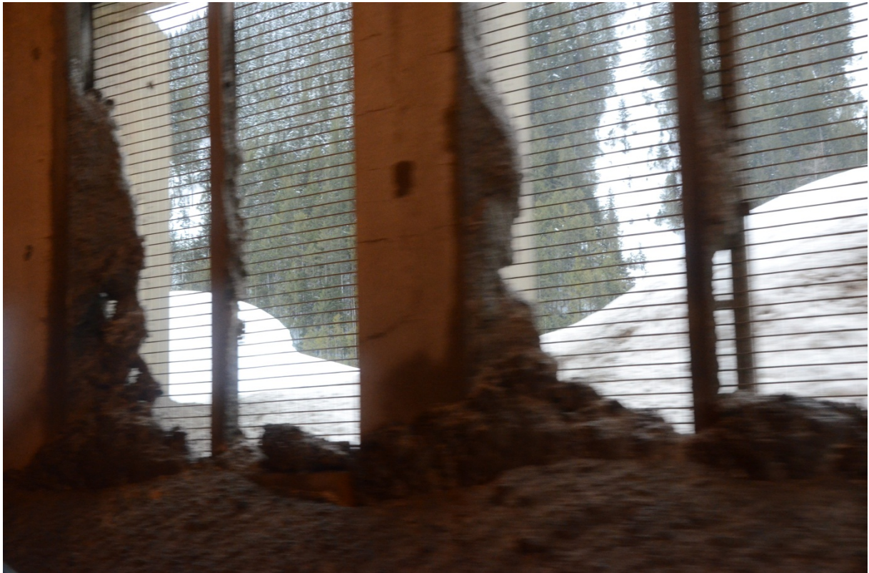
Figur 16 Viser gitteret som er satt opp mellom søylene for å hindre at skredmassene trenger inn overbygget (Foto: Tore Humstad)
