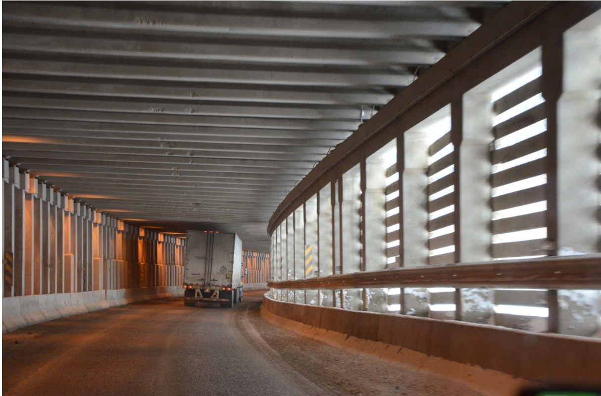
Figur 17 Viser et overbygg der det er satt opp horisontale betongelementene mellom søylene for å hindre at skredmassene trenger inn i overbygget. Overbygget har gode lysforhold noe som øker trafikksikkerheten og kjøreopplevelse (Foto: Tore Humstad)
