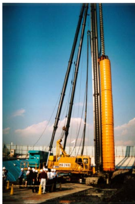
Figur 2.4: Viser Japansk utstyr for våt metode fra byggeplass i Tokyo. Maskinen har to visper. Foto NGI.
