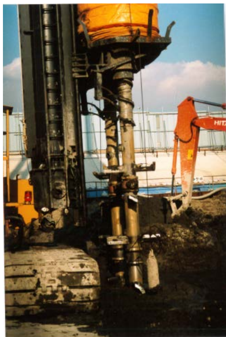
Figur 2.4: Viser Japansk utstyr for våt metode fra byggeplass i Tokyo. Maskinen har to visper. Foto NGI.
