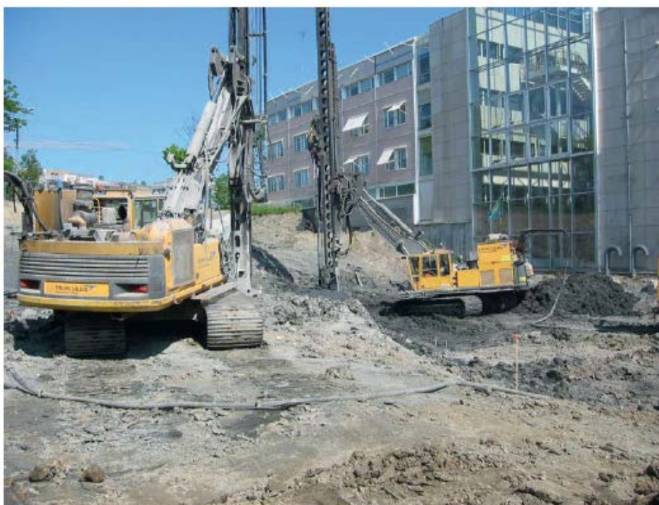
Figur 3.1: Viser kalksementpelmaskiner som stabiliserer i naturlig skråning med kvikkleire (2000 – tallet). Foto NGI.
