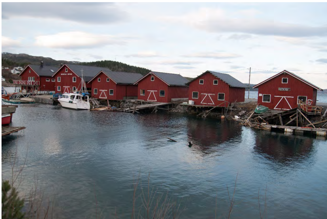
Figur 16: Rorbuene ved Saltbuodden hvor fire av bryggene ble totalt ødelagt. Kai i betong som ligger på motsatt side av rekken av rorbuer sees helt i venstre bildekant.
