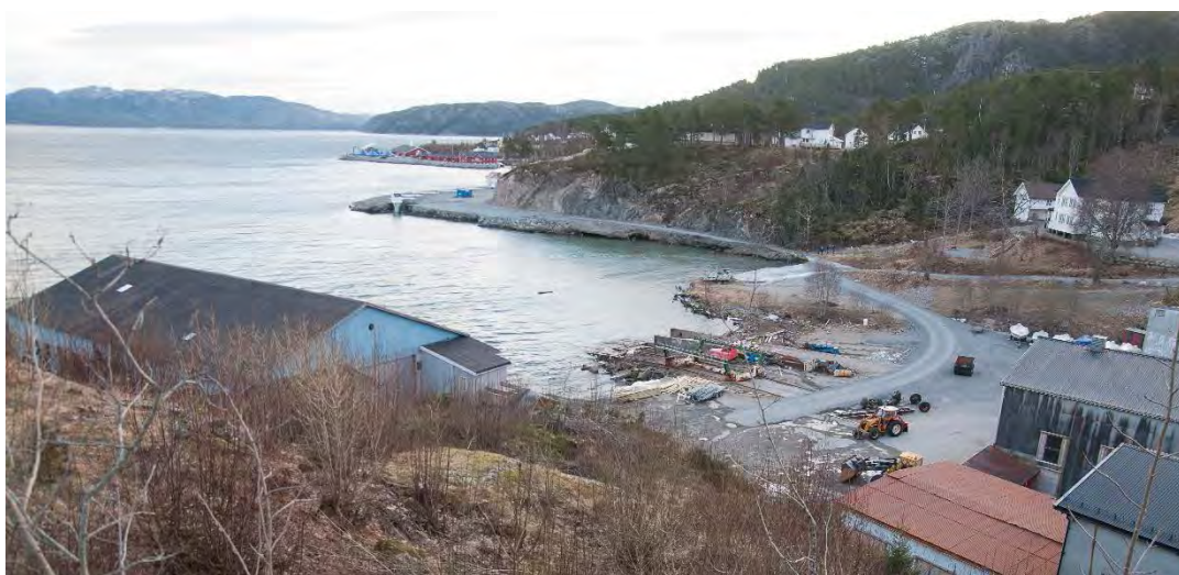
Figur 2: Oversikt over skredområdet og østre del av Sagvika. Oppskyllingen på den flate plassen utenfor snekkeriet kan lett sees foran maskinene i nedre del av bildet (mørk grus).
