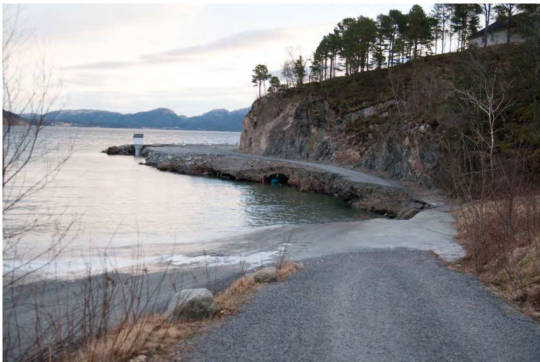
Figur 3: Skredområdet sett mot øst. Vannlekasje kan sees som is på veien.
