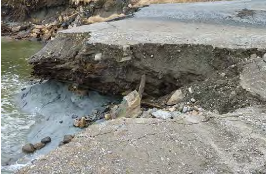
Figur 2.4: Illustrasjonsbilde – flis og bark under mineralisk fylling i Sagvika. I grått skimtes leire. Foto: NVE v/Einar Lyche
