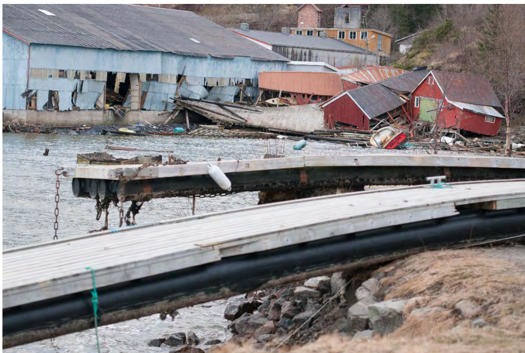
Figur 8: Sagvika med snekkeriet (blått bygg), ødelagte naust, og flytebryggene til småbåthavna som er avsatt på land. Bildet tatt fra butikken mot sørøst.
