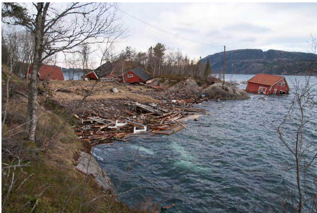
Figur 10: Ødelagte naust ved Kvalvikskjæret NV for Sagvika.
