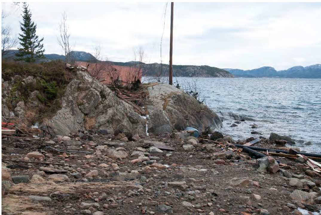
Figur 11: Tang i trærne på Kvalvikskjæret. Naust i bakgrunnen er delvis dratt ut i sjøen. Det var ved dette naustet det var observert en ett tonn tung stein som flodbølgen hadde dratt med seg opp på grunnere vann.
