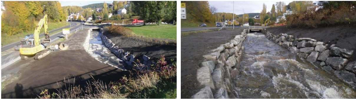
Figur 37 Ombygget elveløp mellom Kirkegata og Sauheradvegen (Foto: Eirik Traae).
