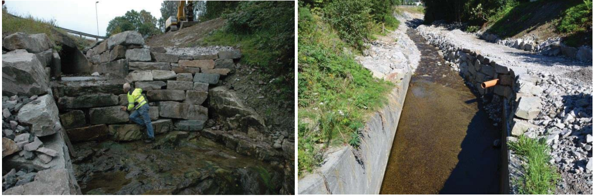
Figur 28 Venstre: Ombygget utløp av kulvert under E134 nedstrøms Høybødalen. Høyre: Erosjonssikring av elvestrekningen øverst i Hvåladalen og inn mot kulverten under Tinneveien (Foto begge: Eirik Traae).
