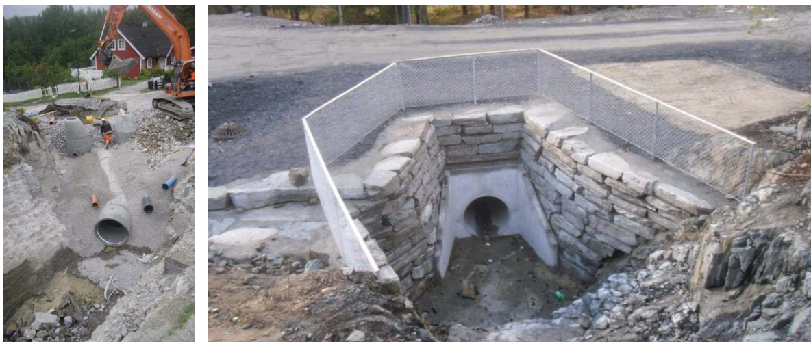
Figur 19 Røret som skal fungere som flomløp (Foto: Eirik Traae).
