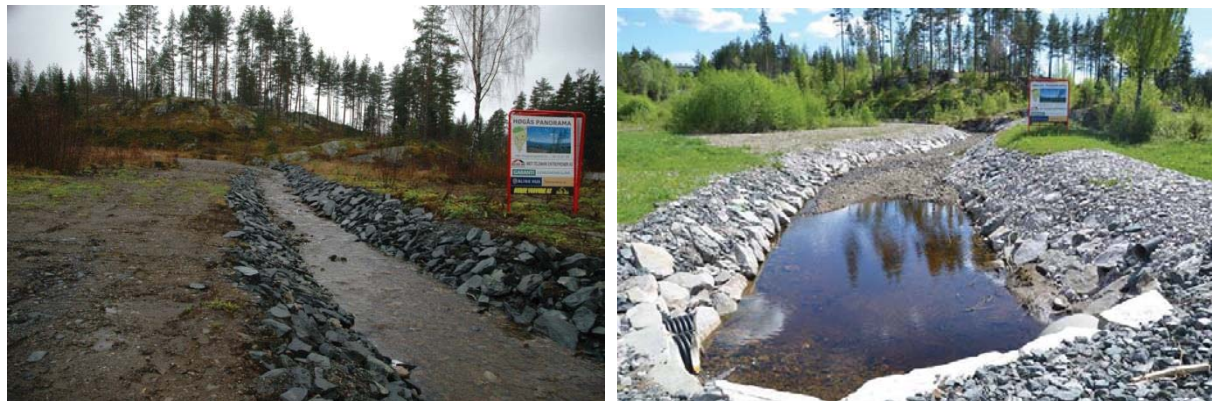
Figur 8 Venstre: Bekk fra Høgås like oppstrøms E134. utfordringer med stor masseavlagring som tetter kulverter under E134. Høgre: Ombygget elveløp like oppstrøms E134. Massebassenget fungerer meget bra (Foto begge: Eirik Traae).
