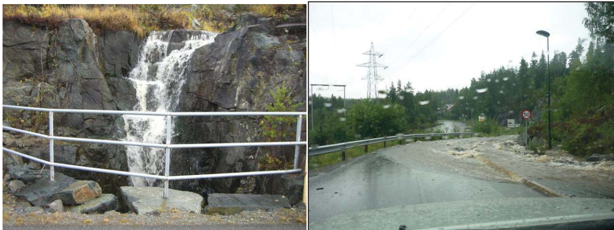
Figur 15 Venstre – Fjellveggen der Surtetjønnbekken går under Framkåsvegen (Traae, 2011). Høyre - Surtetjønnbekken flommer langs Framkåsvegen (Foto: Notodden kommune).
