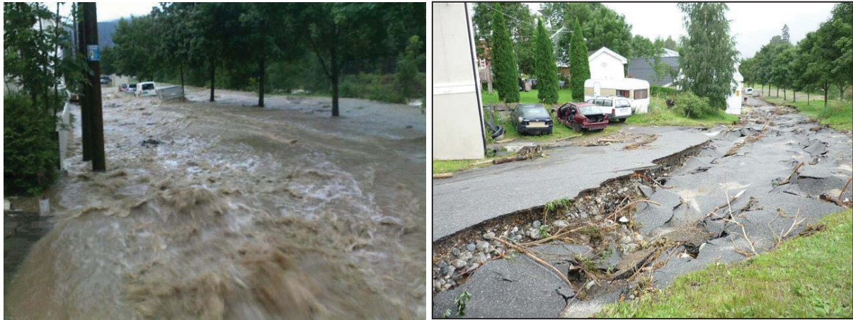
Figur 31: Flomskader i Hvaladalen (Foto: Notodden kommune).
