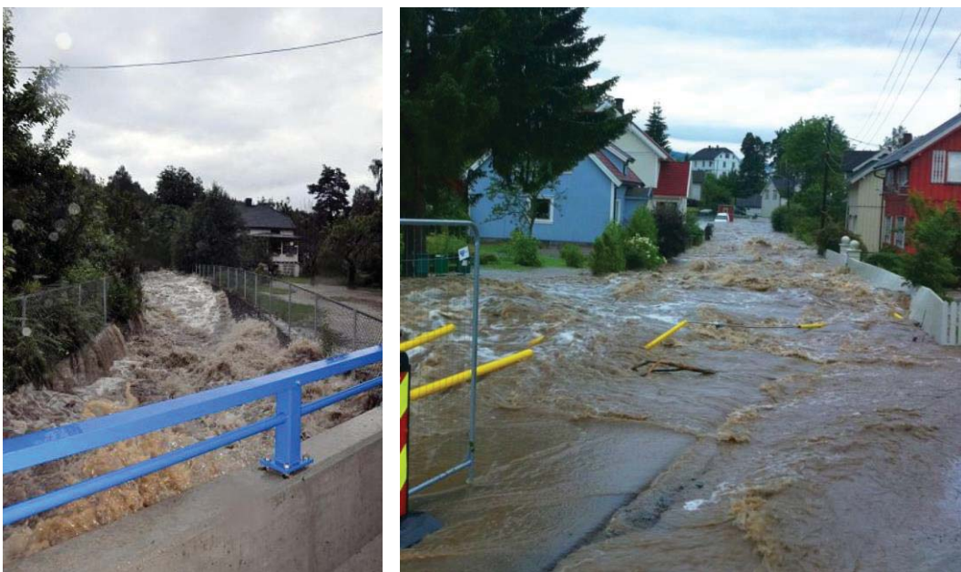
Figur 21: Venstre: Vegbru over Grotbekkvegen. Høyre: Grotbekkvegen (Foto begge: Telen).
