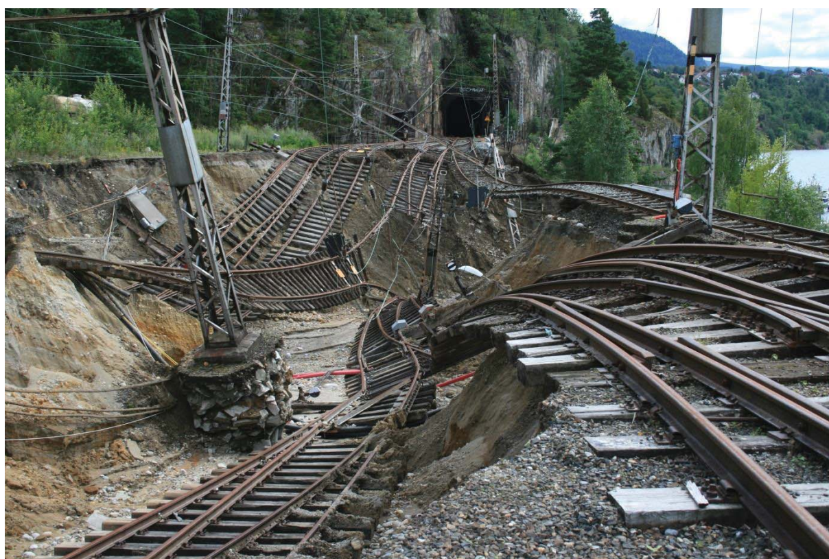
Figur 35 Det ble enorme materielle skader på jernbanestasjonen på Notodden. Bildet viser området med sporvekslere som ble vasket bort (Foto: Pål Buskum).
