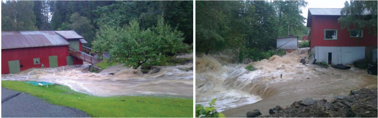
Figur 12: Setrebekken flommer over ved Grotbekkvegen 28 (Foto: Privat).
