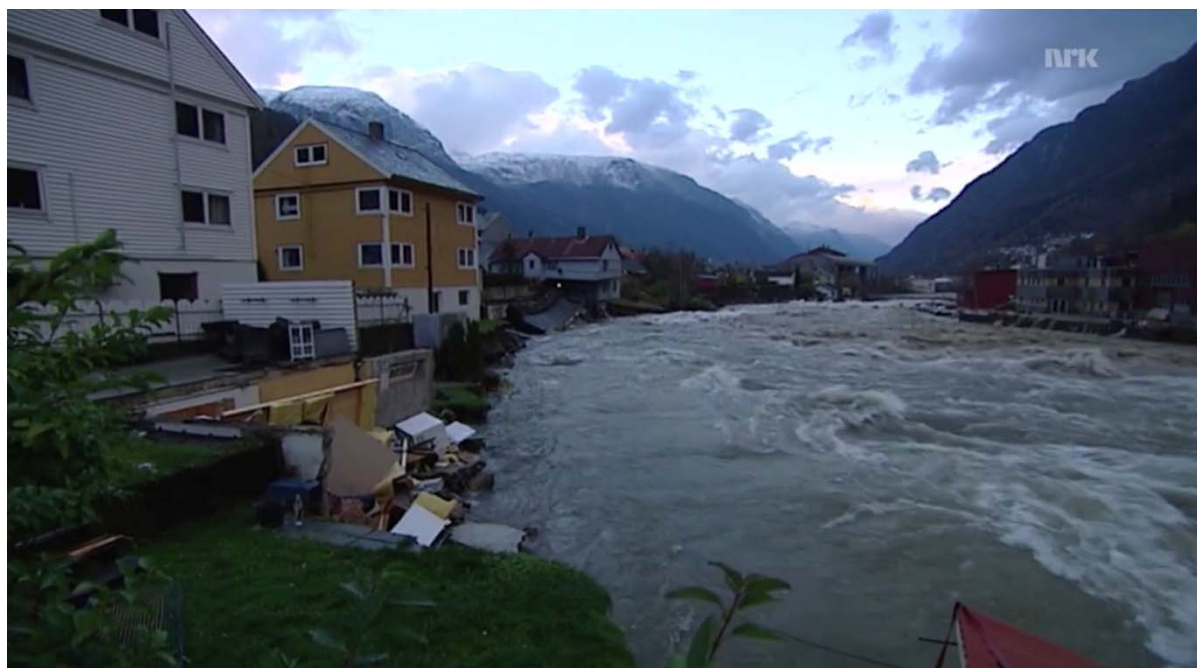
Figur 2 Det flaumråka partiet i Opovegen, der tre bustadhus vart tatt av elva. Vi ser restane av Opovegen 13 i framgrunnen, medan nr.9, som låg på utsida av det gule huset, er heilt vekke. Restane av Opovegen 5 lengst bak. Foto: NRK Hordaland.
