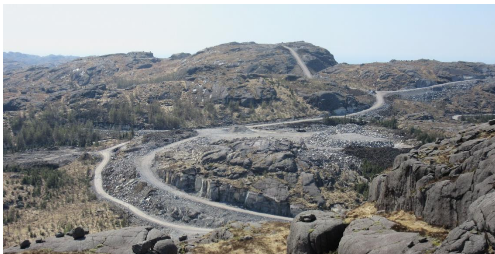
Figur 11: Anleggsfase i Bjerkreim vindkraftverk. Foto: SveinulfVågane.
