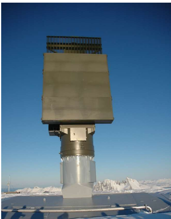
Figur 2. Sindre II radar. Foto: Terje Barthol森, Forsvarsbygg
