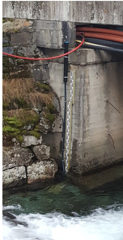
Figur 6 Målepunkt i Hemsedal etablert i 2017. Foto: NVE
