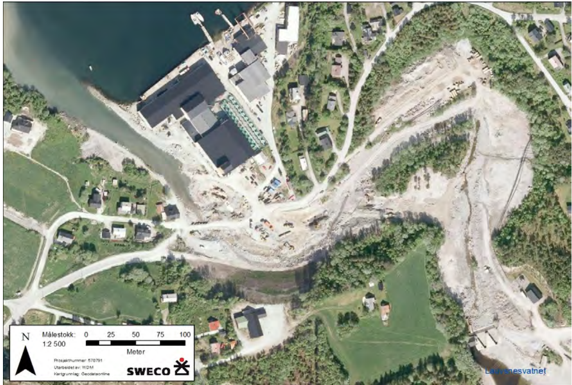
Figur 2-5 Flybilde med skader fra flommen 2006
