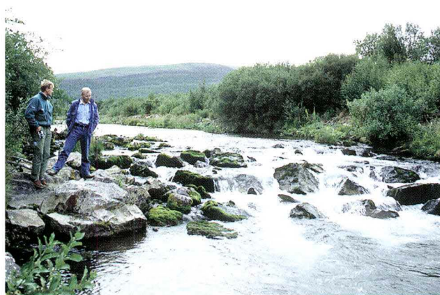
Gammel løsmasseterskel fra 1960-årene i Hanaelva, Østertana. Terskelen er en av de første som ble bygd (foto: Jon Arne Eie).
