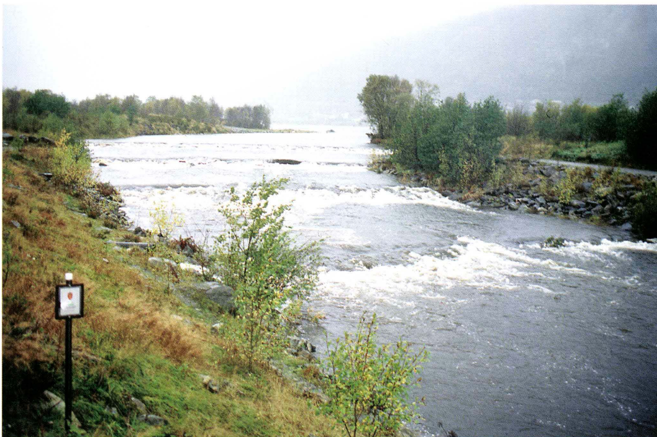
Terskler i Hareidselva ved Grimstadvatnet. Tersklene ble bygd for å hindre senkning av det vernede Grimstadvatnet og dets rike fugleliv da elva skulle kanaliseres av hensyn til landbruket (foto: Jon Arne Eie).
