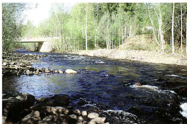
Biotopiltak i Letjenna i mai 1993. Midt på bildet ses en utgravd kulp og strømkonsentratorer ovenfor og nedenfor som skaper strykpartier (foto: Jon Arne Eie).
