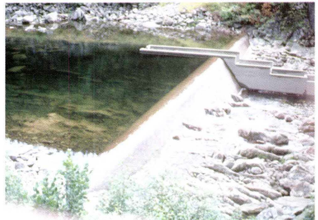
Betongterskel med fisketrapp i Mandalselva, august 1983 (foto: Knut Ove Hillestad).
