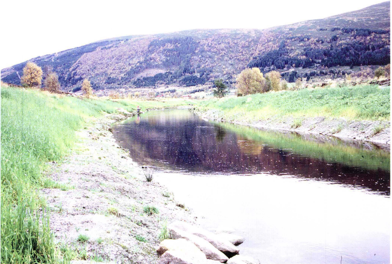
Den kanaliserte elvebredden har "trappeform" for å gjøre elva mer tilgjengelig for fiske både ved lav og høy vannstand. På venstre side av elva er det anlagt en fiskesti til bruk ved lav vannføring. Ved høy vannstand holder fiskerne seg oppe på vollen. Elvebredden er tilsådd. Hareidselva, oktober 1985 (foto: Jon Arne Eie).
