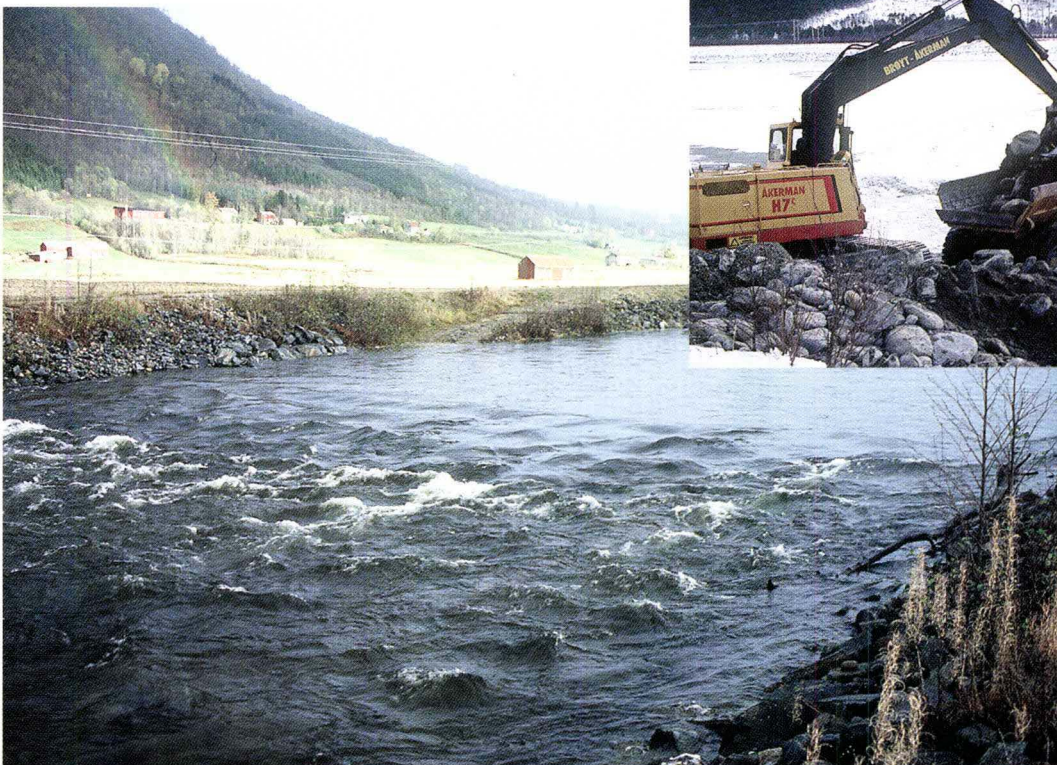
Utlegging av steinrøyser på Lesjaleirene vinteren 1990 (foto: Jon Arne Eie).
