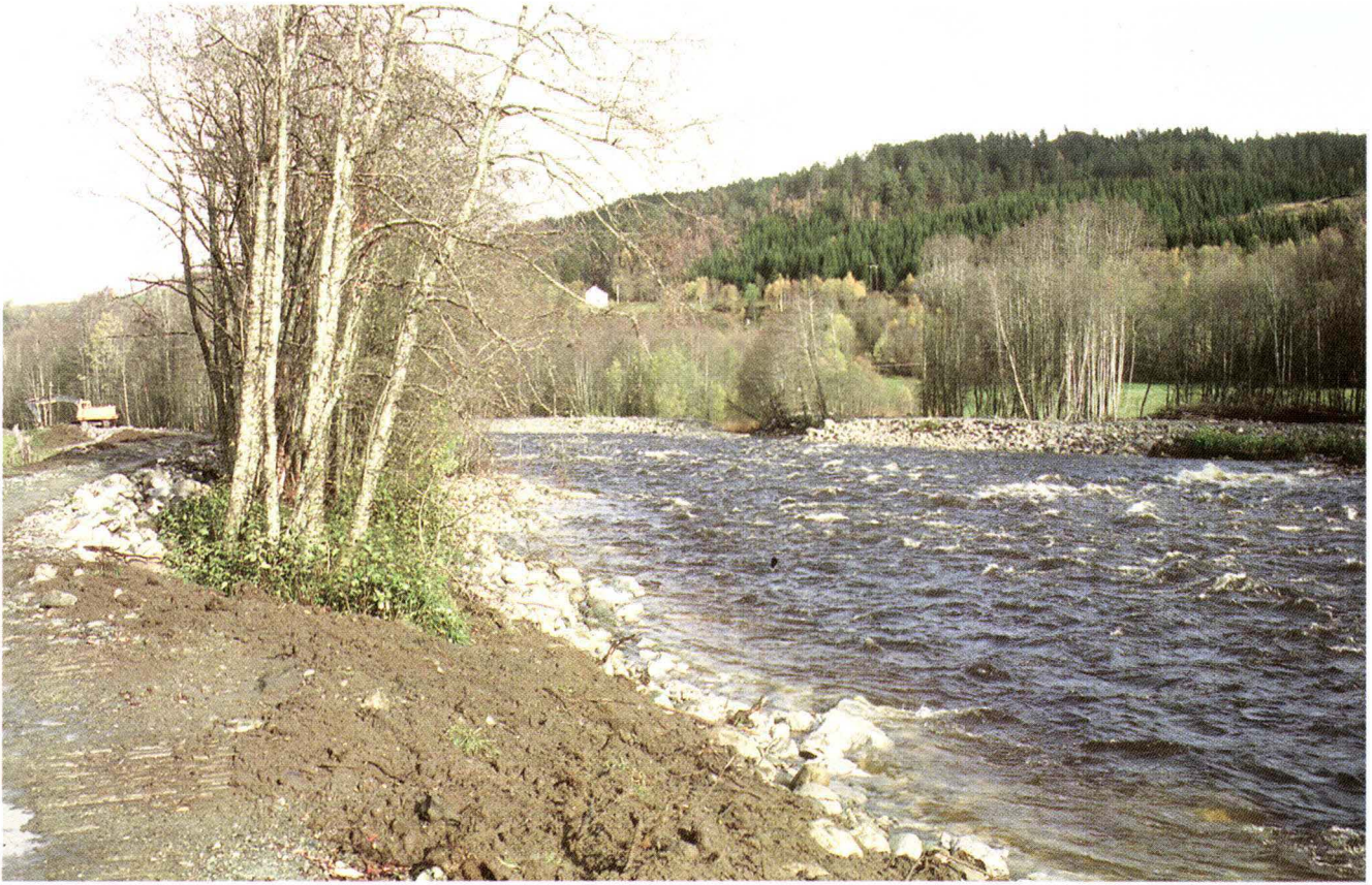
Forbygningvull i Surna. Til venstre i bildet ses vollen som skal hindre oversvømmelse av dyrket mark. Vollen er trukket tilbake for å kunne beholde kantvegetasjonen. Det er kjørt på jord for å hjelpe på etableringen av ny kantvegetasjon. Intakt kantvegetasjon er viktig for tilførsel av organisk materiale til elva, og dermed for produksjonen av næringsdyr i vassdraget. Oktober 1992 (foto: Jon Arne Eie).
