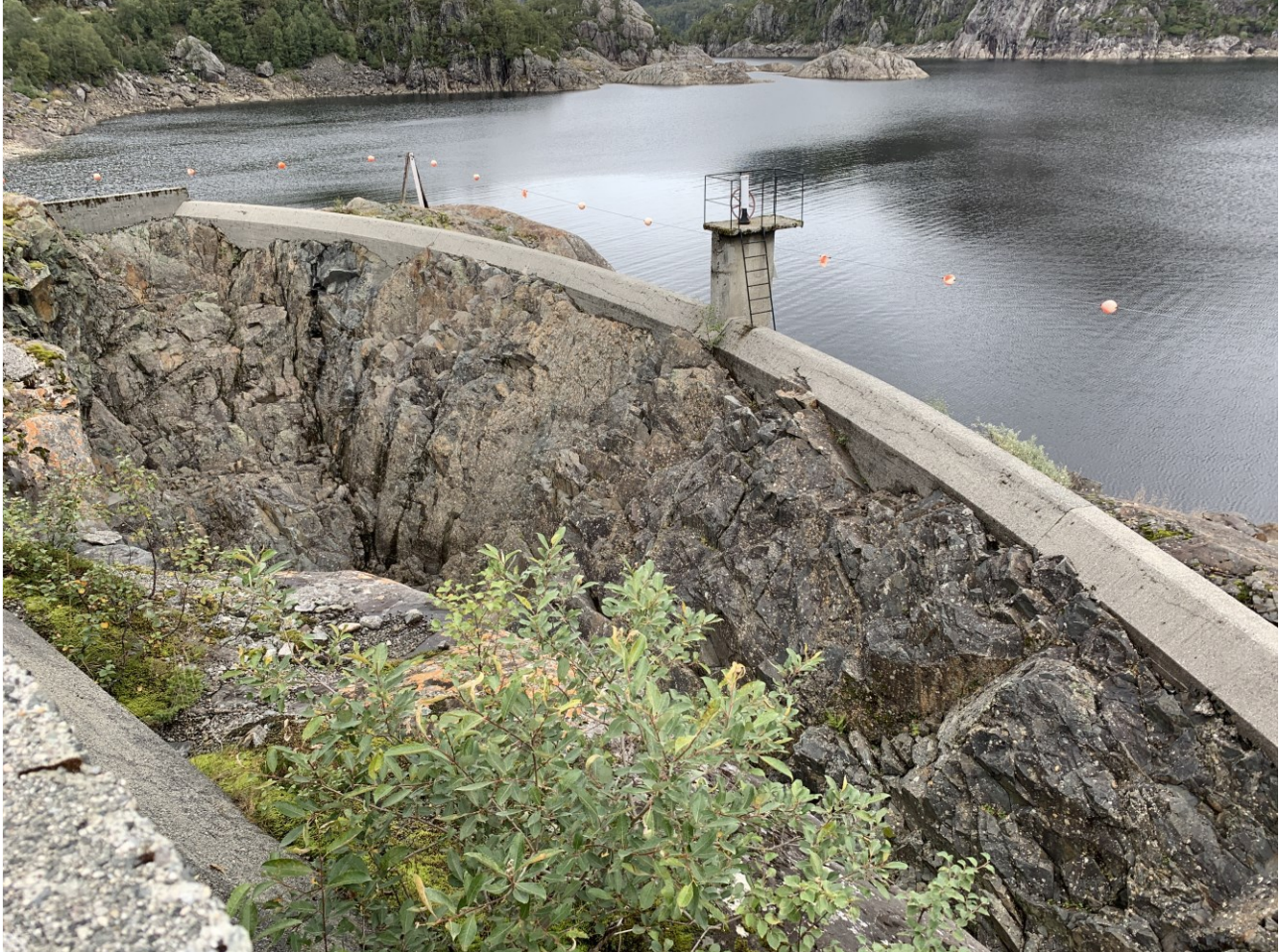
Figur 7-23: Foto av flomløpet til Staffivatn. Overløp og samlekanal (Multiconsult, 2021).
