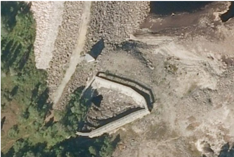
Figur 4-13. Flomløpet ved dam Vasslivatnet før ombygging
