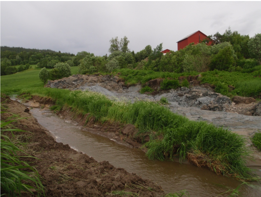
Figur 2 Nytt midlertidig elveløp gravd ut foran skredet
