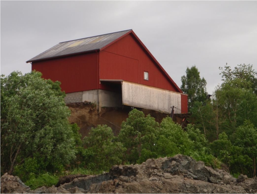
Figur 3 Bakre skredkant og oppstuvning av leirmasser i fronten
