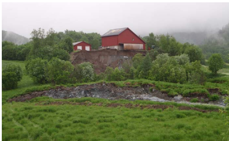
Figur 3 Skredet sett forfra (fra vestsiden av elva)
