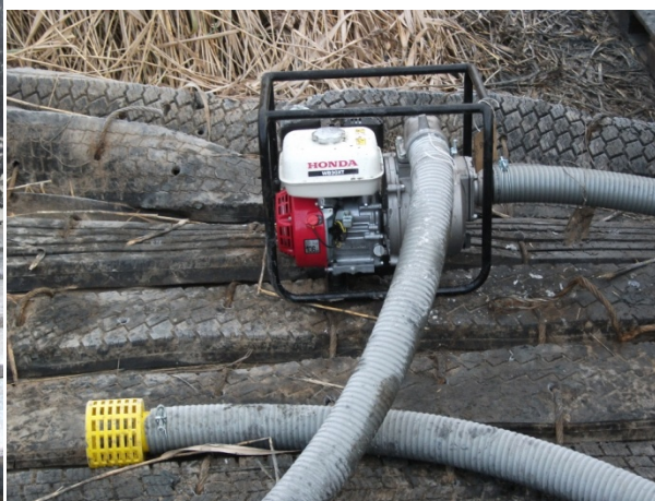
Bilde 7 Sugepumpe til pumping av dispergert leire
