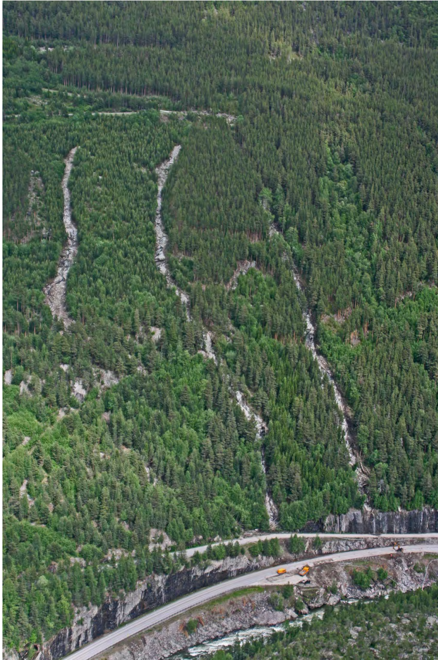
Figur 4: Store skader på E6 grunnet flomskred og erosjon ved Rosten i Gudbrandsdalen i juni 2011. Her har oppryddingsarbeidet startet, men arrene etter tre skred er godt synlige (Foto: A.T. Hamarsland, NVE).
