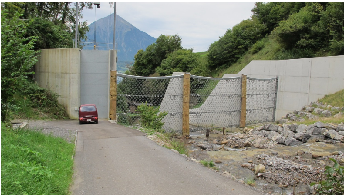
Figur 71. Bilde av sikringsiltaket oppstrøms, bilporten til venstre i bilde (Foto: Audun Langelid)
