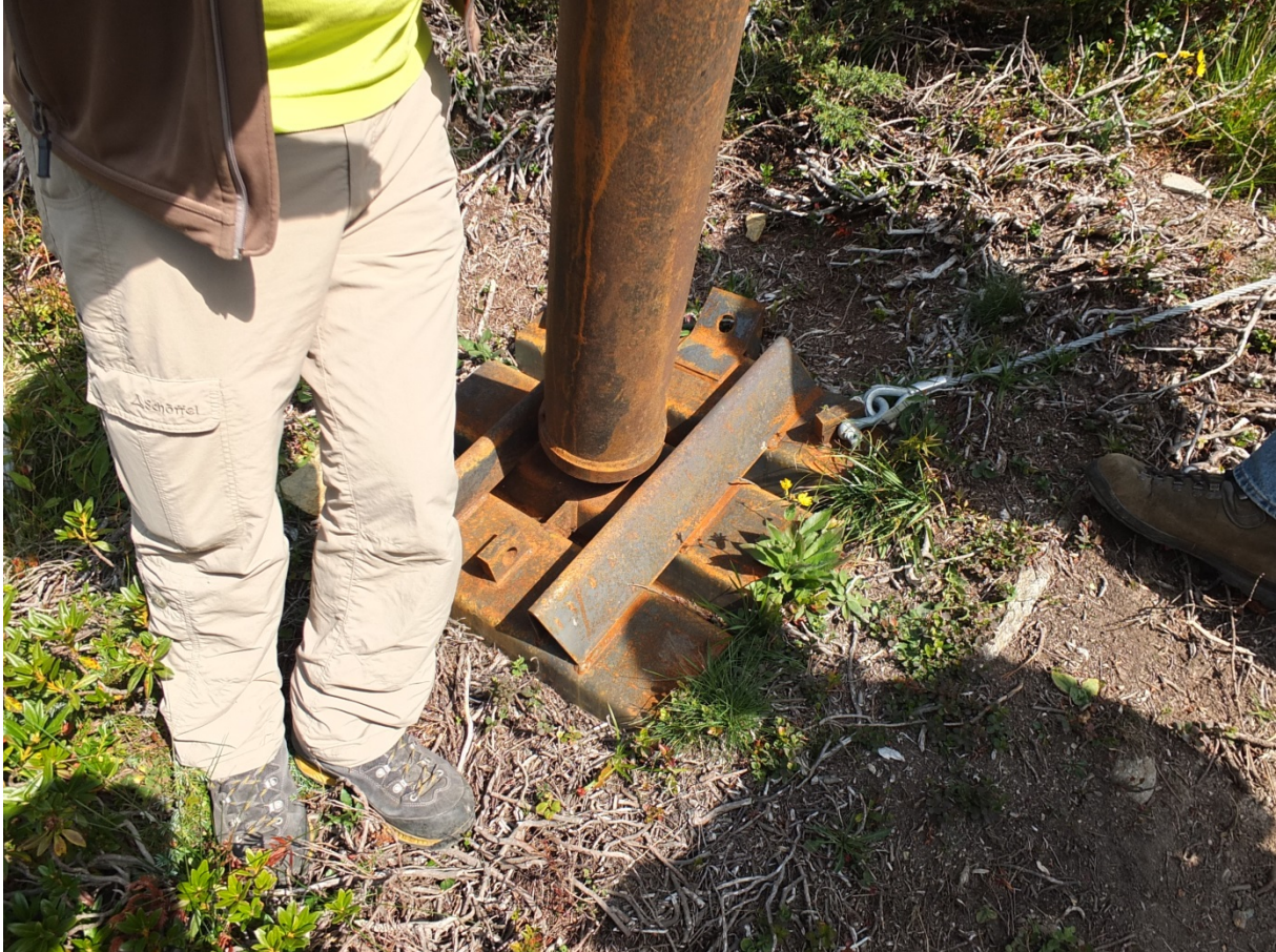
Figur 51. Fundamentplata til gjerdestolpene ikke er forankret i fjell, men er naglet fast til jorda ved vekten til stolpene (Foto: Audun Langelid)
