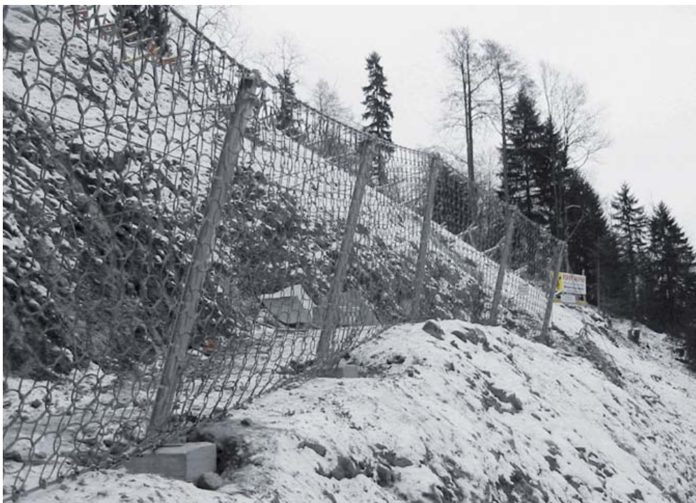
Figur 25. Her er et fanggjerd satt opp både mot steinsprang og mindre snøskred (Foto: Geobrugg)
