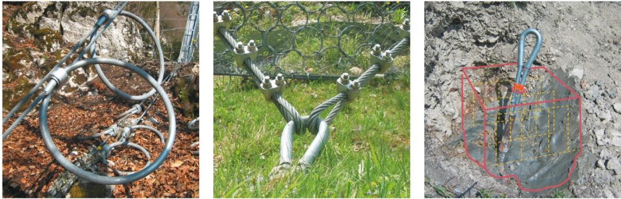
Figur 10. Fra venstre: bremsering, wireanker og selvboret stag med et fleksibelt hode (Foto: Geobrugg)
