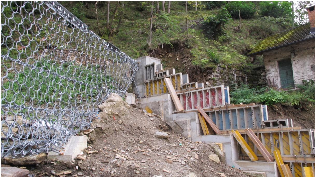
Figur 38. Det er støpt store betongklosser for å få god forankring i løsmassene (Foto: Audun Langelid)
