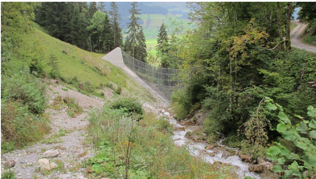
Figur 69. Det er stor lagringskapasitet bak gjerdet (Foto: Audun Langelid)
