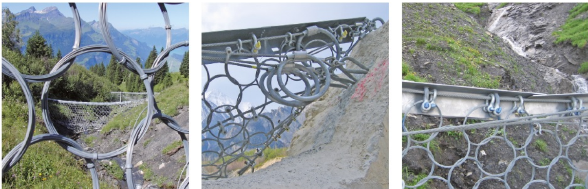
Figur 16. Fra venstre: Rocco ringnett, bremseringer, beskyttelse av bærewire (Foto: Geobrugg)
