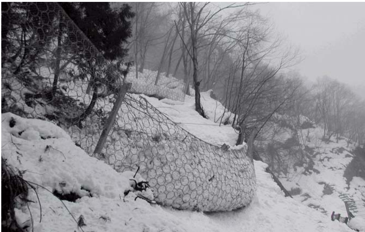
Figur 24. Her har et fanggerde stoppet et mindre glidende snøskred i Hayato, Fukushima i Japan (Foto: Geobrudd)
