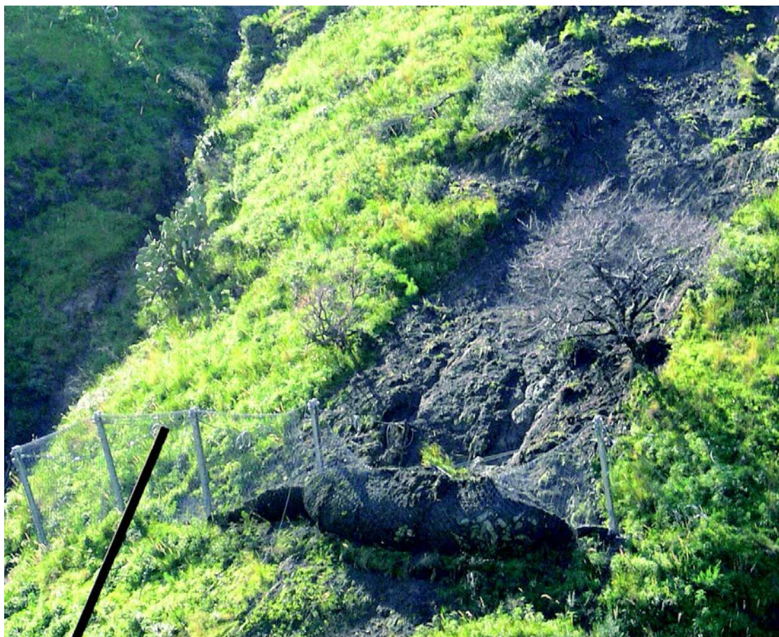
Figur 18. Geobrugg leverer fanggjerdene som er utviklet for å fange opp mindre/grunne jordskred (Foto: Geobrugg)
