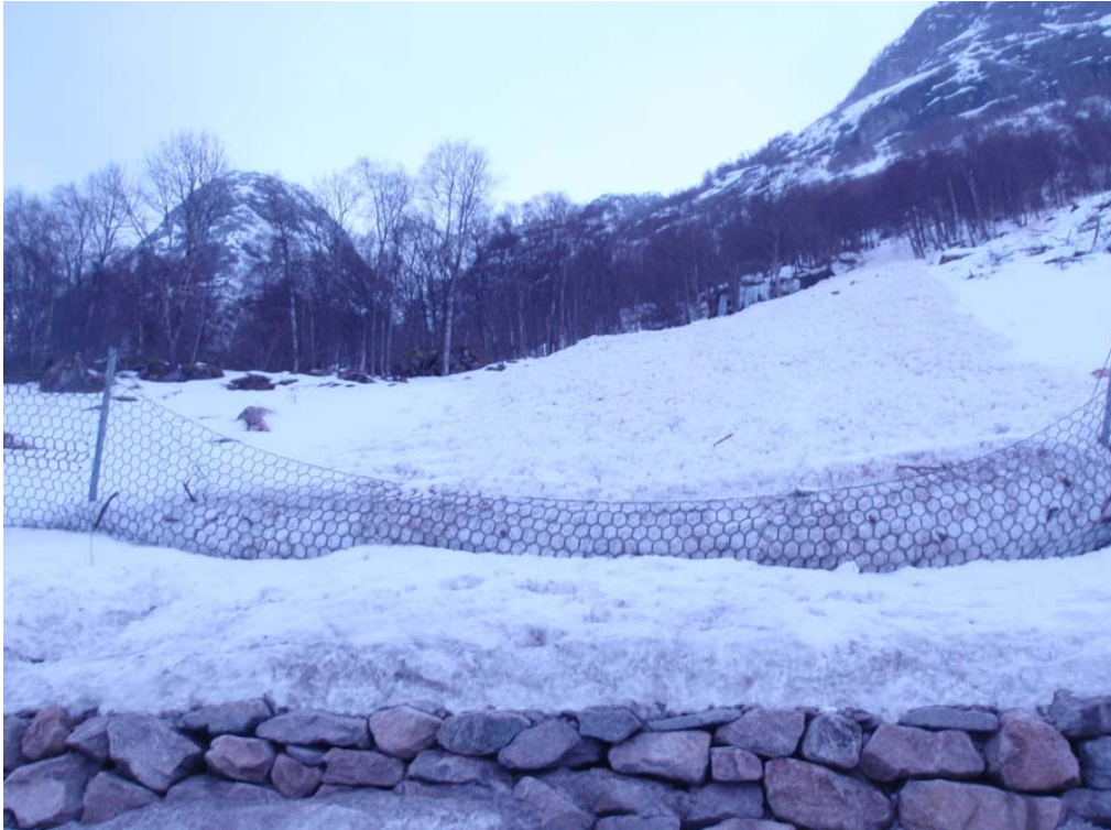
Figur 83. Skredmasser har fylt opp gjerdet og knekt 2 stolper (Foto: Kristian Kjesbu)
