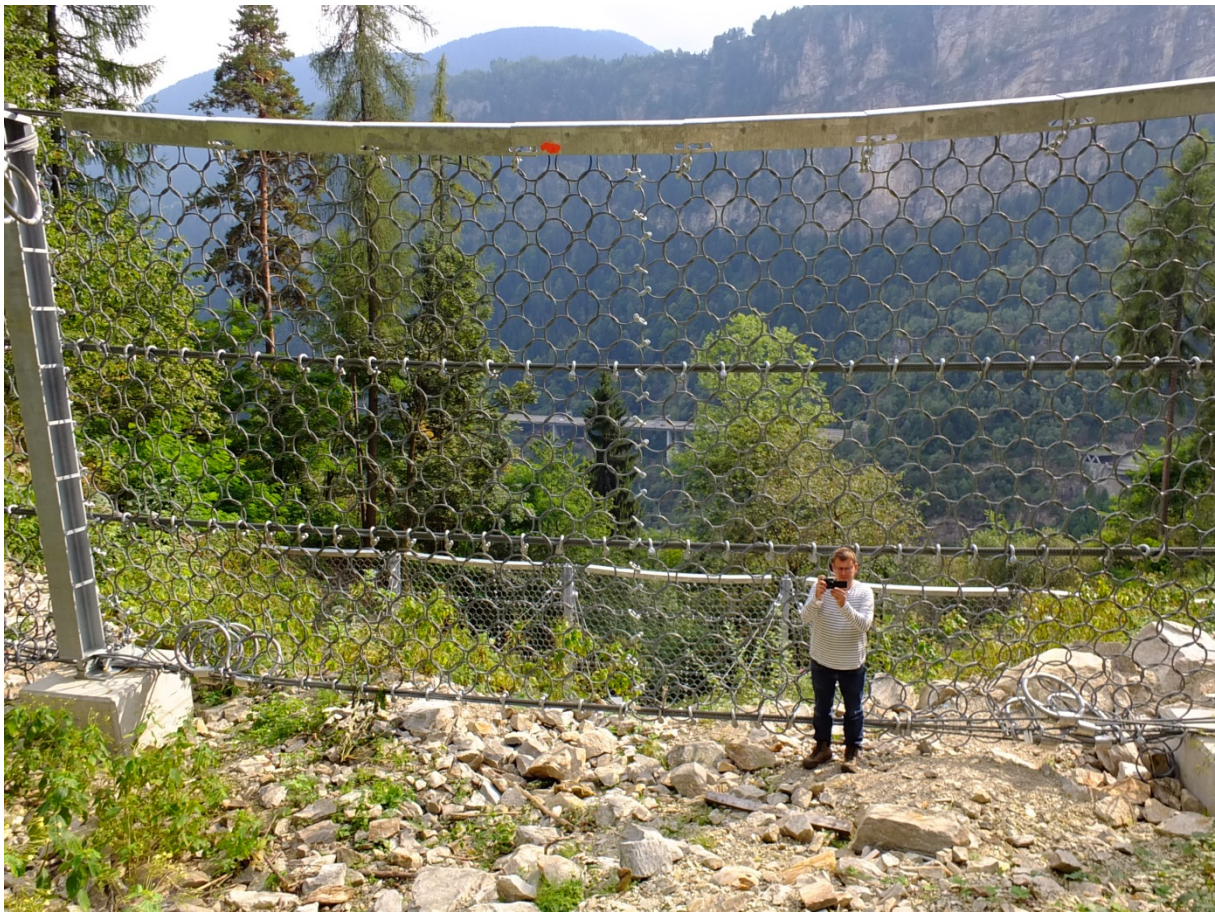
Figur 33. Begge gjerdene sett med skredretningen. (Foto: Gunne Håland)
