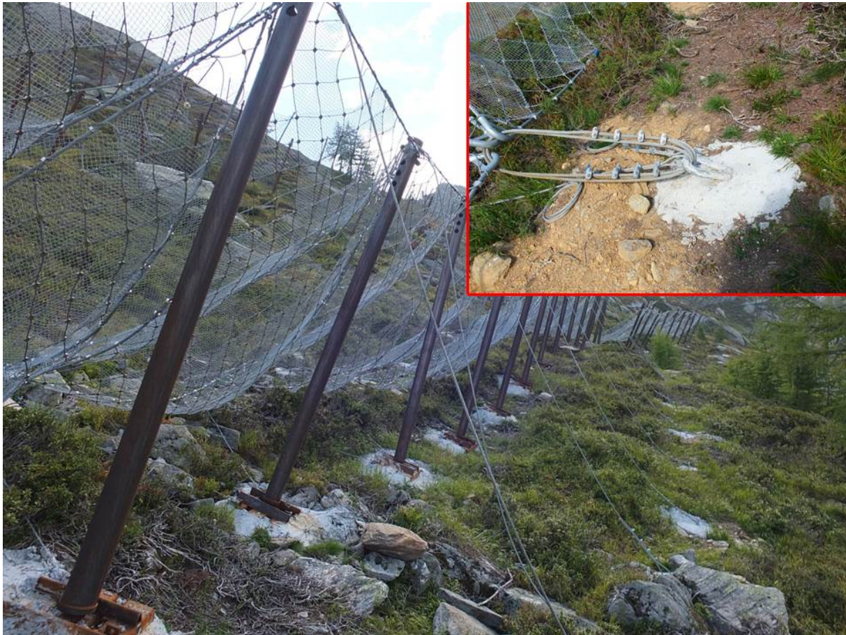
Figur 53. Det er en utfordring med rett maskestørrelse i gjerdene. Det er viktig at den nedre støttewiren er passe stram. Bilde oppe til høyre viser hvordan nettene festes til bakken (Foto: Audun Langelid)
