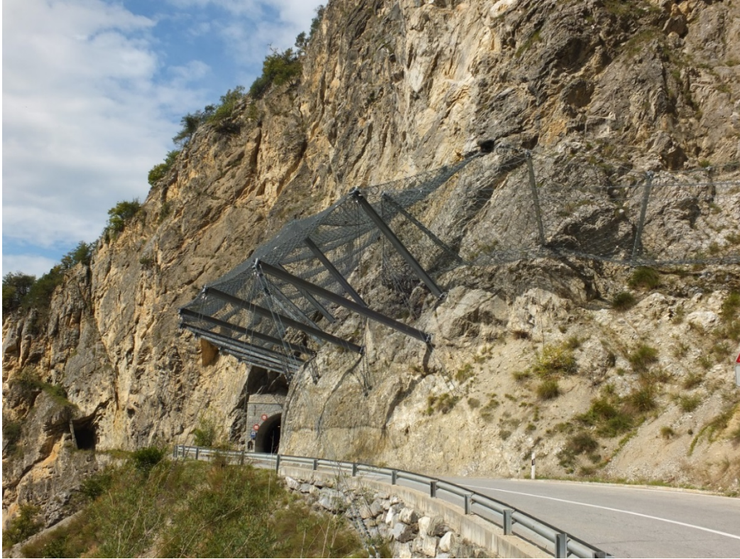
Figur 65. Geobrugg har utviklet et selvrensende fanggjerd for steinsprang som i dette tilfellet har erstattet tunnel og overbygg (Foto: Gunne Håland)
