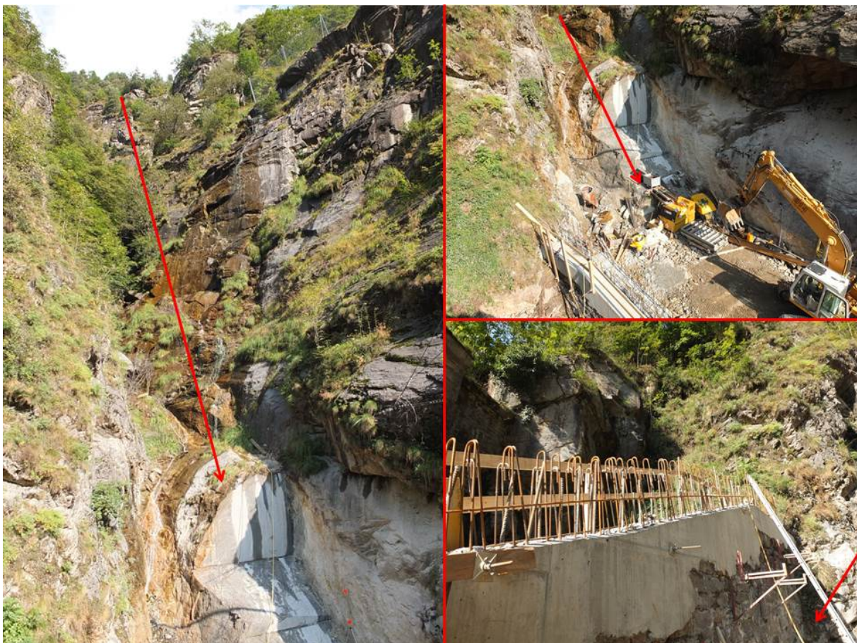
Figur 44. Bilde til venstre viser bekkeløpet som kommer ned i en trakt i fjellskrenten. Området rett under pilen er berg som er tatt bort for å få stort nok lagringsvolum i dammen. De andre bildene viser betongkonstruksjonen som er under bygging mellom bekk og jernbane. Rød pil indikerer bekkeløpet (Foto: Gunne Håland)
