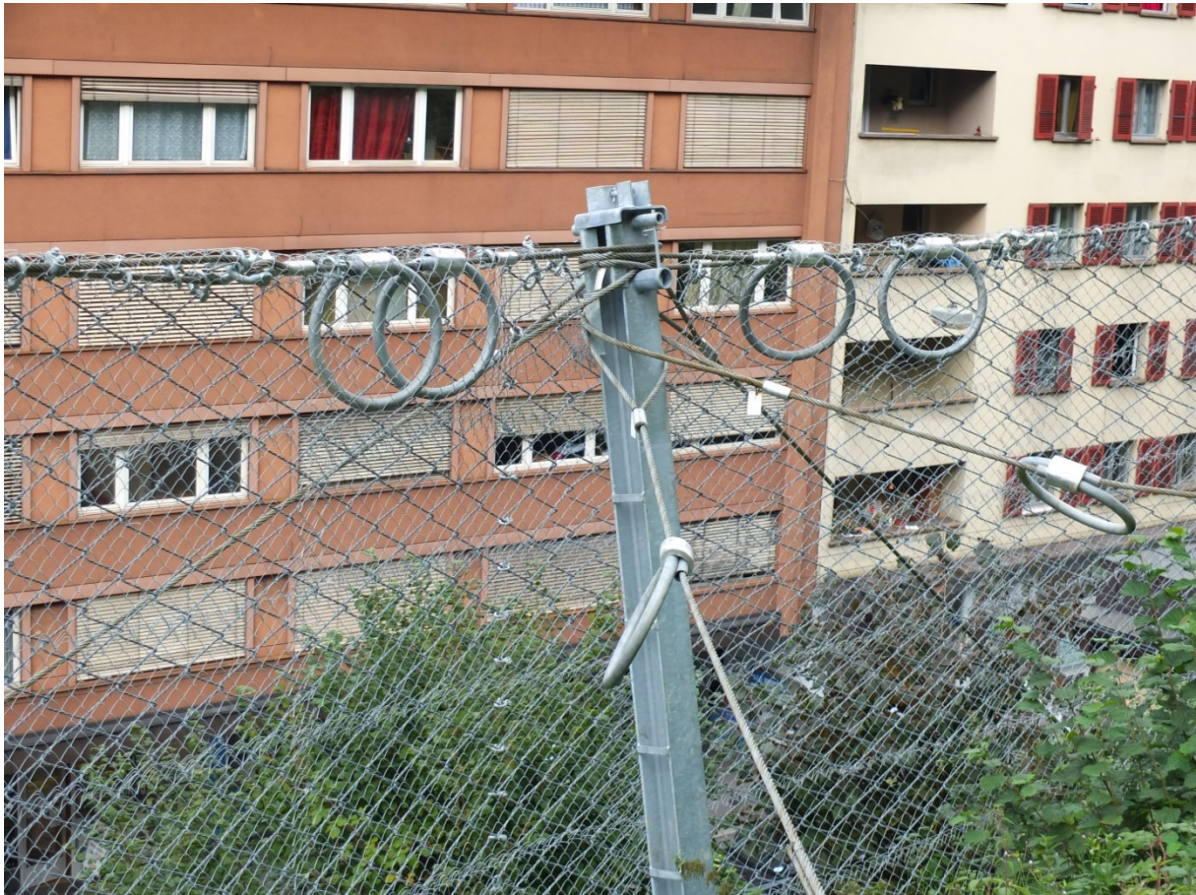
Figur 80. Både de langsgående bærewirene, og støttewirene som er festet til stolpene har bremsringer. Gjerdene har Spider sikringsnett og et vanlig flettverksnett som innernett (Foto: Gunne Håland)
