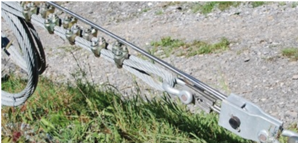
Figur 9. Bremseelement (U-brake system) i GBE - serien (Foto: Geobrudd)
