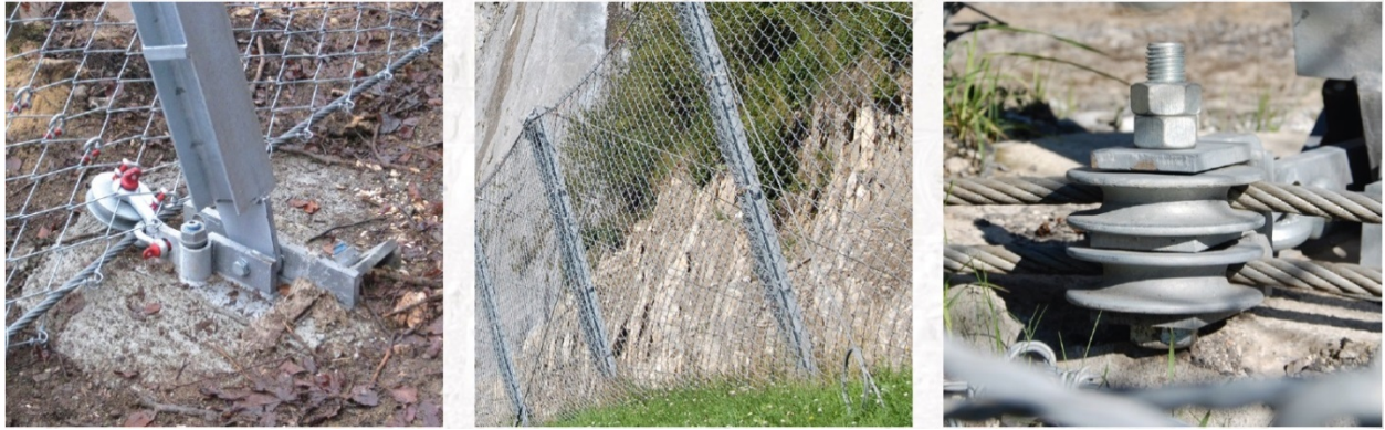
Figur 8. Fra venstre: bunnplaten til gjerdestolpene, gjerdestolper og trinse (Foto: Geobrudd)
