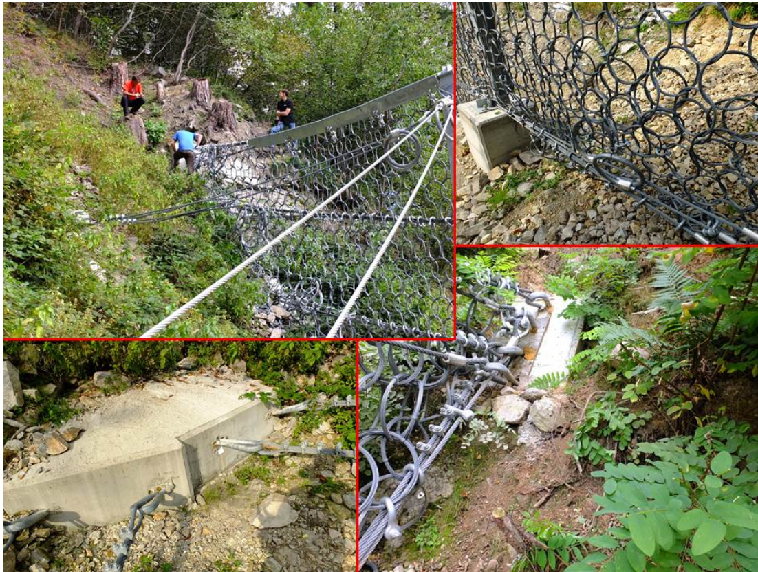
Figur 35. Forankringsmetode (Foto: Gunne Håland og Audun Langelid)
