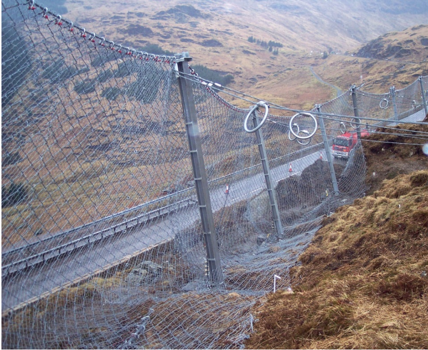
Figur 20. SL - 150 fanggjerdet installert for å fange opp jordskred i Skottland. Legg merke til at man har trukket sikringsnettet tilbake langs bakken (Foto: Geobrugg)
