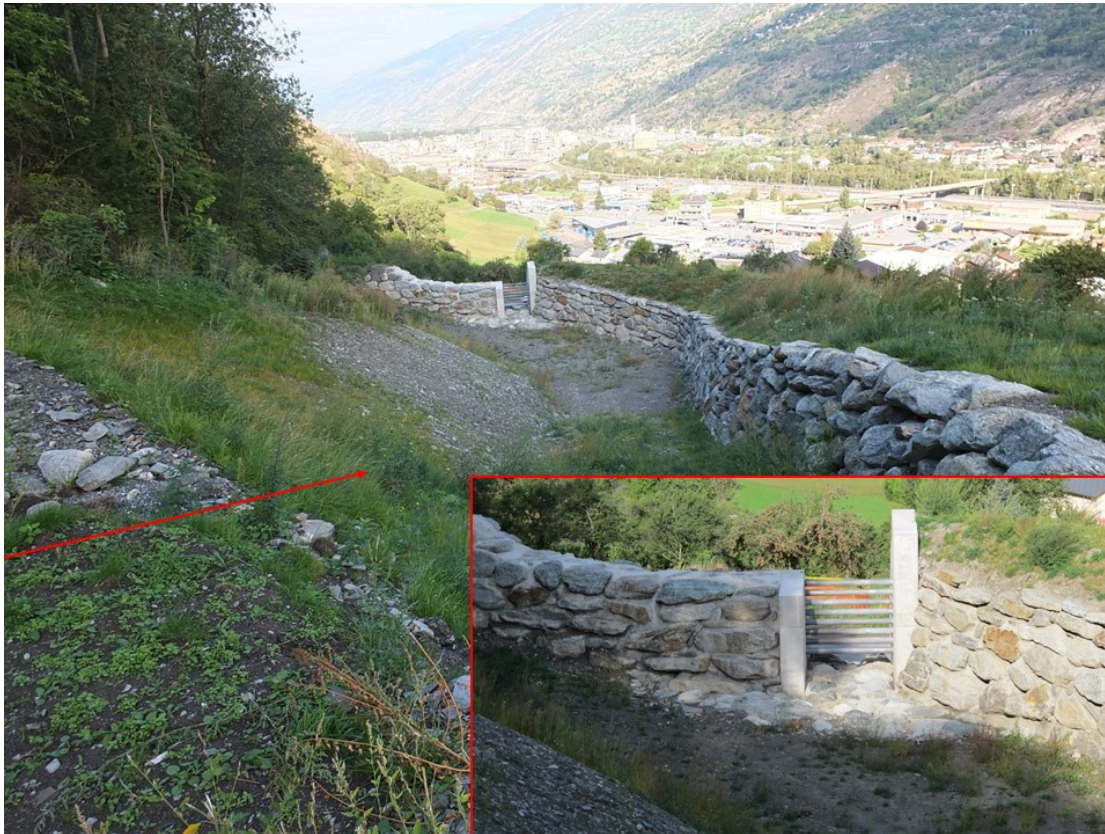
Figur 59. Det nederste bassenget har som formål å fange finere og slamførende masser som blir sluppet gjennom den øverste fangdammen. Rød strek viser skredretning (Foto: Audun Langelid og Gunne Håland)
