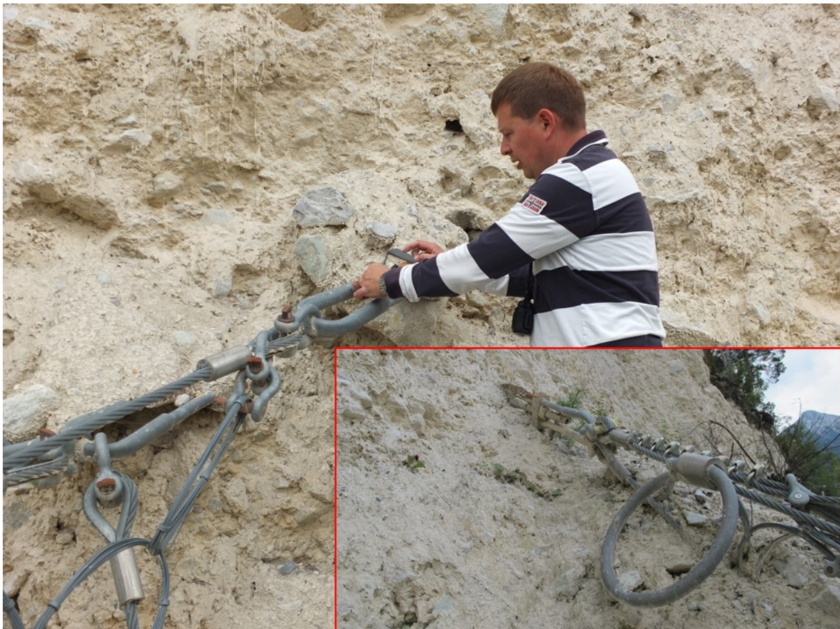
Figur 64. Gjerdene måtte forankres med to ischebeckstag, fordi man ikke fikk fullgyst wireankrene. Bildet viser det fleksible hodet i enden av stagene (Foto: Gunne Håland)
