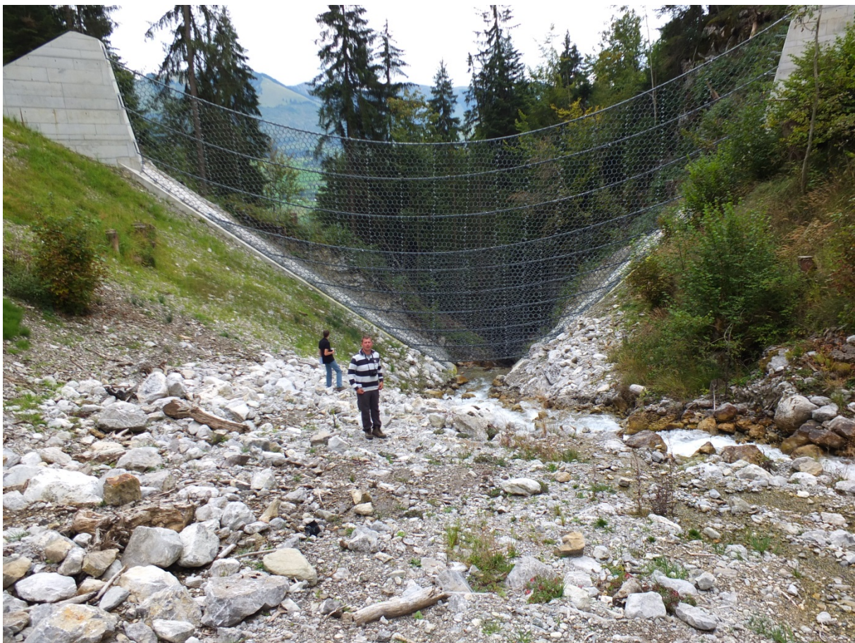
Figur 67. I 2013 ble verdens største fleksible ringnettbarriere satt opp for å sikre landsby (Oberwill), veg og jernbane mot et stort flomskred man frykter kan komme her en gang i fremtiden (Foto: Gunne Håland)
