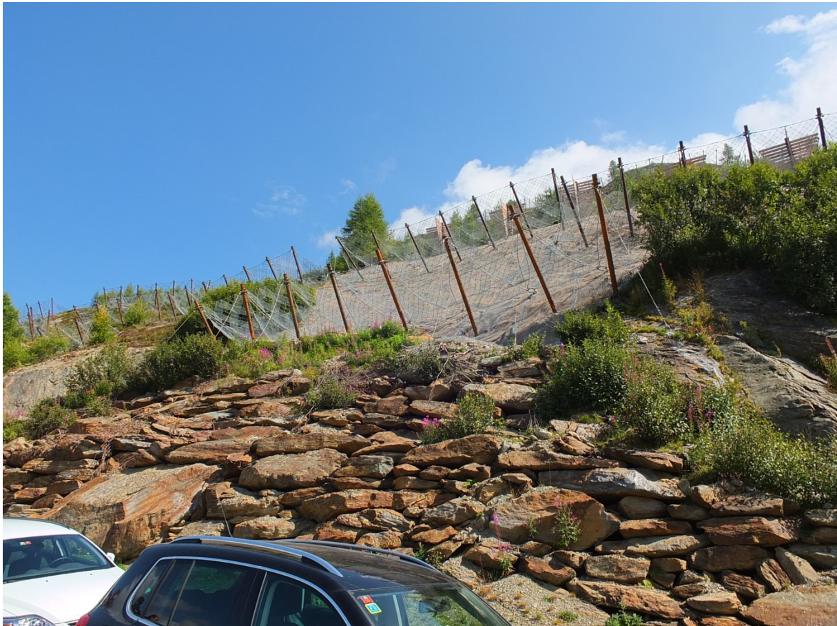
Figur 49. De nederste snøgjerdene sett fra vegen (Foto: Gunne Håland)
