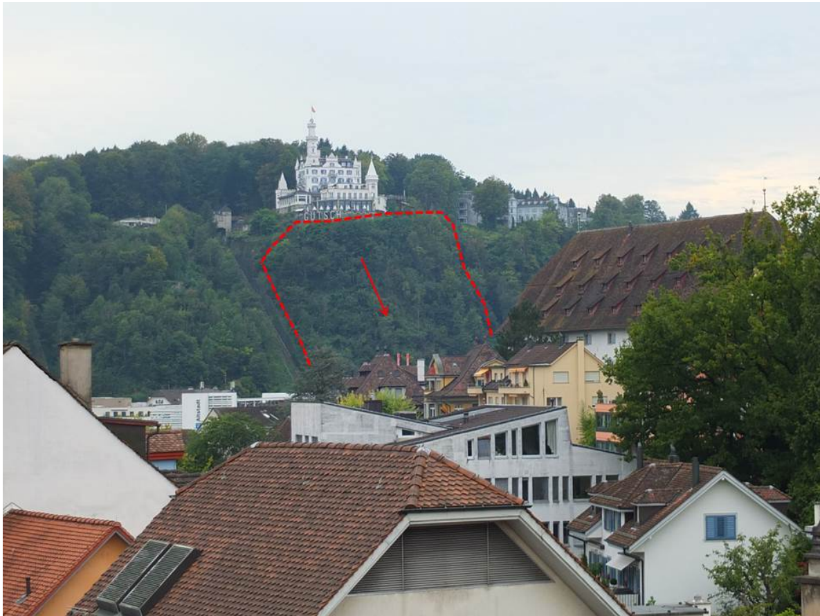
Figur 79. Det ligger en bratt jordskråning over en rundkjøring der man frykter det kan gå et jordskred. Toppen av skråningen går over i et flatt platå der det ligger et slott (Foto: Gunne Håland)
