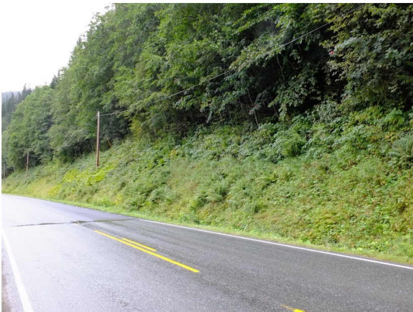
Figur 87. Bratt jordskråning ned mot vegen ved Kotsøy. Grøften er smal og har liten stoppeeffekt fra skred som løsner lenger oppe i dalsiden (Foto: Gunne Håland)
