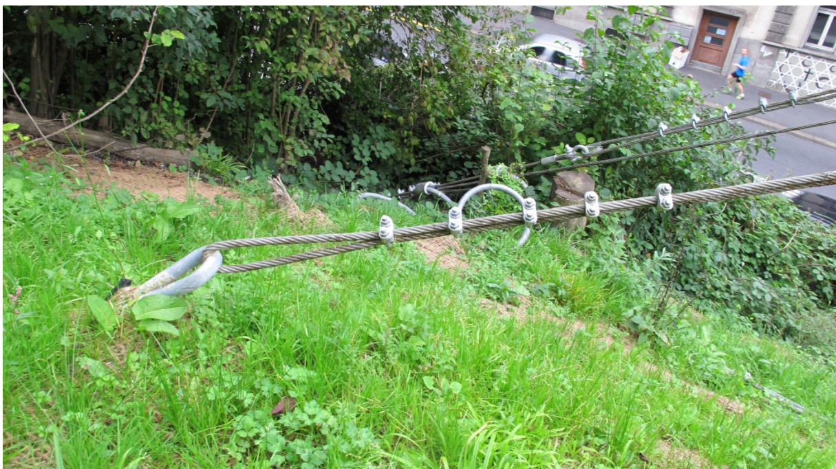
Figur 81. Støttewirene er forankret til bakken med wirebolt (Foto: Audun Langelid)
