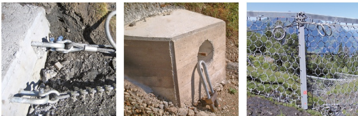
Figur 17. Fra venstre: wireanker, selvboret stag med et fleksibelt hode, gjerdestolper (Foto: Geobrugg)
