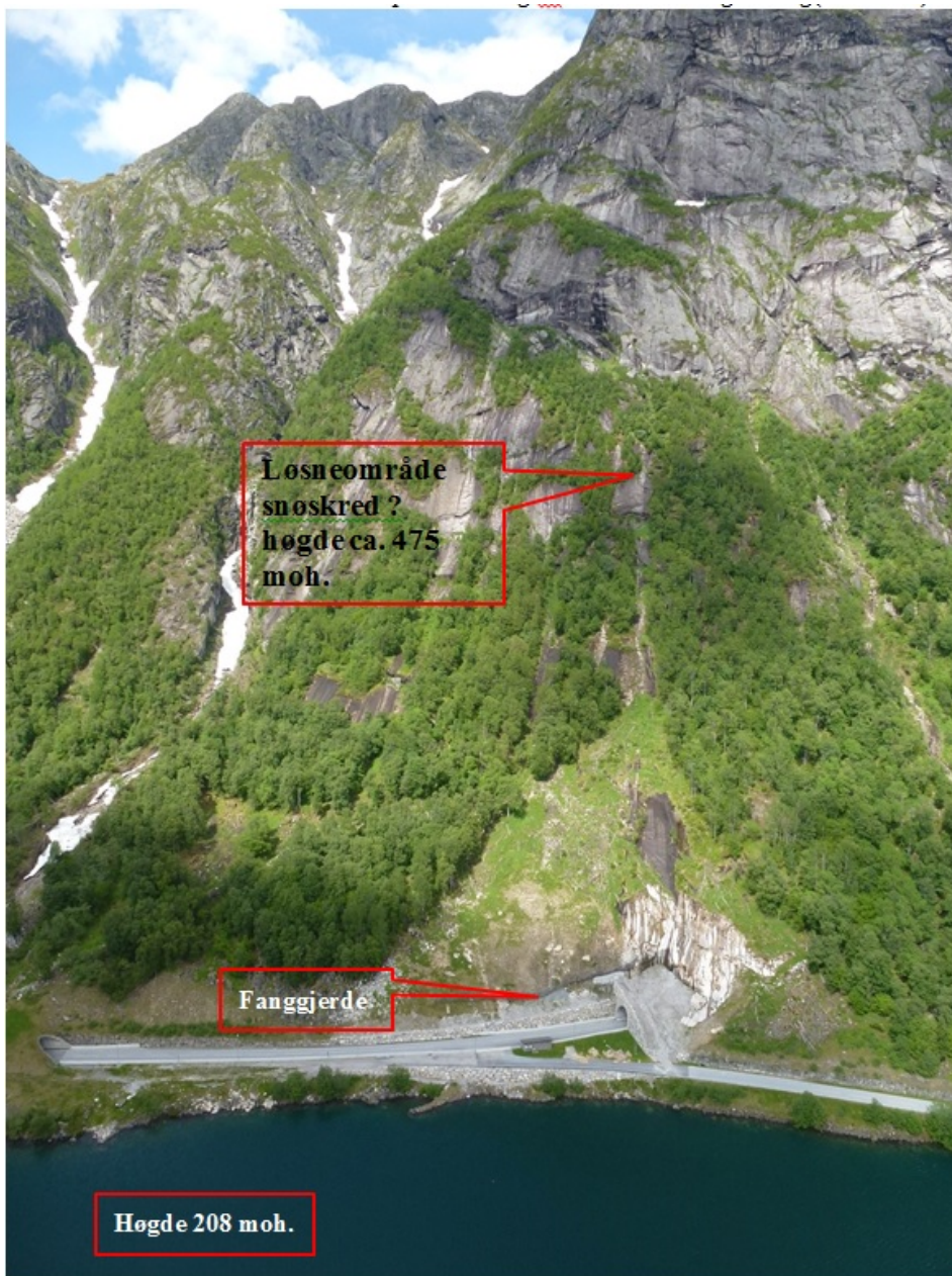
Figur 82. Viser antatt løseområdet til snøskredet og plassering av fanggjerdene (Foto: S. H. Frækaland, 2011)
