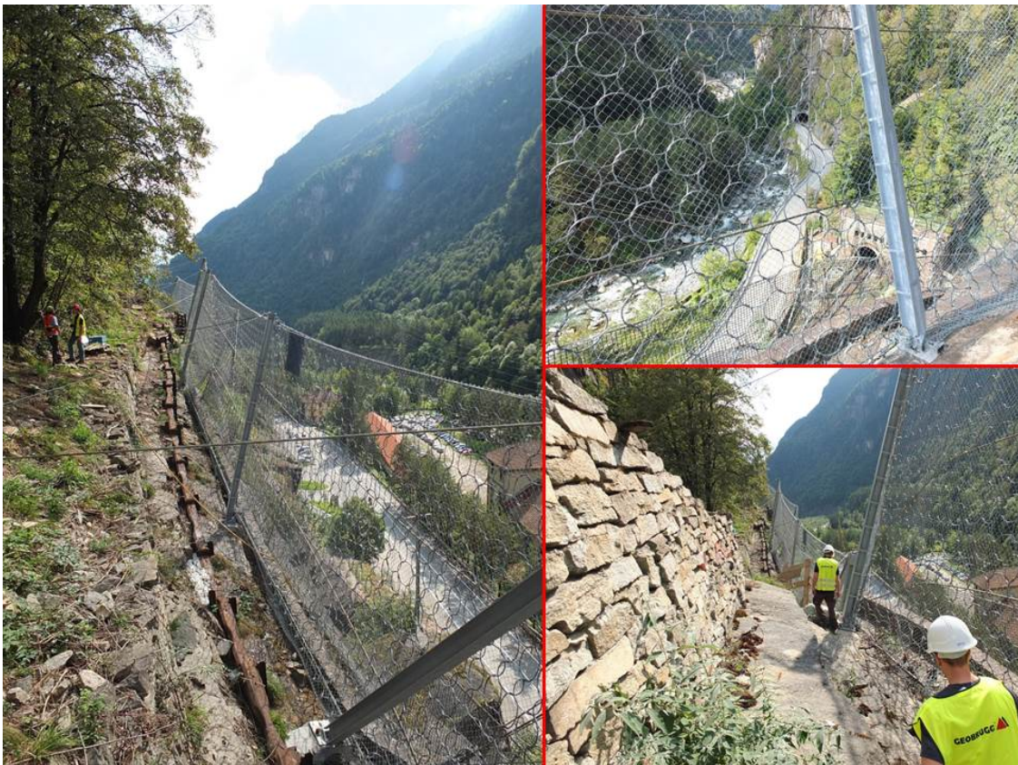
Figur 47. RXE fanggjerdar med Rocco ringnett og Tecco som innernett. Gjerdene er plassert i høye områder i skrenten (Foto: Audun Langelid)
