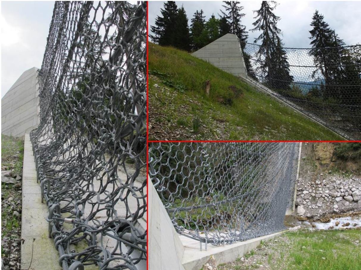
Figur 70. De nederste 9 meterne består av et dobbelt lag med ringnett. De 9 bærewirene er forankret i støpte betongelementer langs kanalveggene. Nederst er det en åpning slik at elven kan strømme fritt gjennom uten å berøre gjerdet (Foto: Gunne Håland og Audun Langelid)
