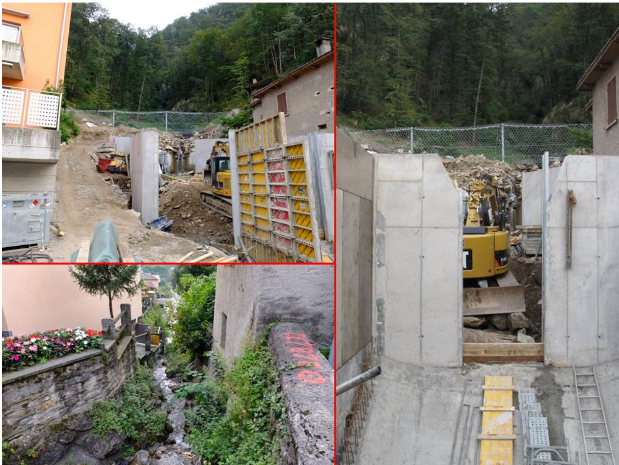
Figur 39. Betongdammen har som hensikt å lede vann og suspenderte masser fra eventuelle flomskred kontrollert til elven som går gjennom landsbyen (Foto: Gunne Håland og Audun Langelid)
