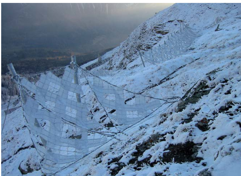
Figur 26. Snøgjerder som støtteforbygning i løseområdet (Foto: Geobrugg)
