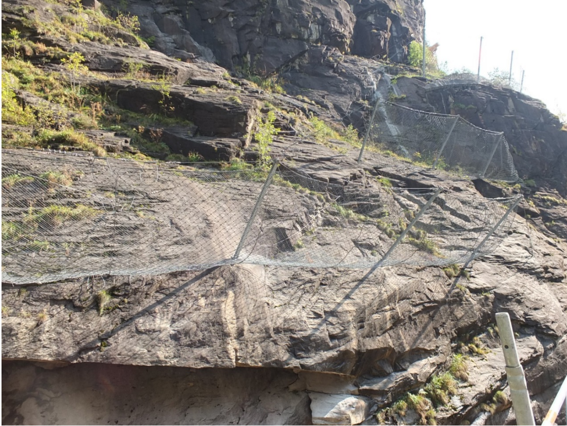
Figur 46. GBE-gjerder med Spider sikringsnett, plassert nederst i skrenten (Foto: Gunne Håland)
