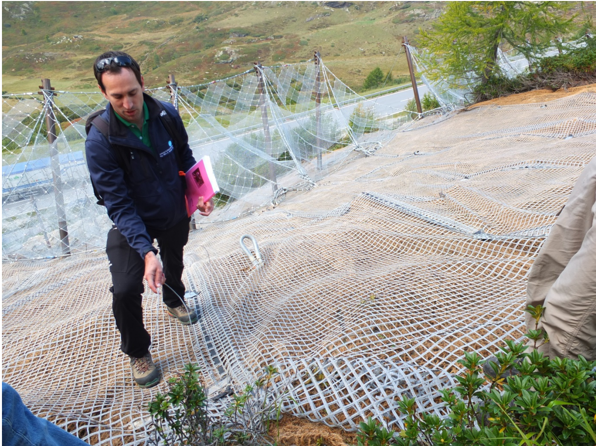
Figur 52. Der terrenget er ekstra bratt og utsatt for jordsig er det valgt å legge geotekstiler mellom radene. Dette for å binde jorda bedre sammen (Foto: Audun Langelid)
