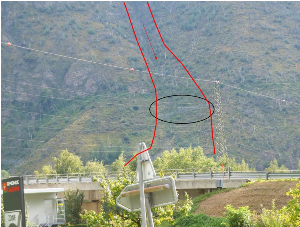
Figur 57. Litt vanskelig å se på bilde, men det er satt opp fanggjerd i en lokal forskning i dalsiden der man tror det kan gå nye skred (svart sirkel). Rød strek viser en forsenkningen som kan være et potensielt skredløp (Foto: Gunne Håland)
