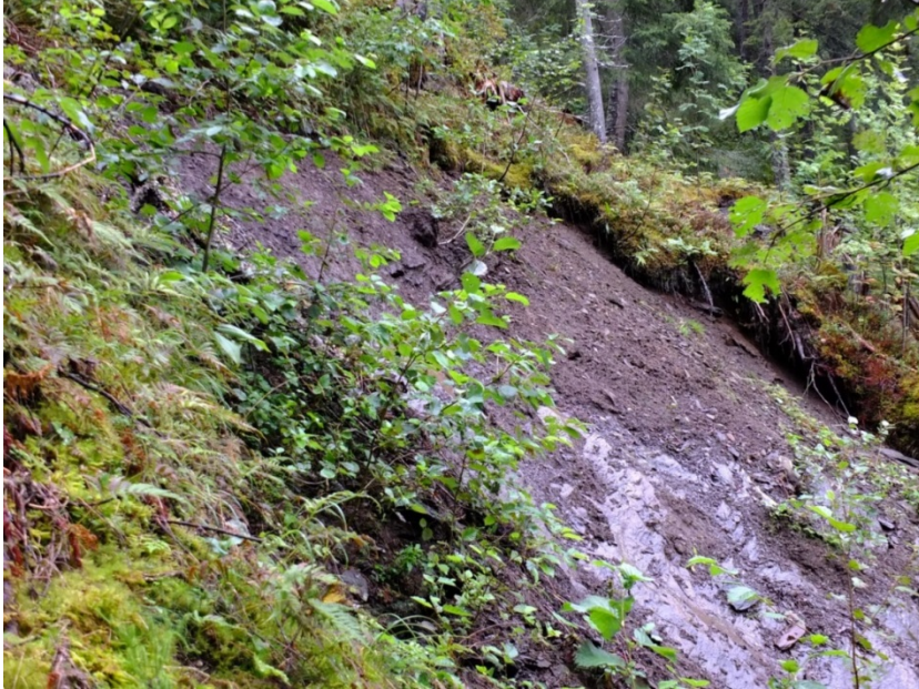
Figur 86. Løsneområdet til jordskredet i 2004 ved Kotsøy (Foto: Gunne Håland)
