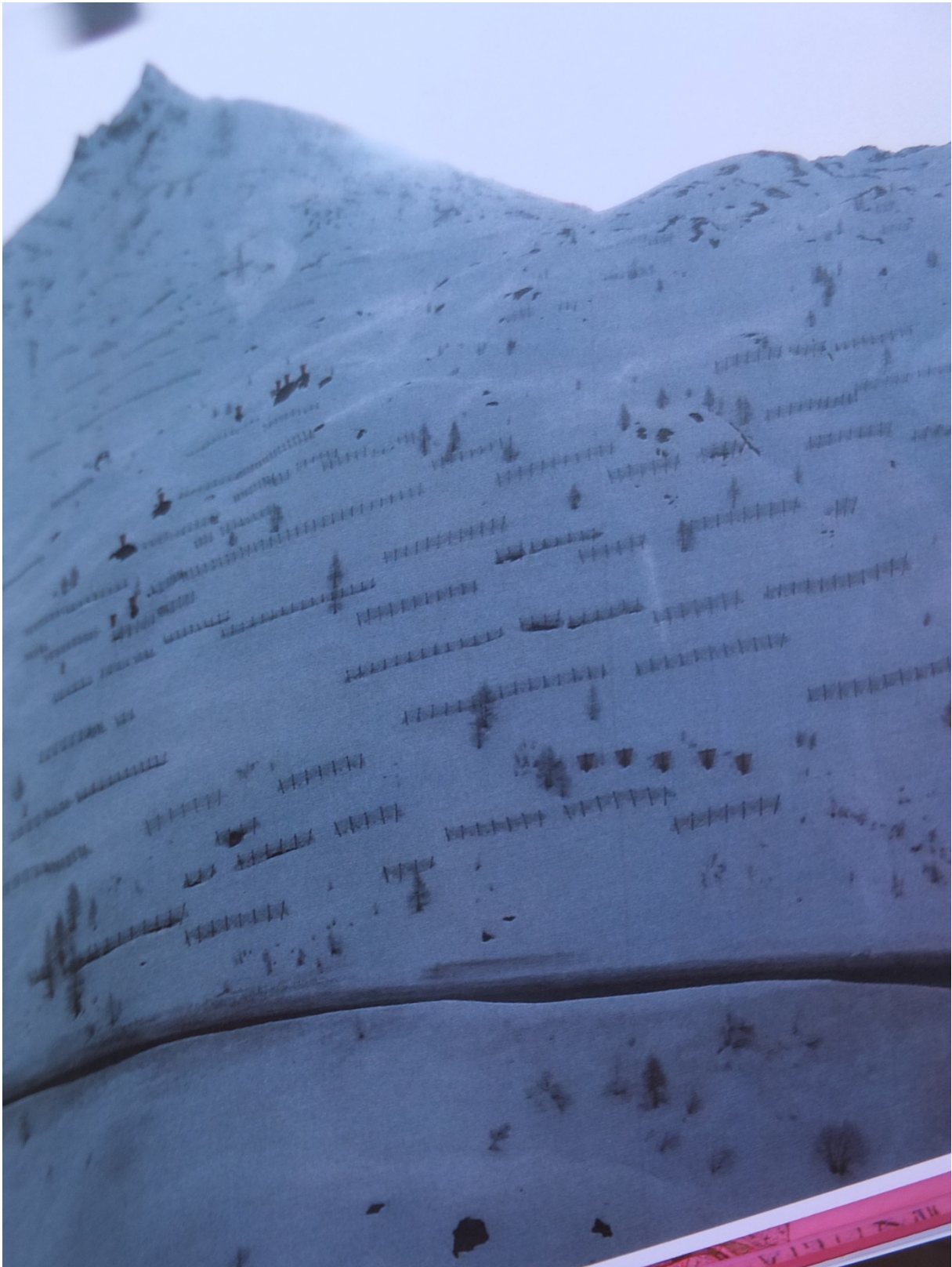
Figur 50. Det er et stort område som er sikret med snøgjerder (Foto: ukjent)
