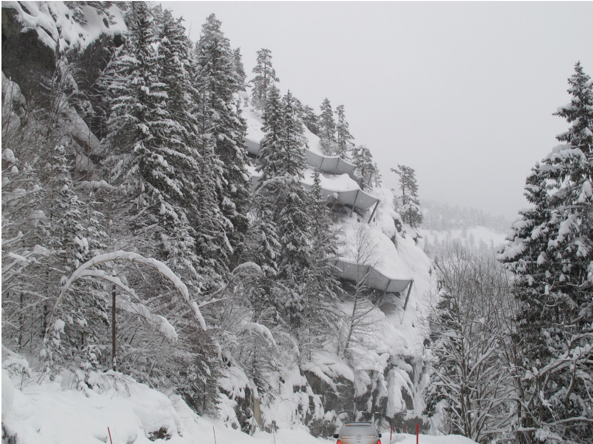
Figur 3. Her blir snøgjerd brukt som støtteforbygning for å hindre at snøskred treffer vegen, fv 503 i Telemark (Foto: Audun Langelid)
