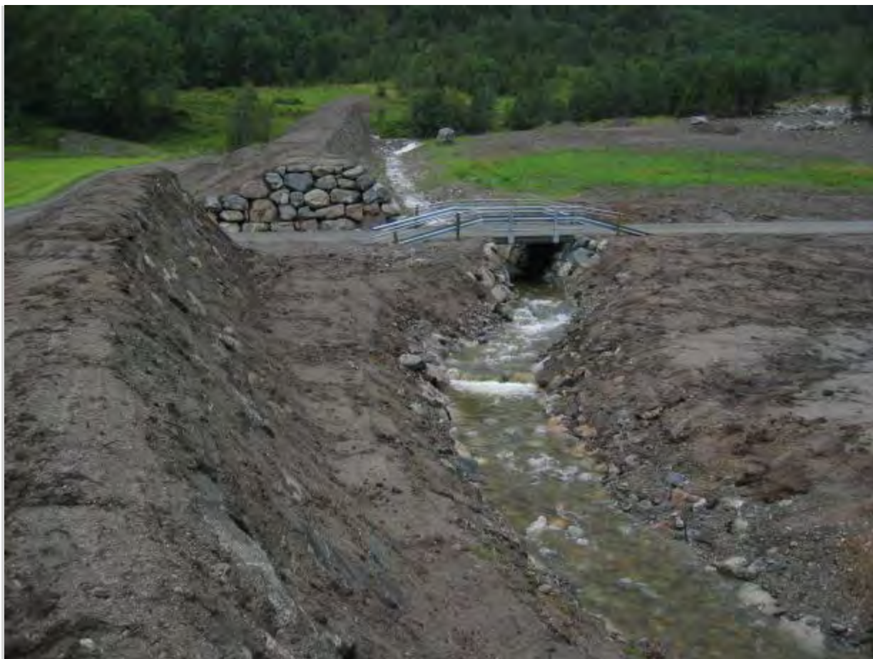
Figur 21 Ferdige sikringsvoller ved Kvednagrovi (Foto: NVE).
