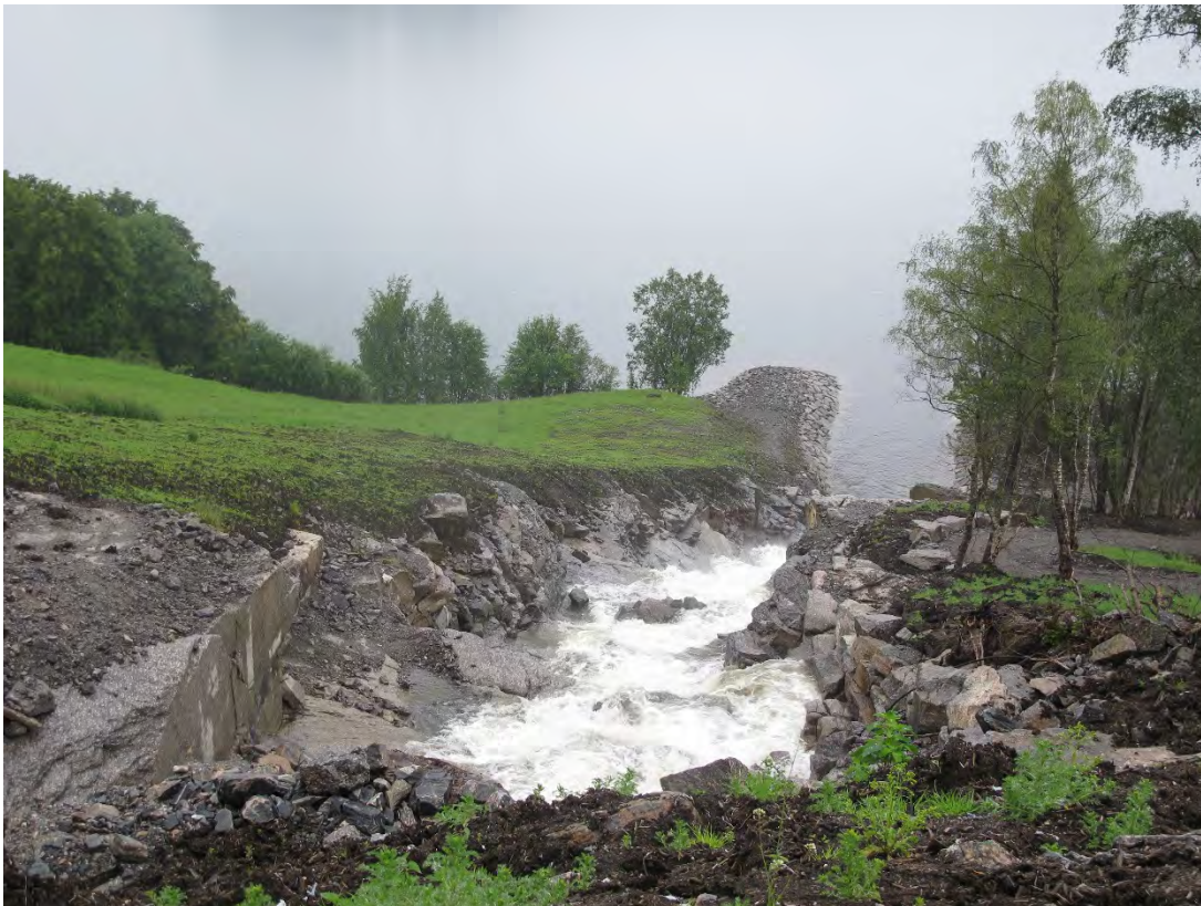
Figur 38 Mot utløpet i Nordfjorden. Venstre side er påfylt vekstjord og tilsådd (Foto: NVE).
