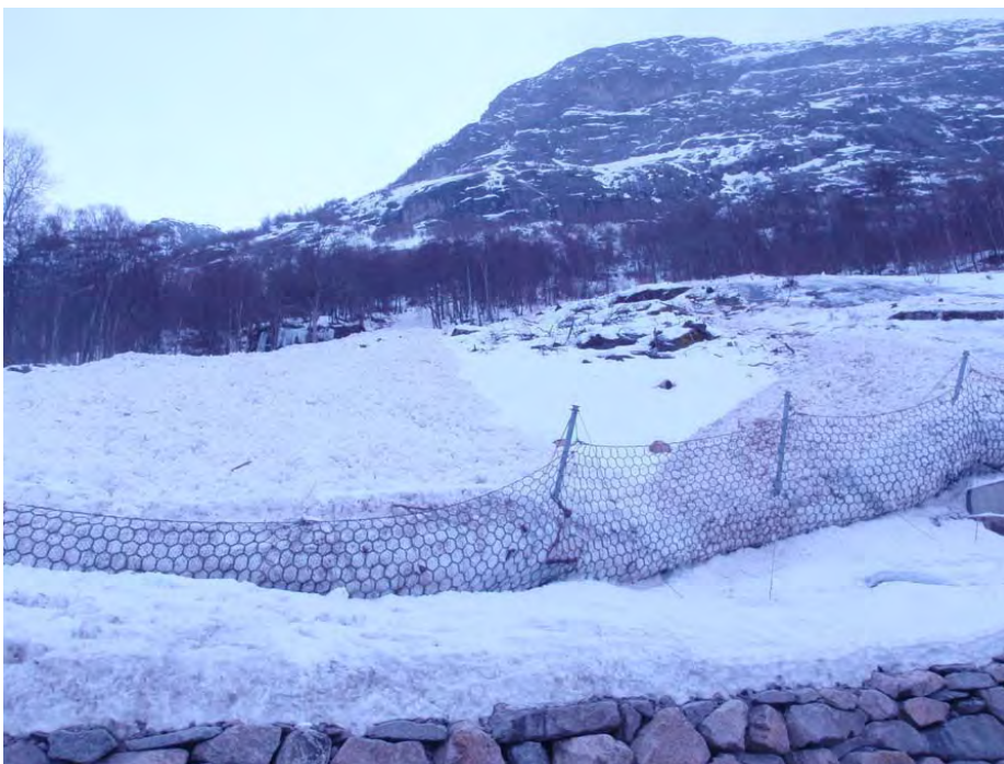
Figur 28 Skredmasser har fylt opp gjerdet fra to forskjellige skredløp. Terrenget over består av bratt svaberg (Foto: Kristian Kjesbu).
