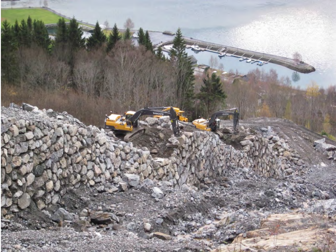
Figur 44 Gjølmunna 2014. Sikringsarbeid under utføring. (Foto: Anders Muldsvor, NVE).
