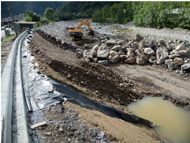
Figur 12 Legging av membran, fyllmasser, filtermasse og plastringsstein, september 2013 (Foto: Jomar Bergheim, NVE).
