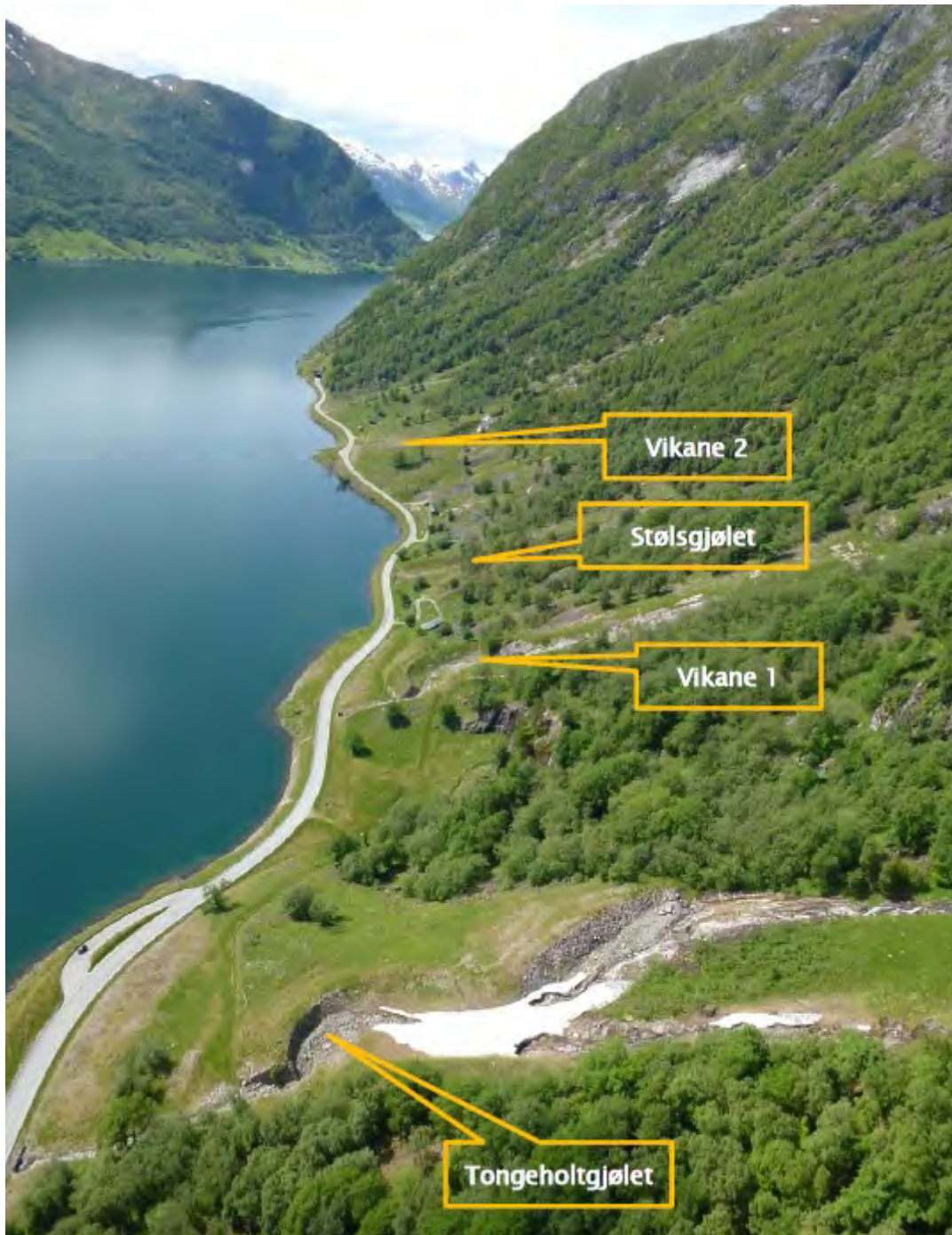
Figur 32 Oversikt over terrengiltakene mellom Bjørnebakktunnelen og Kleivatunnelen (Foto: S. H Frækaland).
