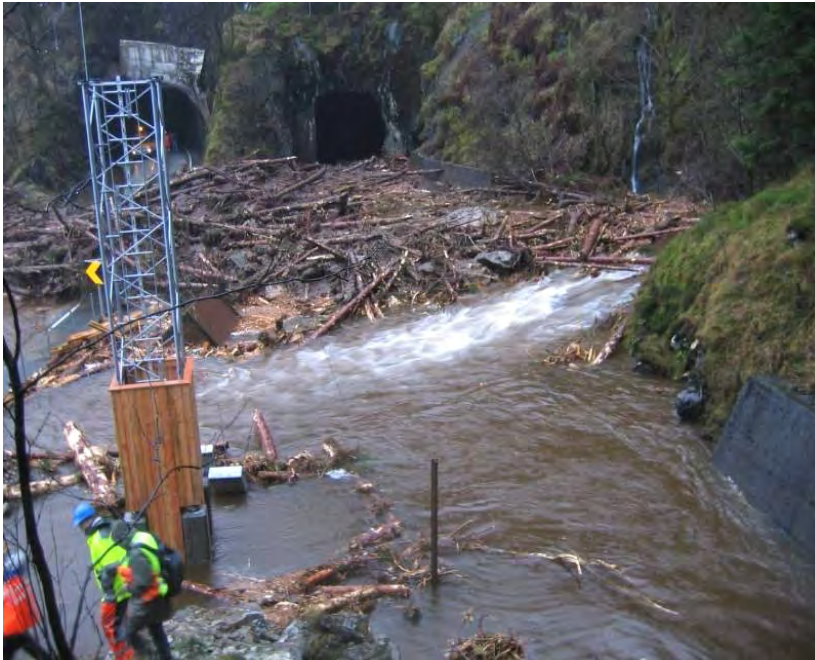
Figur 3 Flomskred ved Langhelle november 2005 (Foto: Jernbaneverket).
