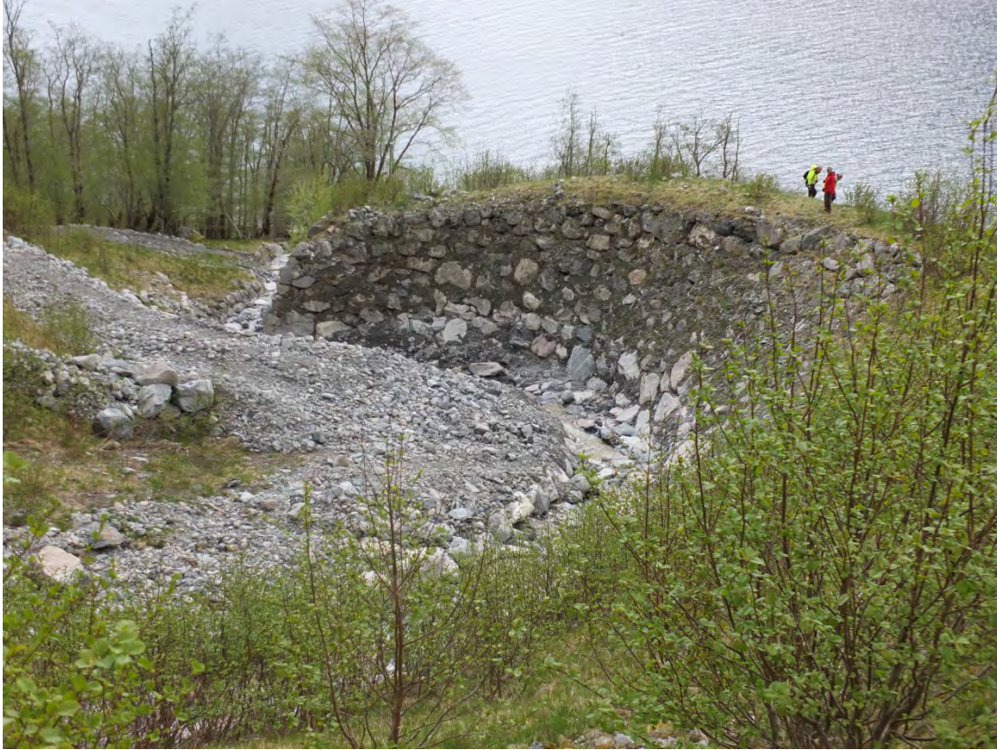
Figur 30 Nedre del av krokvollen er murt opp med en helning på 3:1 i naturstein (Foto: Gunne Håland).
