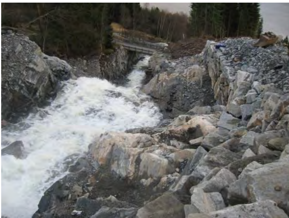
Figur 35 For å få god nok kapasitet på elveløpet, har ein i nokre parti sprengt seg langt ned i fjellet (Foto: NVE).
