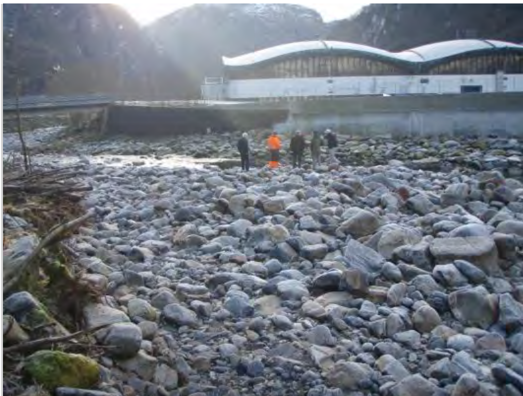
Figur 10 Etter flaumen i 2005. Her er muren mot industribygningen alt reparert (Foto: Anja Midtun, NVE).
