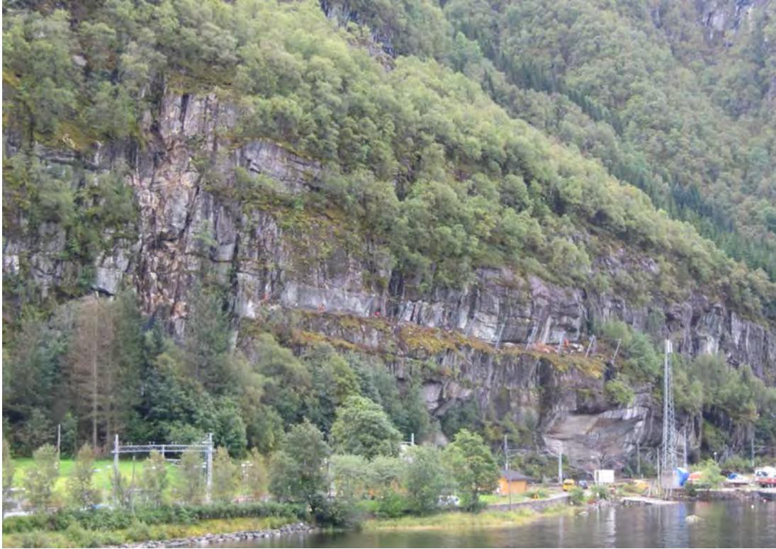
Figur 7 Fra montering av fanggjerdet ovenfor Stanghelle stasjon (Foto: Karl Morten Undal, Jernbaneverket).
