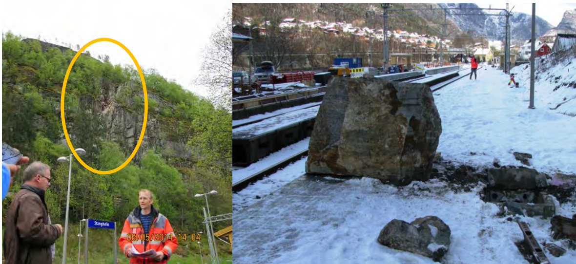
Figur 6 Stanghelle. Venstre: Det innringede fjellpartiet er utsatt for steinsprang og steinskred (Foto: Lene Kristensen, 2014). Høyre: En av steinblokkene som traff plattformen ved Stanghelle stasjon (Foto: Ove Madsen, Jernbaneverket).
