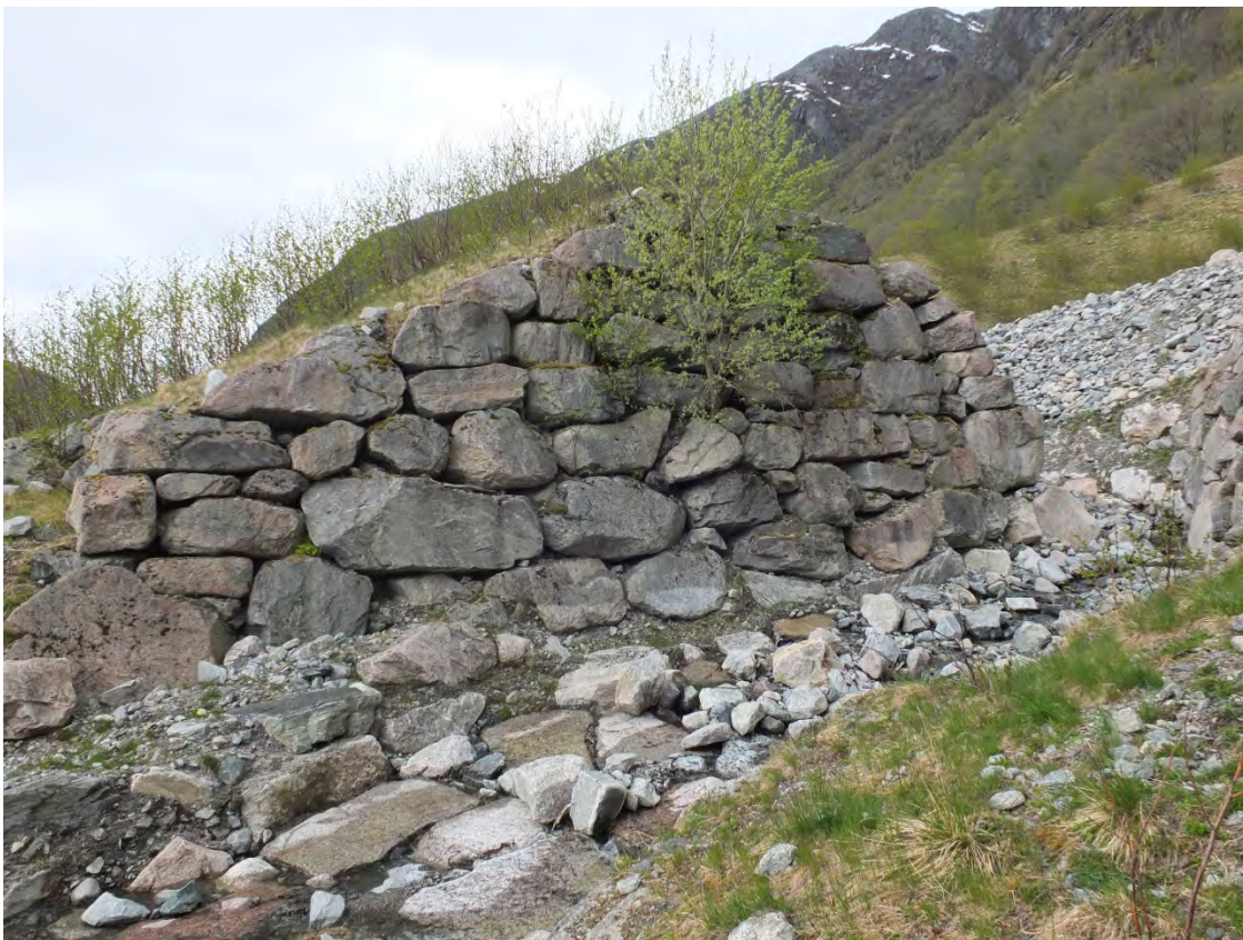
Figur 31 Krokvollen har en helning på 3:1 på støtsiden og 1:1,5 på lesiden (Foto: Gunne Håland).
