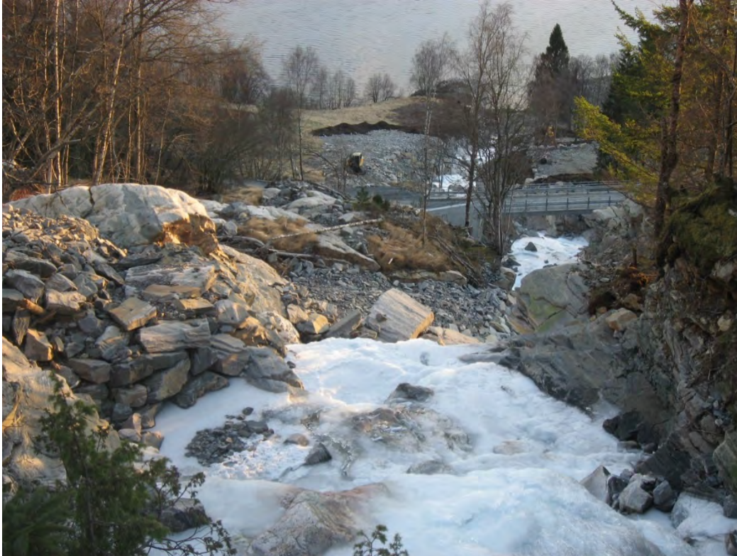
Figur 37 Ferdig utsprengt elveløp sett frå øvre del og ned mot øvste busetnaden. Nordfjorden i bakgrunnen (Foto: NVE).
