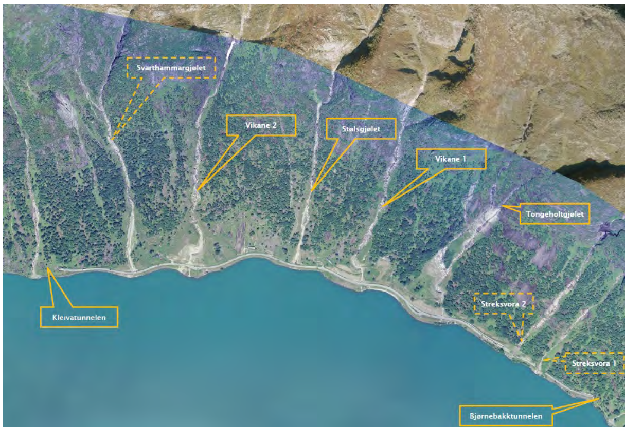
Figur 29 Oversikt over skredløpene mellom Bjørnebakktunnelen og Kleivatunnelen.
