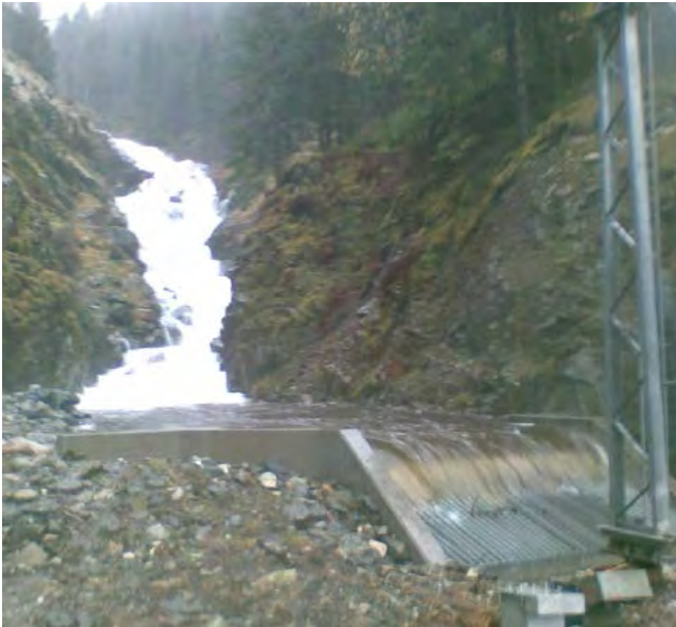
Figur 5 Selvrensende rist ved Langhelle ved flomvannsføring (Foto: John Endre Fossmark).
