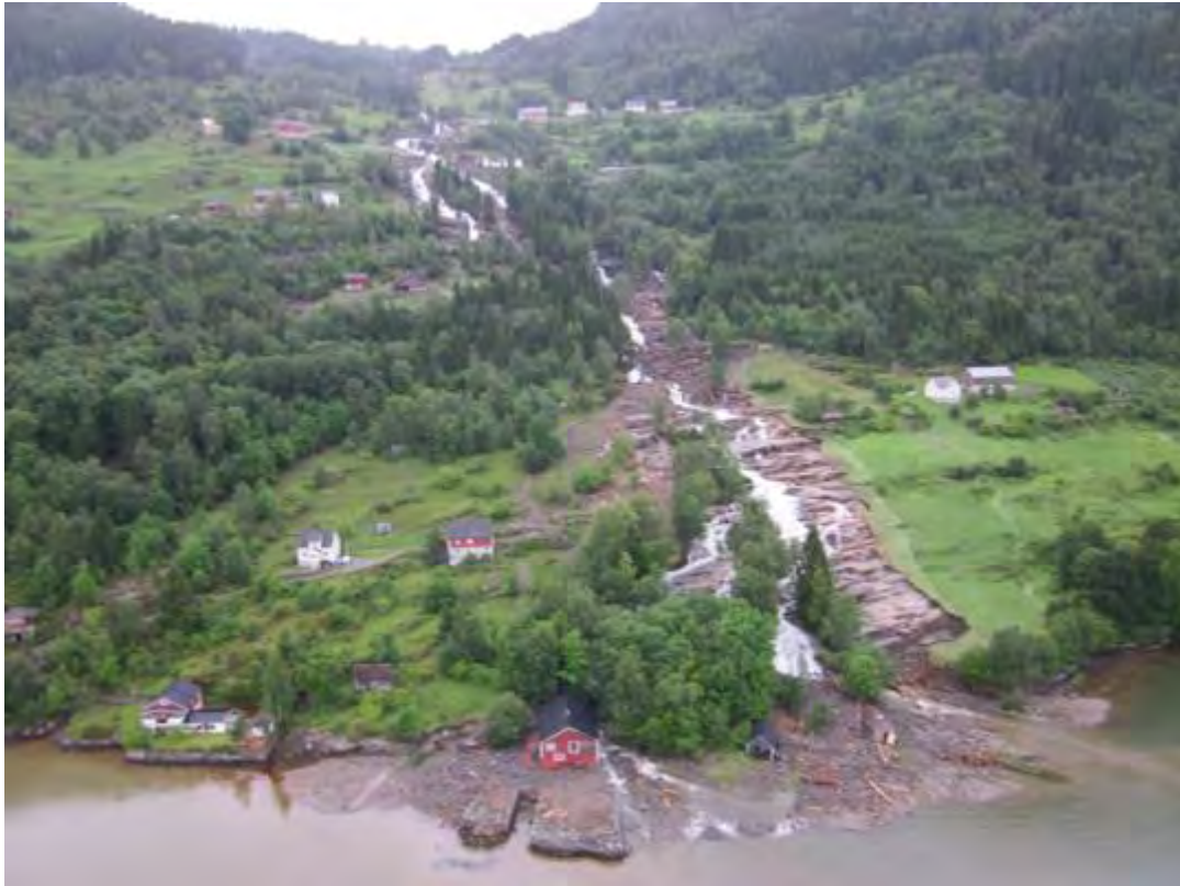
Figur 33 Oversyn Steindøla etter flommen (Foto: NVE).
