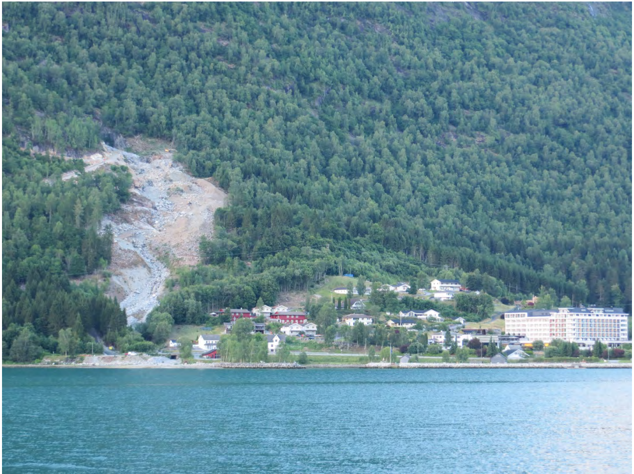
Figur 42 Gjølmunna 2014. Anleggsområdet rydda for vegetasjon. (Foto: Helge Leiv Nordvik, NVE).
