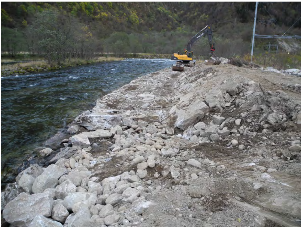
Figur 13 Arbeid med plastring i to nivå, oktober 2013 (Foto: Jomar Bergheim, NVE).
