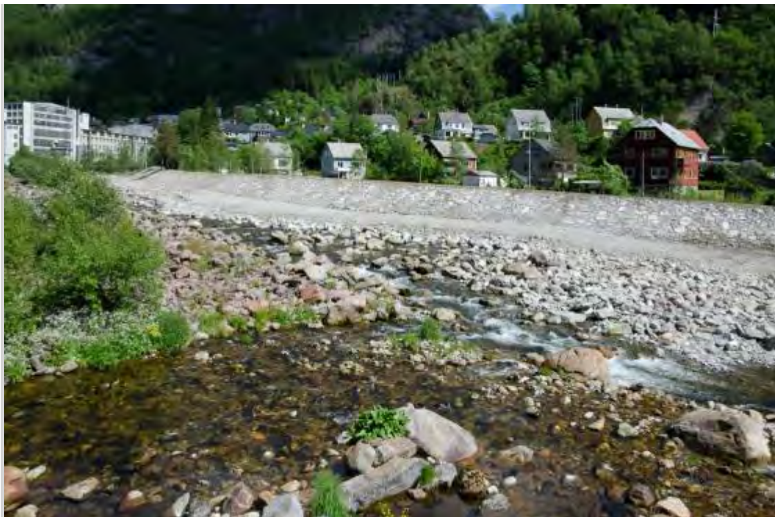
Figur 14 Parti av ferdig anlegg i Bergsdalselva i Dale i Vaksdal, juni 2012 (Foto: Jomar Bergheim, NVE).
