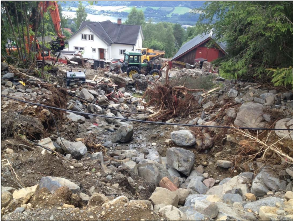
Figur 58: Vann på avveie og skader på øverste bebyggelse ved Bæla (Foto: Steinar Myrabø).
