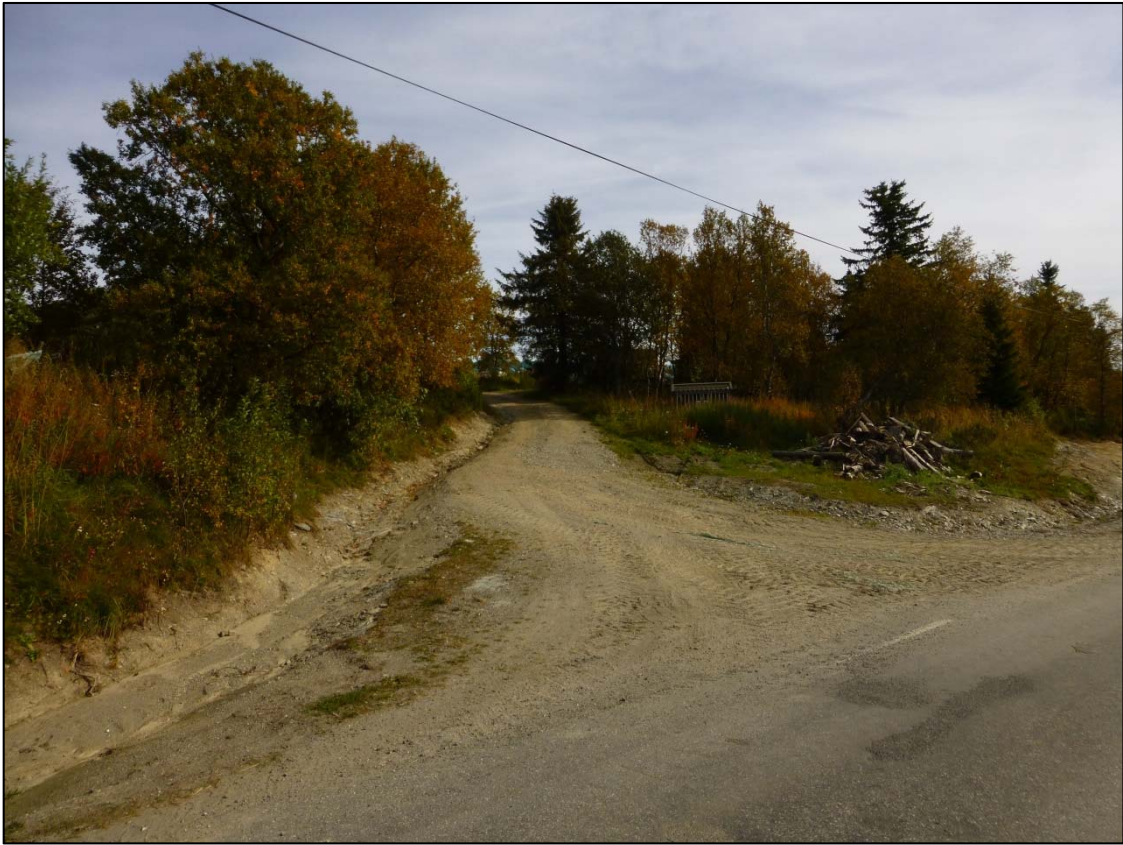
Figur 23: Skogsbilveien fra åkerlappene i Brandrudsåa fungerte som vannvei under flommen (Foto: Maria H. Olsen).
