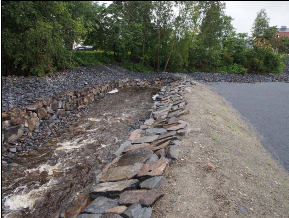
Figur 126: omtrent 400 meter med erosjonssikring er gjennomført ved Fredrik Colletsvei ved Åretta. (Foto: Andres Breili).
