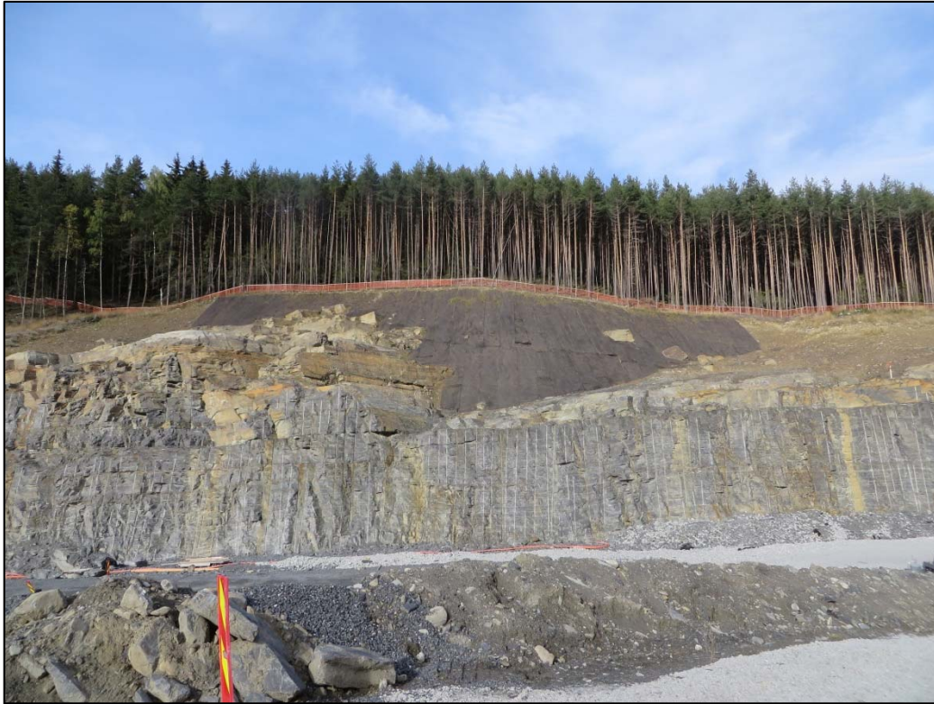
Figur 118: Kokkosmatter brukt til å stabilisere skråning. (Foto: Agathe A. Hopland).
