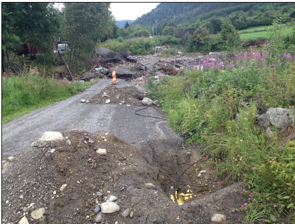
Figur 56: Skader på lokalvei og bru i Bæla (Foto: Steinar Myrabø).
