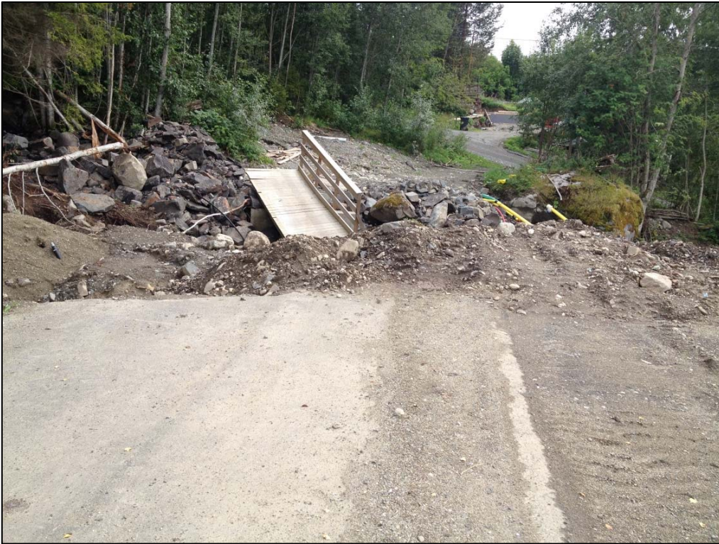
Figur 63: En ny bru ble utvasket på samme sted som i figuren over (Foto: Steinar Myrabø).
