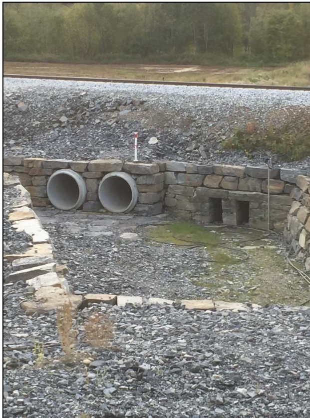
Figur 115: Nye stikkrenner er satt inn ved siden av eksisterende steinkister under jernbanen. (Foto: Maria H. Olsen).
