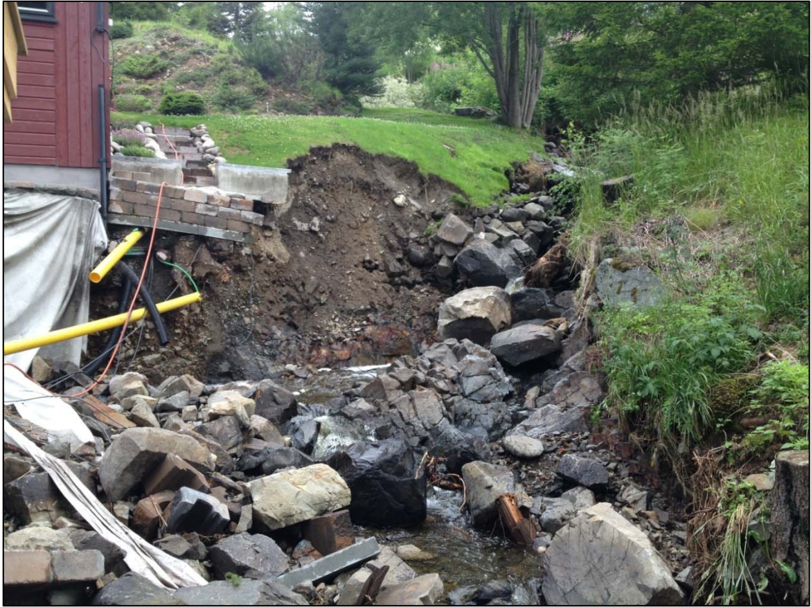
Figur 37: Vannet har erodert på eiendom ved Åretta. (Foto: Steinar Myrabø).
