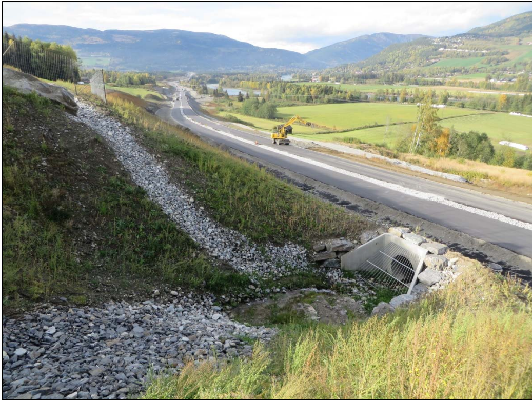
Figur 120:Erosjonssikret terrenggrøfter. (Foto: Agathe A. Hopland).
