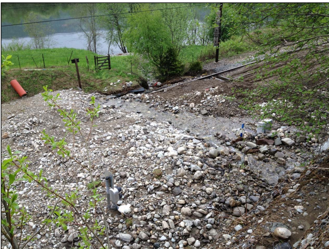
Figur 35: Det ble avsatt store mengder løsmasser på jernbanen ved Sagstugua (Foto: Steinar Myrabø).
