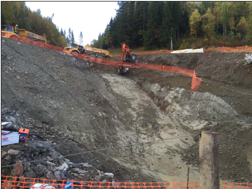
Figur 123: Tiltak ved Sagstugua er under arbeid. (Foto: Maria H. Olsen).
