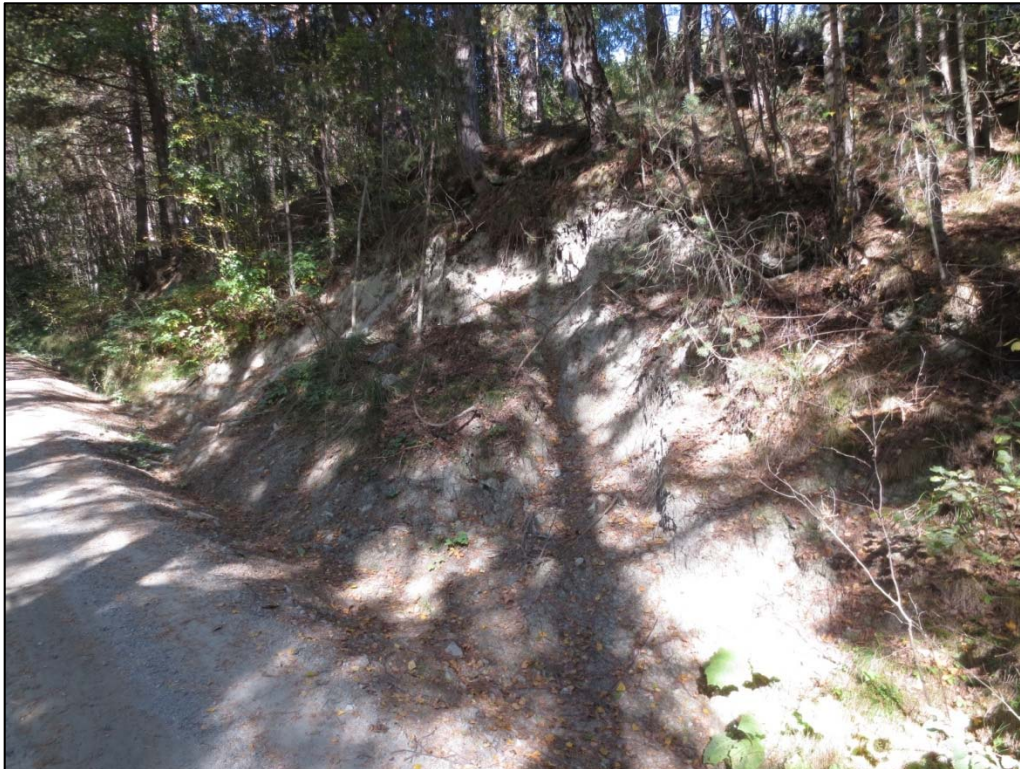
Figur 21: Erosjon i sideterreng etter flommen (Foto: Maria H. Olsen).
