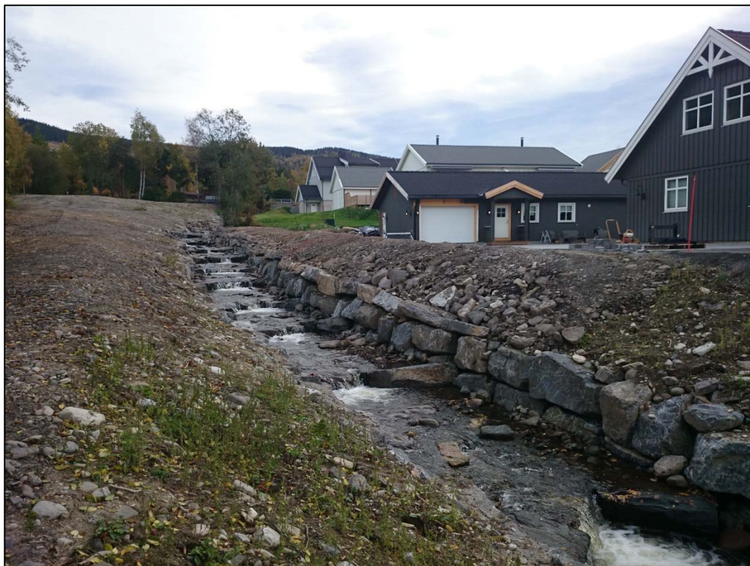
Figur 128: Erosjonssikring i nedre del av Bælavassdraget. (Foto: Anders Breili).
