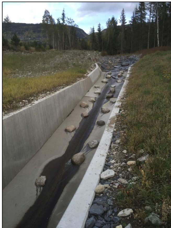
Figur 119: Erosjonssikret bekkeløp med terskler for å sikre fiskevandring. (Foto: Maria H. Olsen).
