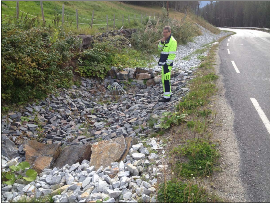
Figur 122: Erosjonssikret grøfteløp med terskler. (Foto: Steinar Myrabø).
