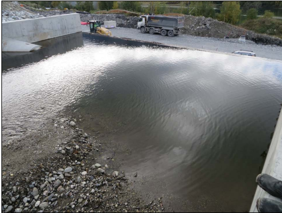
Figur 116: Sedimentasjonsdam er bygget oppstrøms ny E6 og jernbanen i sidebekk til Brandrudsåa for å fange løsmasser før de når stikkrenner under veien. (Foto: Agathe A. Hopland).
