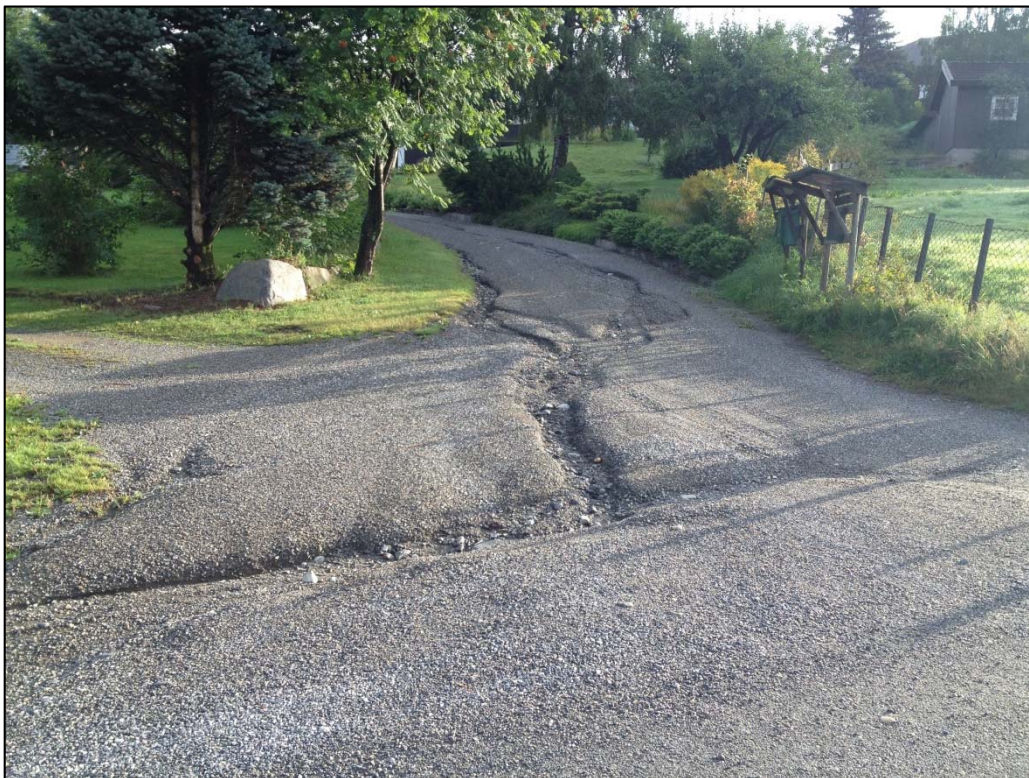
Figur 66: Mange steder rant vannet i veiene med erosjon og massetransport ned mot sentrum, da det er dårlig med veigrøfter (Foto: Steinar Myrabø).
