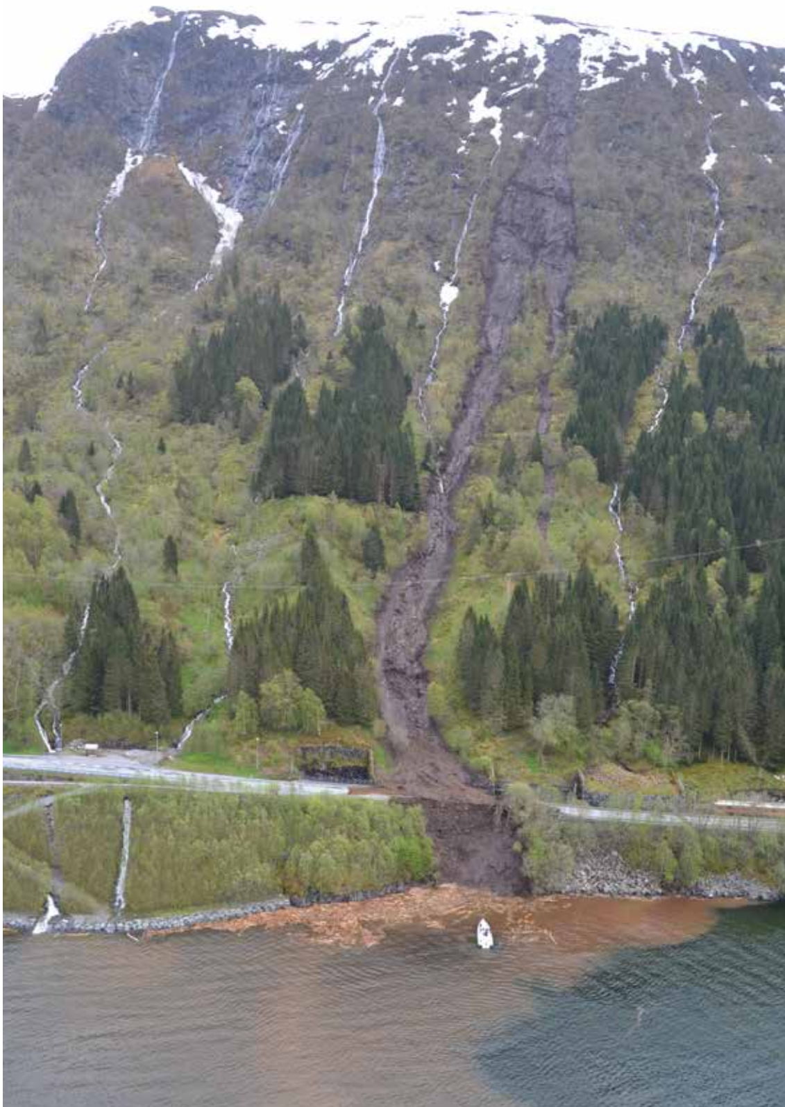
Figur 18: Skredet ved Bogelia i Vaksdal kommune 12. mai utfordret både veg og bane. Foto: Julie Bjørlien, 2015
