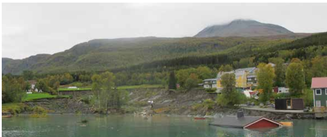
Figur 13: Kvikkleireskredet ved Lyngseidet i september 2010 gjorde stor skade på infrastruktur og bebyggelse Foto: Statens vegvesen 2010
