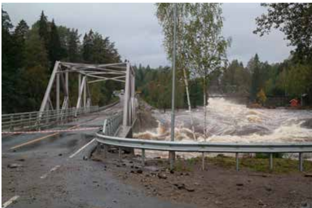
Landsverk bru, E134 Sauland kommune under flommen i september 2015.
