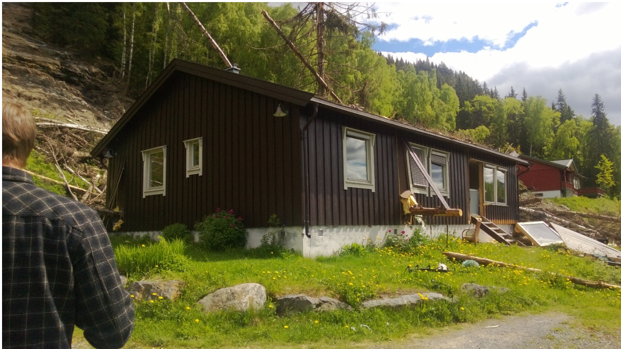
Figur 2.2. Hus truffet av jordskred med store mengder tømmer. Svenskeplassen – Nord-Aurdal kommune. Foto: Odd Are Jensen, NVE
