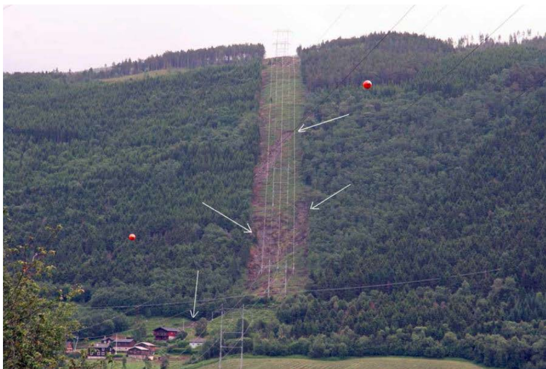
Figur 3.9. Utløsning av jordskred etter at skogen er hogd ved etablering av kraftlinje i Vågå kommune. (NGI-rapport 20120078-01-R, foto: Øyvind Olsen, Statnett)
