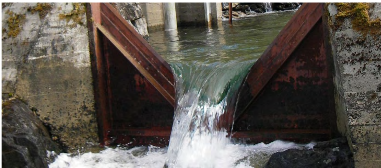
Kunstig profil, V-overløp på målestasjon 174.11 Taraldsvikelv. (Foto: NVE-HHs stasjonsbildearkiv)
