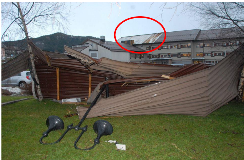
Figur 36 Skade på Vestnes sjukeheim i 2011 21
