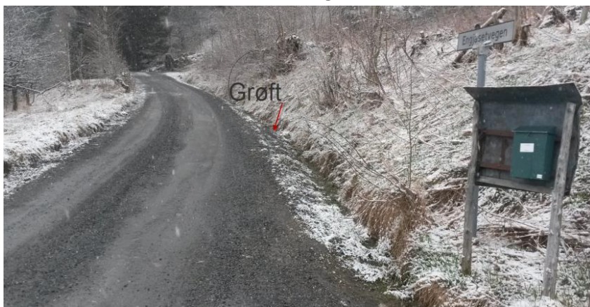
Figur 24 Eksempel på for grunn grøft langs grusvei (fra Engjasetevegen)
