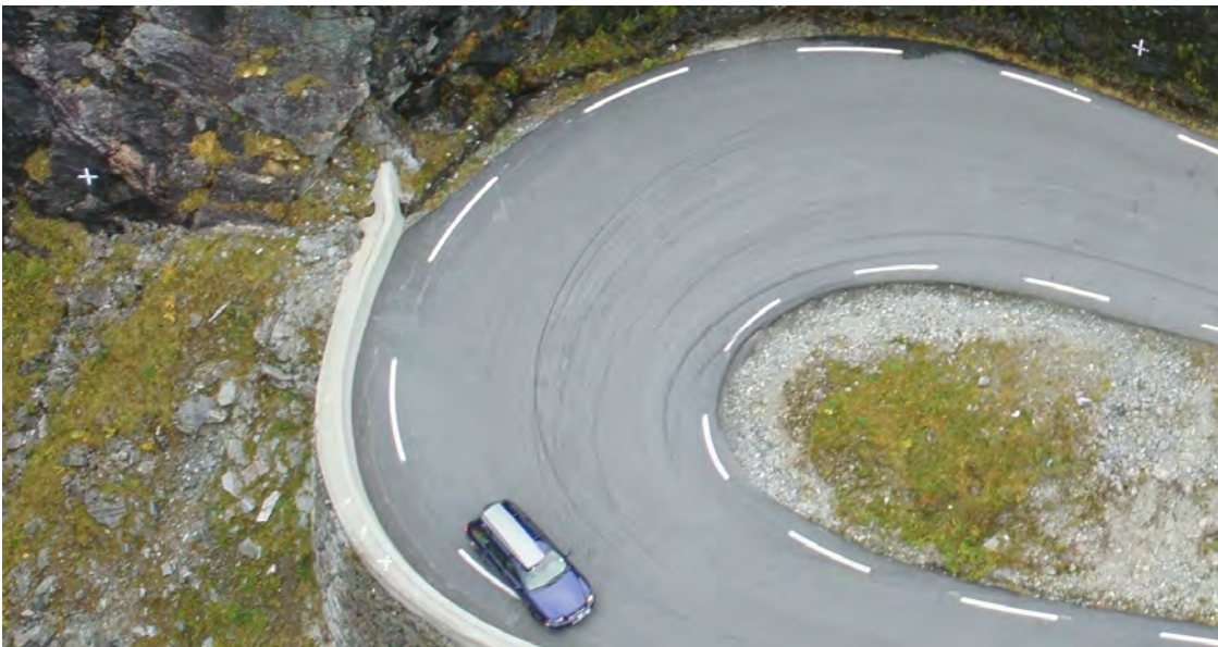
Utsnitt fra samme bilde. Her sees to av de signalerte gittpunktene (passpunktene) øverst til venstre og øverst til høyre i utsnittet.
