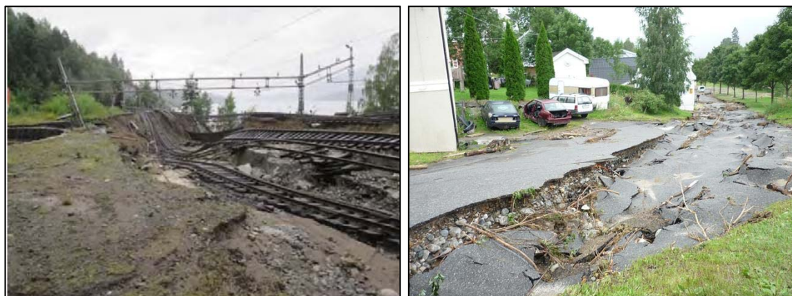
Figur 2 Skadar under flaumen i Notodden juli 2011. Venstre: Notodden jernbanestasjon (Foto: Christian Kierulf ). Høgre: Hvåladalen (Foto: Notodden kommune ).
