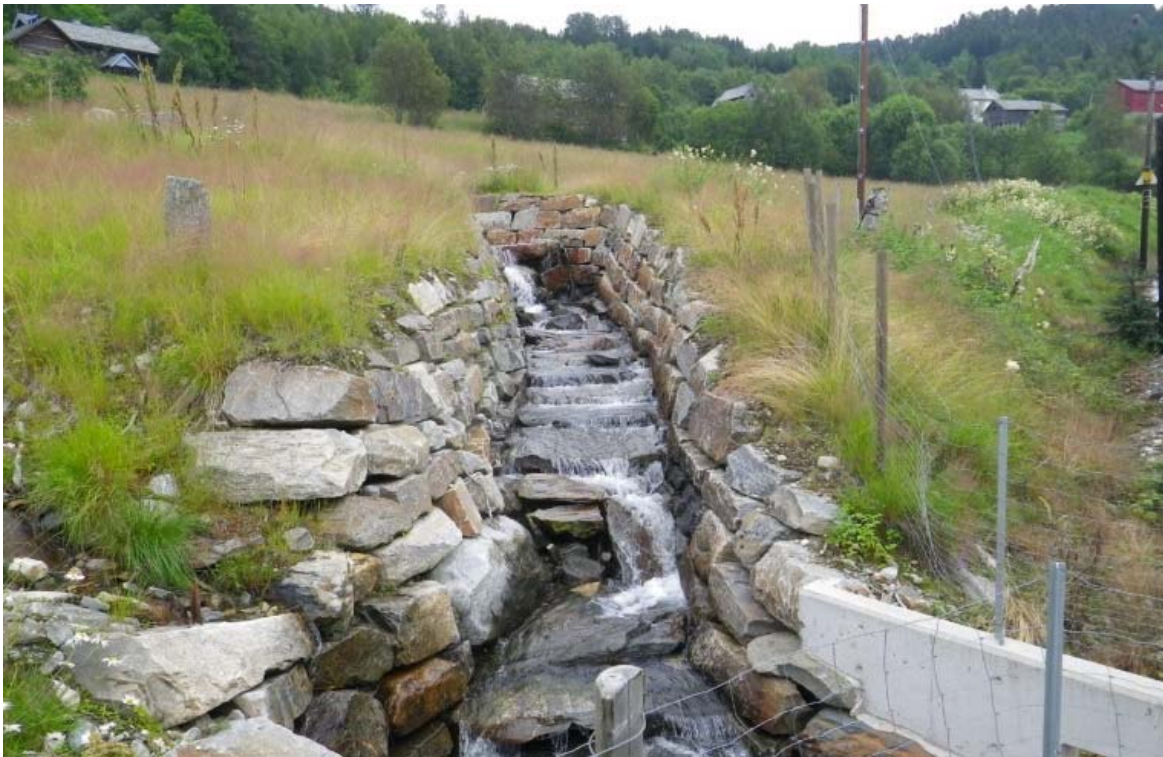
Figur 15 Eksempel på tersklar i bekk for å dempe vasshastigheit (Foto: Ole Erik Almenningen).
