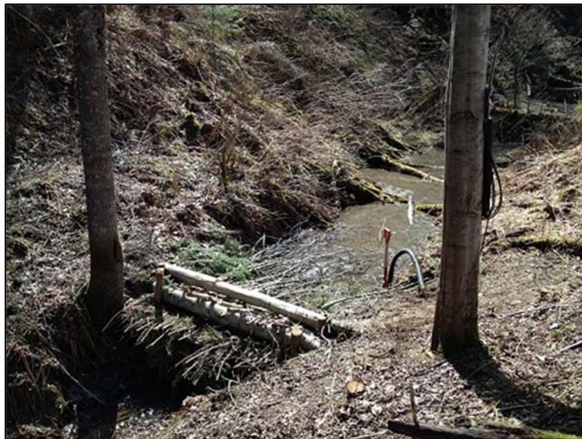
Figur 12 Kvistdammen i Minnesund, oppfylt med sediment (Foto: Bent C. Braskerud).
