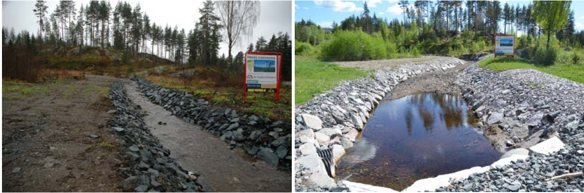
Figur 17 Eksempel på massebaseng framfor kulvert som går under E134 på Notodden (Foto: Eirik Traae).
