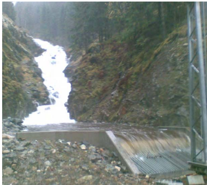
Figur 23 Rista på Langhelle ved høg vassføring. Alt som er for stort til å gå igjennom rista blir skyve over rista og lagt ut til sida (Foto: John Endre Fossmark).
