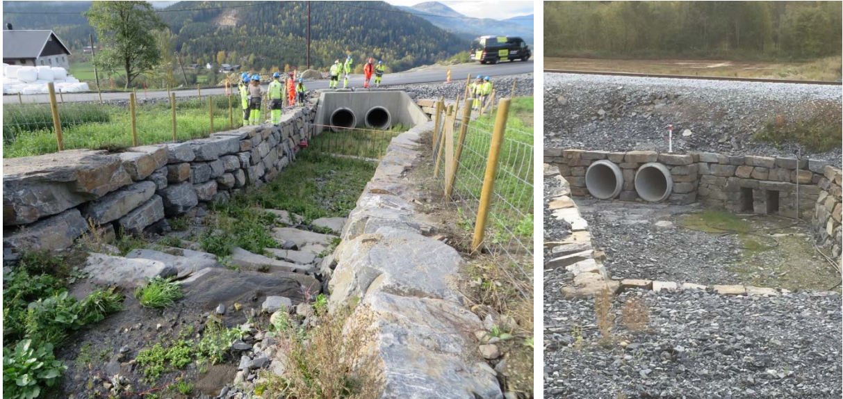
Figur 20 E6 Frya-Sjoa prosjektet i Oppland (Foto: Agathe Alsaker Hopland). Venstre: Nye stikkrenner med tersklar og grind for å hindre rask i å tette. Høgre: Nye stikkrenner under jernbana. Opphavig drenering (steinkister) til høgre for stikkrennene.
