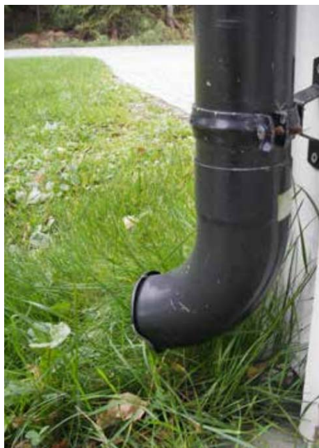
Figur 35 Fråkopla takrenne der vatnet går ut på plena i staden for i avløpsnettet (Braskerud og Skallebakke, 2013)
