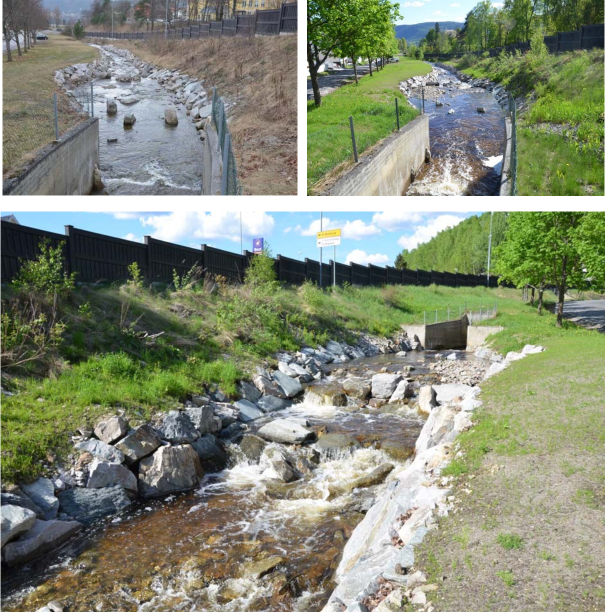
Figur 16 Sætrebekken på Notodden kor det er laga tersklar (Foto: Eirik Traae).
