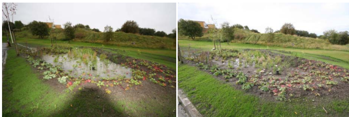
Figur 40 Venstre: Regnbed på Risvollan, Trondheim ved nedbør. Høgre: 15 timar etter nedbøren (Ekle, 2011).
