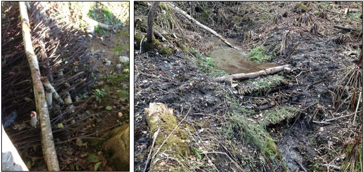
Figur 11 Venstre: Kvistdam Storlykkja i Soknedal, Sør-Trøndelag (Foto: Maria Hetland Olsen). Høgre: Kvistdam i Minnesund, bygd 2012. Bildet er tatt i 2014 og viser at kvistdammen er fylt opp av sediment (Foto: Steinar Myrabø).
