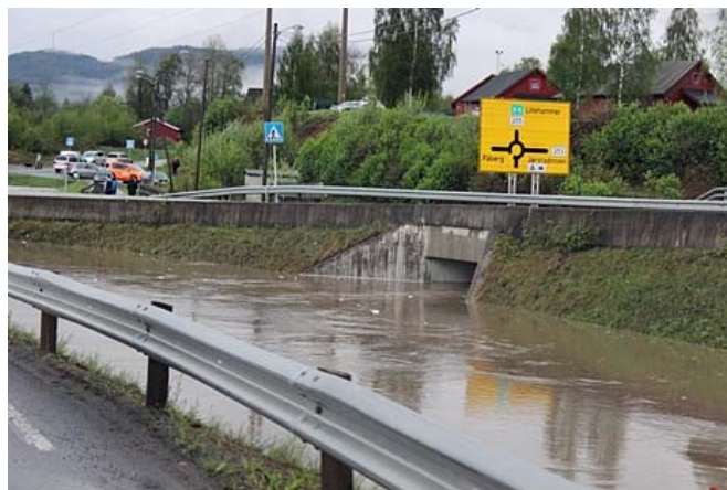
Figur 28 Undergong som fungera som alternativ flaumveg på Fåberg, Lillehammer kommune (Kilde: hest.no ).
