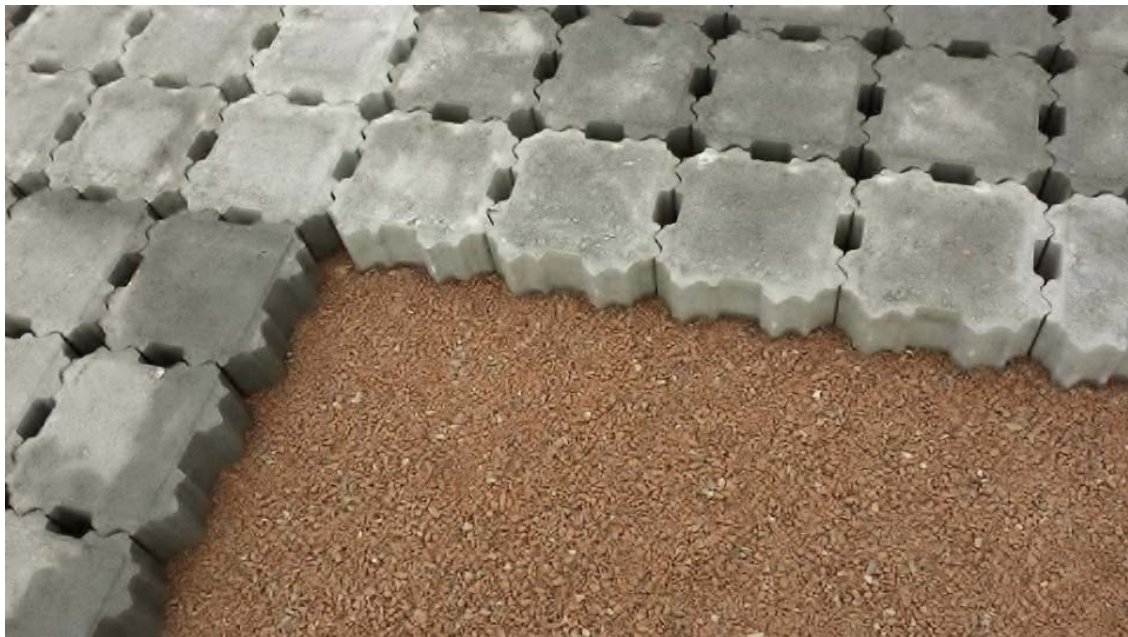
Figur 36 Eksempel på permeabelt dekke av belegningsstein (Kjelde: Lintho Steinmiljø).
