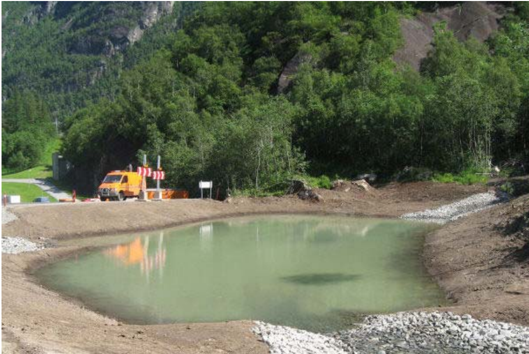
Figur 30 Fordrøyningsdam langs E136 Romsdalen (Kilde: Johs. J. Syltern ).
