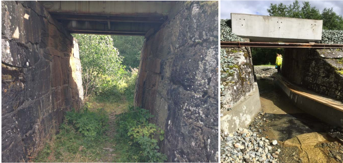
Figur 43 Venstre: Undergang under Meråkerbanen før omlegging av Ingstadbekken (Foto: Kristin Skei). Høyre: Ingstadbekken etter omlegging (Foto: Agathe Alsaker Hopland).
