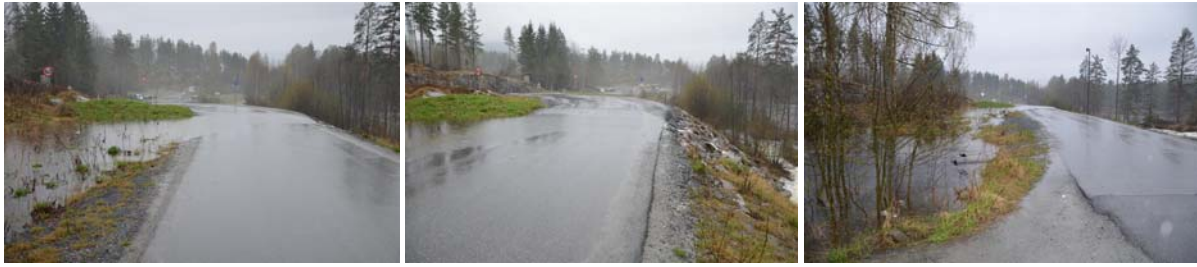
Figur 29 Jordvoll og fartshump ved Høgåskrysset i Notodden som leiar vatnet over E134 og ut i Grotbekktjønn når kullvertane går fulle (Foto: Eirik Traae).
