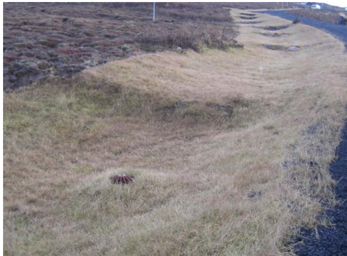
Figur 41 Eksempel på graskledd vassveg frå Urridaholt på Island (Foto: Tore Leland).
