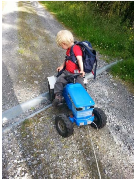
Figur 24 Dreneringsrenner av gamle autovern i skogsveg (Foto: Trude Paulsen).
