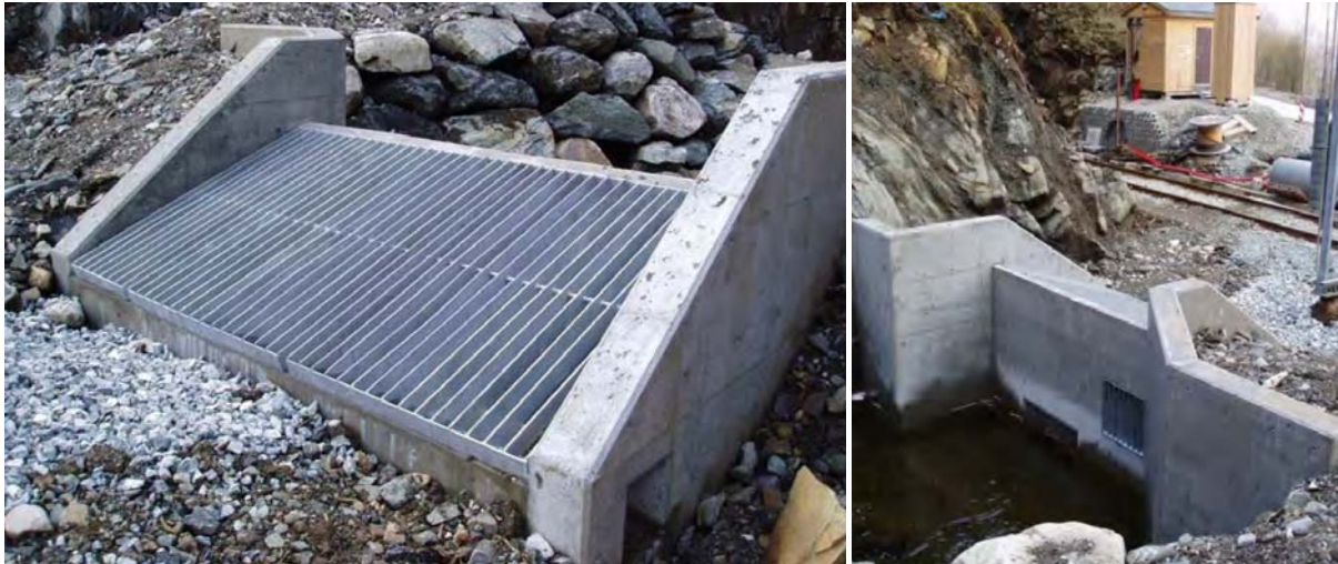
Figur 22 Sjølvreinsande rister på bekk langs jernbana ved Langhelle i Hordaland (Foto: Jeanette Gundersen).
