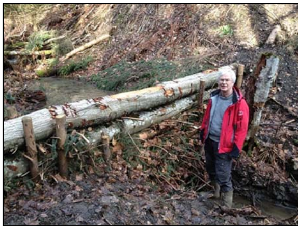
Figur 14 Miks av stokk- og kvistdam i Minnesund (Foto: Steinar Myrabø).
