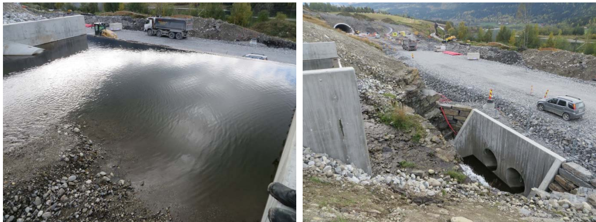
Figur 32 Sedimentasjonsbasseng langs E6 Frya-Sjoa i Oppland (sidebekk til Brandrudsåa) (Foto: Agathe Alsaker Hopland). Venstre: Sedimentasjonsbassenget er nesten fult. Høyre: Nedstrøms bassenget er to store stikkrenner som leiar vatnet under den komande E6.
