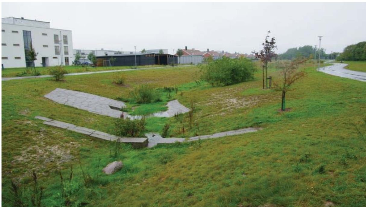
Figur 2.14: Fordrøyningsbasseng i et etablert boligområde, Malmø. (Foto: C. Ræstad).
