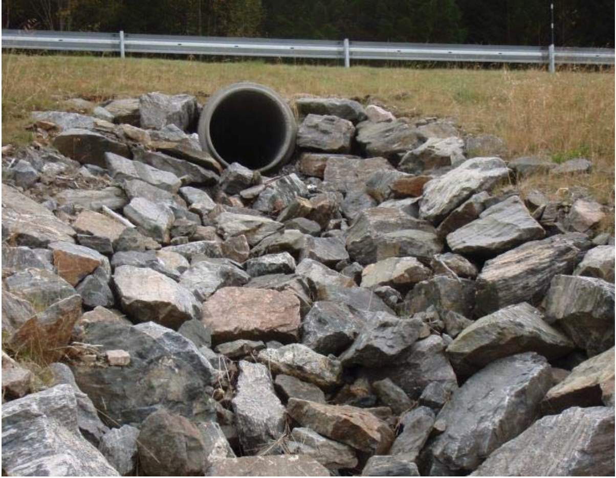
Figur 4.12: Eksempel på nedføringsrenne med stor, rauset stein. Rv 70 Tingvoll, (Foto: H. Norem).
