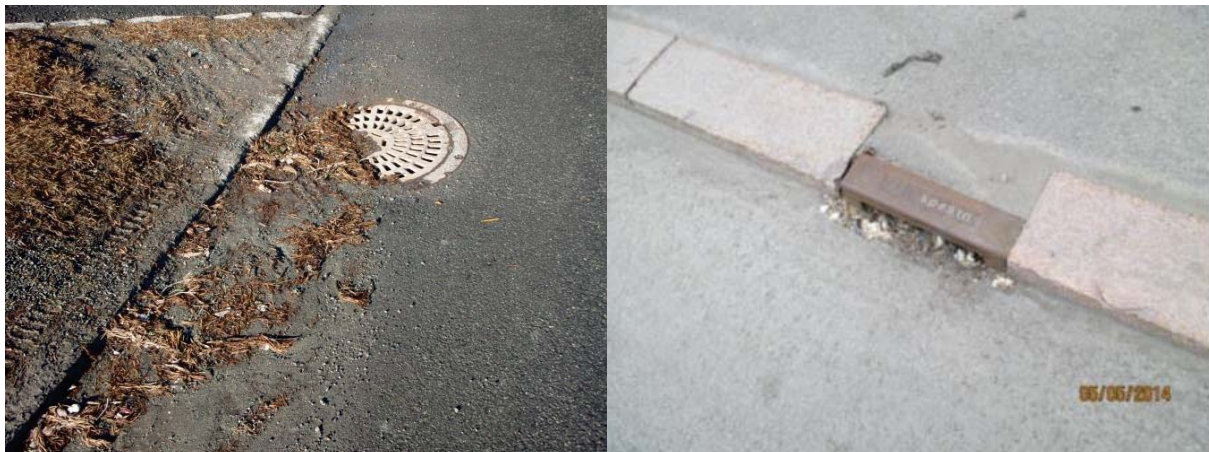
Figur 6.29: Eksempler på sirkulær slukrist og kjeftsluk. Slukrister plassert i vegbanen har tendens til å tettes igjen av løv og sedimenter. (Foto. H. Norem og G. Mosevoll).
