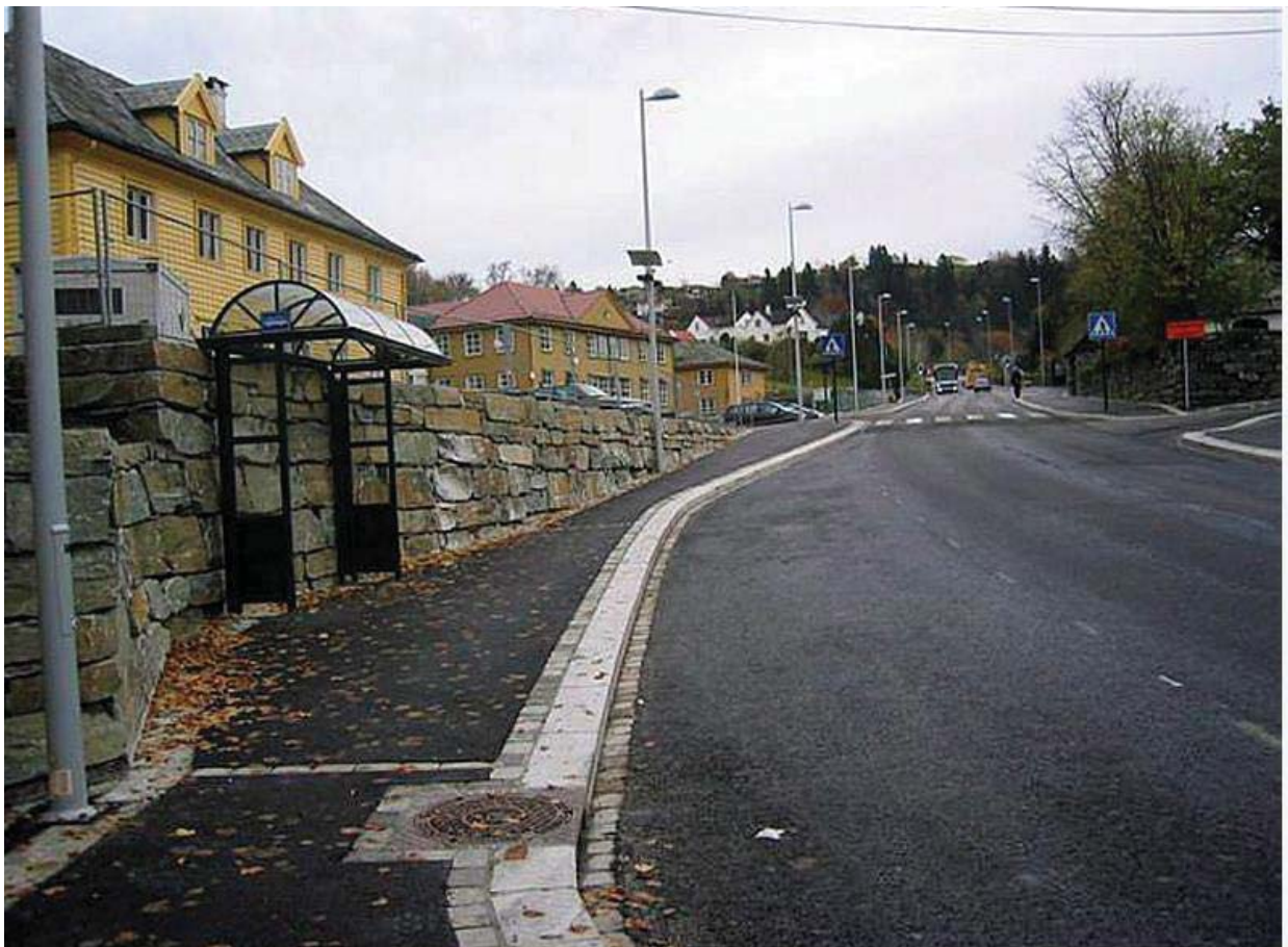
Figur 6.26: Foto av busslomme med kantstein og kombinert ristsluk på fortau og kjeftsluk i tilknytning til kantsteinen. Nestun, Bergen (foto: T. Engevik).
