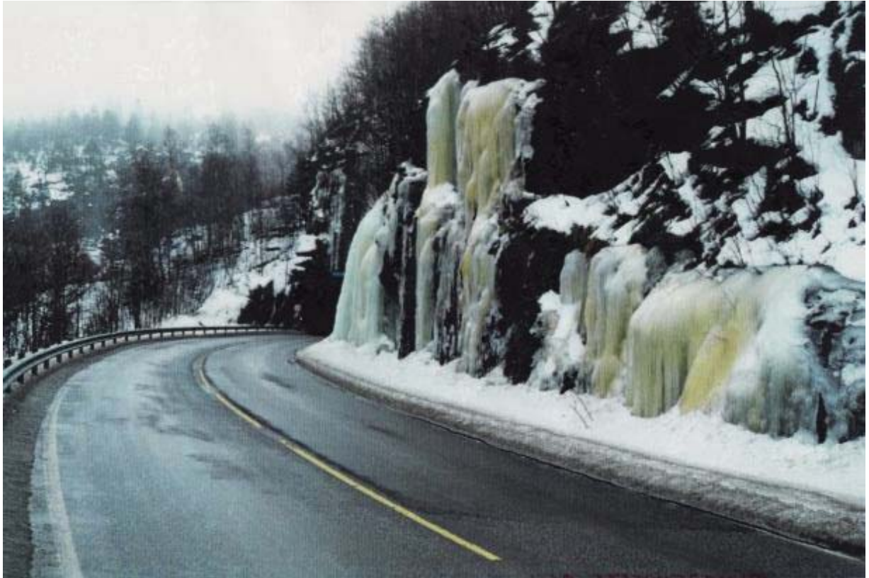
Figur 2.7: iskjøving i fjellskjæring, Rv 7, Tokagjelet, Hordaland (foto: H. Norem).
