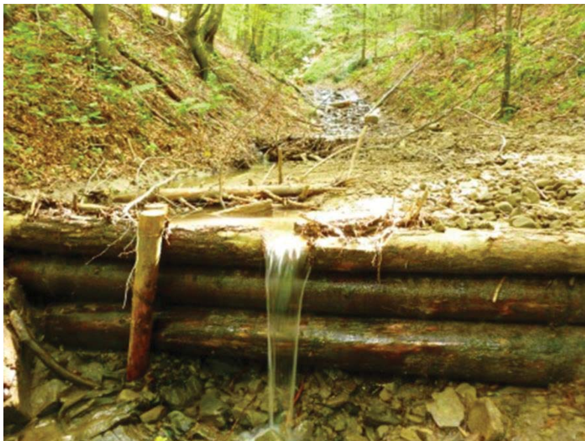
Figur 4.18: Eksempel på stokkdamm. Etter hvert som dammen fylles opp av sedimenter er det spesielt dammens evne til å fange opp sedimenter og energireducerende effekt som er viktig. Foto B. Braskerud.
