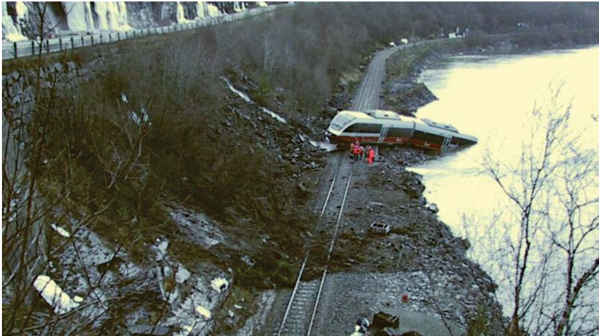
Figur 2.11: Mindre flomskred som er utløst ved utløpet av en stikkrenne for E6 og deretter forårsaket sperring av Nordlandsbanen og avsporing. (Foto: Jernbaneverket).
