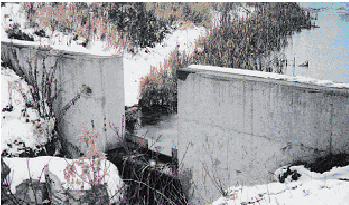
Figur 4.27: Eksempler på utløp i overvannsdammer. Vannføringen ut er begrenset ved lav vannstand og dammene har et bredt overløp dersom disse blir fylt helt opp. (Foto: S. Endresen 2006).
