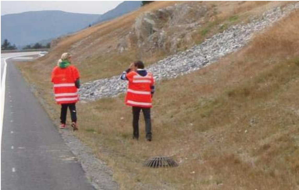
Figur 6.23: Eksempel på kuppelrist for å fange opp vann fra grunne sidegrøfter, E39, Gjemnes, Møre og Romsdal (foto: Harald Norem).
