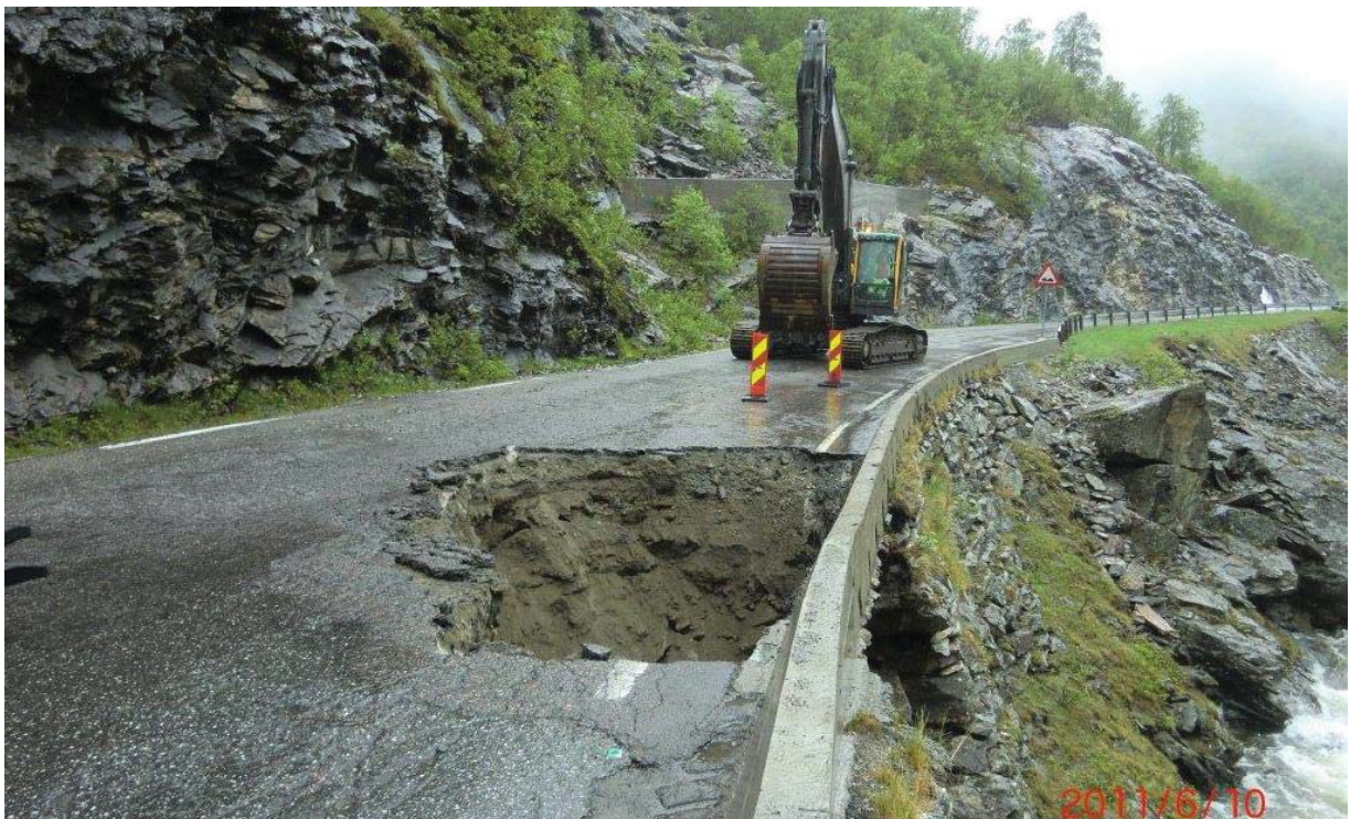
Figur 2.9: Utglidning av veg på grunn av vanntrykk mot tørrmur og store vannstrømmer ved foten av muren, E16 Borlaug, Sogn og Fjordane (foto: T. Borlaug).
