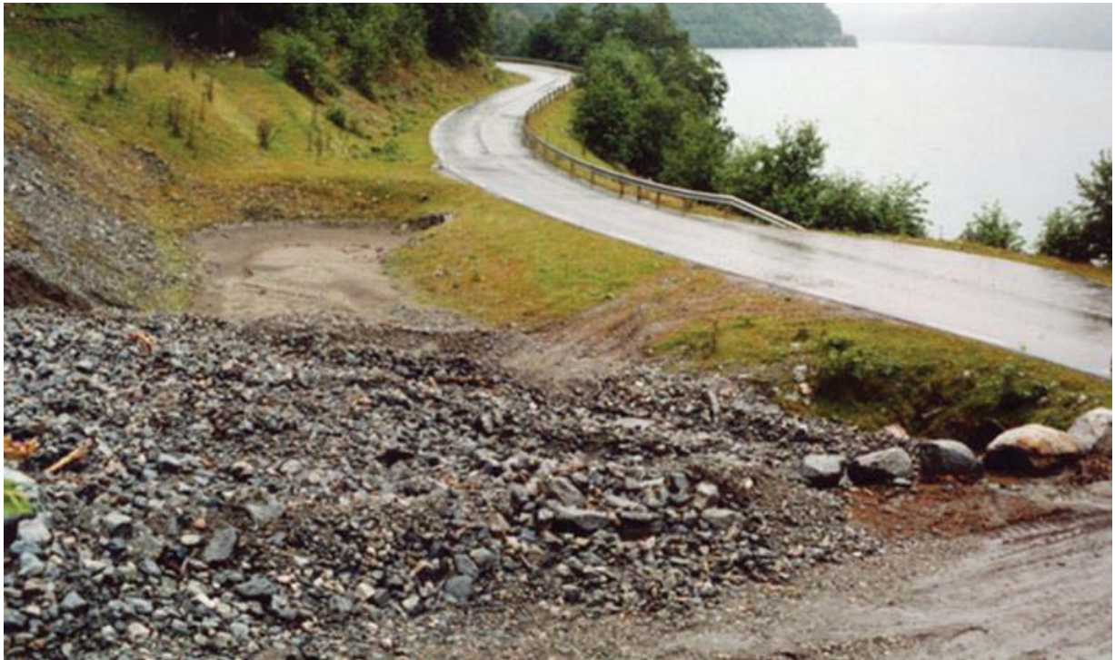
Figur 4.23: Sedimenteringsbasseng bør ha en lengde i strømningsretningen på min.5 m. Som oftest bør det også bygges en ekstra stikkrenne 15–20 m til side for hovedløpet. Fv 192 Øvre Vike, Møre og Romsdal. Foto. H. Norem.
