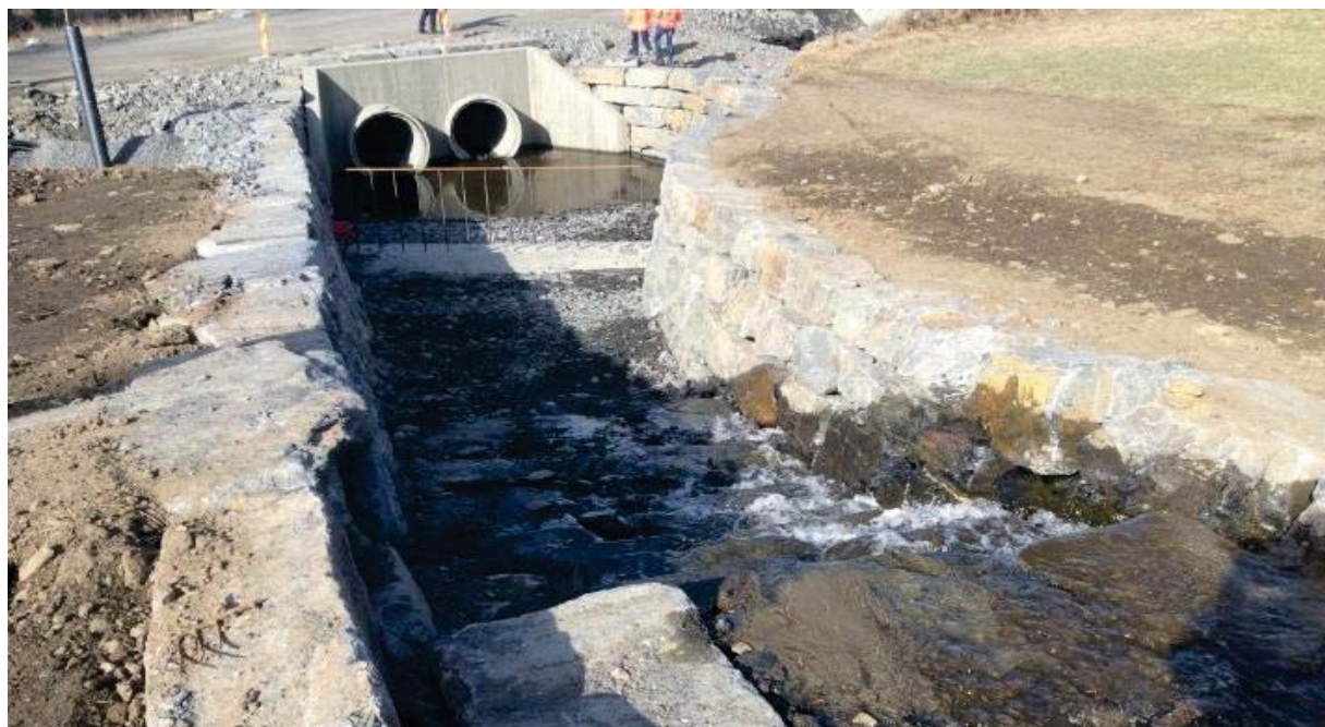
Figur 2.15: Vannveger skal håndtere dimensjonerende avrenning, hastighetsenergien og transport av sedimenter. E6-prosjektet Hundorp (foto: T. Kval).
