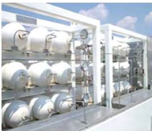
Figur 9 Lagring av CGH 2 i tanker (Kilde: h2tools.org)
