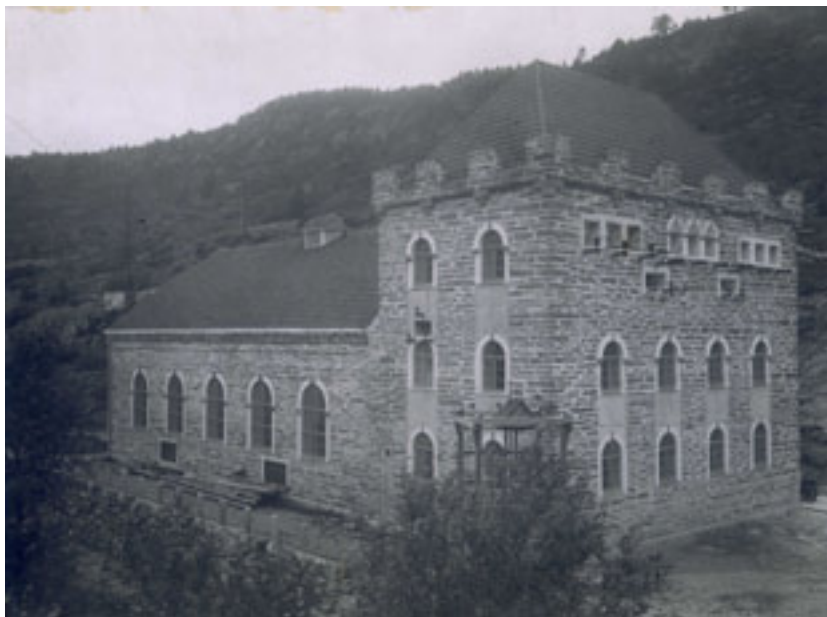
Herlandsfoss kraftverk. I dag er skyteskivene på taket fjernet ellers fremstår bygningen stort sett slik den var ny. Foto: NVEs arkiv
