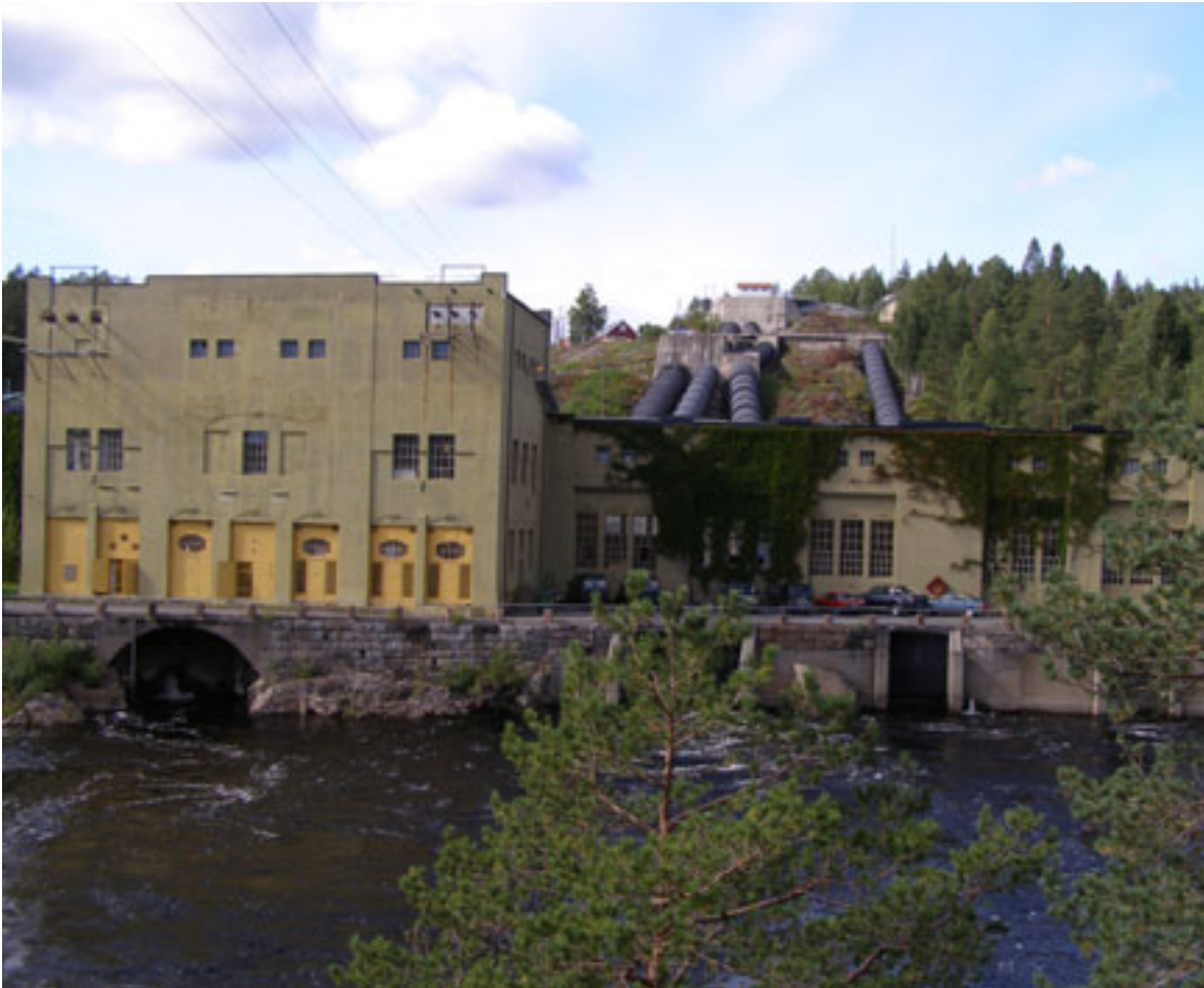
Bøylefoss kraftverk. Foto: NVE
