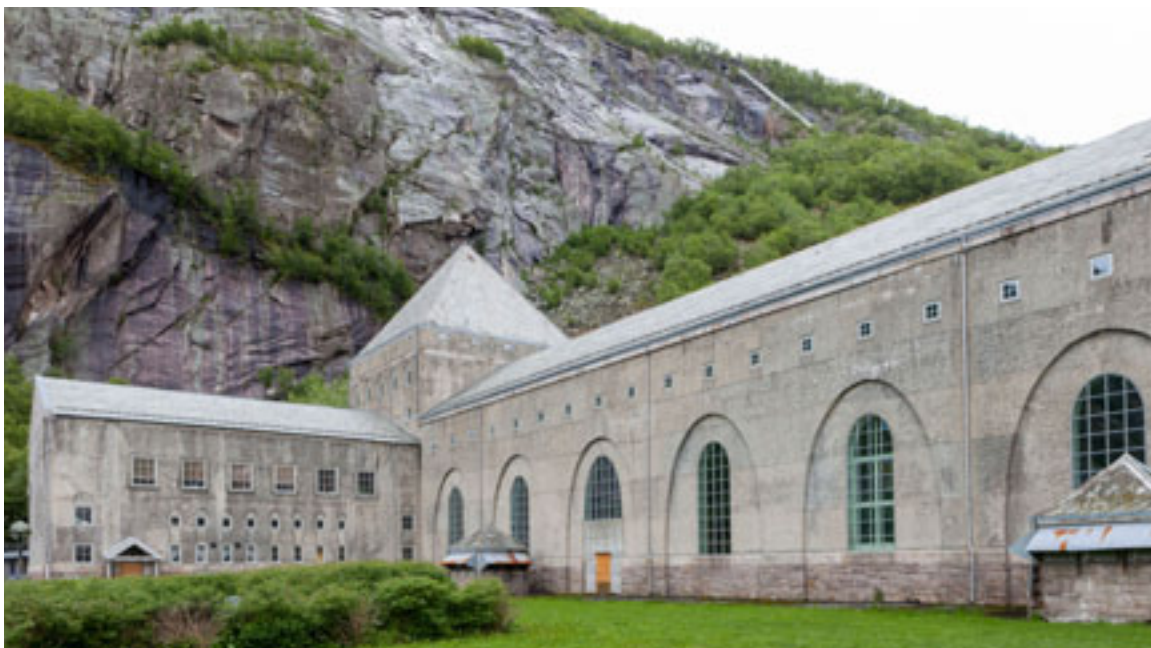
Kraftstasjon Glomfjord. Foto: Dag Endre Opedal/NVIM
