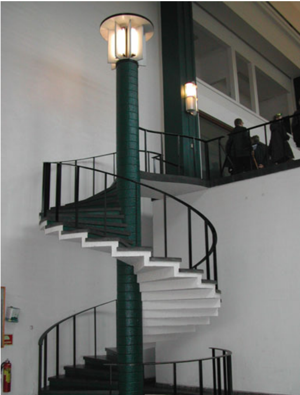
Interiør Suda III kraftstasjon. Foto: Helena Nynäs 2008/NVE
