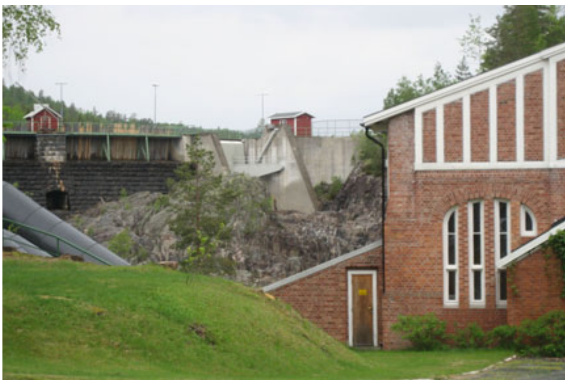
Dalsfos kraftstasjon. Foto: Helena Nynäs 2009/NVE
