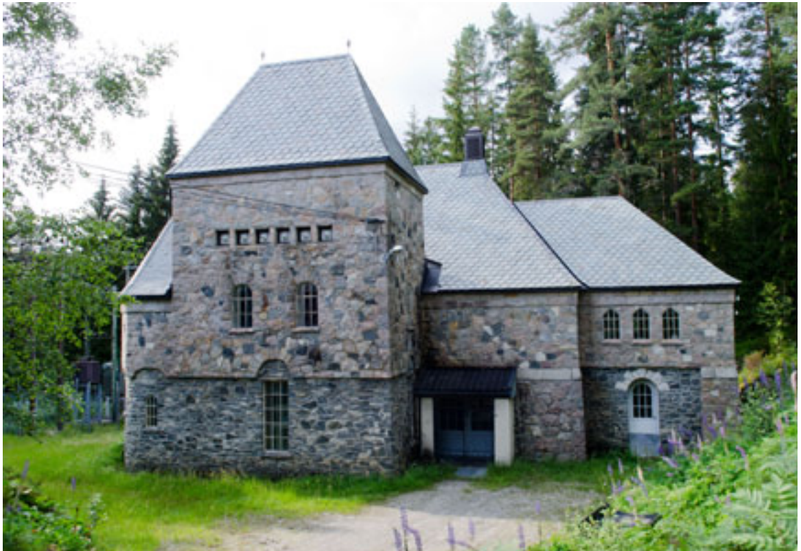
Longerak kraftstasjon. Foto: Hallgeir Vestøl/Agder Energi
