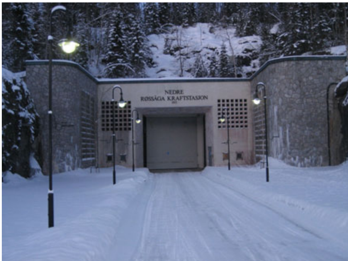
Portalen til Nedre Røssåga kraftstasjon. Foto: Helena Nynäs/NVE
