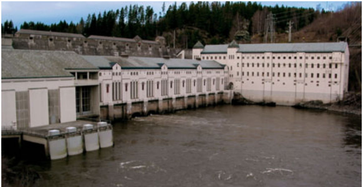
Vamma kraftstasjon fra 1914 ble utvidet i 1941. Lengst til venstre ses nybygget med det 11. aggregatet, som ble satt i drift i 1971. Alle byggetrinn er tegnet av arkitektfirmaet Astrup. Foto: Hafslund ASA
