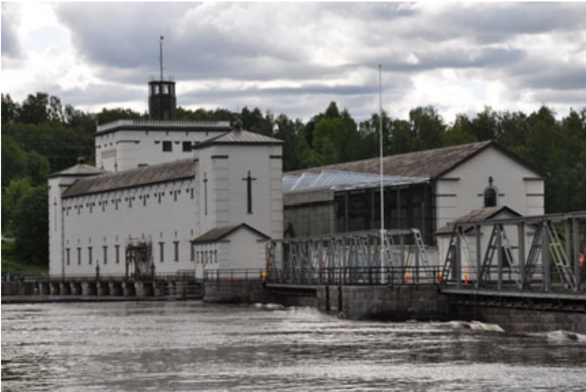
Rånåsfoss III, med ny maskinsal i midtpartiet. Foto: Helena Nynäs 2011/NVE
