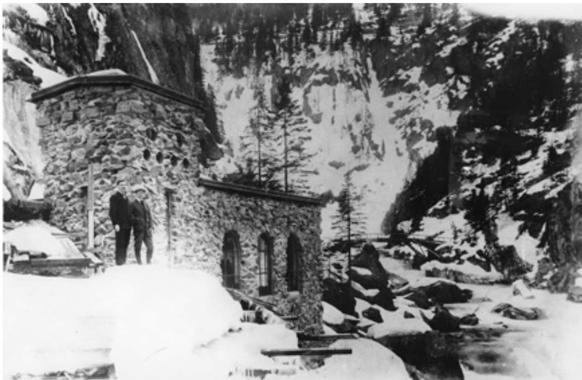
Liten kraftstasjon til anleggskraft nede i juvet på Vemork, tidlig 1900 Foto: Ukjent/Norsk Industriarbeidermuseum
