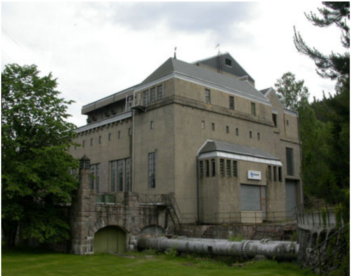
Hakavik kraftstasjon. Foto: Margrethe Moe 2003/NVE
