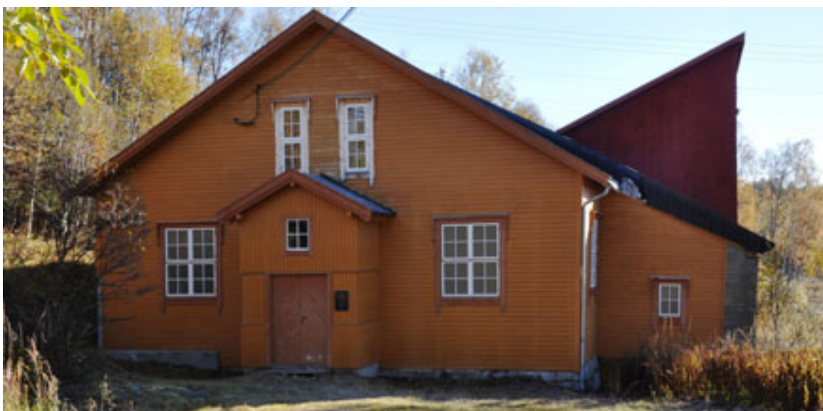
Kraftstasjonen på Kuråsfossen I. Foto: Helena Nynäs 2010/NVE
