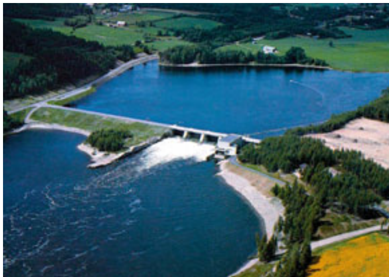
Braskereidfoss elvekraftverk. Foto: Eidsiva Energi AS
