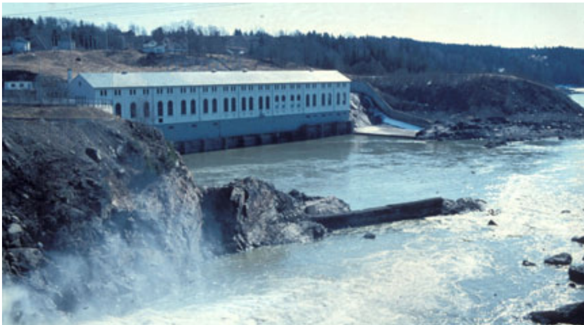
Kykkelsrud kraftstasjon . Foto: Bjarne Nicolaisen 1980/NVE
