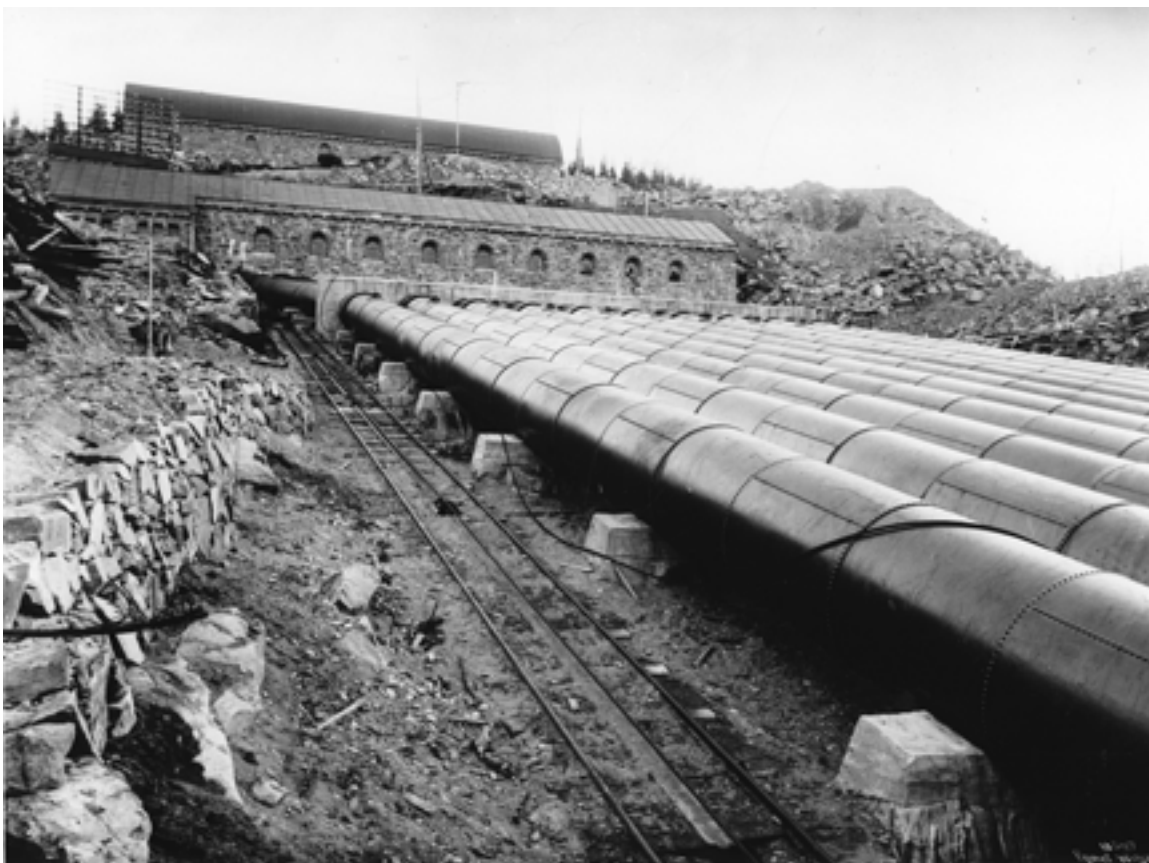
Toppen av rørgate på Vemork, tidlig 1900. Foto: Wilse/Norsk Industrierbeidermuseum
