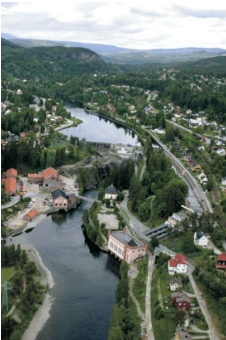
Tinfos-anleggene på Notodden med kraftproduksjon siden 1894.
