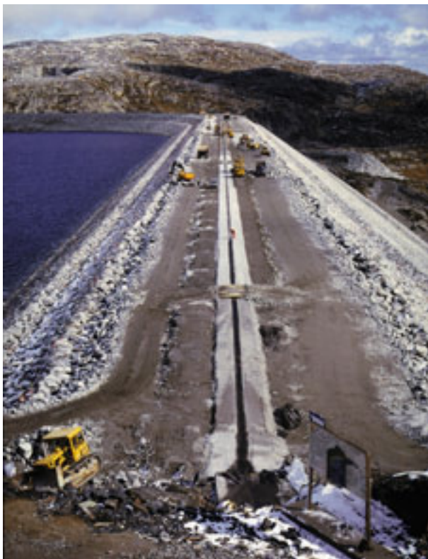
Storvassdammen (Ulla-Førreverkene) under bygging med asfaltkjerne. Foto: Knut Ove Hillestad/NVE
