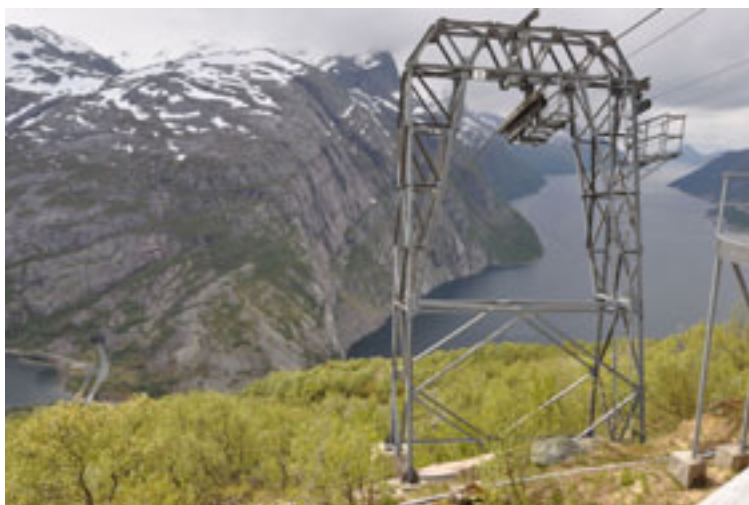
Taubane ved Glomfjord kraftverk. Foto: Helena Nynäs 2010/NVE
