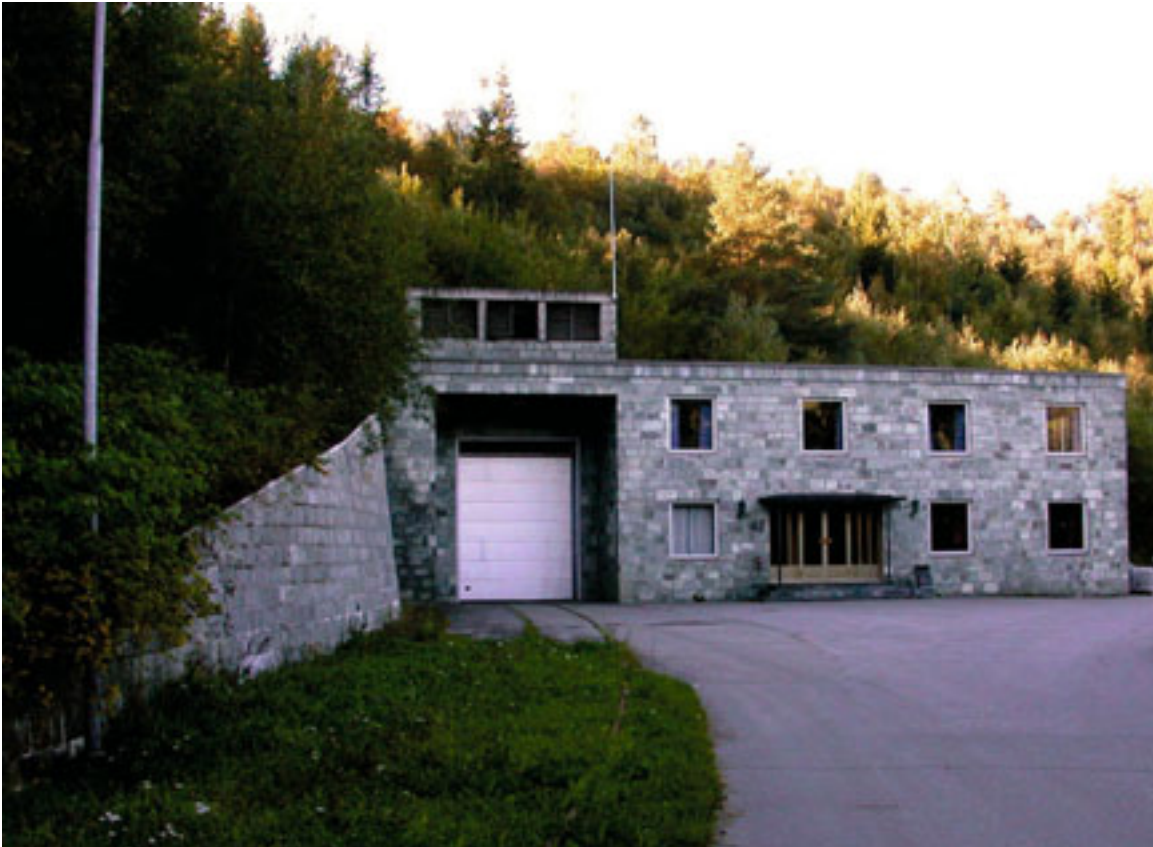
Inngangsparti til Nedre Vinstra kraftstasjon. Foto: Margrethe Moe 2004/NVE
