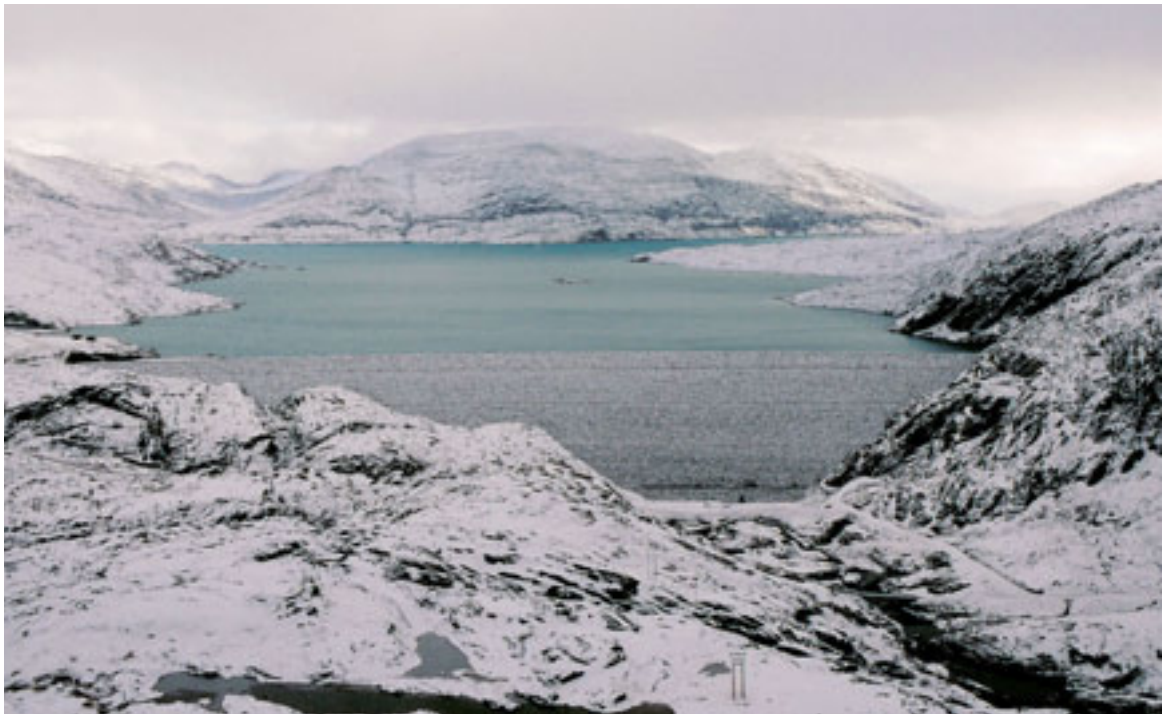
Storglomvatnet er Norges største magasin i volum med 3 500 mill m 3 . Dammen er 125 meter høy og 825 meter lang. Foto: Statkraft
