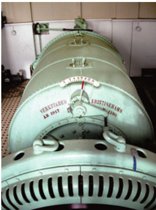
Horisontal Francis-turbin produsert av Verkstaden Kristinahamn for Skjefstadfoss kraftverk. Foto: NVE
