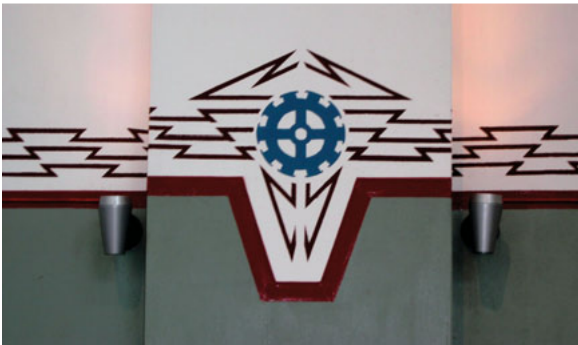
Detalj av brystningen etter utført restaureringsarbeid. Foto: Harald Hognerud/NVIM
