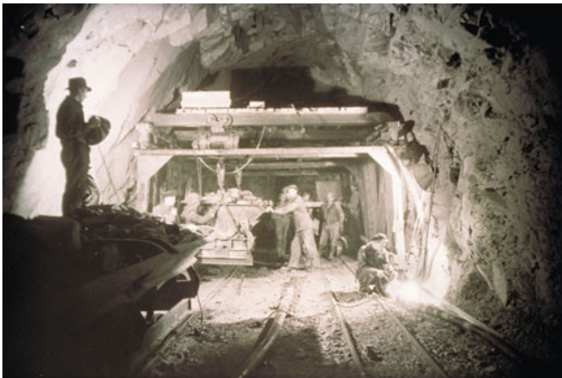
Vanntunnel under bygging (Noreverkene). Foto: Statkraft
