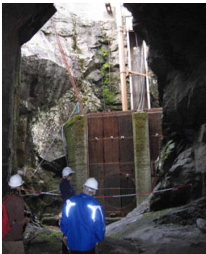
Vannveiens overgang fra tunnel til rørene som førte vannet ned til kraftstasjonen Tyssø I nede ved Sørffjorden i Hardanger. Fallhøyden var 400 m. Anlegget ble fredet i 2000.
