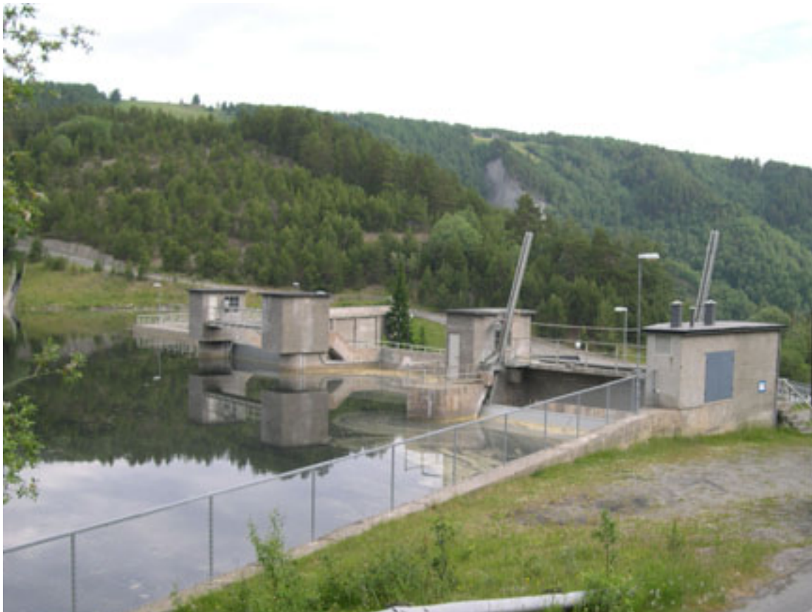
Lamelldam ved Nedre Vinstra kraftverk. Foto: Jens Nicolai Thom 2009/NVE
