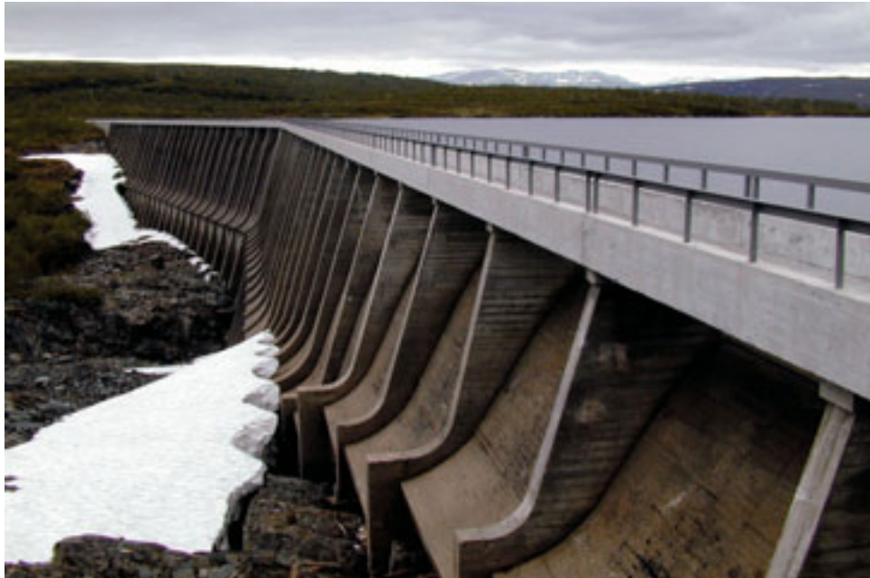
Dammen ved Vessingsjø. Foto: Trondheim Energiverk
