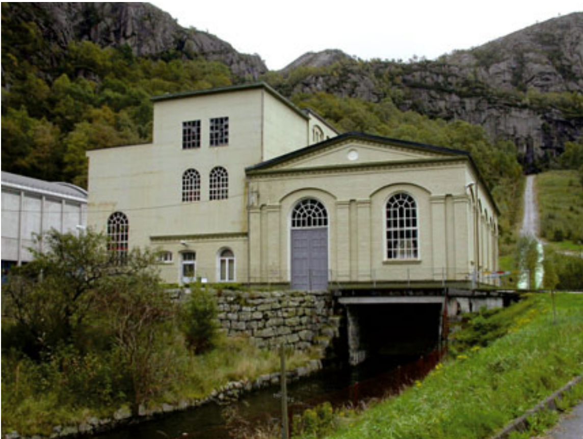
Kraftstasjonsbygningen fra 1905. Foto: Margrethe Moe 2004/NVE
