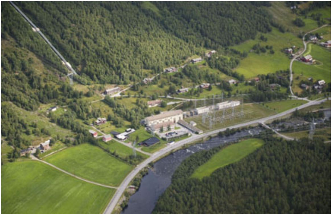
Kraftverket Hol I med rørgate, kraftstasjonsbygning og utgående kraftlinjer. Helt til høyre i bildet sees utløpet fra stasjonen i elva. Foto: E-CO Energi
