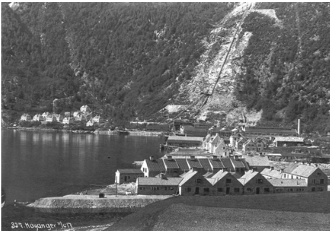
Høyanger anno 1917. Anleggsarbeidene med rørgaten er påbegynt og enkelte boliger og andre bygninger er under oppføring. Foto: Ingeniør Chr F Grønners Stiftelse
