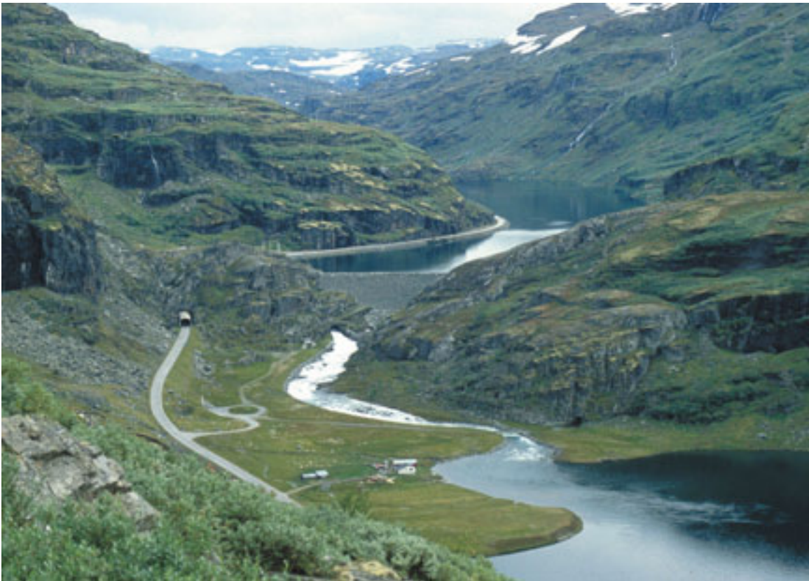
Utbyggingen av Aurlandsvassdraget medførte en rekke inngrep i fjellområdet som inntil da var nærmest uten tekniske inngrep. Foto: Per Einar Faugli/NVE
