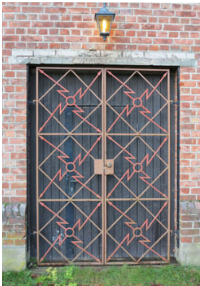
Detalj ved Hammeren kraftverk. Foto: Helena Nynäs 2012/NVE
