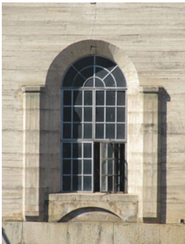
Detalj fra Solbergfoss kraftstasjon. Foto: Helena Nynäs/NVE
