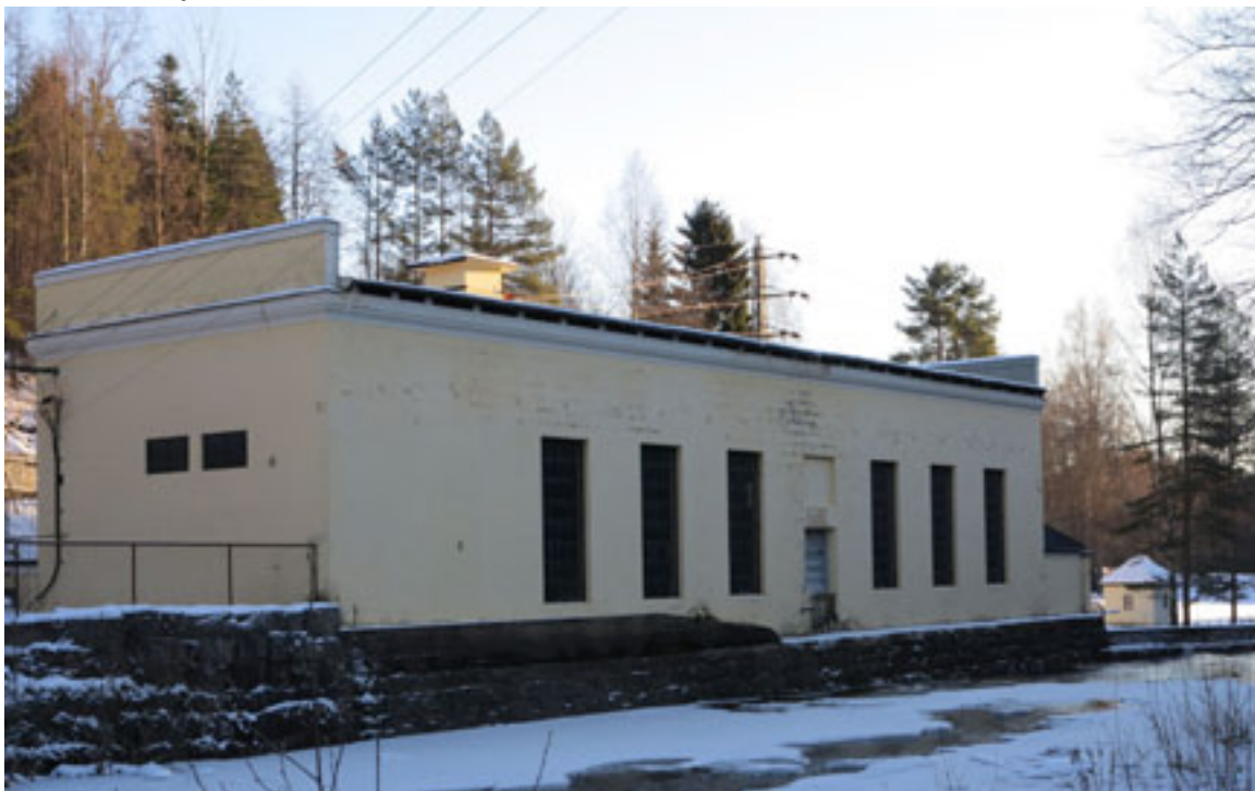
Hammeren kraftstasjon. Foto: Helena Nynäs 2012/NVE
