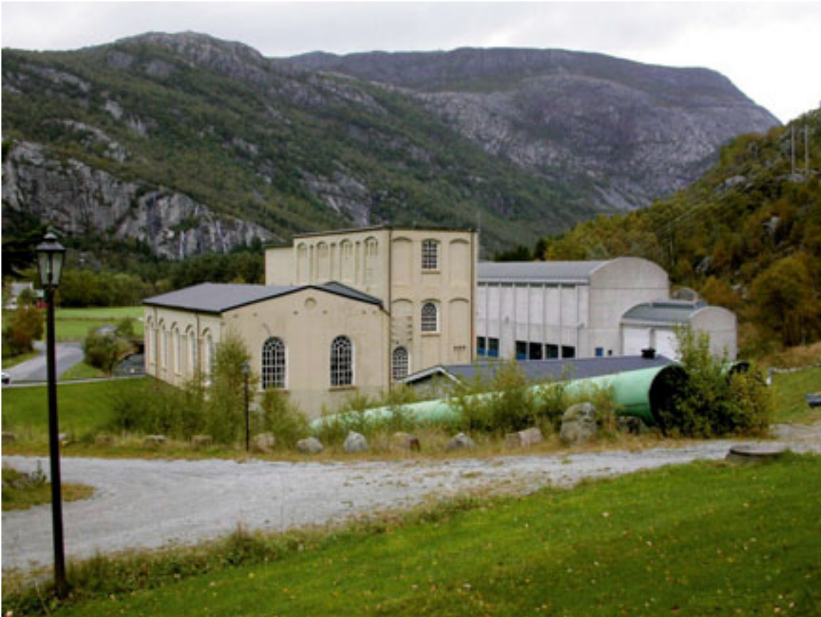
Gammel og ny Oltedal kraftstasjon. Foto: Margrethe Moe 2004/NVE
