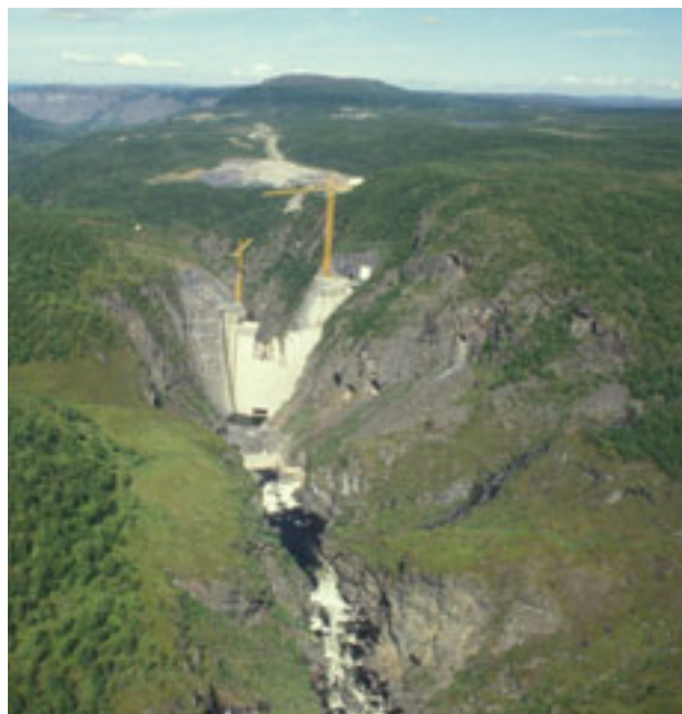
Altadammen under bygging. Foto: Knut Ove Hillestad/NVE
