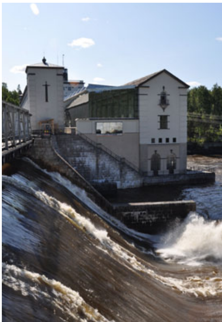
Rånåsfoss kraftstasjon sett fra dammen.
