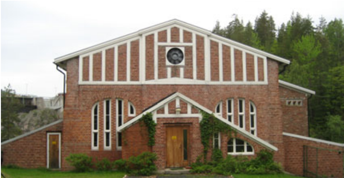
Dalsfos kraftstasjon. Foto: Helena Nynäs/NVE, 2009
