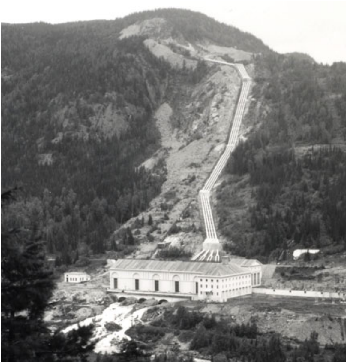
Kraftanlegget Nore I kom i drift i 1928. Foto: Ivar Aasen – Buskerud fylkesarkiv.
