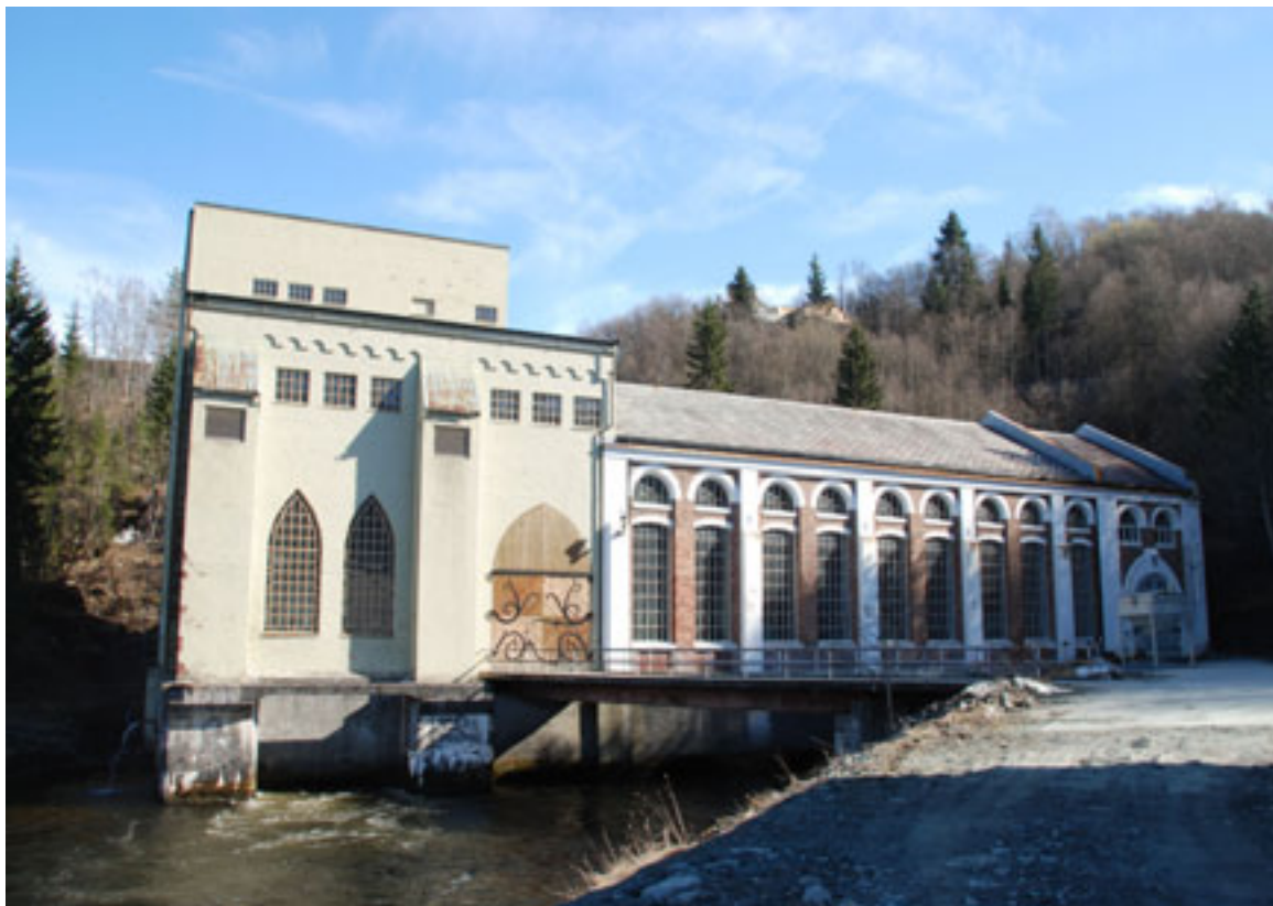
Øvre Leirfoss kraftverk. Foto: Elisabeth Hovås/NVE, 2009
