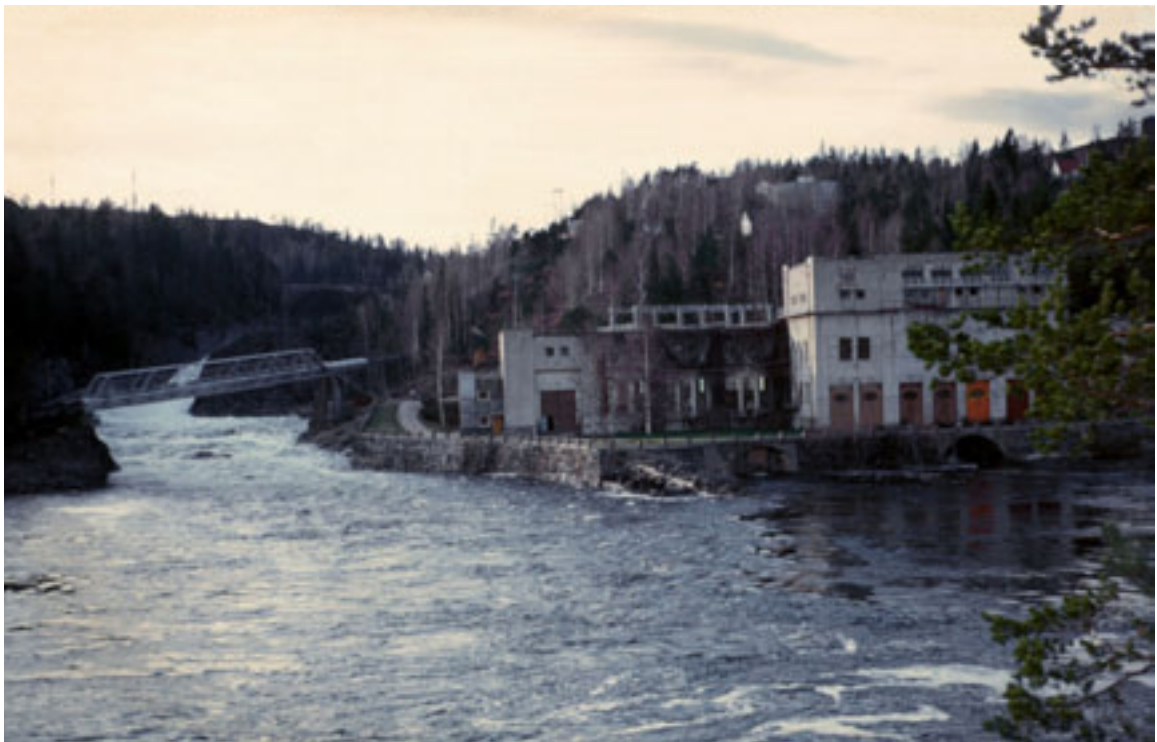
Bøylefoss kraftstasjon. Foto: Rolf M. Krogh 2010/NVE
