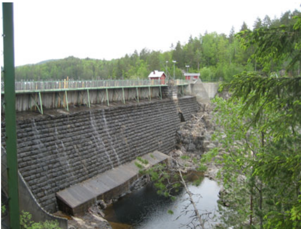
Dam Dalsfos med nålestensel. Foto: Helena Nynäs 2009/NVE
