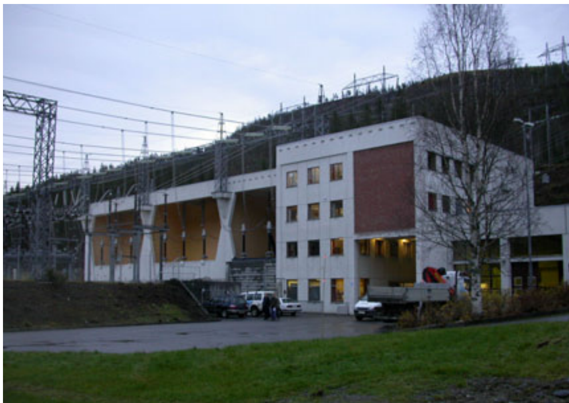
Koblingsanlegg i friluft ved Tunsjødal kraftanlegg i Nord-Trøndelag. Foto: NVE
