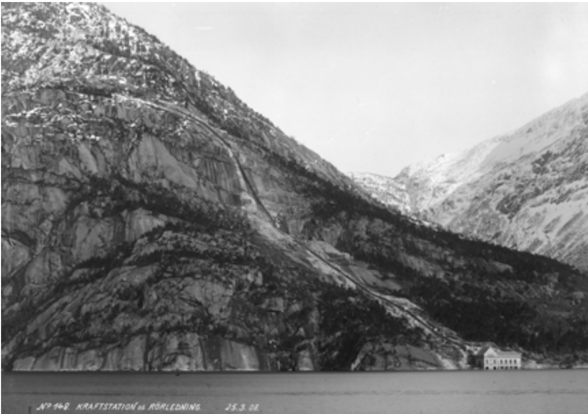
Kraftstasjonen Tysso I ble satt i drift 4. mai 1908. Den ble utvidet i flere byggetrinn. Foto: K. Knudsen & Co, Bergen/Statkrafts fotosamling
