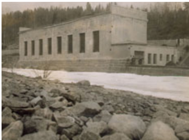
Hammeren kraftstasjon anno 1900. Foto: NVE
