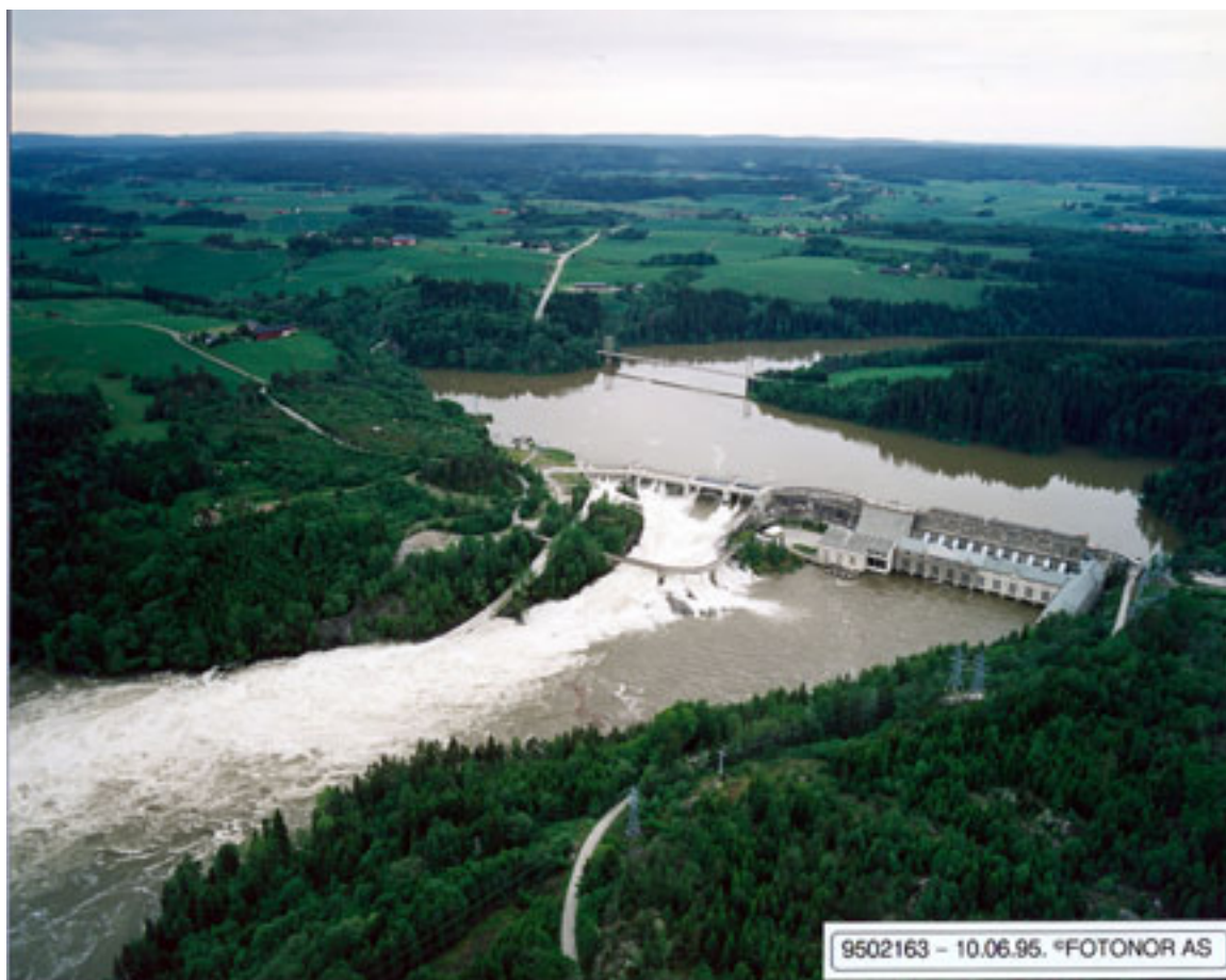
Vamma kraftanlegg under storflommen i 1995. Flyfoto: ©Blom Geomatics AS
