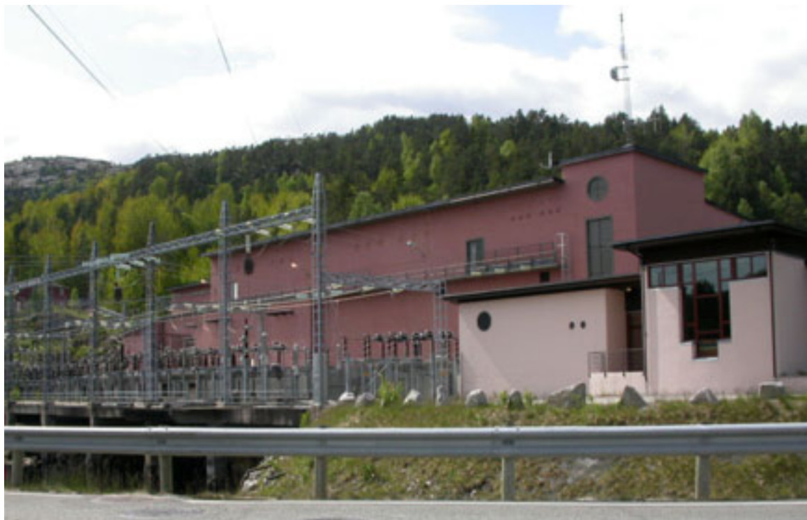
Skjerka kraftstasjon. Foto: NVE
