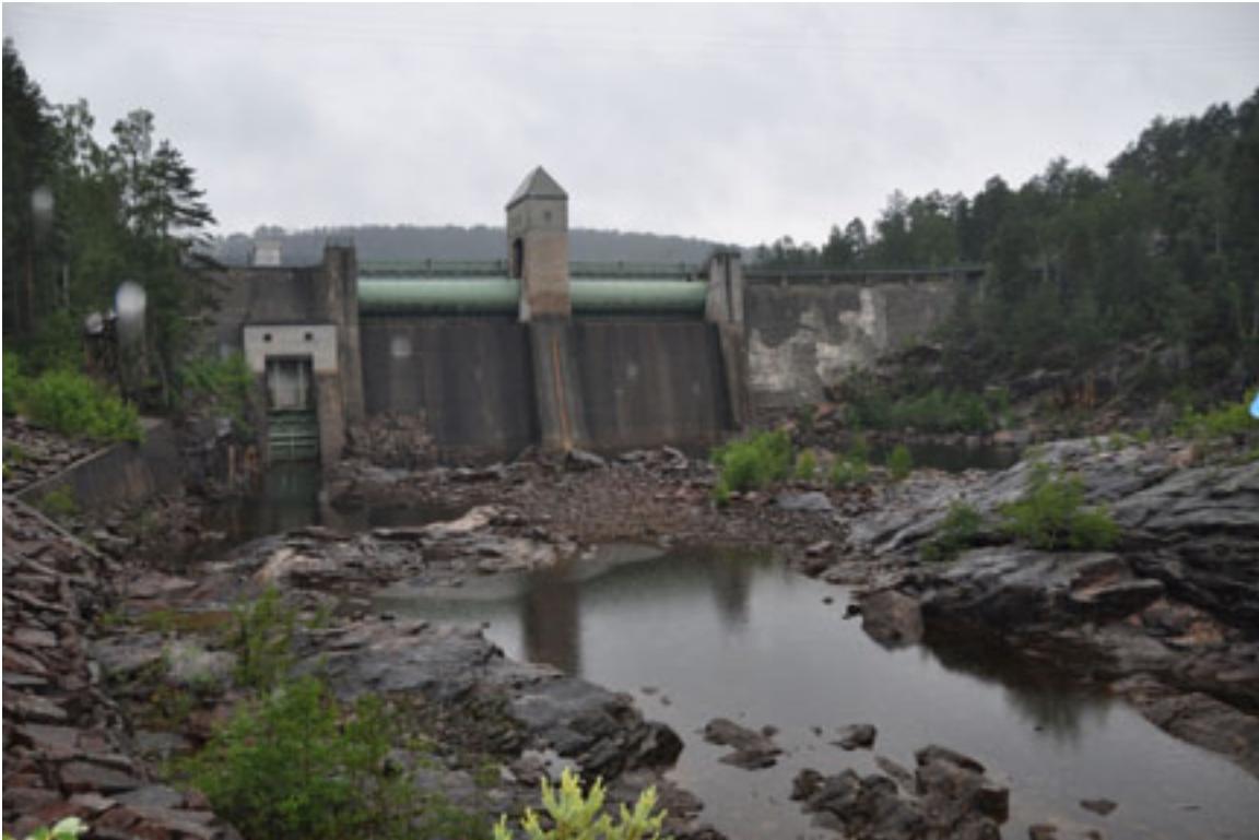
Dammen ved Nomeland kraftverk. Foto: Helena Nynäs 2011/NVE
