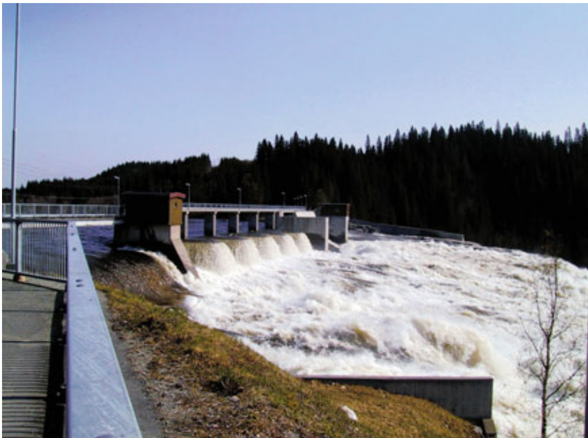
Dammen ved Nedre Fiskumfoss ved stor vannføring. Foto: Nord-Trøndelag Elektrisitetsverk
