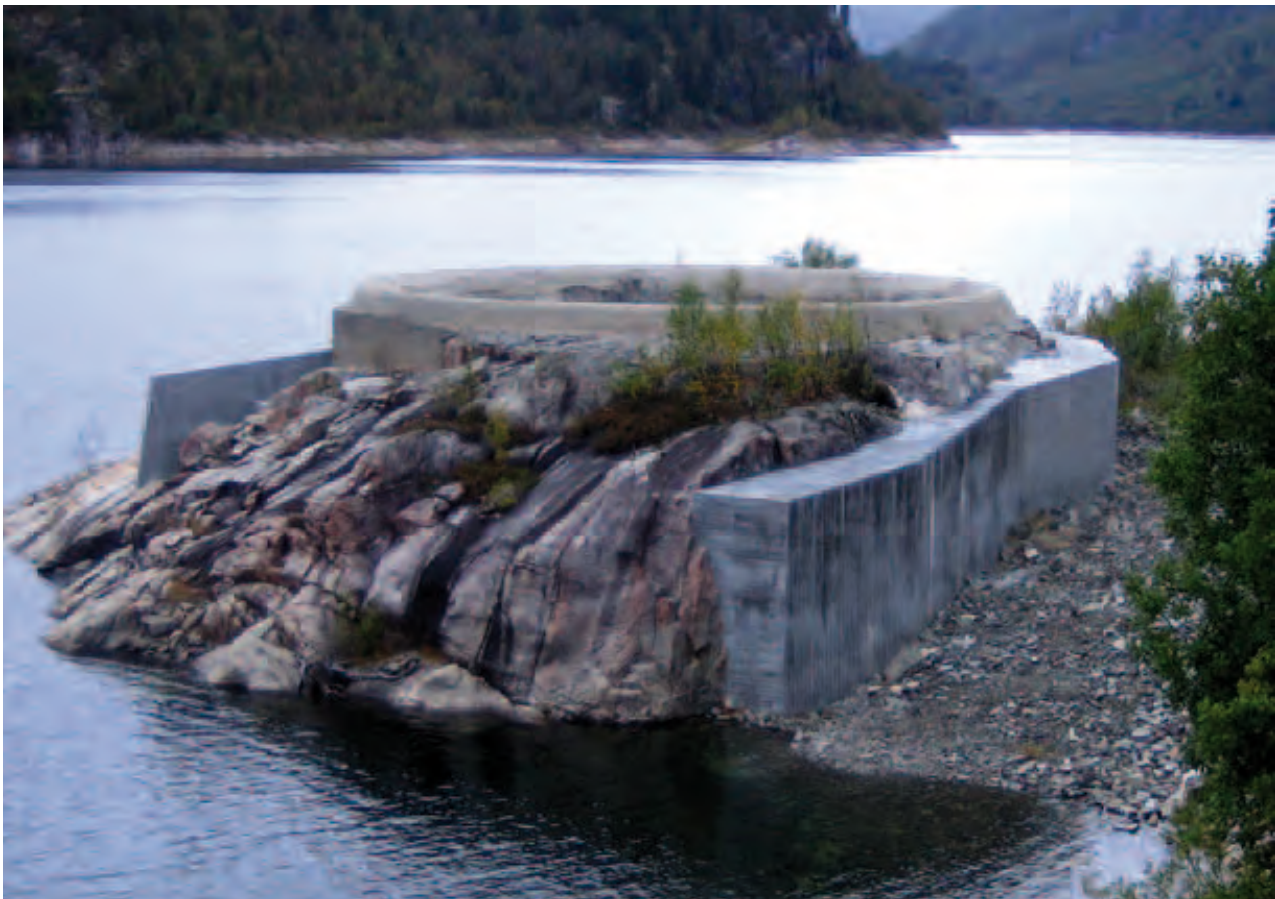
Overløpet "Morning glory spillway" under lav vannstand, august 2008.
