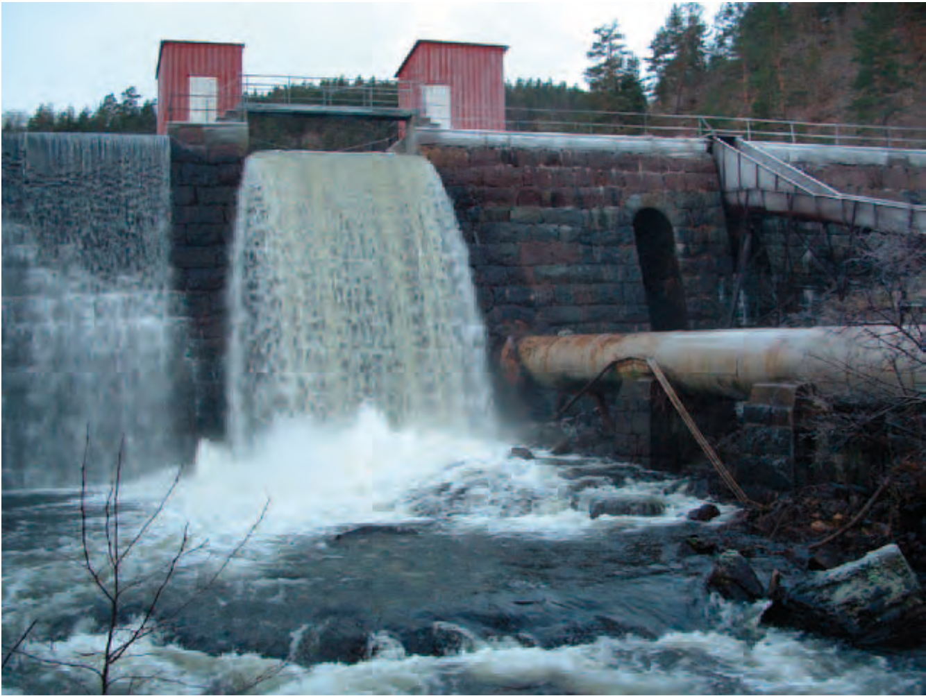
Kongens Dam fra 1903 ved Bamble bruk i Herrevassdraget, Telemark.
