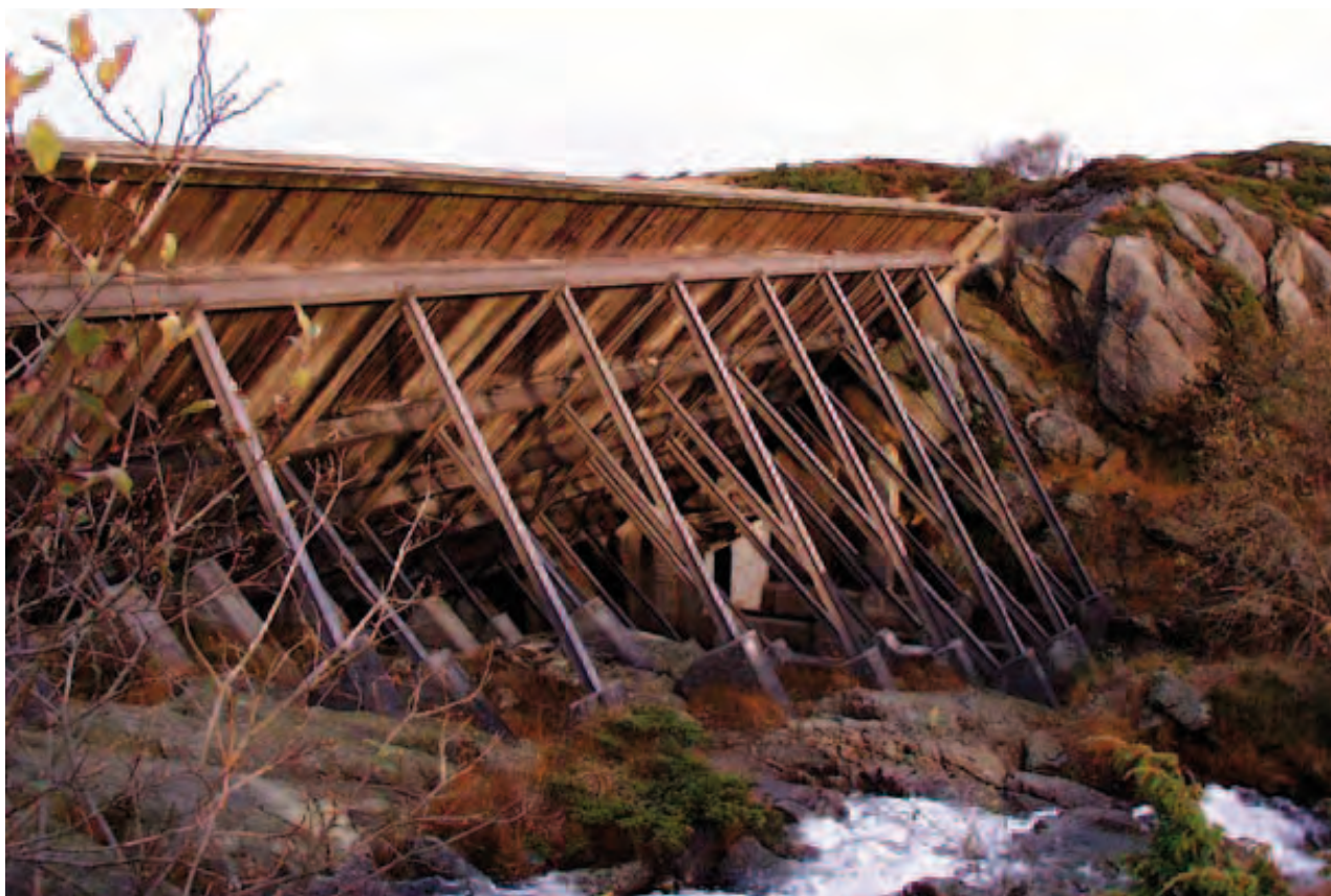
Trebukkedam til formål vannforsyning ved Tistreidvatn, Karmøy, Rogaland
