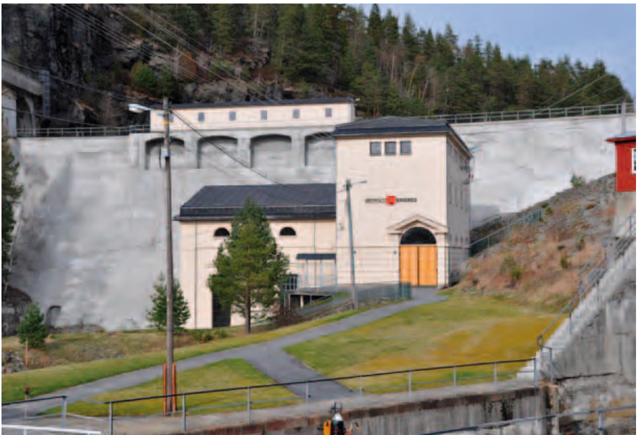
Dam og kraftstasjon med Brekke sluser på sydlig side.
