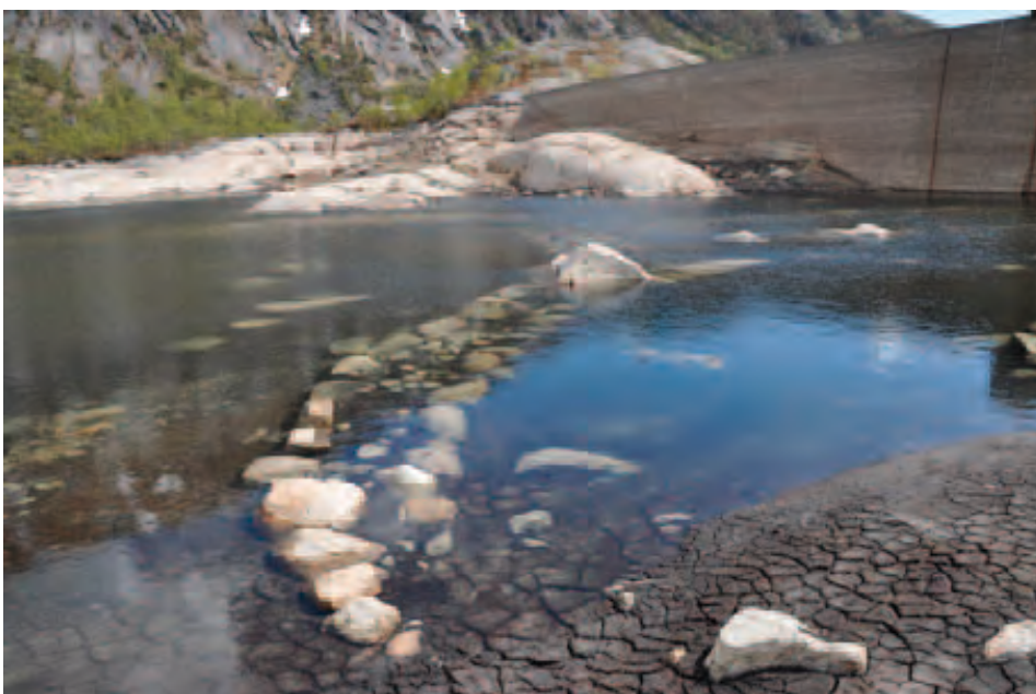
En eldre murdam synlig under lav vannstand i Valedalsvatn, Kvinnherad.
