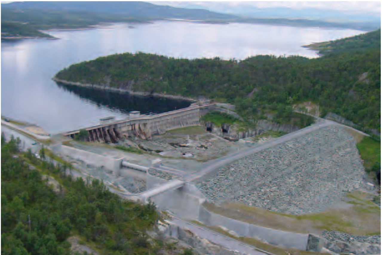
Eldre dam Møsvatn bak ny fyllingsdam i 2002. Store deler av den eldre dammen er revet, og er ikke synlig lenger.
