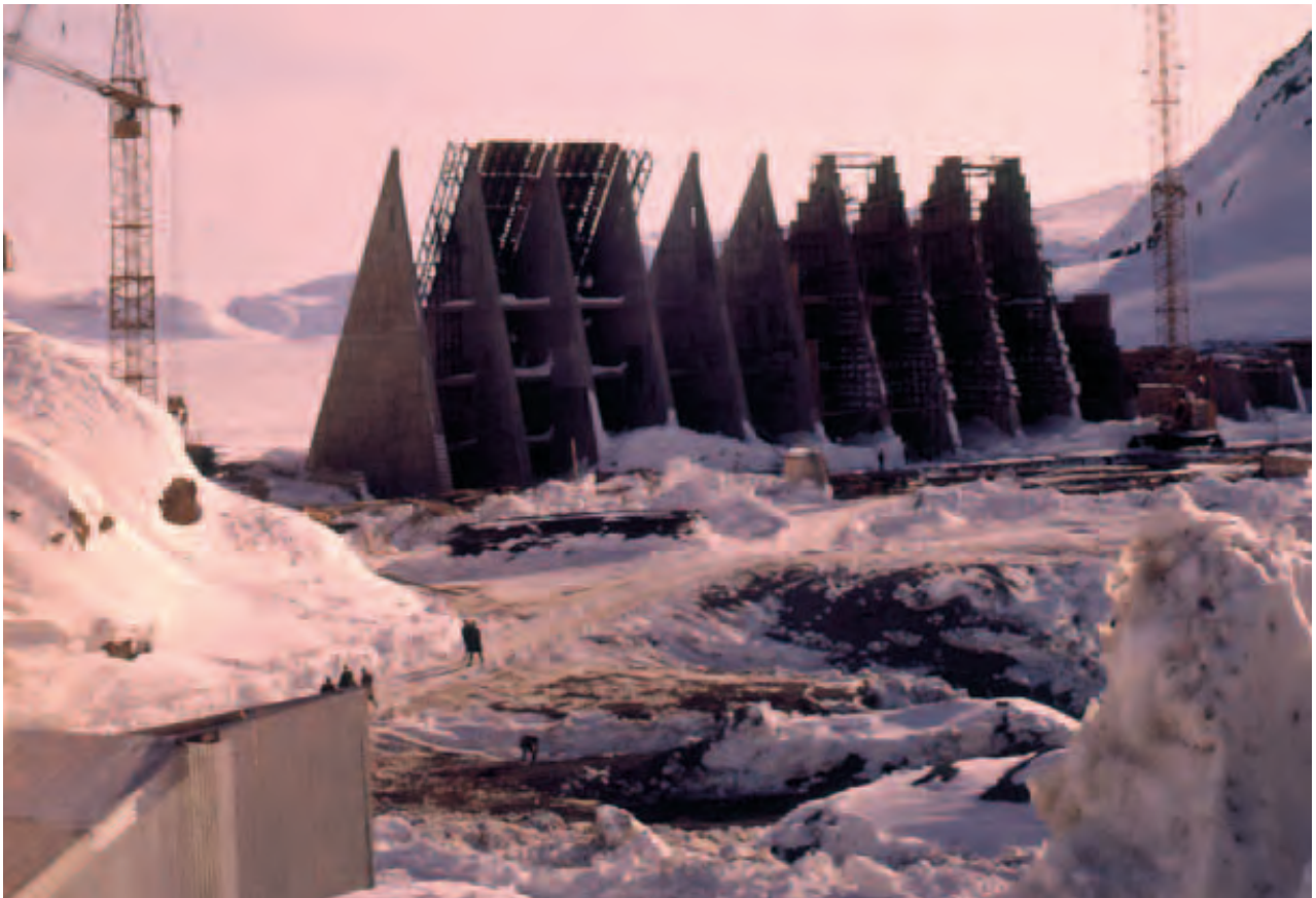
Dam under bygging på midten av 1960-tallet.
