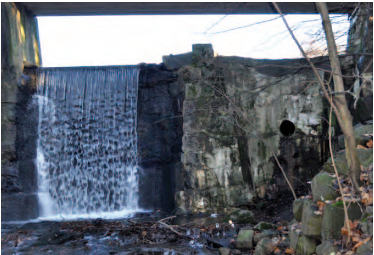
Nedre Frognerdam med hull etter røropplegg til Vassdragsvesenets kraftverk til Verdensutstillingen i 1914.
