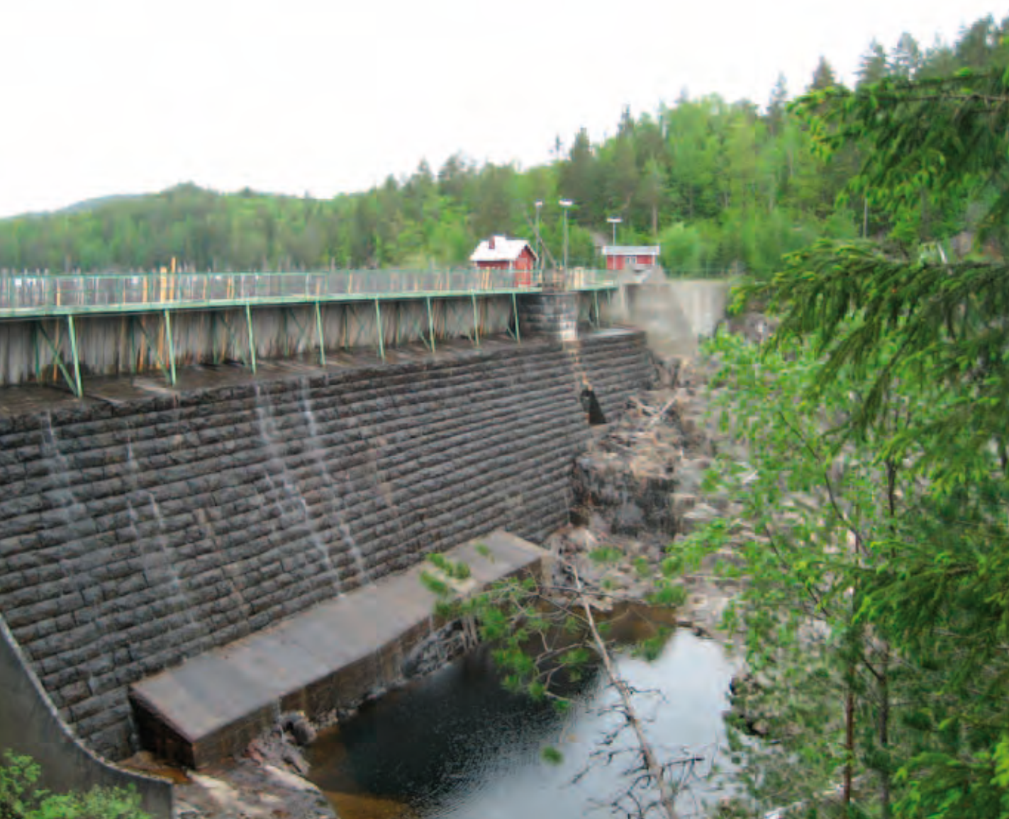
Dam Dalsfos i Telemark i 2009, før gjenstøping av nålestengsel og ny forblending.
