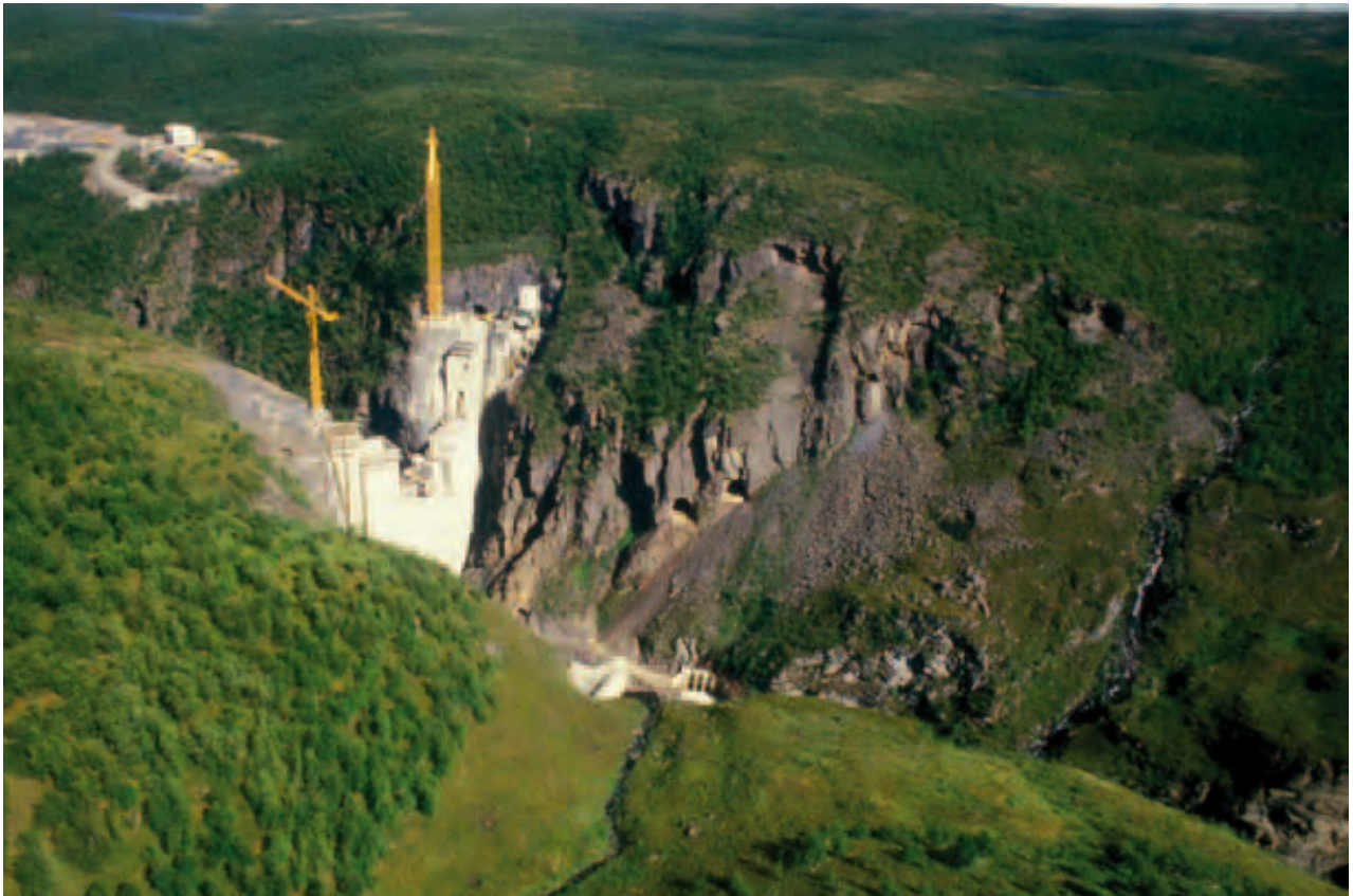
Dam under bygging i 1986
