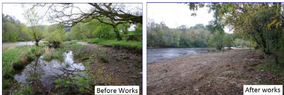
Figur 45 – Området “Chambon” i Dordogne før (til venstre) og etter (til høyre) tiltak for å sikre en jevnt skrånende elvebredd for å unngå ”pool trapping” (etter Cazeneuve et al. 2009).
