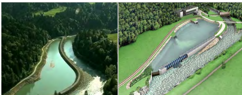
Figur 46 – Til venstre vises et fordrøyningsbasseng nedstrøms kraftverket Alberschwende i elva Bregenzerach i Østerrike (fra Schmutz). Til høyre vises planer for et tilsvarende anlegg i Sveits (Hasilaare), der mikroturbiner vil utnytte fallet mellom kompensasjonsmagasinet og elva (Schweitzer 2009).
