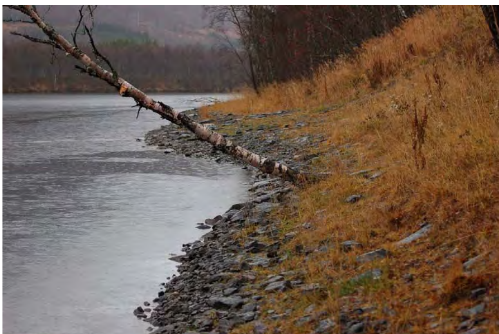
Figur 37 – Erosjonsforbygning ved tverrprofil 2.
