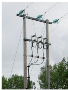
Kabelavgreiningsmast
