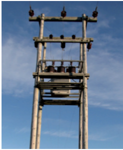
Stolpemonterte transformatorer
