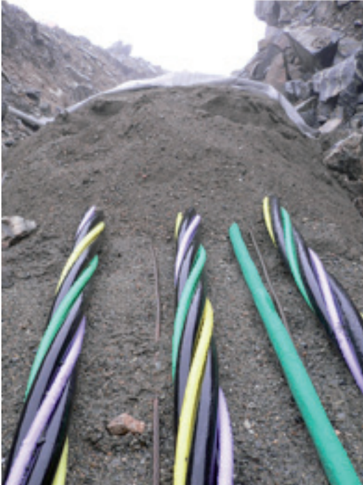
Jordkabel i grøft
