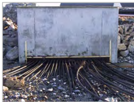
Figur 17 Legging av kollektorer i fjæra og samlelum for kollektorer
