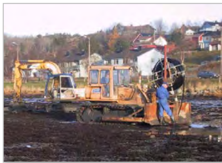
Figur 17 Legging av kollektorer i fjæra og samlelum for kollektorer
