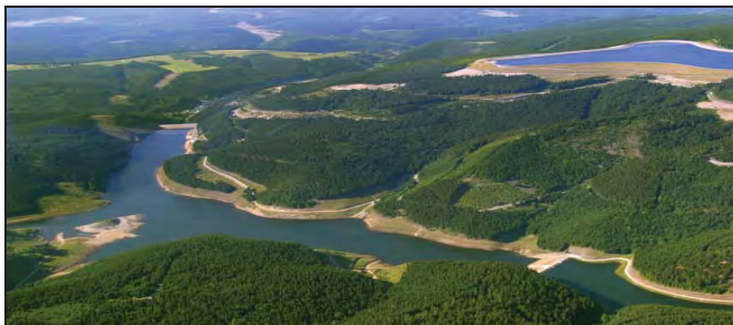
Figur 3. Det største pumpekraftverket i Tyskland "Goldisthal" med øvre og nedre magasin
