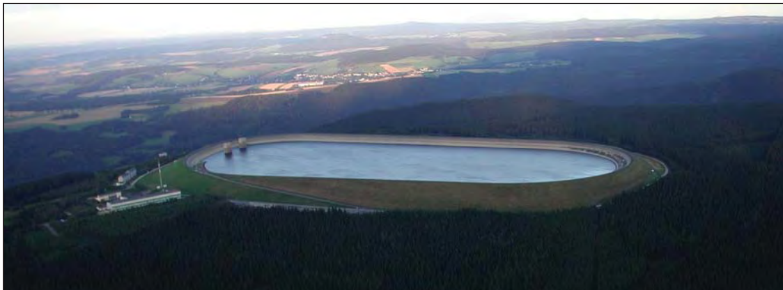
Figur 13. Øvre magasin til pumpekraftverket "Markersbach"
