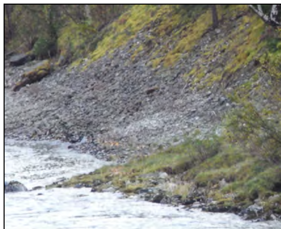
Fig. 2.32. Skråning ned mot elveløpet
