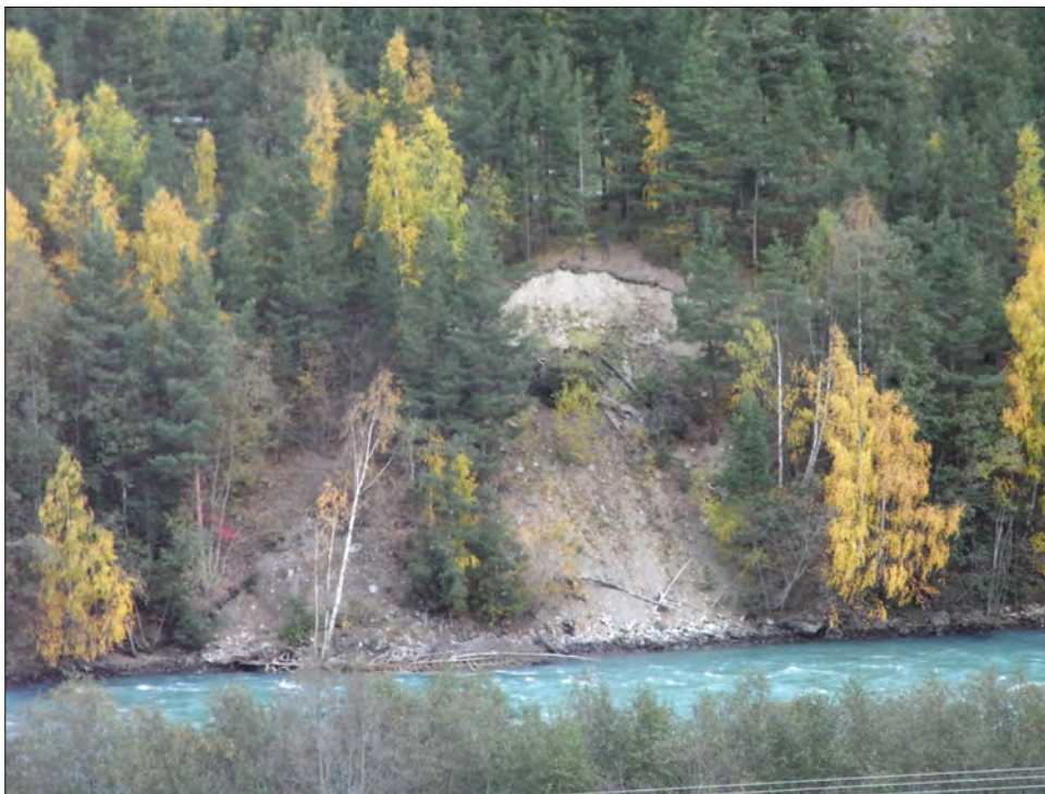
Fig. 2.5. Erosjonskråning langs elveløpet ved Sanden.
