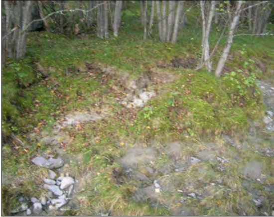
Fig. 2.19. Erosjon på banken ved lokalitet 1
