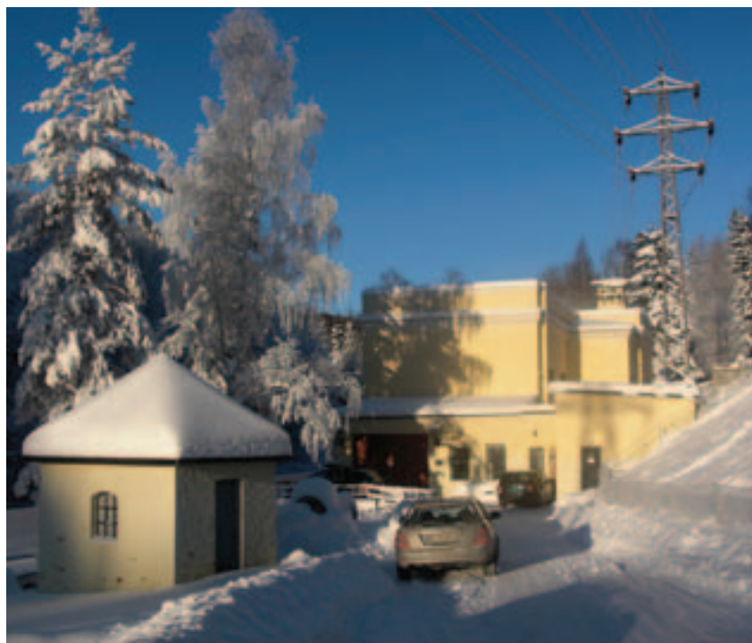
Hammeren kraftverk fra 1900 er fortsatt i full drift. Anlegget var trolig landets første arkitekttegnede kraftverk. Foto: Arne Vegard Langmo, Hafslund Nett
