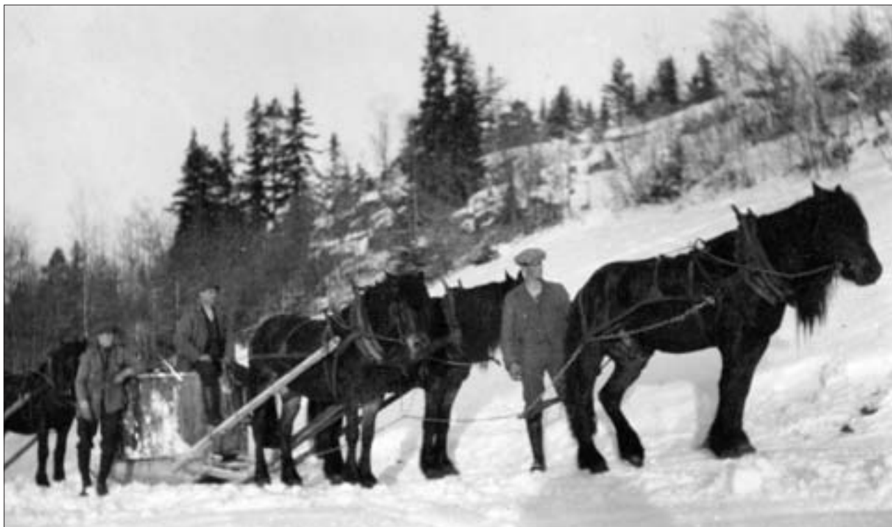
Fra byggingen av Noreledningen. På bildet ser vi kabelutkjøring med hest i Rånsetlia vinteren 1927. Foto: Statkraft
