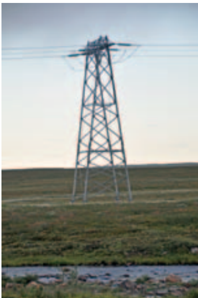
Vest-Finnmark har etter hvert fått styrket sin elektrisitetsforsyning vesentlig. Her ser vi forankringsmast på 132 kV-ledningen Skaidi–Alta fra 1989. Foto: Henning Weyergang-Nielsen, NVE
