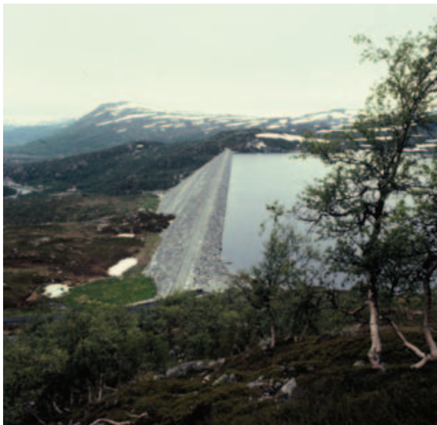
Sima-utbyggingen var meget omfattende, og inneholder flere verdifulle tekniske kulturminner. På bildet ser vi den imponerende Sysendammen – 80 meter høy og en kilometer lang. Foto: Statkraft
