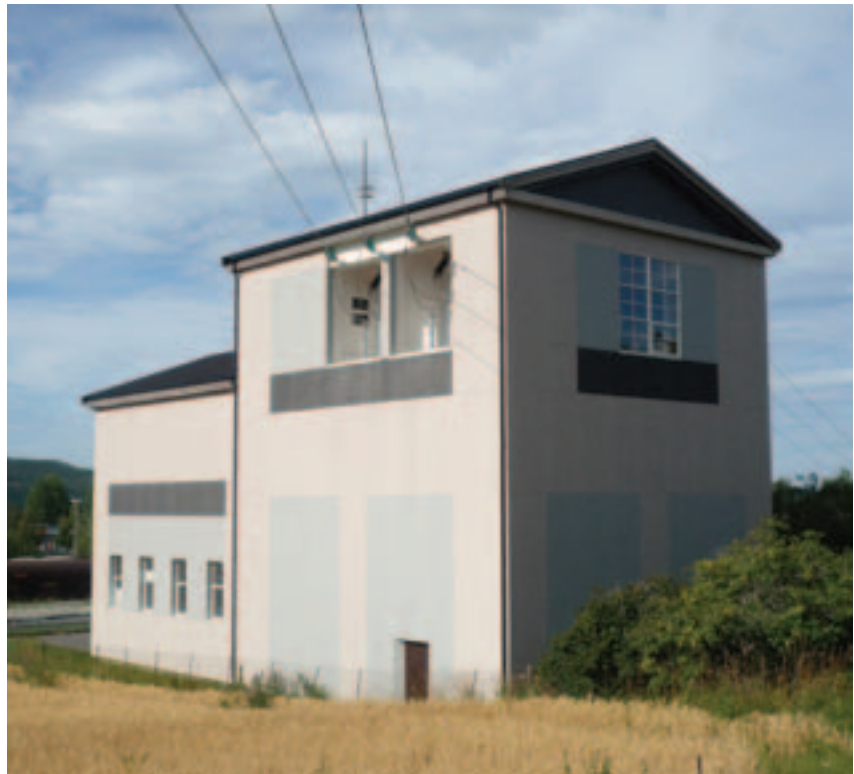
Åsen transformatorstasjon i Nord-Trøndelag. Bygningen har i nyere tid fått platekledning, men formen er i hovedsak den samme som den var ved idriftsettelsen i 1923. Legg særlig merke til hvordan ledningsinntaket er bygget som galleri inn i vegg. Foto: Sissel Riibe, NVE
