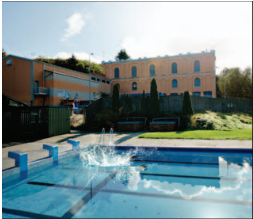
Gamlingen svømmestadion like ved transformatorstasjonen ble tatt i bruk i 1957 og er åpen hele året. Foto: Øyvind Ellingsen, Stavanger Aftenblad
