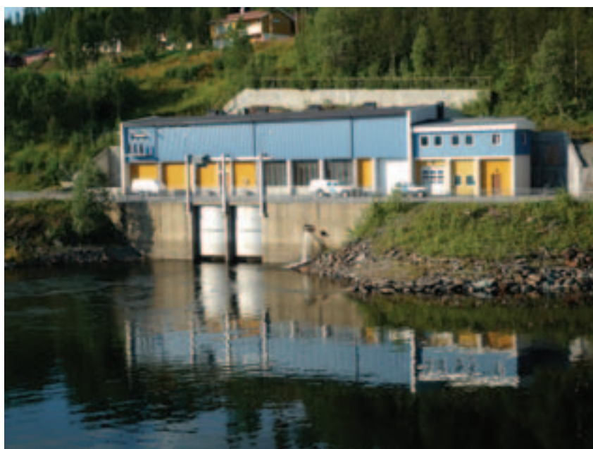
Røyrvikfoss er et av kraftverkene som ble bygget av Kraftverkene i Øvre Namsen. Foto: Sissel Riibe, NVE
