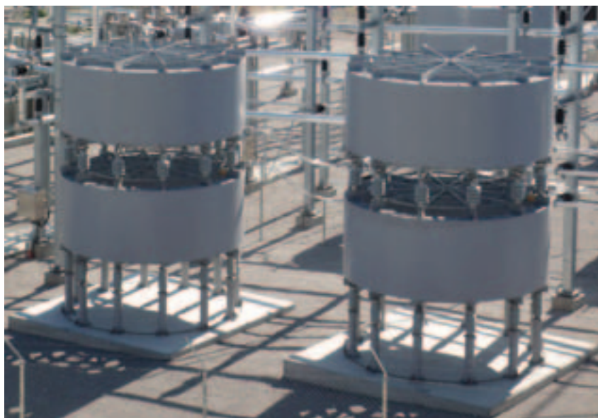
Reaktorer i SVC-kompenseringsanlegg. Foto: Sissel Riibe, NVE
