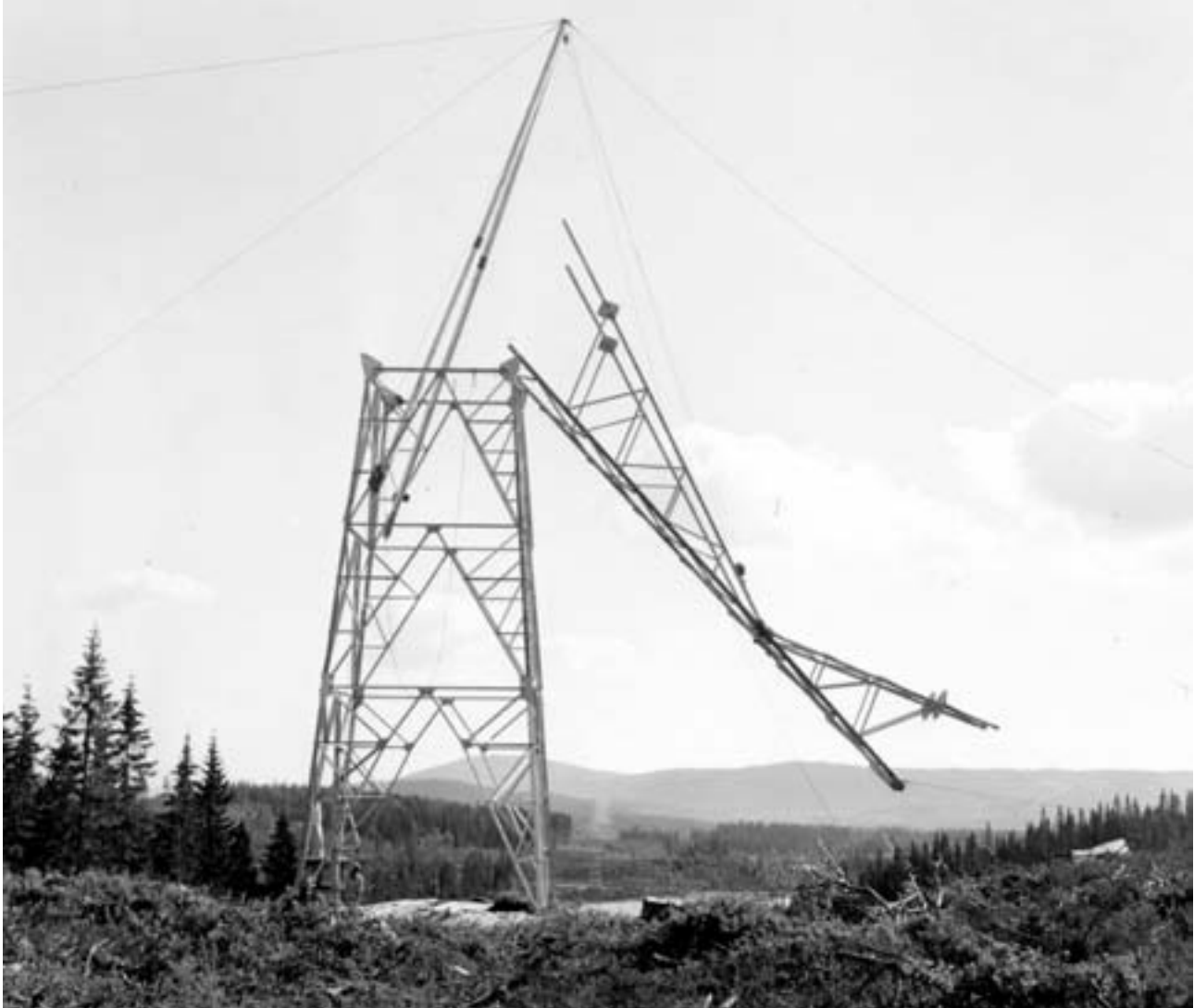
September 1967. Mastebygging med spir på Oslo Lysverkers ledning Usta–Frogner. En ny masteseksjon heises opp ved hjelp av vinsjer, samtidig som den "bremses" slik at den ikke hekter i den allerede stående masteseksjonen. Foto: P. O. Breifjell, Oslo Lysverker / Oslo byarkiv
