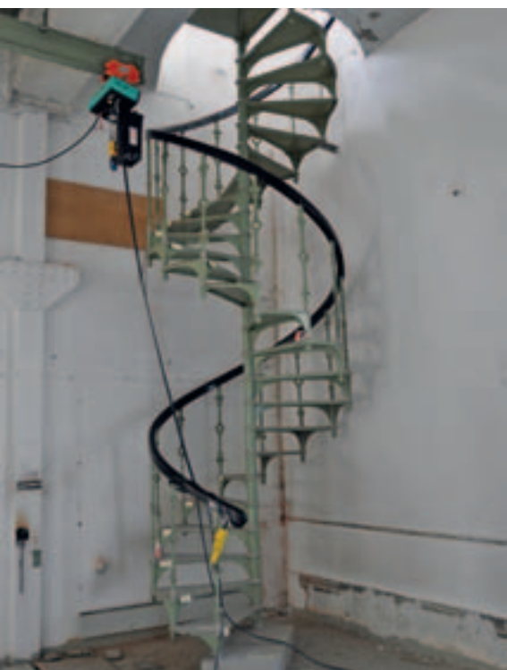
Vindeltrapp i smijern ved Riis transformatorstasjon i Oslo. Foto: Sissel Riibe, NVE
