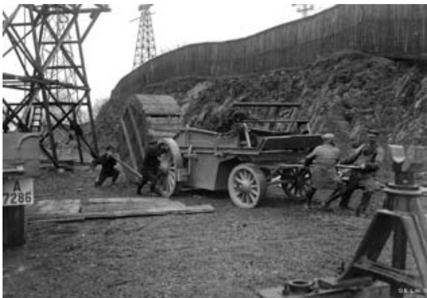
Hardt arbeid med transport og lossing av rull med 30-kilovolts kabel ved Tøyen transformatorstasjon i Oslo i 1923. Ukjent fotograf. Fra arkivet etter Oslo Lysverker / Oslo byarkiv
