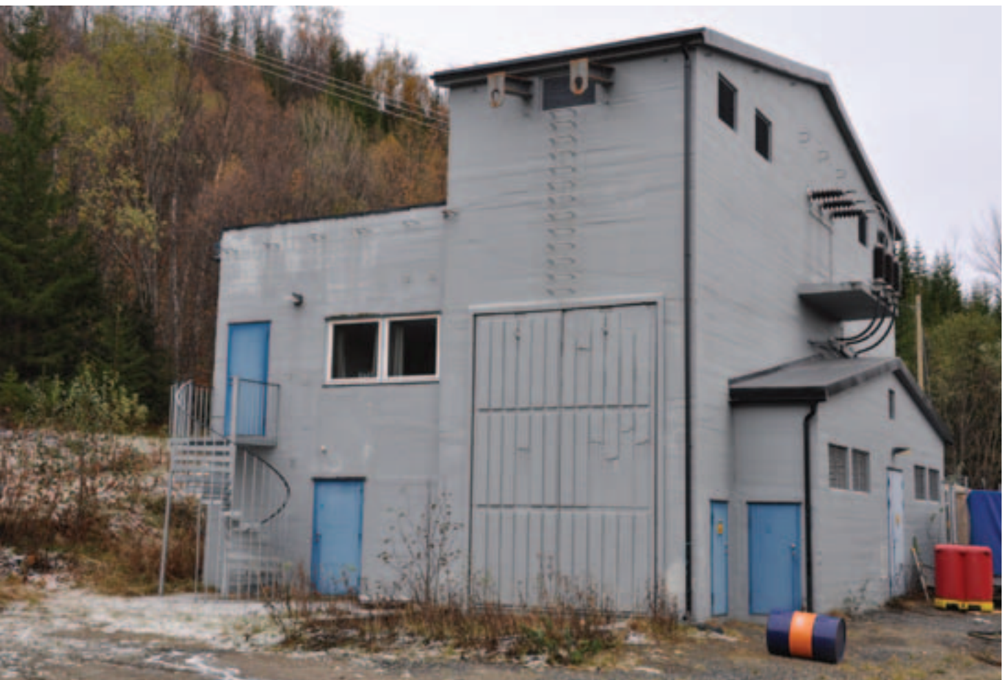
Salangen transformatorstasjonen fra 1960 i Troms er tegnet av arkitekt Roar Tønseth. Bygningen har beholdt sin opprinnelige form. Foto: Sissel Riibe, NVE
