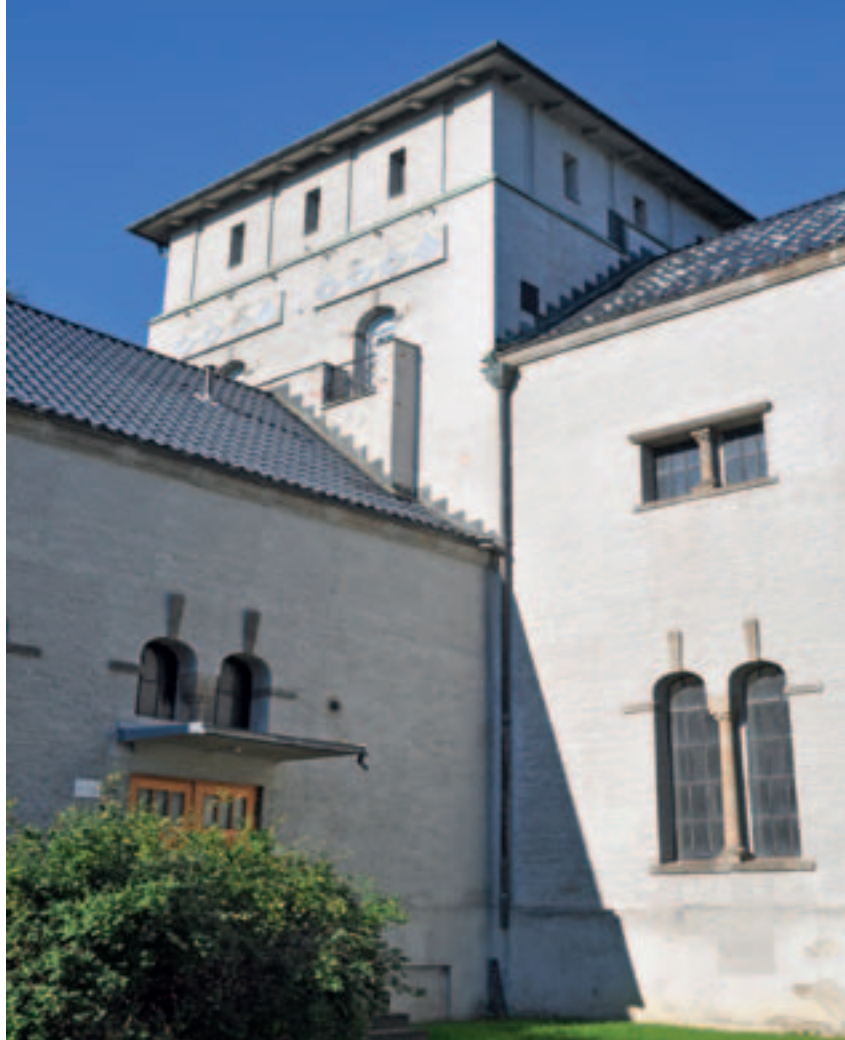
Riis transformatorstasjon i Oslo. Utsnitt av bygningen med hjørnetårnet fra 1918. Foto: Sissel Riibe, NVE
