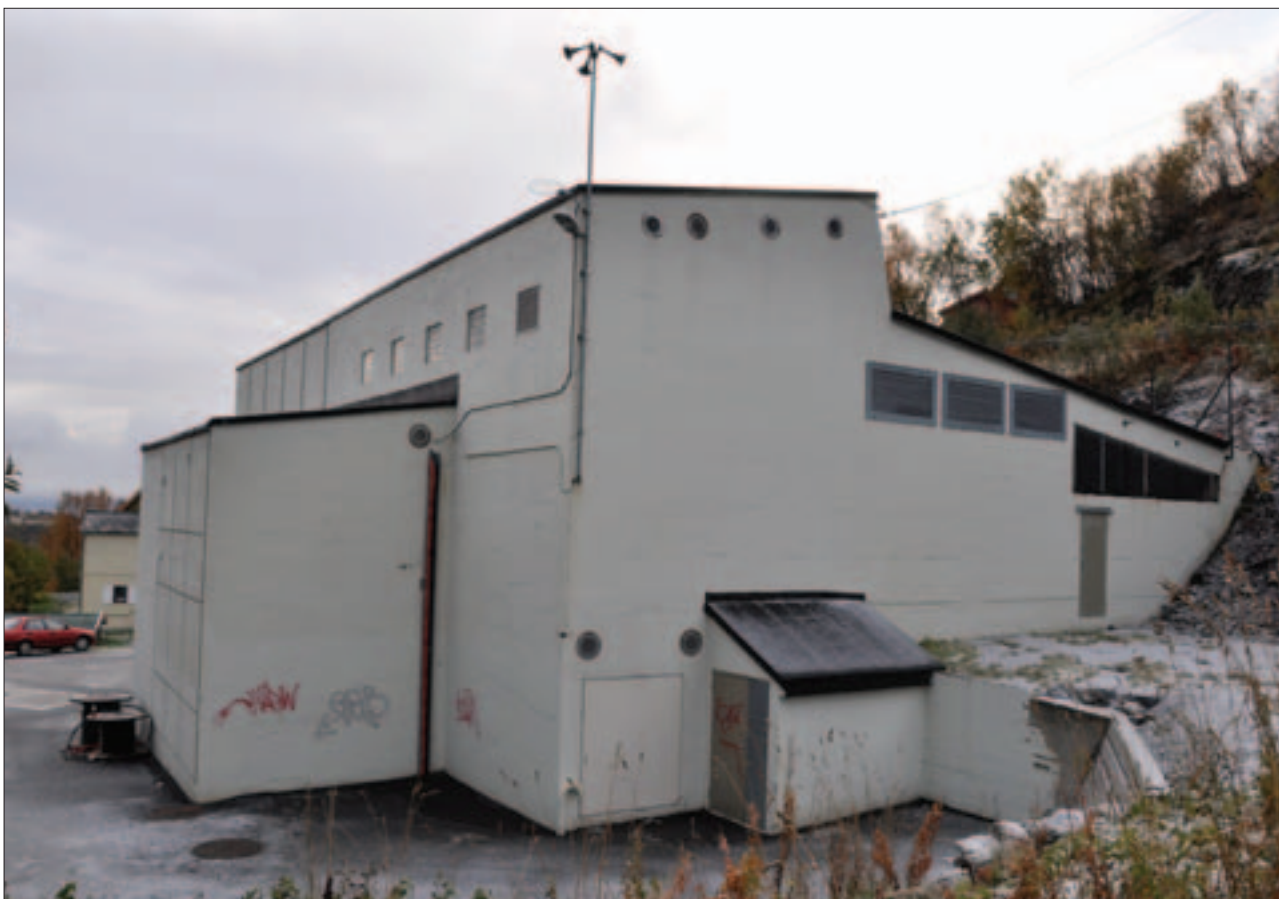
Transformatorstasjonen er fint plassert i det bratte terrenget. Høsten 2009 så stasjonen slik ut. Utvendig er den lite endret siden 1960. Foto: Sissel Riibe, NVE
