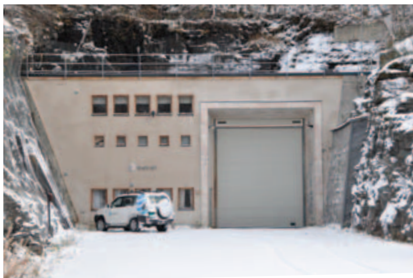
Portalbygget til Innset kraftstasjon, som er sprengt ut i fjell. Foto: Sissel Riibe, NVE
