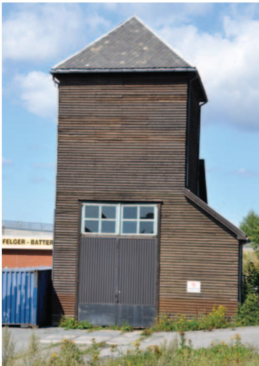
På motsatt side av veien står en trebygning med tårn kalt "kjerka". Bygningen var en integrert del av stasjonen, og her foregikk blant annet reparasjon av transformatorene. Stasjonen og "kjerka" var knyttet til jernbanen med et sidespor som nå er borte. Foto: Henning Weyergang-Nielsen, NVE
