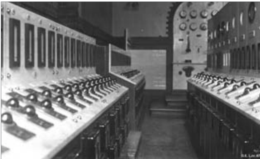
Apparatpulter i maskinrommet på Ankerløkka sekundærstasjon, der vekselstrømmen fra Hammeren kraftverk ble omformet til likestrøm. Opprinnelig gikk litt over halvparten av produksjonen til sporveiene, mens resten gikk til alminnelig forsyning. Bildet er tatt i 1914. Ukjent fotograf. Fra arkivet etter Oslo Lysverker / Oslo byarkiv
