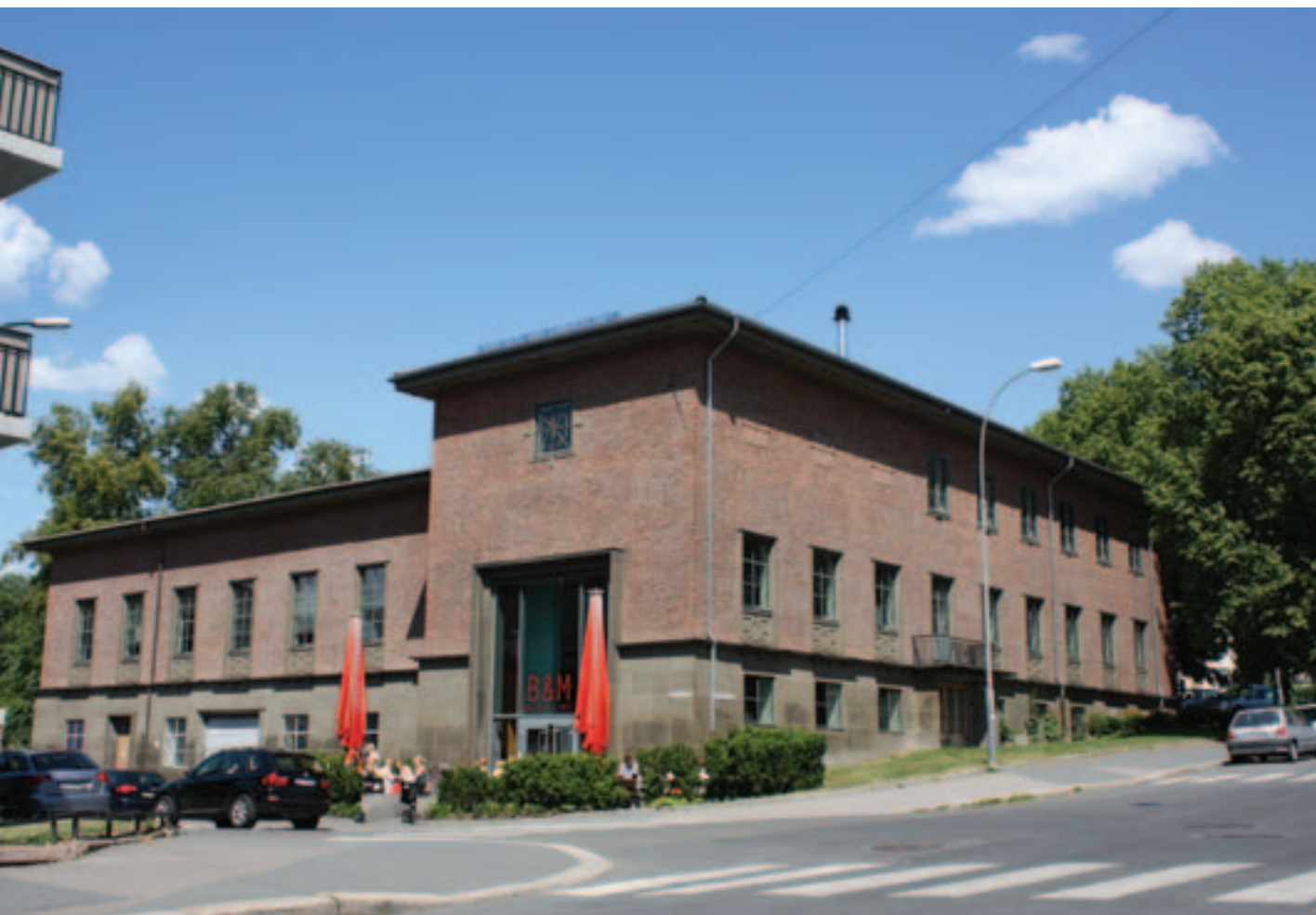
Briskeby transformatorstasjon i Oslo ble tegnet av Byarkitekten i 1944. Dette er en av de tre stasjonene for jordkabel som Oslo Lysverker satte opp på 1940-tallet. Foto: Ivar E. Stav
