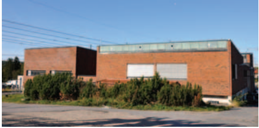
Hasle transformatorstasjon anno 2009. Bildet viser kontrollbyggets fasade mot øst. Foto: Henning Weyergang-Nielsen, NVE
