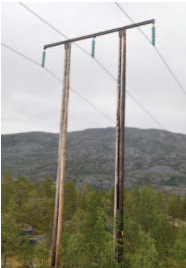
Den første del av strekningen – fra Kvænangsbotn kraftverk til Alta transformatorstasjon - ble satt i drift i 1965. Mastene har stolper av rundtømmer og ståltraverser (venstre). I 1984 kom den andre ledningen mellom Kvænangsbotn og Alta. Under skoggrensen er det hovedsakelig brukt limtremaster (høyre). Foto: Sissel Riibe, NVE
