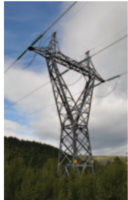
På ledningen fra Kvæningen til Nordreisa er det også brukt en del stålmaster. Her en forankringsmast like sør for Kvæningen kraftverk. Foto: Sissel Riibe, NVE
