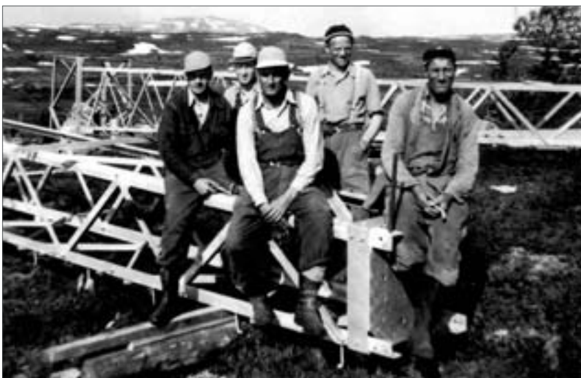
Arbeidslaget tar en velfortjent pust i bakken under byggingen av ledningen på slutten av 1950-tallet. Foto: Statnett
