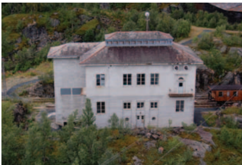
Bygningens bakside, med sæteritaket godt synlig. Tilbygget til venstre er den tredje transformatorcellen som ble oppført i 1953. Foto: Åsmund Wie, Jernbanelinjen
