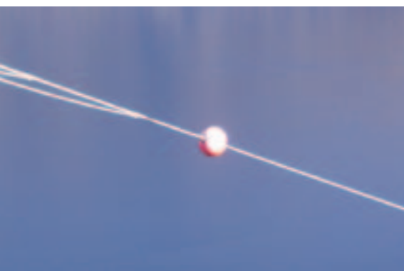
Flymarkør i plast på fjordspennline. Foto: Hallgrim Berg, Statnett
