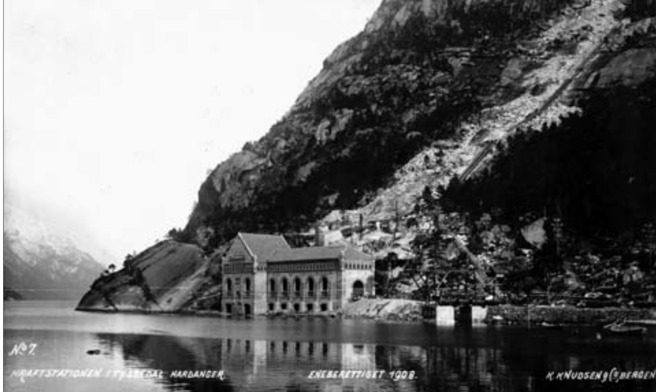
Den første Odda-ledningen ble satt i drift 4. mai 1908. På bildet ser vi mastene til høyre for Tyssedal Kraftstasjon, som så slik ut etter første byggetrinn i 1908. Foto: K. Knudsen & Co, Bergen. Fra Statkrafts fotosamling
