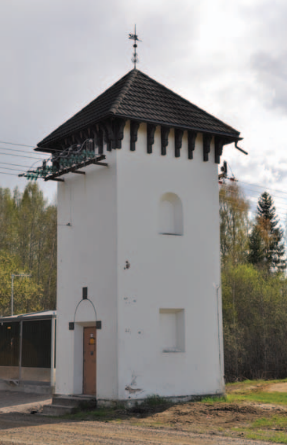
Skansgården transformertårn ved Kongsvinger er fra 1920. Den særpregete bygningen har konsoller av tre som bærer et utragende pyramidetak. Foto: Henning Weyergang-Nielsen, NVE
