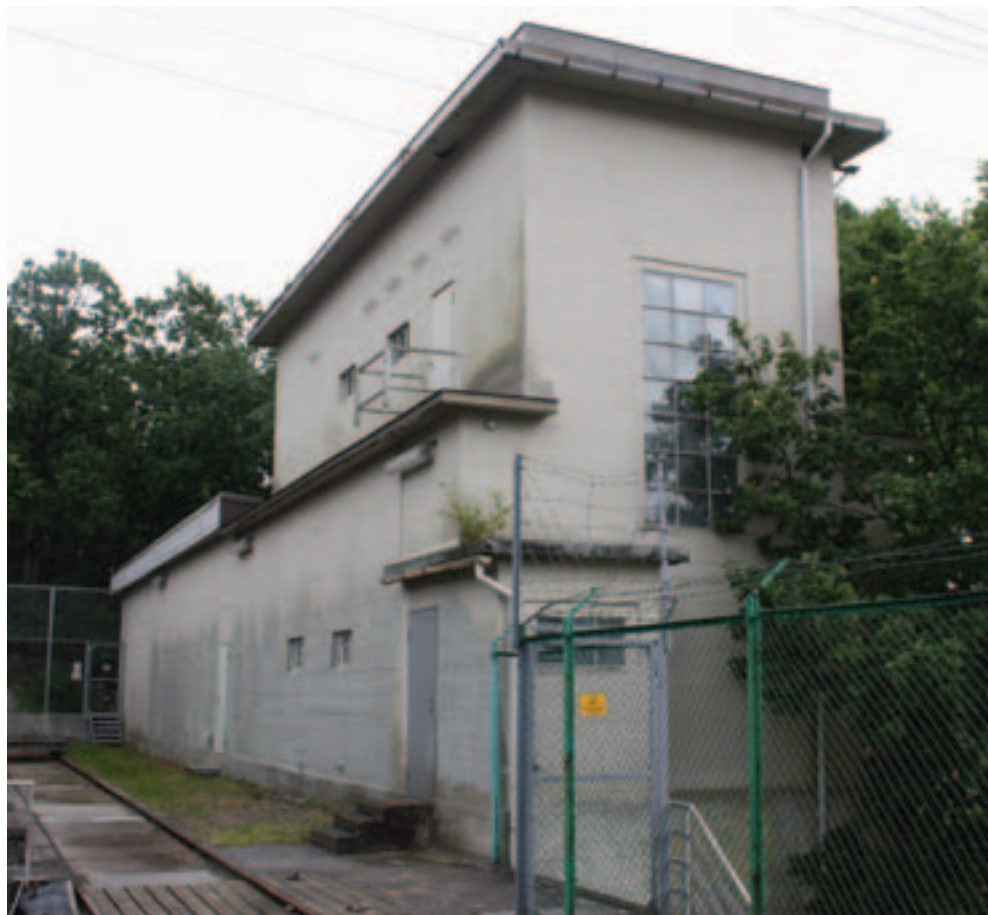
Krossen transformatorstasjon i Kristiansand ble bygget i 1933. Den kjennetegnes av funksjonalismens ”rene” arkitektur. Foto: Ivar E. Stav
