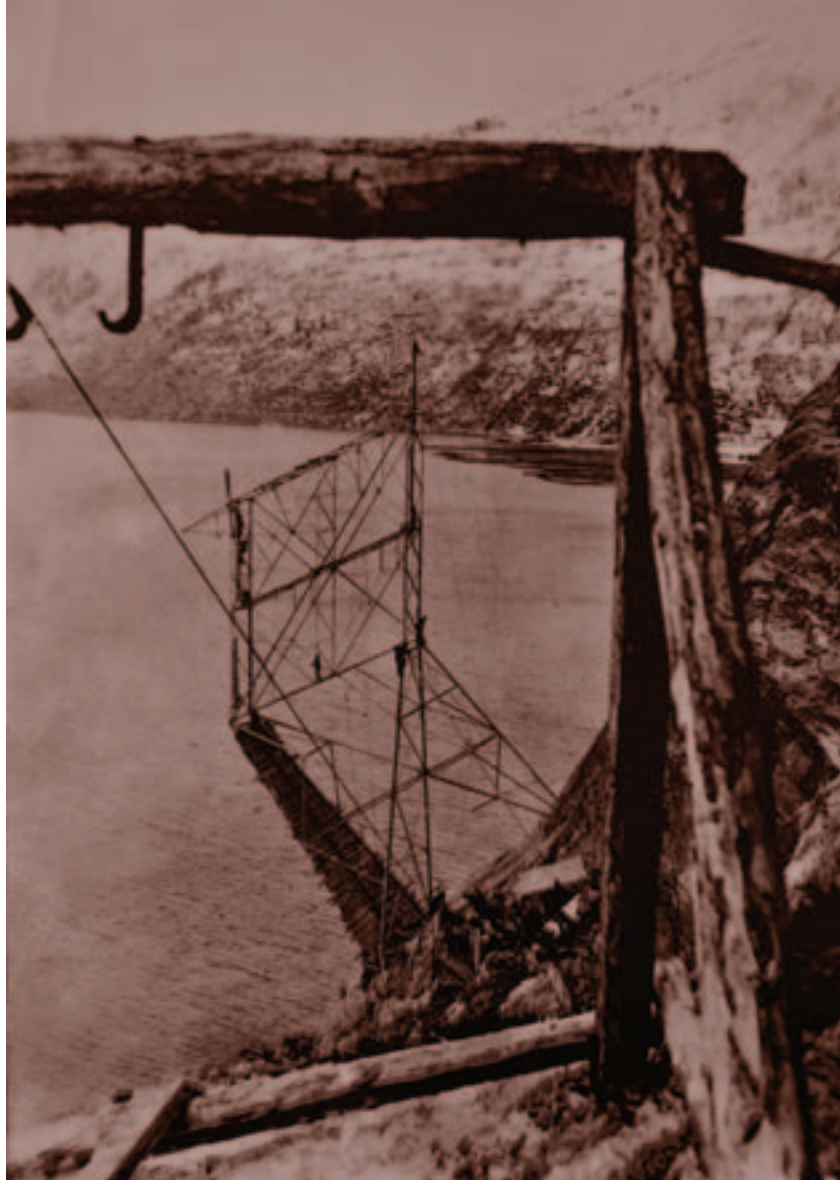
Bygging av spesialkonstruert mast i fjordveggen nedenfor Syltfjellet. Foto: Tafjord kraftnett
