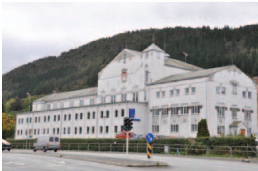
Den monumentale Solheim transformatorstasjon fra rundt 1915 i Bergen er tegnet av arkitekt Sigurd Lunde. Foto: Henning Weyergang-Nielsen, NVE
