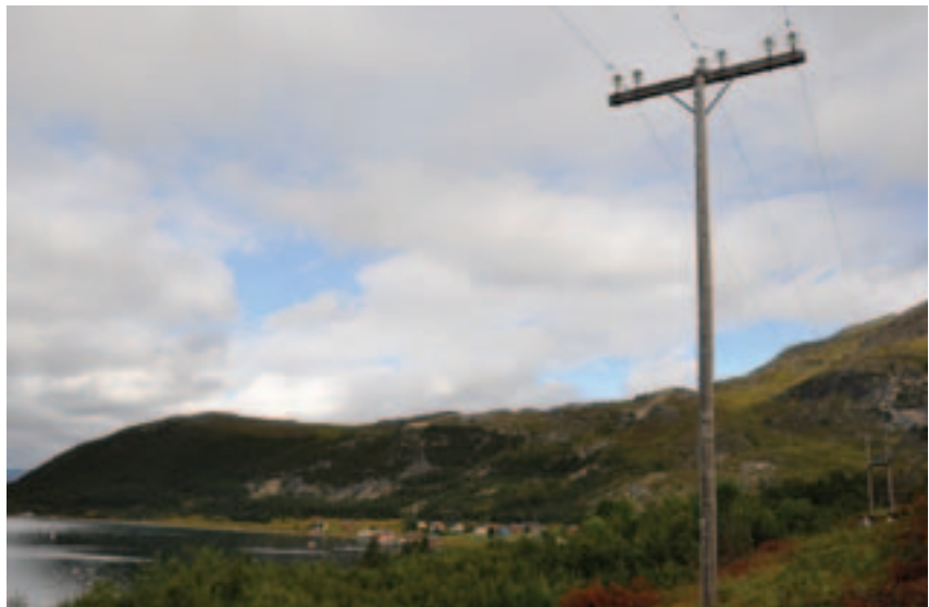
Den gamle Porsa-ledningen går gjennom bygda Neverfjord på østsiden av Vargsundet. Foran ser vi en enkeltmast (E-mast). I bakgrunnen skimtes en stolpetransformator med gammel betjeningsplattform. Foto: Sissel Riibe, NVE
