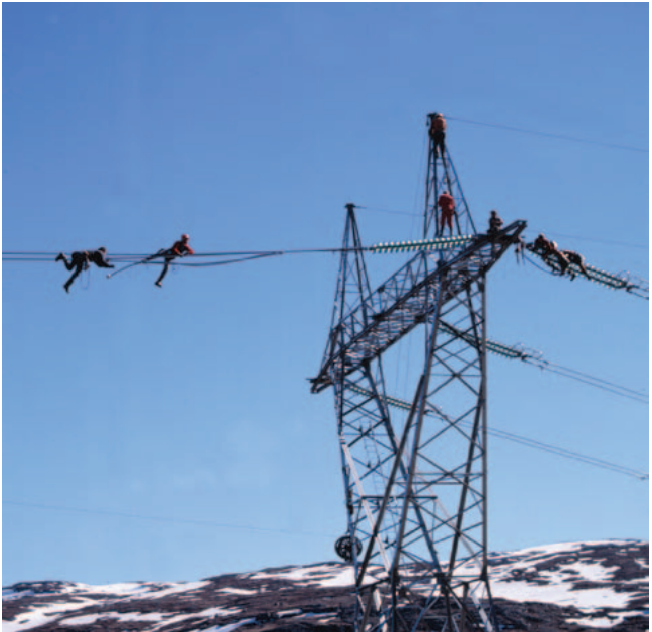
Som ledningsbygger bør man ikke ha høydeskrekk. På bildet utfører arbeidere fra Oslo Lysverker linemontasje på ledningen Hol–Aurland i 1973. Ukjent fotograf. Fra arkivet etter Oslo Lysverker / Oslo byarkiv
