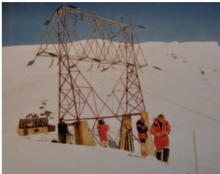
Ledningsinspeksjon i Uriskaret. På grunn av de store snømengdene i fjellet er det bygget master med svært høye betongfundamenter. Her er det kun øverste del av fundamentene som stikker opp over snøen. Foto: Tafjord kraftnett
