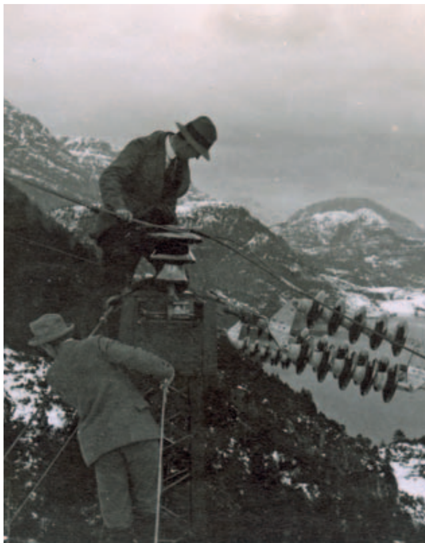
Ledningsnettet må også inspiseres. Her fra Aalfot interkommunale kraftselskaps spennmast ved Nordalsfjorden i Sogn og Fjordane, fotografert på 1920-tallet. Fotograf ukjent. Fra arkivet til NVE, Elektrisitetsdirektoratet
