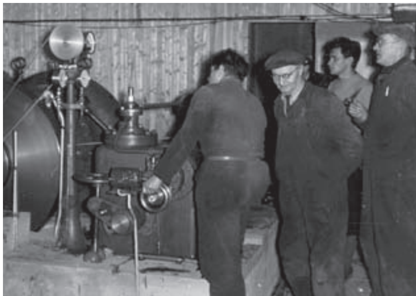
Fra maskinhuset i den gamle kraftstasjonen i Porsa. Prøvekjøring av generator 2 tidlig på 1950-tallet. Foto: Hammerfest Energi
