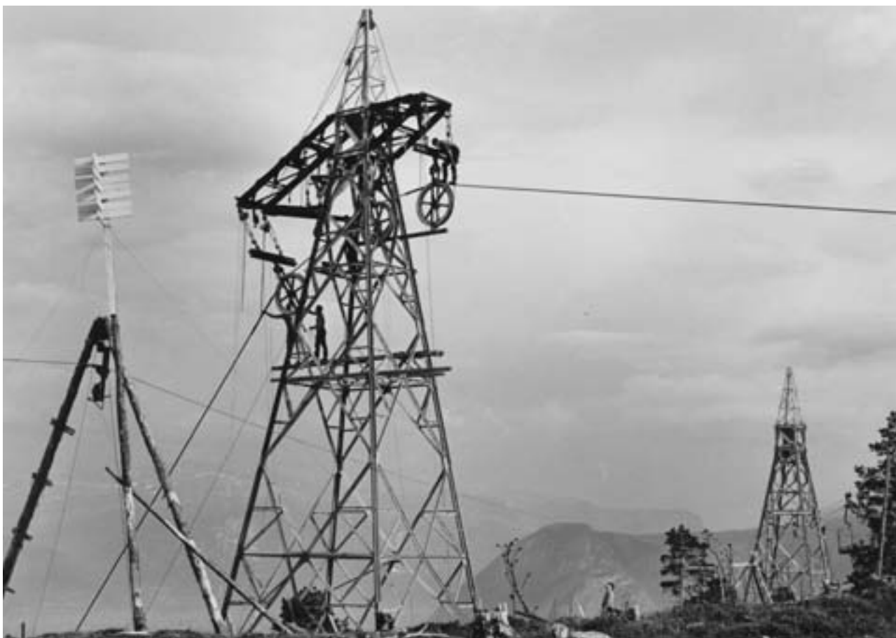
Fra strekkingen av Sognefjordspennet sommeren 1967. Foto: NVE
