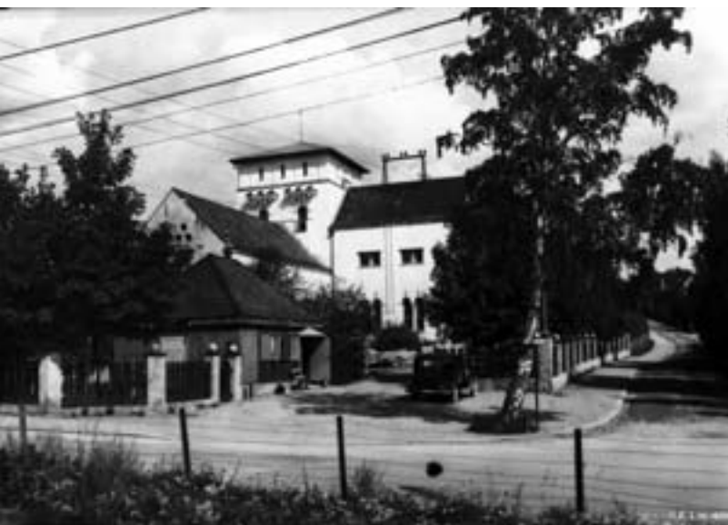
Riis er en av transformatorstasjonene som ble satt opp langs Kykelsrudledningen i 1903. I 1918 ble bygningen utvidet og endret etter tegninger av arkitekt Thorvald Astrup. Slik så den ut i 1936. Ukjent fotograf. Fra arkivet etter Oslo Lysverker / Oslo byarkiv
