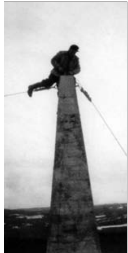
Luftig byggearbeid på ledningen Vinstra – Oslo tidlig på 1950-tallet. Foto: Statnett
