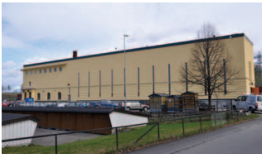
Anlegget slik det fremstår i dag. Foto: Henning Weyergang-Nielsen, NVE
