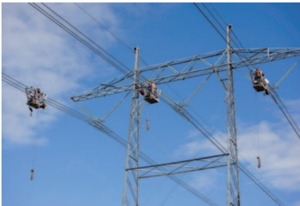
Ledningsbygging i Setesdalen sommeren 2009. Foto: Trond Isaksen. Fotoeier: Statnett
