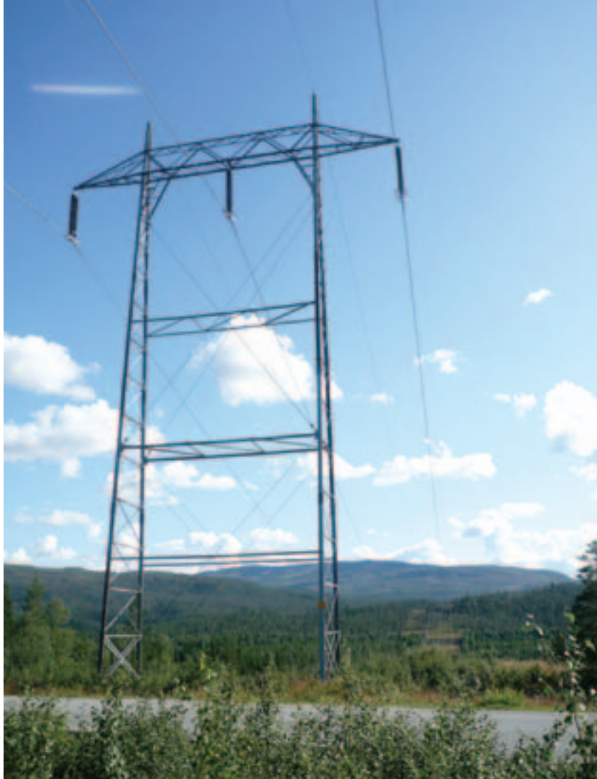
Standard portalmast av stål. Foto: Sissel Riibe, NVE
