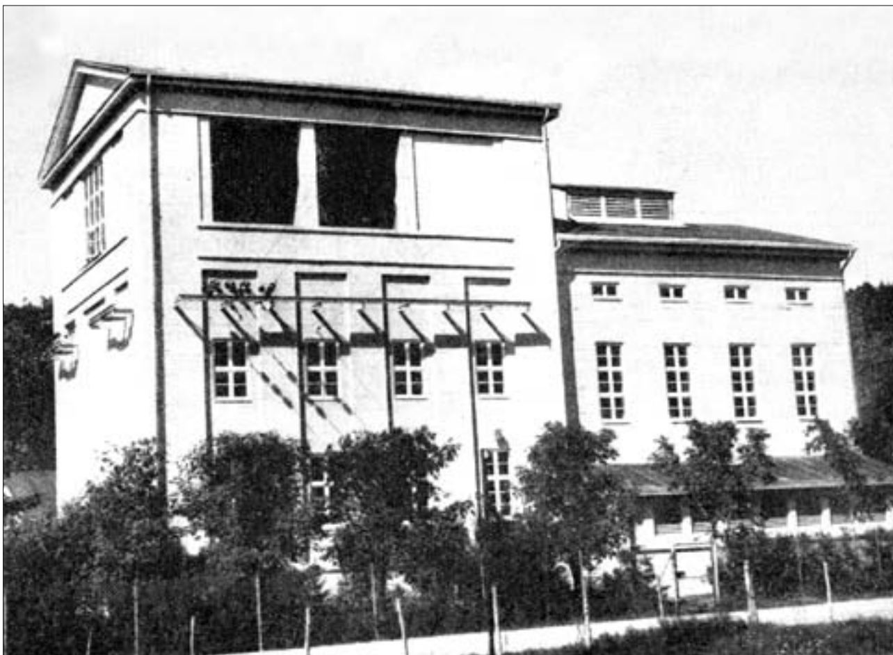
Fylkets tre hovedtransformatorstasjoner i 1923 var like store. De så ut slik som stasjonen i Namsos gjør på dette gamle bildet. Foto: Nord-Trøndelag Elektrisitetsverk (kopi fra bok)
