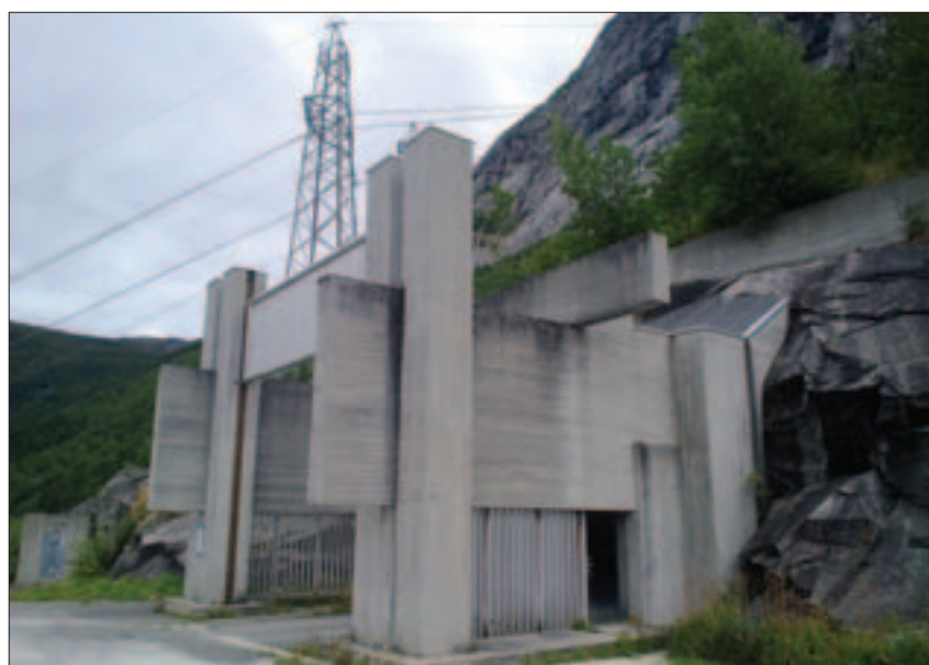
Portalbygget til kraftstasjonen Tyso II i Skjeggedal er også signert Geir Grung. Foto: Jan-Erik Haugli, AS Tyssefaldene
