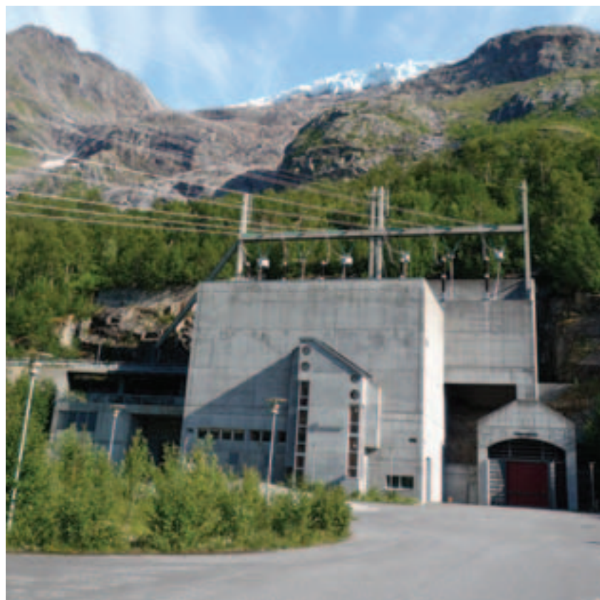
Byggingen av ledningen mellom Salten og Svartisen kan settes i direkte sammenheng med byggingen av Svartisen kraftverk – en av landets største og mest komplekse kraftutbygginger. Bildet viser portalbygningen innerst i Holandsfjorden. Foto: Sissel Riibe, NVE
