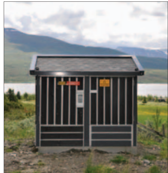
Elektrifiseringen av nordmenns hytteområder på fjellet blir stadig mer utbredt. Bildet viser en nylig oppført nettstasjon av typen ABB Senior, i hytteområdene ved Nordre Syndinvann i Valdres i Oppland. Foto: Henning Weyergang-Nielsen, NVE
