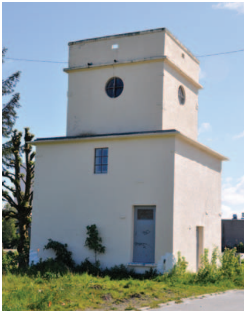
Over: I den tidligere Kvalebergleiren satte tyskerne under andre verdenskrig opp dette tårnet. Det var både vakttårn og transformatorkiosk. Foto: Sissel Riibe, NVE
