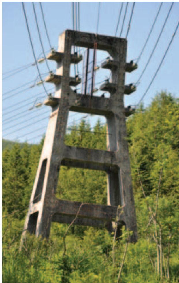
Opprinnelig forankringsmast i betong fra 1920. Glomfjord. Foto: Henning Weyergang-Nielsen, NVE
