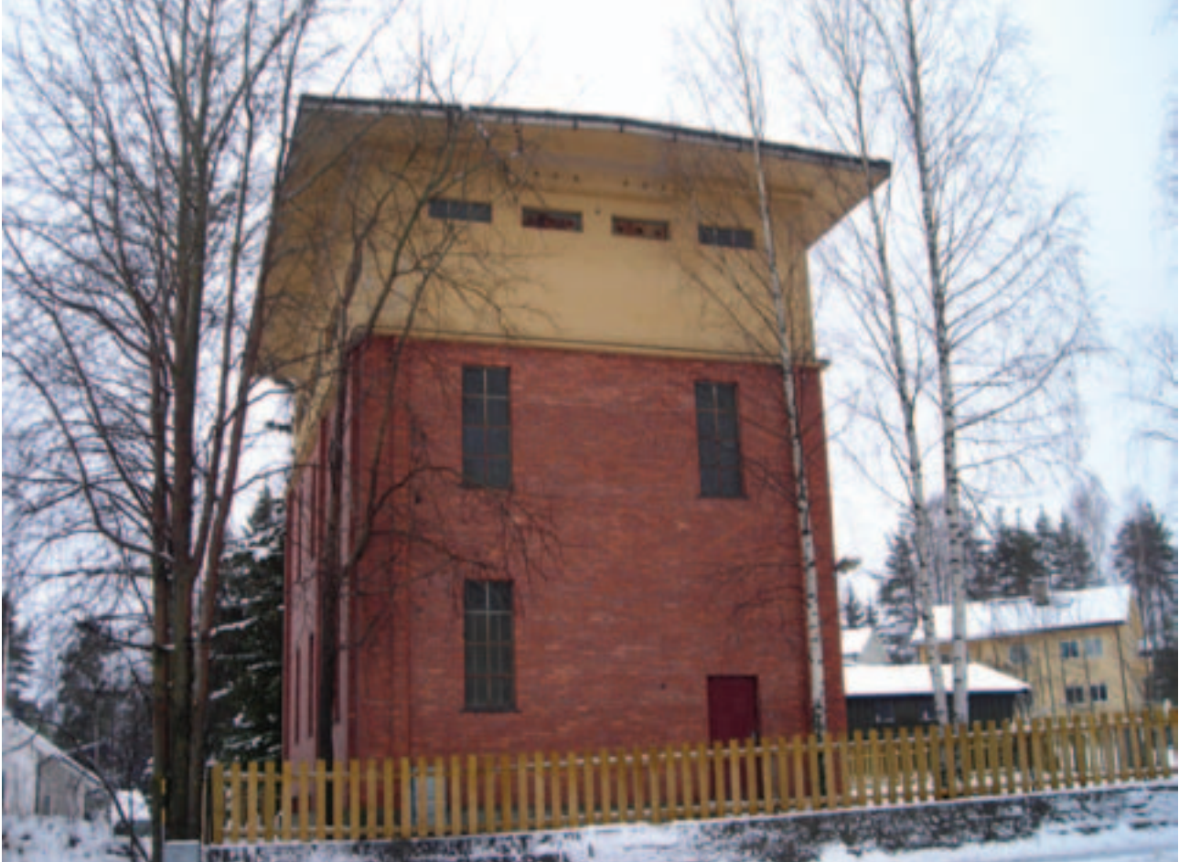
Gamle Leiret transformatorstasjon i Elverum er fra 1939. Ytterveggene har en kombinasjon av synlig tegl og pusset overflate, og det flate taket krager langt ut fra vegglivet. Foto: Henning Weyergang-Nielsen, NVE
