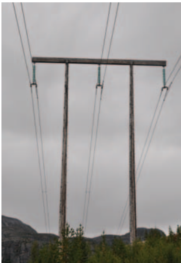
Den første del av strekningen – fra Kvænangsbotn kraftverk til Alta transformatorstasjon - ble satt i drift i 1965. Mastene har stolper av rundtømmer og ståltraverser (venstre). I 1984 kom den andre ledningen mellom Kvænangsbotn og Alta. Under skoggrensen er det hovedsakelig brukt limtremaster (høyre). Foto: Sissel Riibe, NVE
