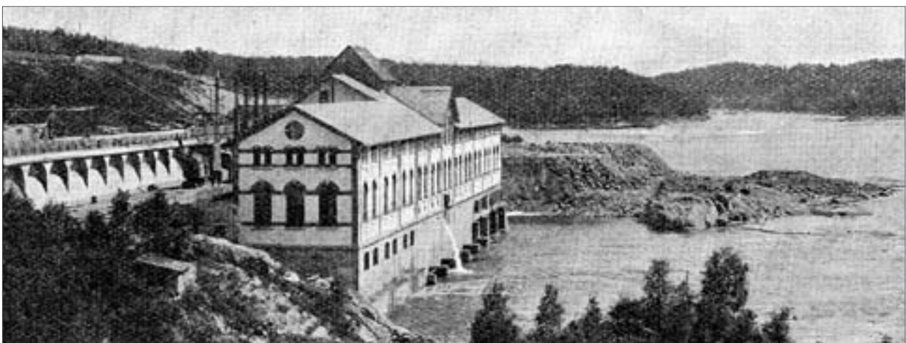
Kykkelsrud er et av de eldste, virkelig store kraftverkene i Norge, og har også en sentral plass som kraftprodusent til et overføringssystem som i sin tid var av oppsiktsvekkende dimensjoner. Første byggetrinn ble satt i drift i 1903. På bildet ser vi kraftverket etter utvidelsene i 1914. Foto: Statnett
