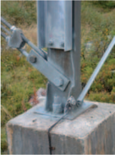
Stålmaster festes som regel til et fundament støpt i betong, mens for betongmaster blir vanligvis mastebeinet ført ned i et hull i bakken og "låst fast". Begge foto: Henning Weyergang-Nielsen, NVE
