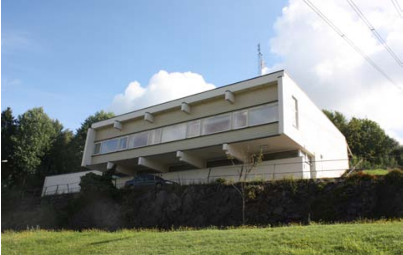
Tveiten transformatorstasjon utenfor Tønsberg ble satt i drift i 1966. Den utragende andreetasjen bæres av kraftige betongdragere. Foto: Ivar E. Stav
