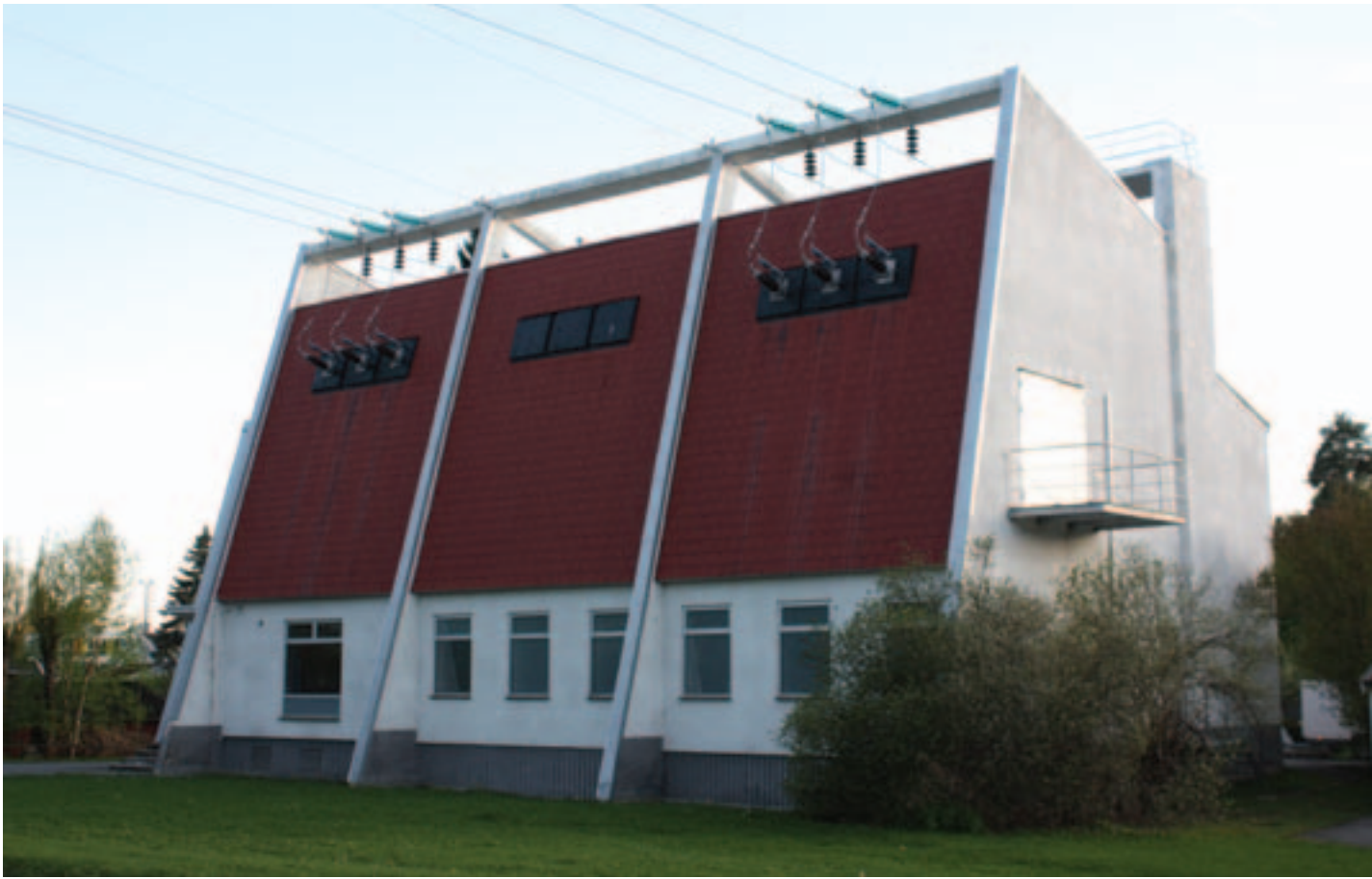
Ballerud transformatorstasjon i Bærum er tegnet av Astrup og Hellern på slutten av 1950-tallet. Skrå vegger kledd med takshingel går også igjen på Tegneby transformatorstasjon i Vestby som arkitektkontoret tegnet omtrent på samme tid. Foto: Ivar E. Stav
