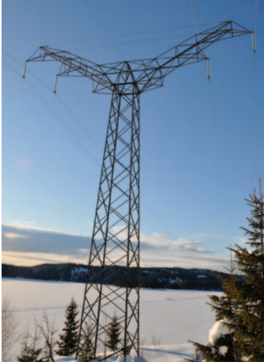
Ledningen har i stor grad beholdt sitt opprinnelige uttrykk, men på et parti gjennom Sørkedalen er de to nederste faselinene tatt ned. Her ser vi ledningen ved Heggelivann i Sørkedalen. Foto: Henning Weyergang-Nielsen, NVE
