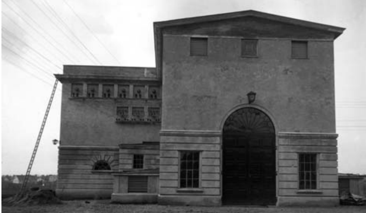
Børstad transformatorstasjon kort tid etter idriftsettelsen. Foto: Eidsiva Energi AS
