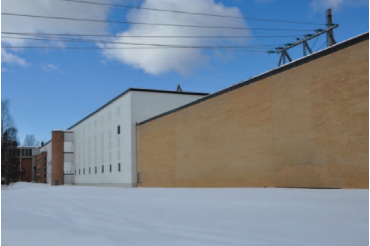
Den store Sogn transformatorstasjon i Oslo er tegnet av arkitektene Leif og Ernst Torp. Foto: Sissel Riibe, NVE
