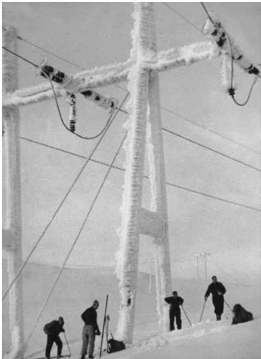
Kåre Ørbekk, Leif Koppervik, Kjell Fauske og Rolf Nybø fra Vinstra Kraftselskap inspiserer ledningen vinteren 1960. Det værutsatte høyfjellsterrenget satte store krav til ledningens styrke og dimensjoner. Foto: Statnett
