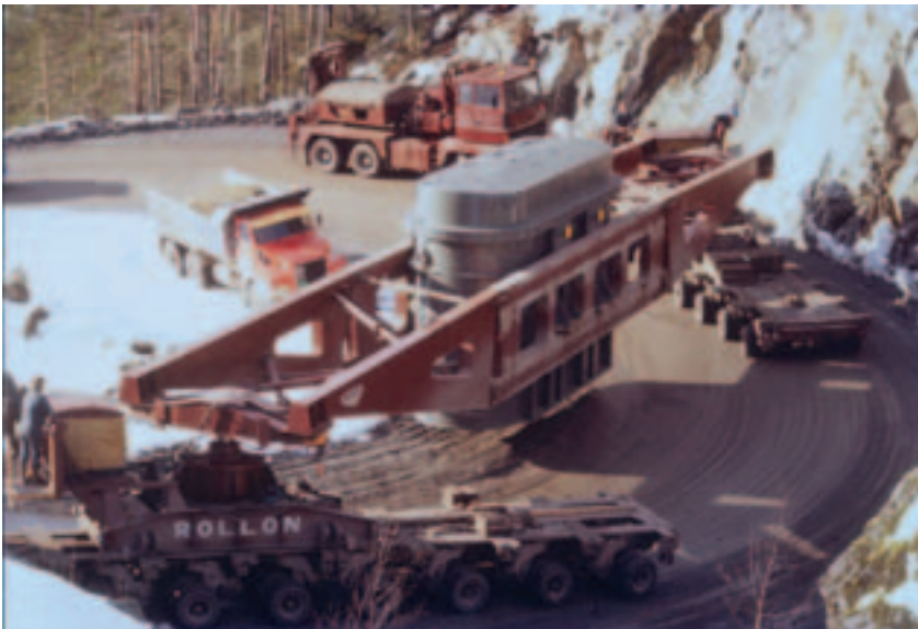
Transformatortransport til Saurdal transformatorstasjon i 1980-årene. Foto: Statkraft
