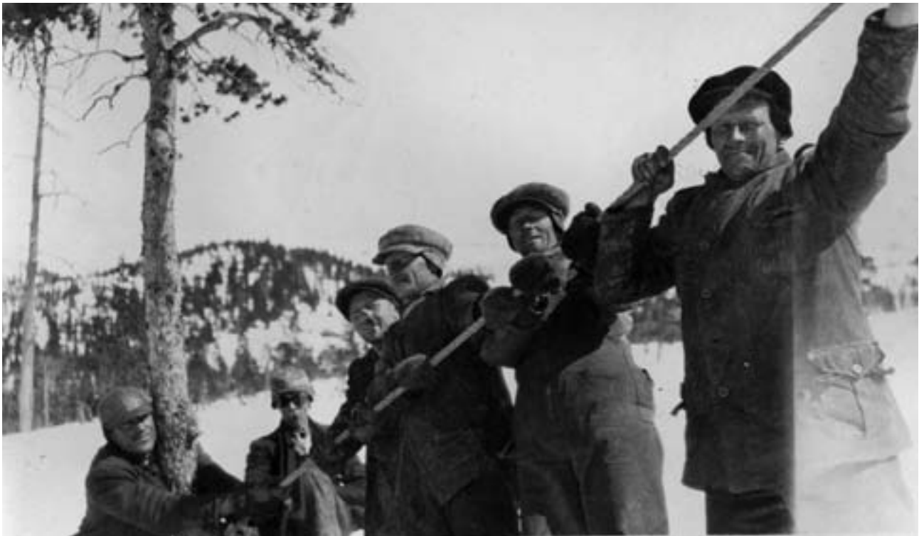
Senvinteren 1927: Et arbeidslag er i ferd å stramme bardunene før travers skal heises opp på mast nr 100. Foto: Statkraft
