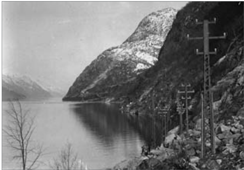
Kraftledningene mellom Tyssedal og Odda ble lagt i en bratt og rasfarlig fjellside der det aldri hadde vært vei. I bakgrunnen skimtes rørgata fra Lilletopp ned til kraftstasjonen ved Sørfjorden. Foto: AS Tyssefaldenes fotosamling
