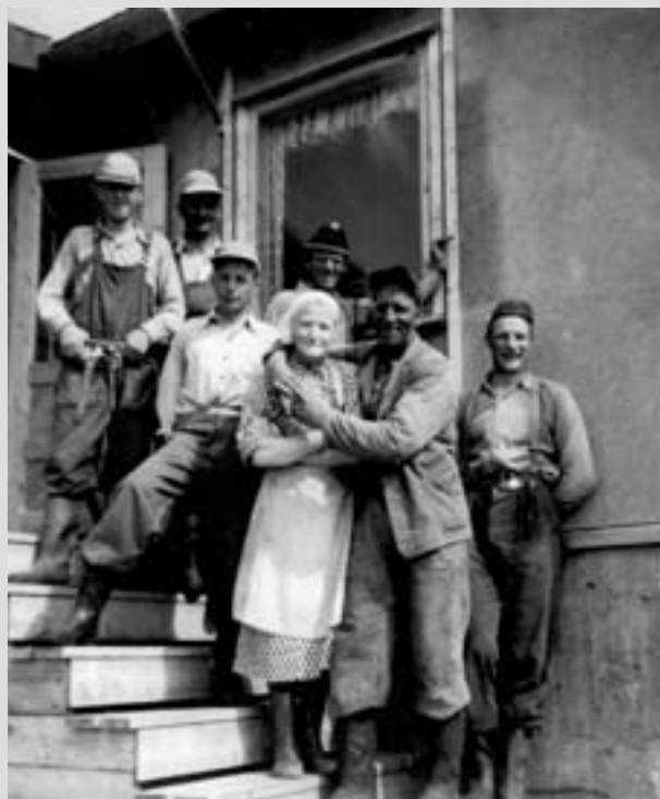
Fundamentlag sammen med anleggskokken, på trappen til anleggsbrakken ved Djupholma øst for Essandsjøen, under bygging av statens ledning fra Nea til Järpströmmen. Foto: Statnett
