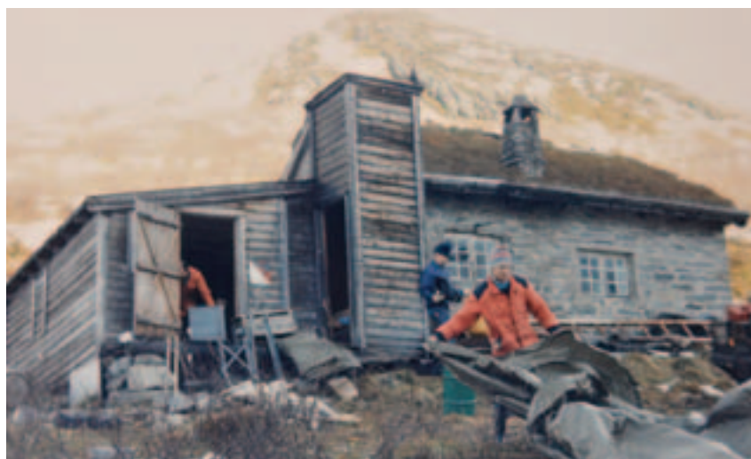
Ledningshytte på fjellet i Uriskaret. Legg særlig merke til tårnkonstruksjonen i tre, bygget for å kunne ta seg inn i hytta om vinteren når snømengdene er som størst. Foto: Tafjord kraftnett
