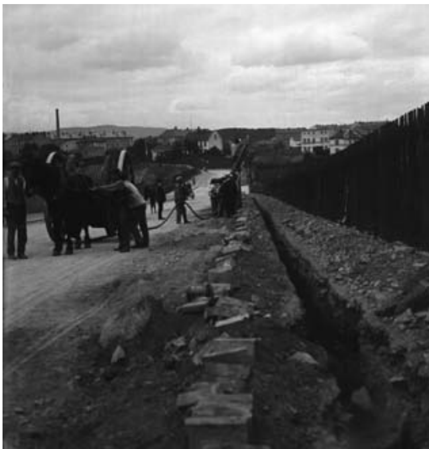
Kabelutstrekking i Bentsebrugata i Oslo ved hjelp av hest, i forbindelse med at jordkabelen for Hammeren-ledningen ble forlenget i årene etter 1910. Ukjent fotograf. Fra arkivet etter Oslo Lysverker / Oslo byarkiv
