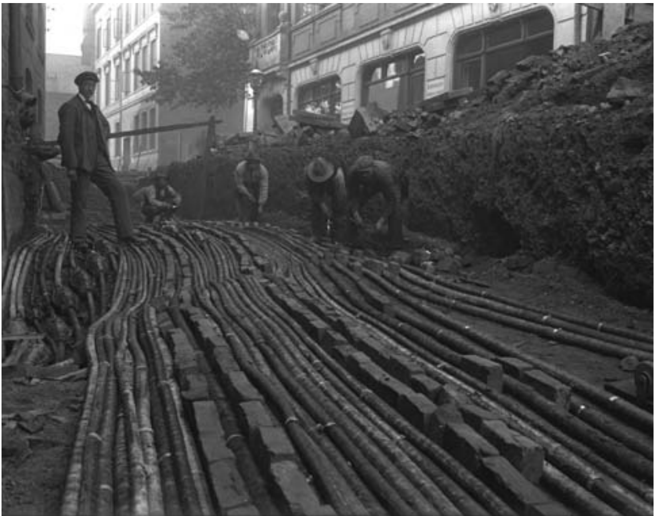
Fra kraftoverføringens tidlige epoke: Kristiania Elektrisitetsverk under arbeid med strekking av jordkabel til Ankerløkka sekundærstasjon på Østre Elvebakke i 1915. Ukjent fotograf. Fra arkivet etter Oslo Lysverker / Oslo byarkiv
