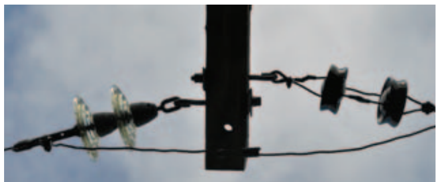
Gamle isolatorer av glass med kappe og porselen. Foto: Sissel Riibe, NVE
