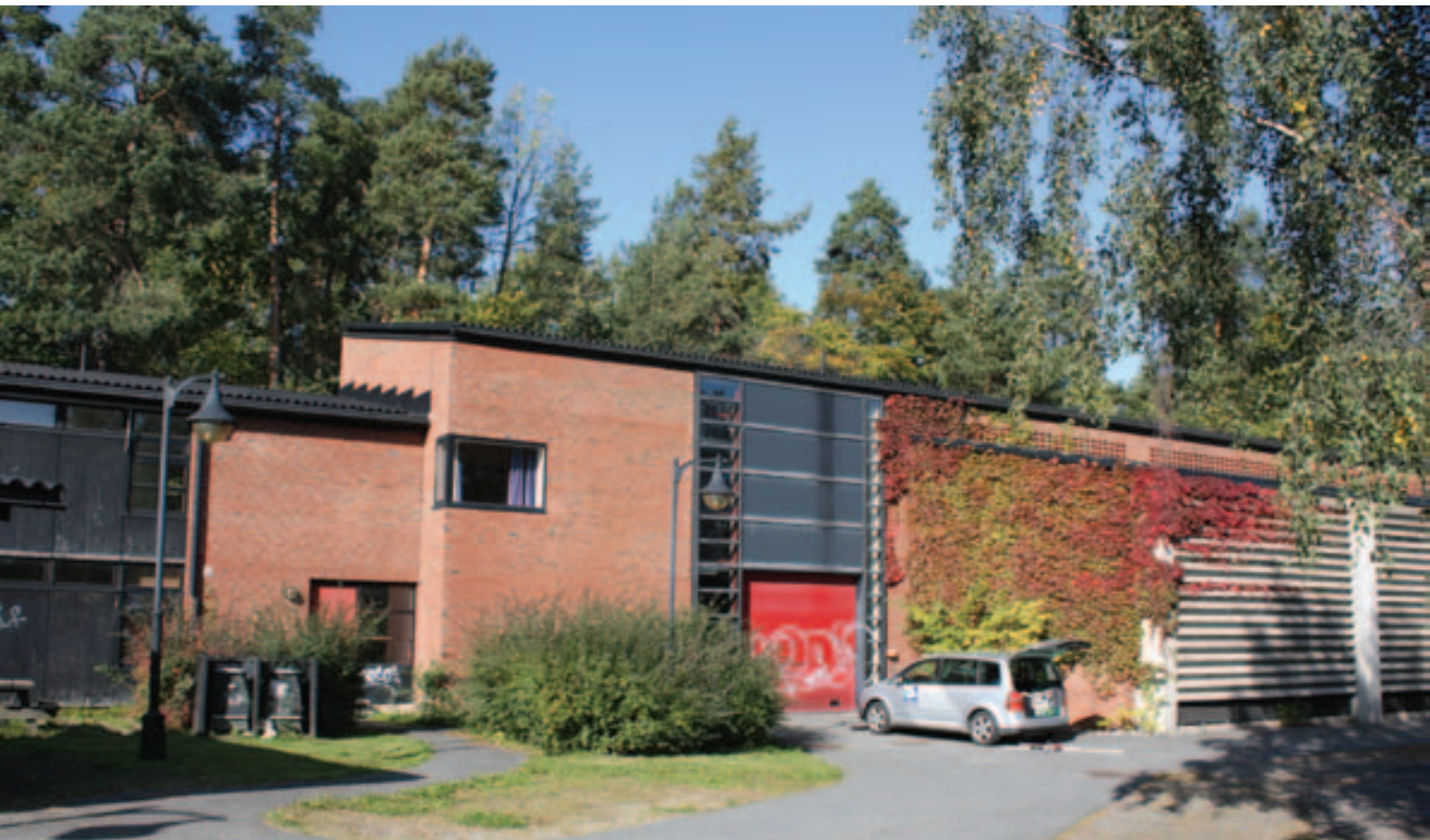
Fornebu transformatorstasjon i Bærum er også tegnet av arkitektfirmaet Guttorm Bruskeland. Med mørke farger og oppdeling i flere bygningsvolumer glir anlegget godt inn i stedets natur. Foto: Ivar E. Stav
