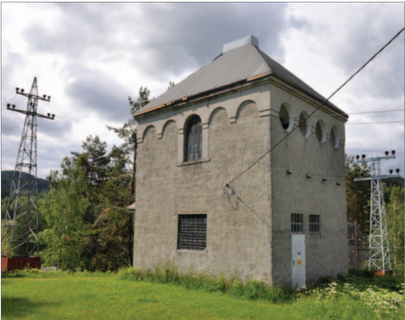
Sundet koblingshus, der ledningen fra Hakavik deler seg til henholdsvis Skollenborg og Asker. Foto: Henning Weyergang-Nielsen, NVE
