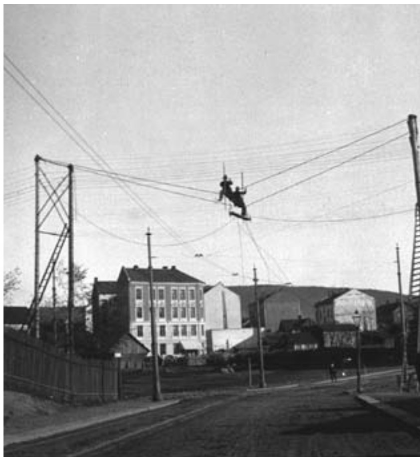
Fra byggingen av den første ledningen mellom Hammeren og Ankerløkka i 1899. Linjestrekking i krysset Kierschows gate / Uelandsgate på Sagene. Ukjent fotograf. Fra arkivet etter Oslo Lysverker / Oslo byarkiv
