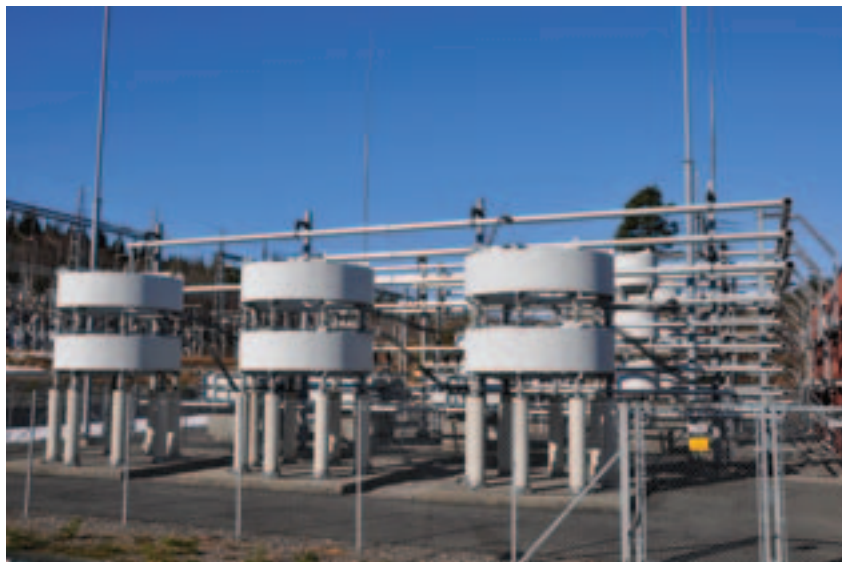
Midt på 1990-tallet fikk Kristiansand transformatorstasjon installert et spenningsregulerende SVC-anlegg, levert av ABB. Foto: Henning Weyerang-Nielsen, NVE
