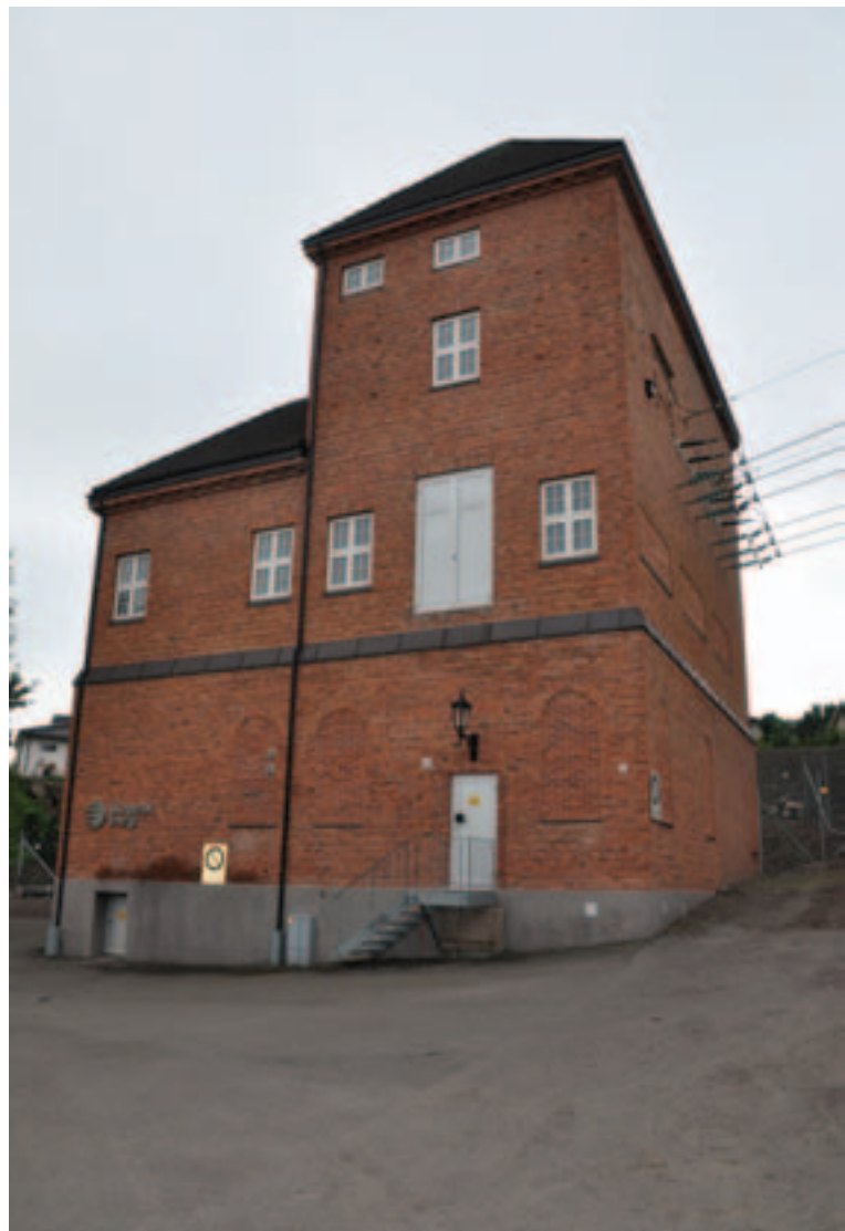
Denne transformatorstasjonen med borgpreg står i Horten og er fra 1912. Foto: Henning Weyergang-Nielsen, NVE
