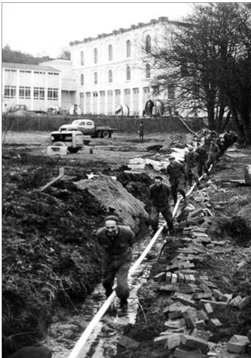
I 1959 gikk det ut 26 jordkabler fra transformatorstasjonen. Mange måtte trå til når kablene skulle legges ut. Foto: Lyse Energi AS
