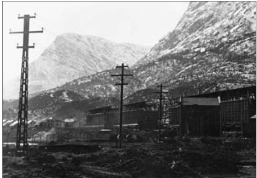
Kraftledningene fra Tyssedal endte i en fordelingsstasjon ved karbidfabrikken i Odda. Bildet er trolig fra 1908-1909, da bare den første ledningen var bygget ferdig. Fordelingsstasjonen ses til høyre for den siste masten. Foto: AS Tyssefaldenes fotosamling
