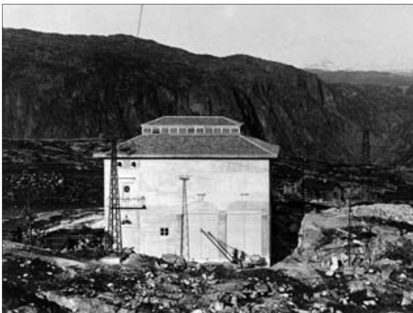
Katterat transformatorstasjon fotografert i 1922-1923. Til høyre ses 80 kV-ledningen mellom riksgrensen og Narvik. Foto: E. Solberg, Norsk Jernbanemuseums samling
