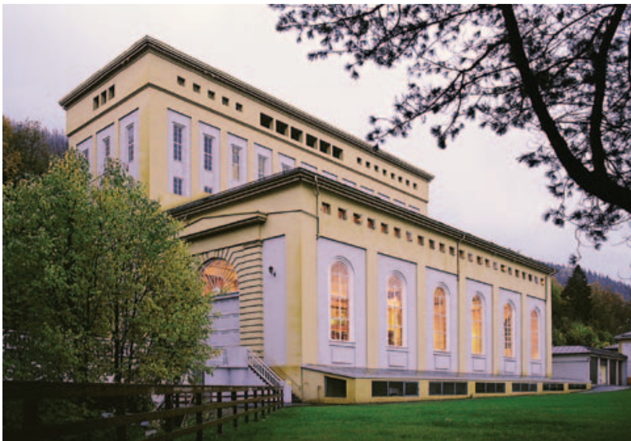
Fylkets tre hovedtransformatorstasjoner ble i likhet med kraftstasjonen i Follafoss tegnet av domkirkearkitekt Olaf Nordhagen. Den høyreste kraftstasjonen er litt mer monumental enn transformatorstasjonene, men enkelte fellestrekk går igjen. Foto: Steinar Johansen, for Nord-Trøndelag Elektrisitetsverk
