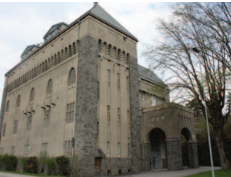
Hauen transformatorstasjon i Skien er tegnet av arkitekt Olaf Nordhagen og satt i drift i 1915. Den høyreiste bygningen har mange påkostede detaljer. Foto: Ivar E. Stav
