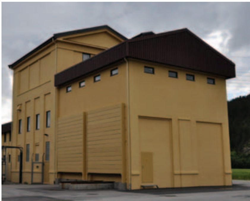
Den opprinnelige transformatorporten på tverrveggen er erstattet av to nye porter på langveggen mot sør. De åpne galleriene for inntak av luftledninger er tettet igjen. Foto. Sissel Riibe, NVE
