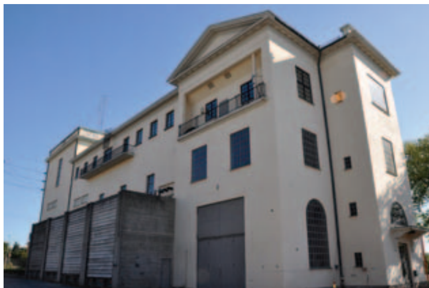
Ved gjenoppbyggingen etter brannen i 1933 ble hovedtransformatorene plassert utendørs. Foto: Sissel Riibe, NVE
