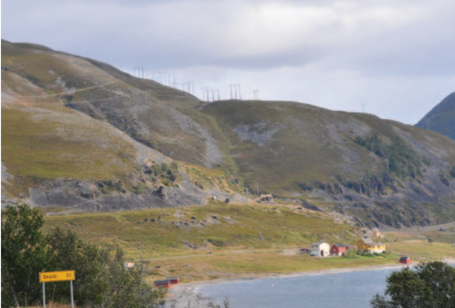
Kraften fra Kvænangen ble fra 1965 levert over regionalnettet fra Skaidi. Nettet ble senere forsterket, og i dag går det to parallelle 132 kV-ledninger over Kvaløya til transformatorstasjonen i Hammerfest. Foto: Henning Weyerang-Nielsen, NVE
