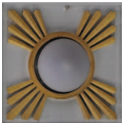
Detalj av trappegelender og taklampe i Noreveien 24. Foto: Sissel Riibe, NVE
