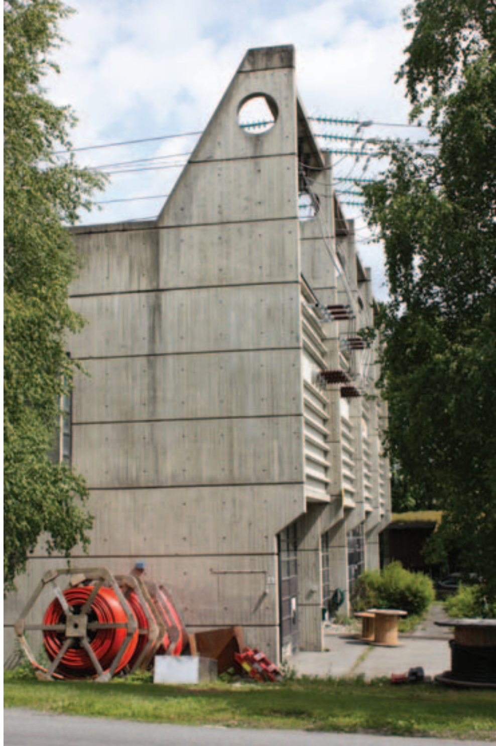
Rud transformatorstasjon i Bærum har en dynamisk og kraftfull form. Her griper bygningen tak i luftledningene. Tegnet av arkitektfirmaet Guttorm Bruskeland. Foto: Ivar E. Stav
