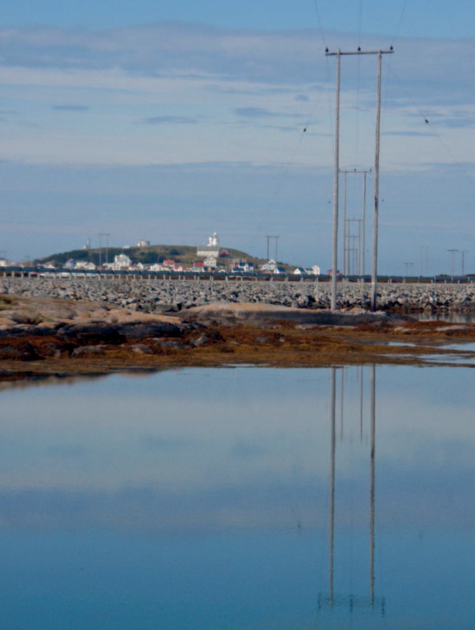
Distribusjonsnettet i Norge strekker seg helt ut til de ytterste øyer og skjær. Denne 22 kV-ledningen går fra Lomsøya til Sula i havet utenfor Frøya på Trøndelagskysten. Foto: Rune Aasgaard
