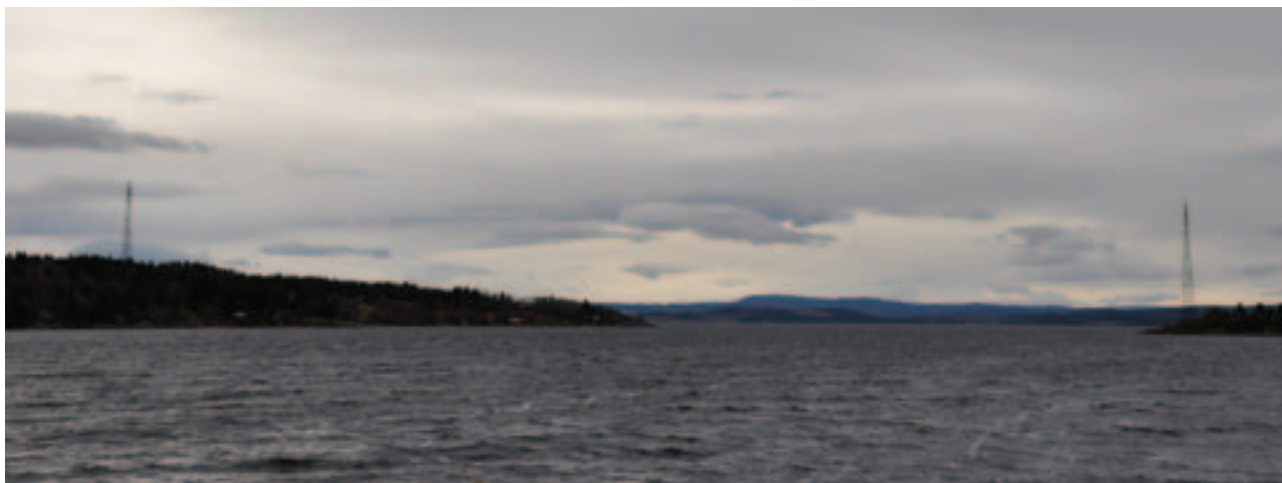
Spennvidden mellom de to tårnmastene i Beitstadsundet er 626 meter. Foto: Sissel Riibe, NVE
