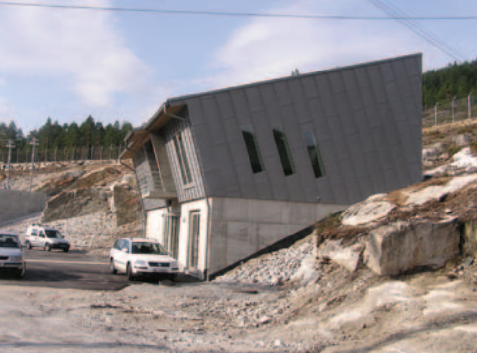
Statnetts kontrollbygg ved Brokke transformatorstasjon er støpt i betong. Den utoverskrånende andreetasjen er kledd med sinkplater. Tegnet av Tore Karlsøen i arkitektkontoret LINK Signatur. Foto: Steinar Rosseland, Statnett SF
