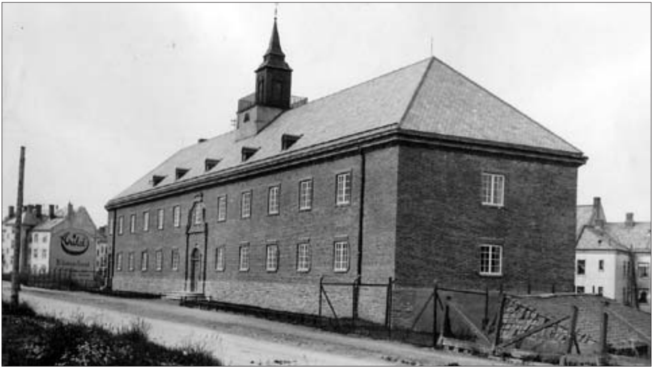
Paulinelund 2 i Trondheim, etter idriftsettelsen i 1927. Foto: Trondheim Energi
