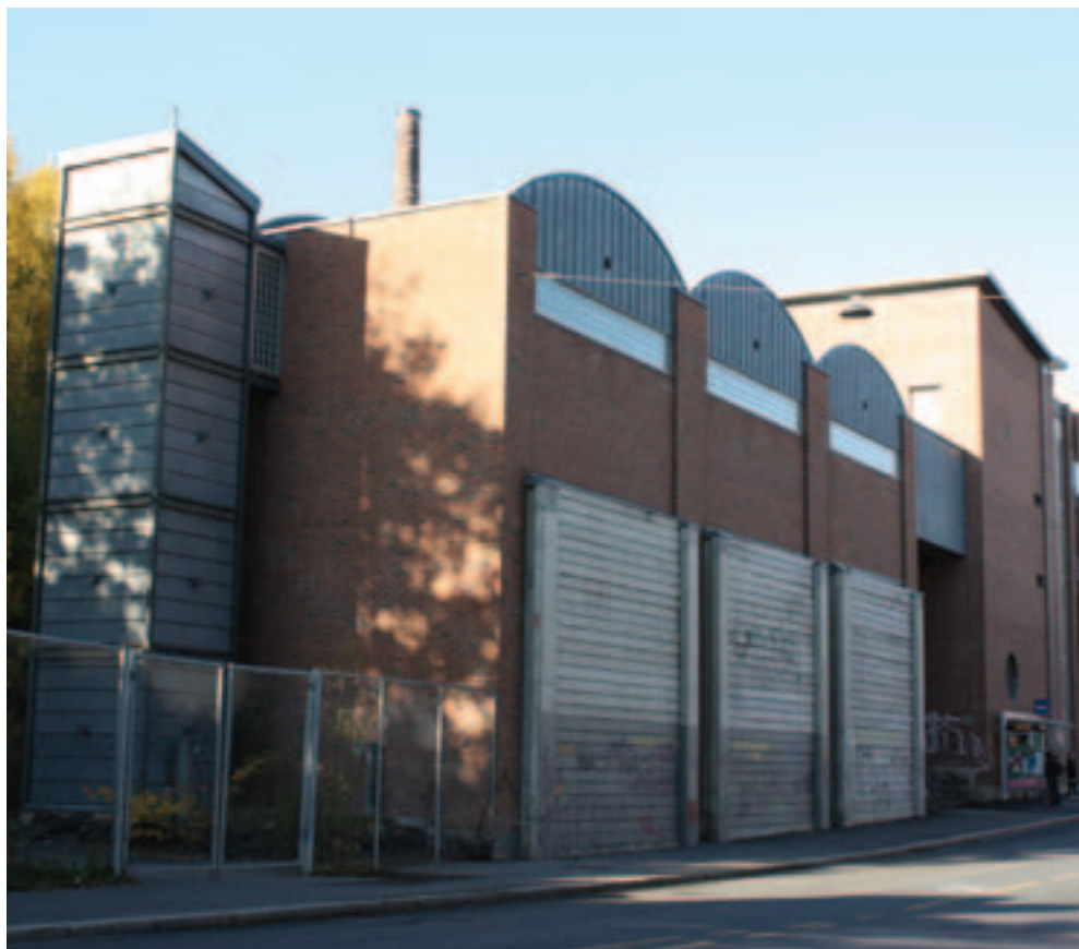
Akersberget transformatorstasjon i Oslo fra 1995 er tegnet av Tias Berg. Anlegget er godt integrert i bystrukturen. Hovedfasaden følger Maridalsveiens løp. Foto: Ivar E. Stav
