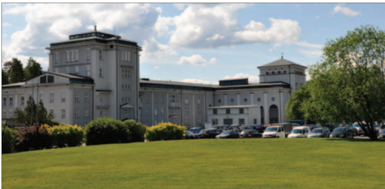
Smestad transformatorstasjon juni 2009: Stasjonen fremstår som godt ivaretatt, og særlig utvendig har den i stor grad bevart sitt arkitektoniske uttrykk slik det fremstod etter utvidelsene i 1928. Foto: Henning Weyergang-Nielsen, NVE
