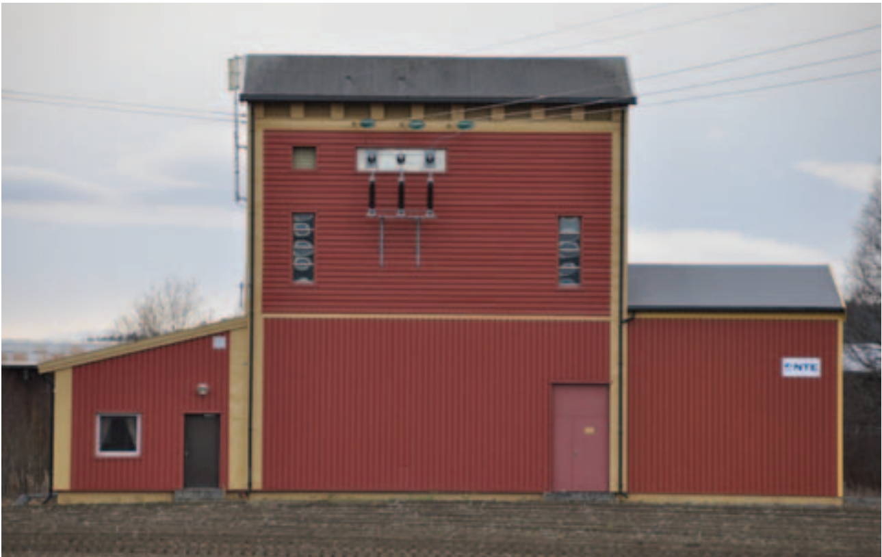
Eksempel på nøktern arkitektur: Skogmo transformatorstasjon i Overhalla i Nord-Trøndelag ble oppført like før andre verdenskrig og satt i drift i 1945. Bygningen i betong er senere platekledd. Foto: Sissel Riibe, NVE
