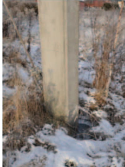
Stålmaster festes som regel til et fundament støpt i betong, mens for betongmaster blir vanligvis mastebeinet ført ned i et hull i bakken og "låst fast". Begge foto: Henning Weyergang-Nielsen, NVE
