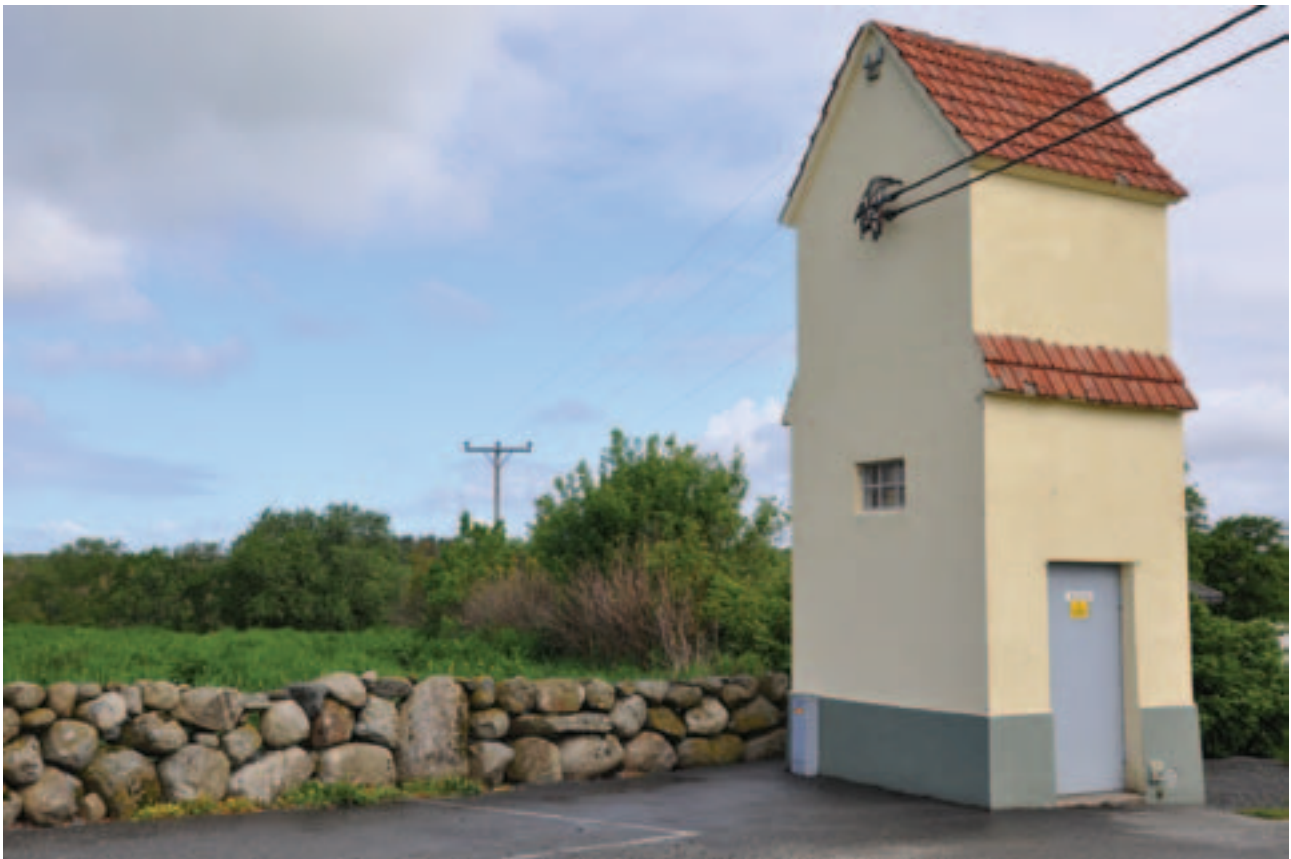
På Garborg, like ved barndomshjemmet til dikteren Arne Garborg, står dette transformatorstårnet fra rundt 1920 i et vakkert og karakteristisk jærlandskap. Det er nylig restaurert av dagens eier Lyse Energi. Foto: Sissel Riibe, NVE
