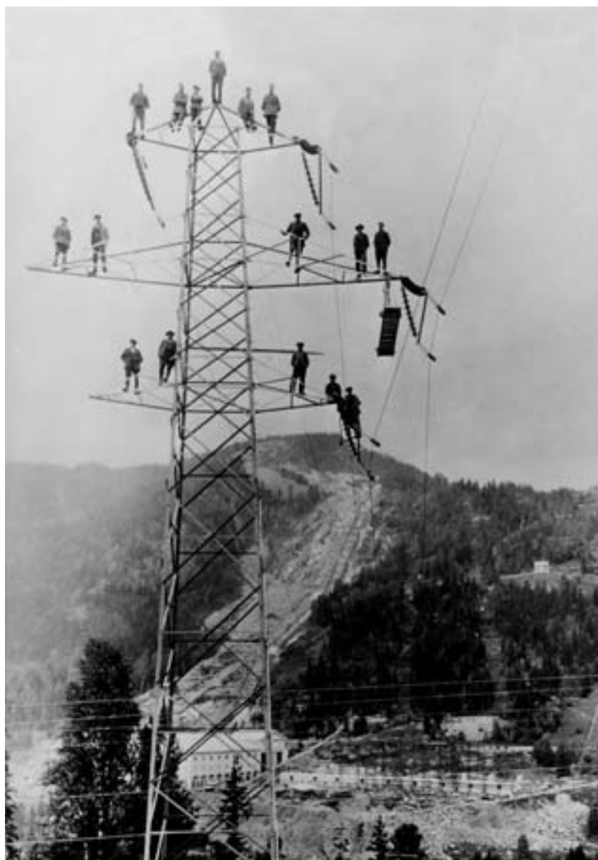
Nore kraftverk ble satt i drift i 1928, og herfra ble det bygget ledning til Flesaker. Som vi ser var ikke kravene til sikkerhet de samme som i dag. Foto: Statkraft
