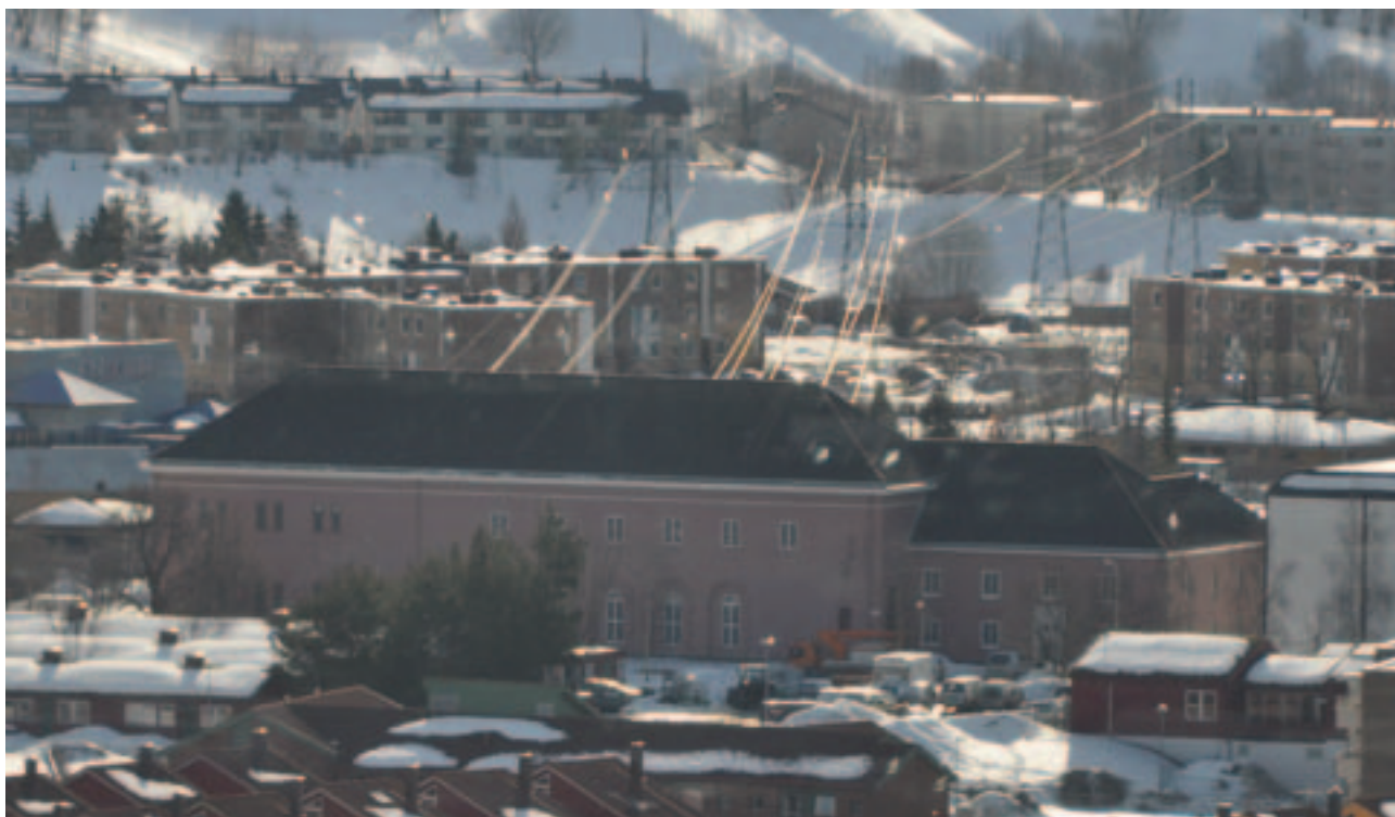
Moholt transformatorstasjon anno 2009 ligger i et område preget av rekkehus, studentboliger og store butikker. Bildet viser anlegget fra nordvest, fotografert fra Tyholtårnet. Foto: Henning Weyergang-Nielsen, NVE
