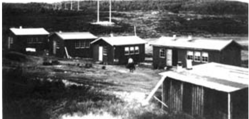
Brakkerigg på Sveipe, satt opp i forbindelse med byggingen av betongmastledningen Vinstra–Oslo på begynnelsen av 1950-tallet. Foto: Statnett
