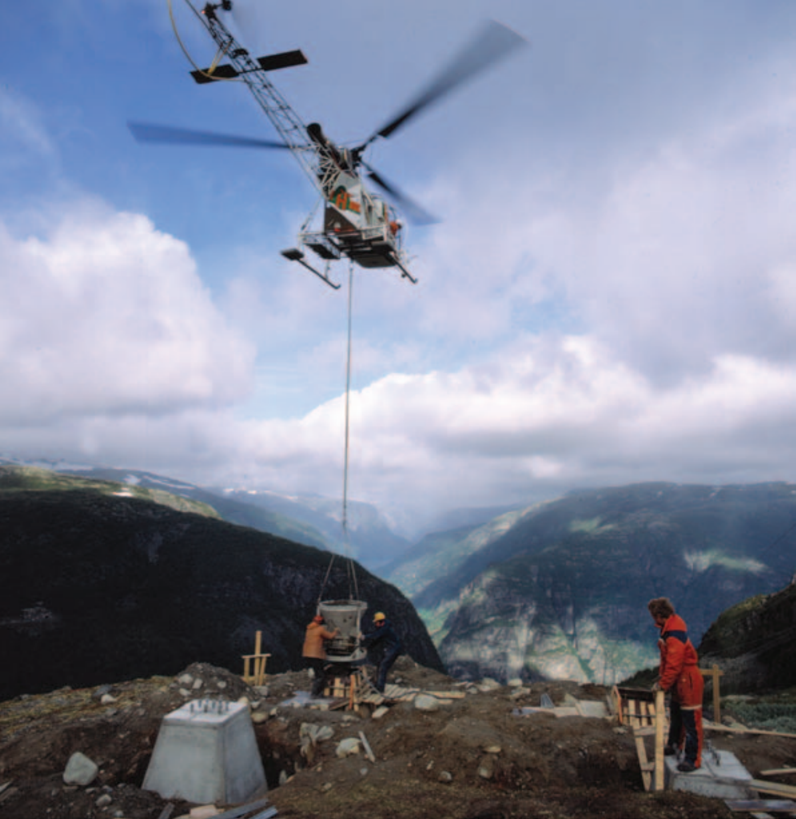
Utviklingen av ferdigbetong og økt bruk av helikopter har gjort fundamenteringsarbeidet langt enklere, som her under byggingen av ledningen Hol–Aurland. Ukjent fotograf. Fra arkivet etter Oslo Lysverker / Oslo byarkiv
