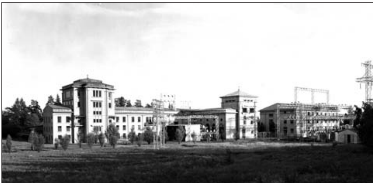
Smestad transformatorstasjon fotografert i 1936. Den eldste delen av Noreveien 26 ligger midt i bildet. I 1928 ble dette anlegget bygget på mot nordøst, og et nytt fasekompensatorhus ble i tillegg bygget på nabotomten i Noreveien 24. Foto: Statnett
