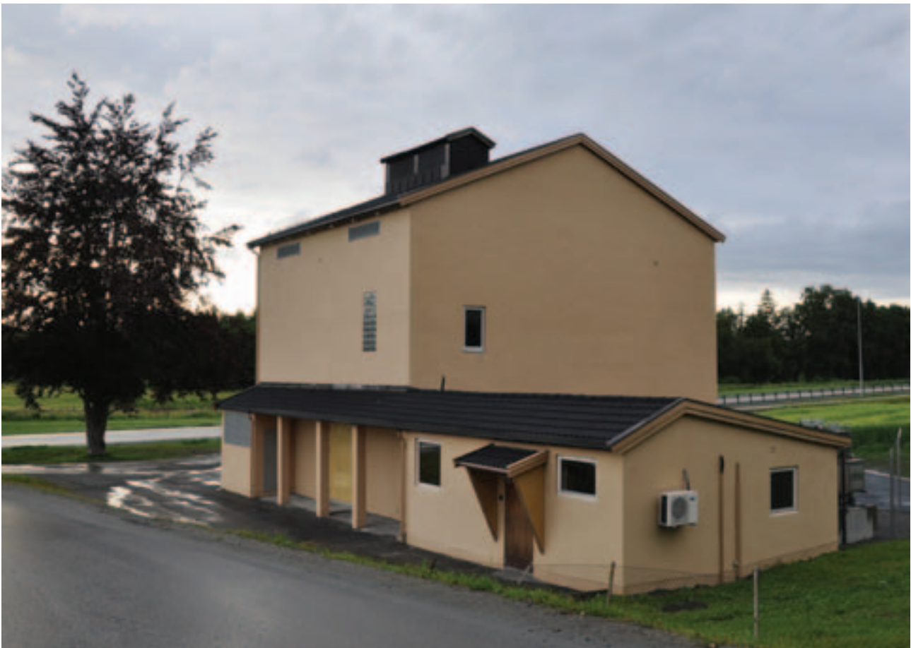
Røra transformatorstasjon i Nord-Trøndelag er eksempel på en stasjonsbygning med kontorfløy. Foto: Sissel Riibe, NVE
