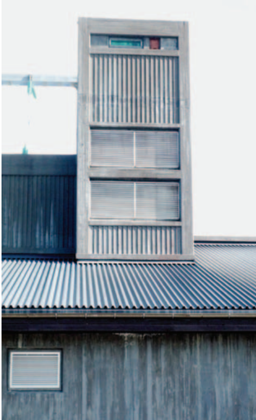
Tårnet i bygningens sørlige ende, utformet av hensyn til Kraftforsyningens Siviltforsvarsnemnds krav om muligheter for vakt hold over anlegget i forsvarshensyn.
