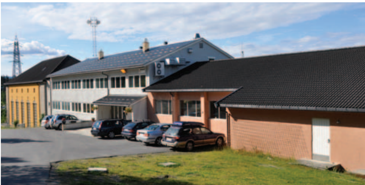
Flesaker transformatorstasjon er et godt eksempel på ulike epokers industriarkitektur. Her ser vi kontrollbyggets østvegg. Foto: Henning Weyergang-Nielsen, NVE
