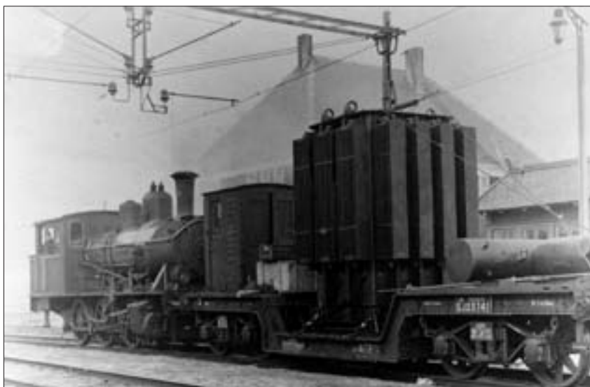
Transformator til transformatorstasjonen opplastet på svensk dyplastevogn. Fotografert i 1922-1923. Foto: E. Solberg, Norsk Jernbanemuseums samling
