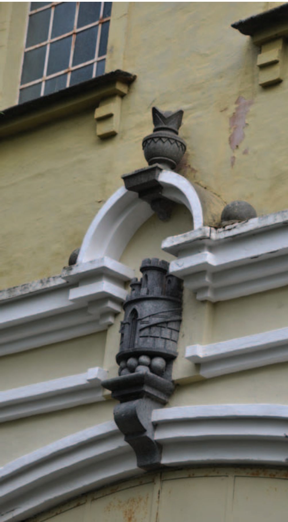
Detalj av fasade på Sandviken transformatorstasjon i Bergen fra 1928. Over en av de rundbuede transformatorportene finner vi byvåpenets borgtårn i rundskulptur. Foto: Henning Weyergang-Nielsen, NVE
