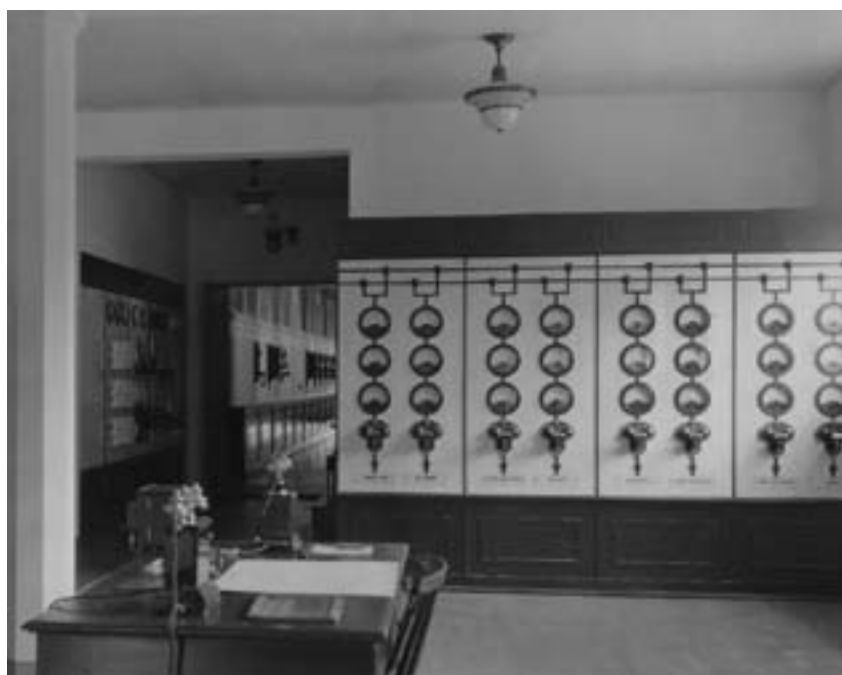
Kontrollrommet med instrumentering på tavler i åpen firkant, slik det fremstod etter anleggets ferdigstillelse på 1920-tallet. Foto: Trondheim Energiverk
