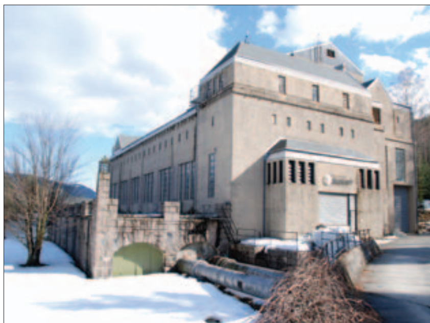
Hakavik kraftverk ved Eikeren i Buskerud produserte fra 1922 kraft til elektrifiseringen av statens jernbaner på Østlandet. Foto: Elisabeth Høvås, NVE
