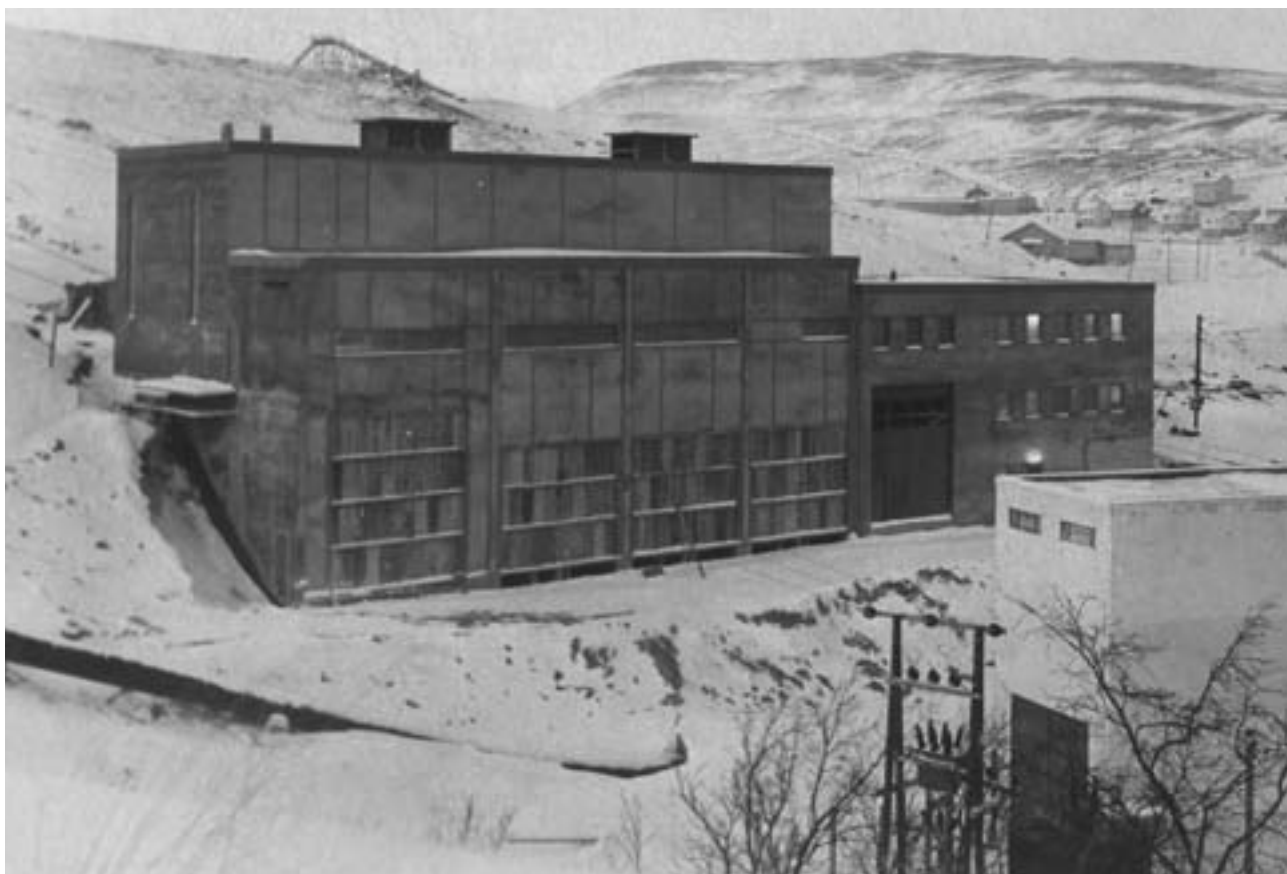
Den nye transformatorstasjonen i Hammerfest ble satt i drift våren 1967. Slik så den ut da den var ny. Foto: Hammerfest Energi AS
