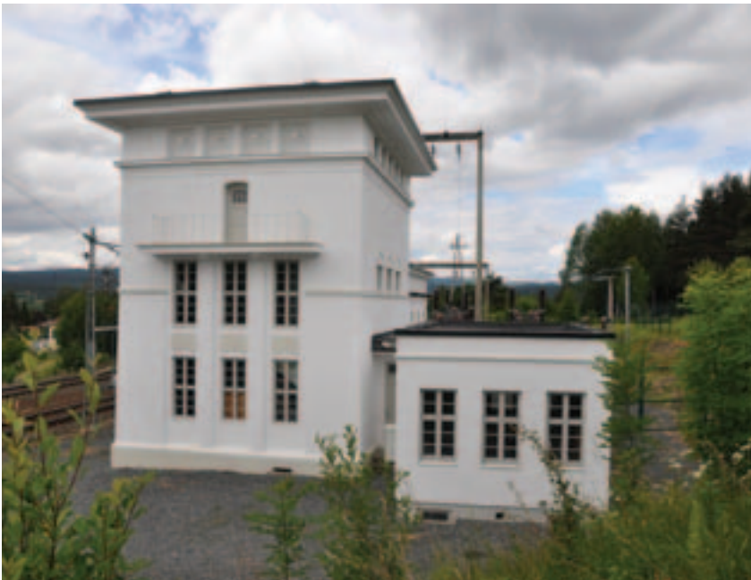
Skollenborg transformatorstasjon er et stilrent eksempel på 1920-tallets nyklassisisme. Tegnet av Gudmund Hoel ved NSBs arkitektkontor. Hovedbygningen ble satt i drift i 1929 og det lavere tilbygget til høyre i 1956. Foto: Henning Weyergang-Nielsen, NVE
