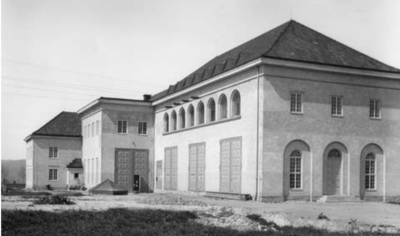
Stasjonen sett fra øst, slik den fremstod kort tid etter idriftsettelsen på 1920-tallet. Foto: Trondheim Energiverk
