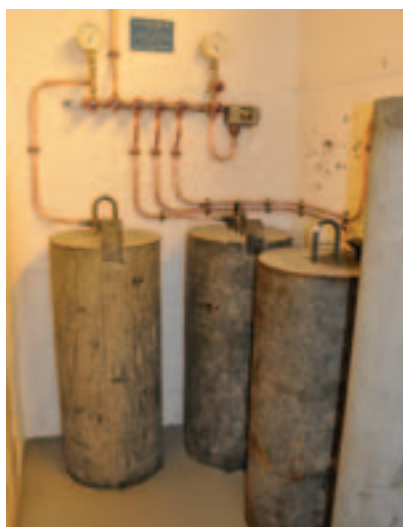
I 1968 ble det montert oljekabelanlegg da den gamle Follafoss-ledningen ble lagt i kabel under den nye flyplassen på sørsiden av stasjonen. Foto. Sissel Riibe, NVE
