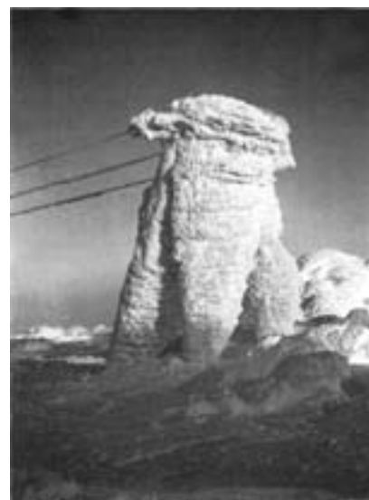
Topografien i Norge har medført at det – i større grad enn i de aller fleste andre land – har vært nødvendig å bygge kraftledninger gjennom områder med kupert terreng og værhardt klima. Naturens rammebetingelser har derfor ofte utfordret ledningsbyggingen. Bildet viser en nediset mast på kraftledningen opp til fjernsynssenderen på fjellet Lønahorgi ved Voss i Hordaland. Foto: Voss Energi AS
