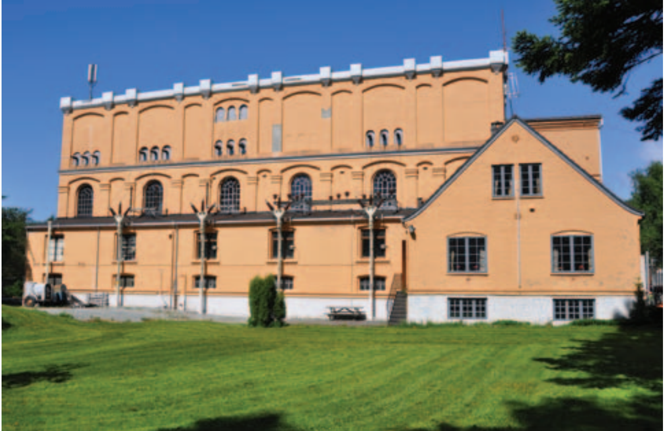
Den første transformatorstasjonen i Stavanger by ble oppført ved Mosvatnet i 1909. Bygningen ble senere forlenget i samme stil, og den lave fløyen med bolig for vaktmann ble oppført i 1913. Foto: Sissel Riibe, NVE
