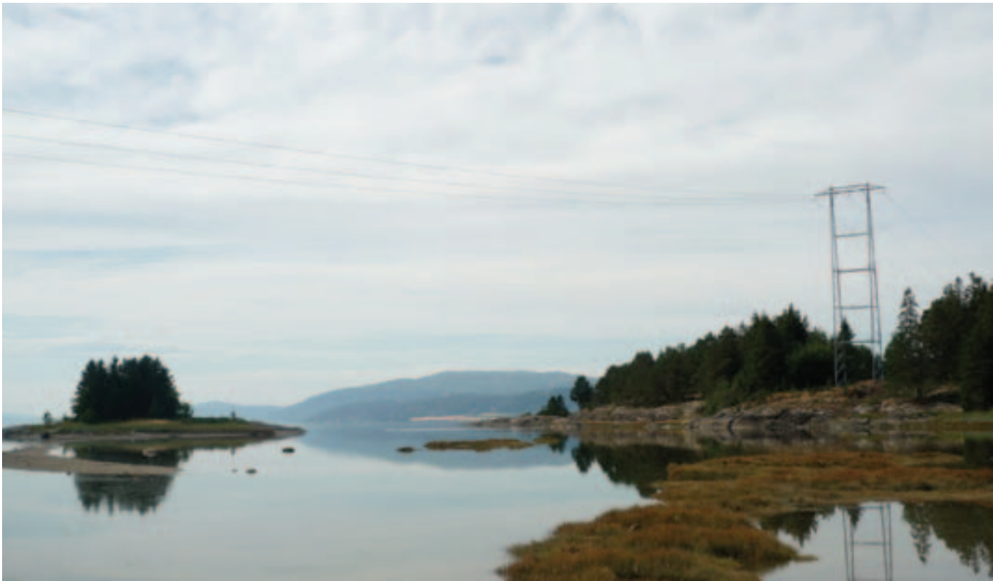
Over Hammerleiret på nordsiden av Steinkjerfjorden ble det på slutten av 1990-tallet satt opp nye portalmaster av stål. Foto: Sissel Riibe, NVE
