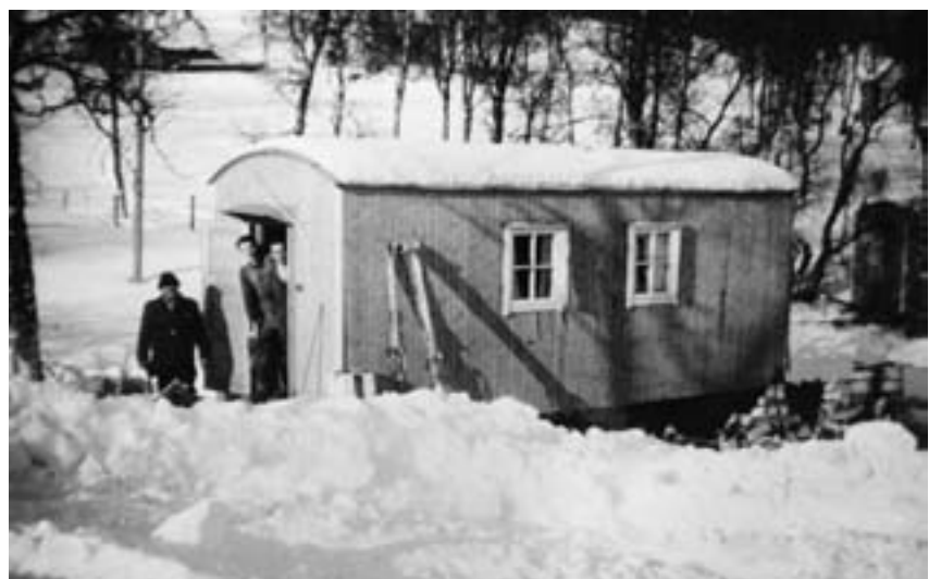
Ofte var boforholdene enkle. Bildet viser brakke for innlosjering av ledningsbyggere på Tjeldøya, i forbindelse med byggingen av ledningen Kvanndal–Kanstadbotn i 1957. På bildet ser vi Anders Jakobsen, R. Ingebrigtsen og Arthur Pettersen. Foto: Arbeiderbevegelsens arkiv og bibliotek
