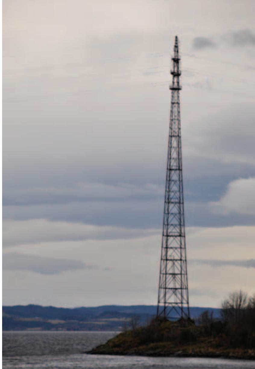
I Beitstadsundet står den ene av de 78 meter høye tårnmastene fra 1923 på Rambergsholmen, der hekkende sjøfugl holder den med selskap. Foto: Sissel Riibe, NVE
