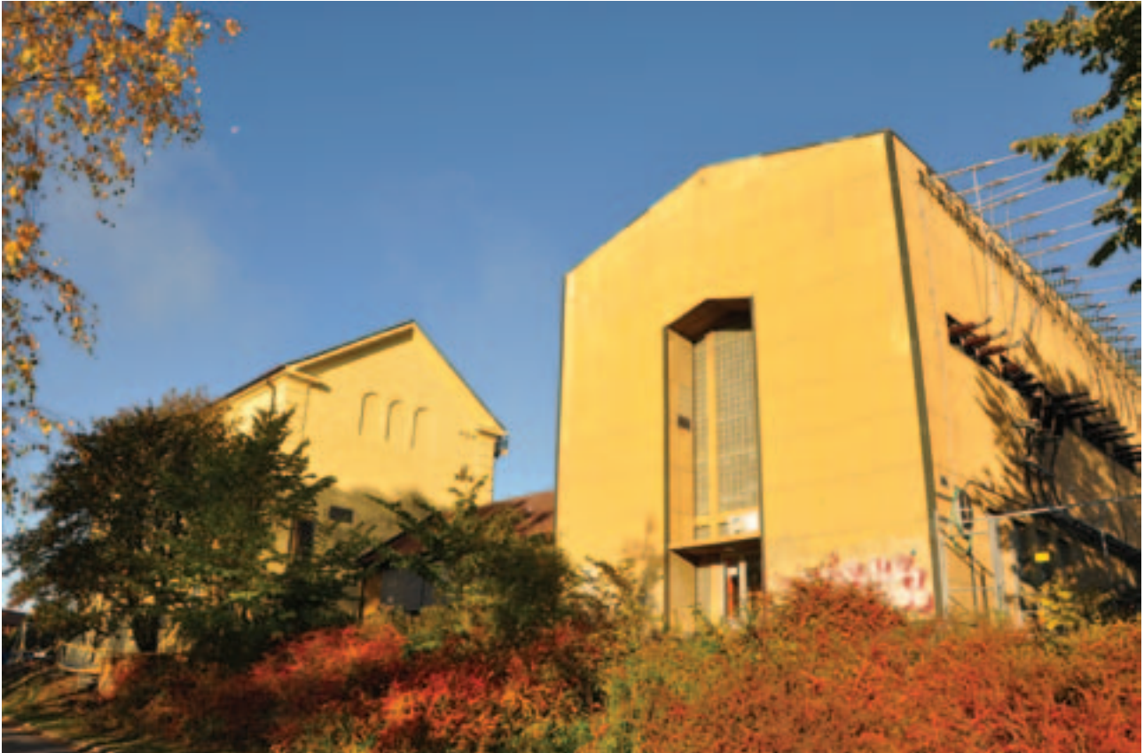
Glommens Træsliberis transformatorstasjon fra 1920 på Nesset i Moss ble tegnet av Thorvald Astrup. På 1950-tallet ble stasjonen utvidet med bygningen til høyre som ble tegnet av arkitektkontoret Thv. & Henning Astrup og Eivind Hellern. Foto: Henning Weyergang-Nielsen, NVE
