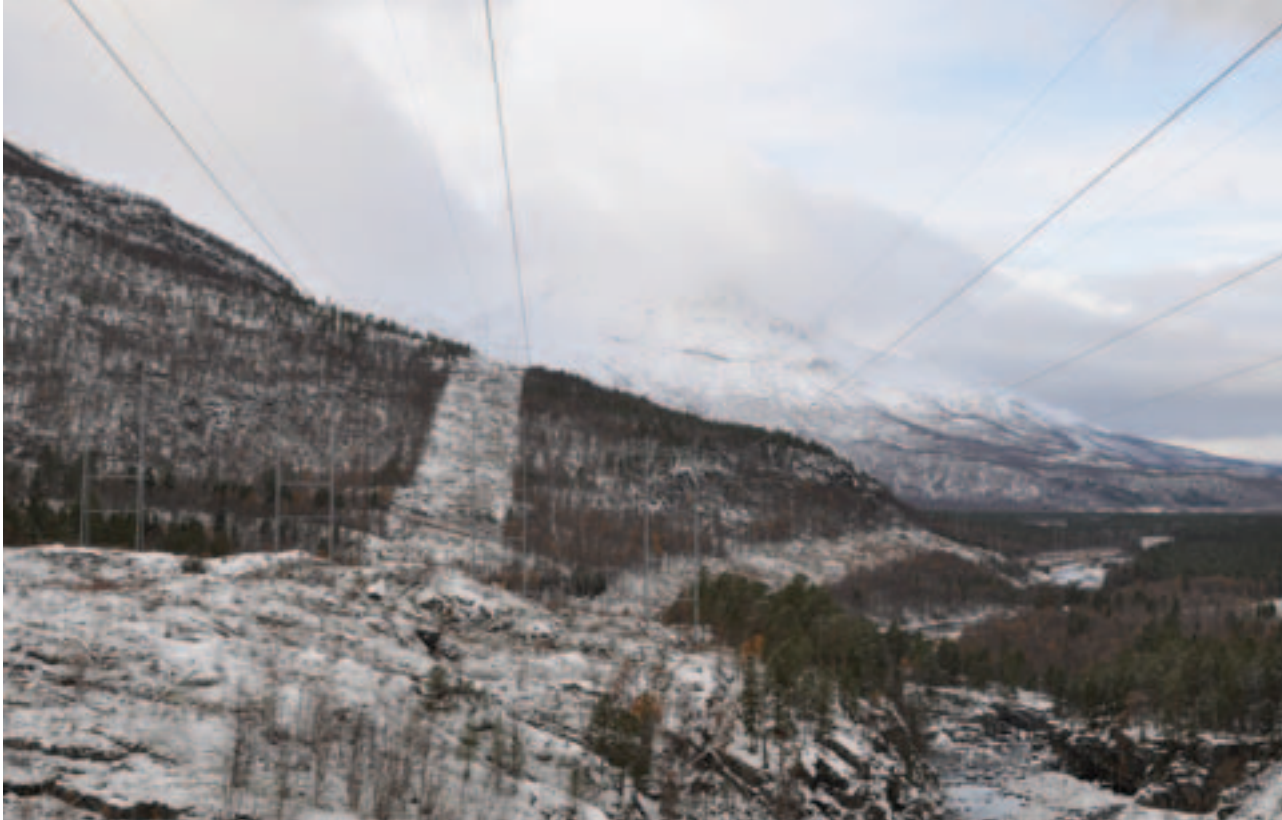
Traseer vest for Straumsmo. Til venstre de to ledningene fra 1960 og 1966 vestover mot Kvanndal. Til høyre de to ledningene fra 1960 og 1974 nordover mot Bardufoss. I bakgrunnen troner Storfjellet 1395 moh, og til høyre renner Barduelva. Foto: Sissel Riibe, NVE
