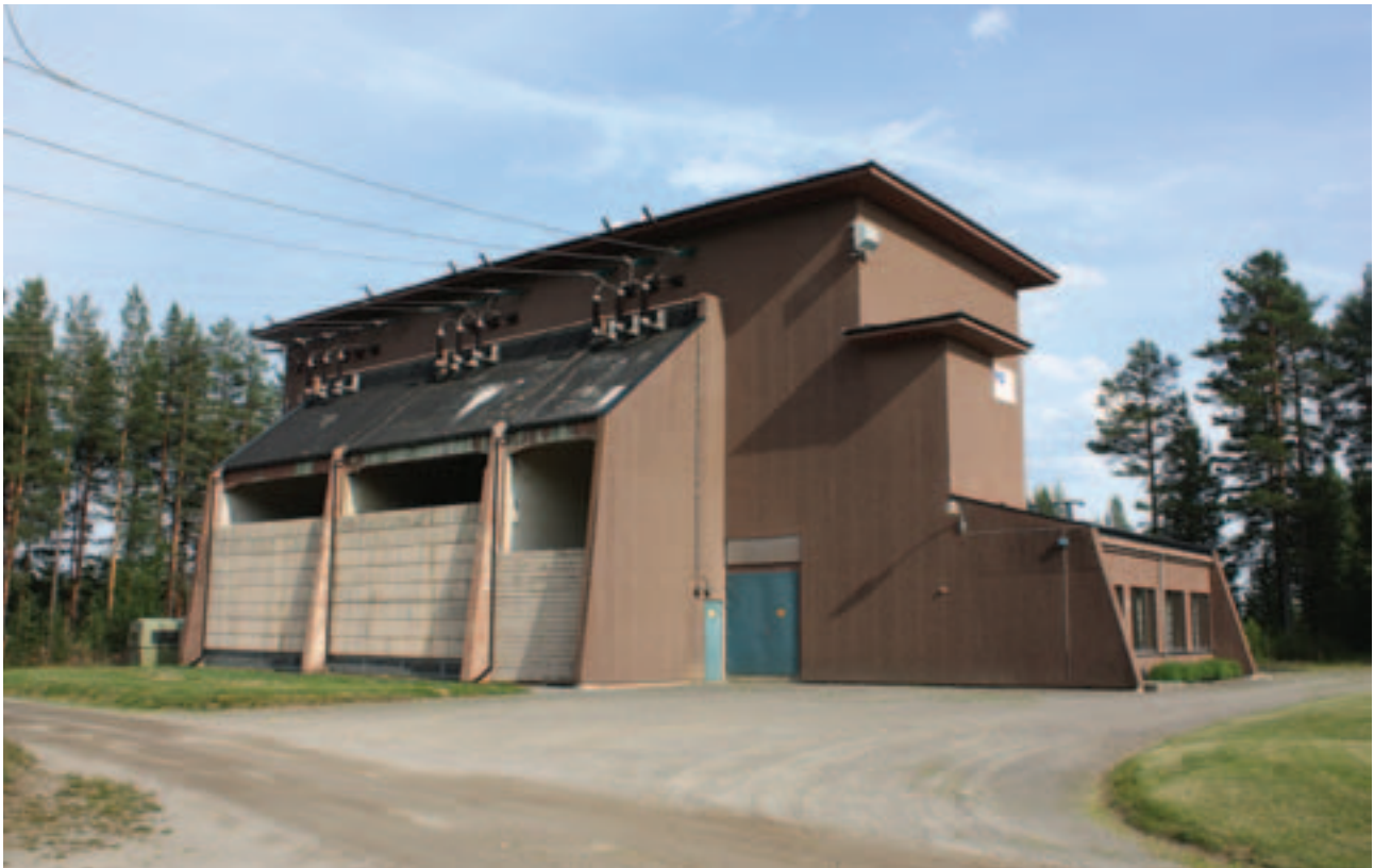
Elverum transformatorstasjon, Grindalsmoen, fra 1954 er utformet av sivilingeniør Ottar Birkeli. Foto: Ivar E. Stav
