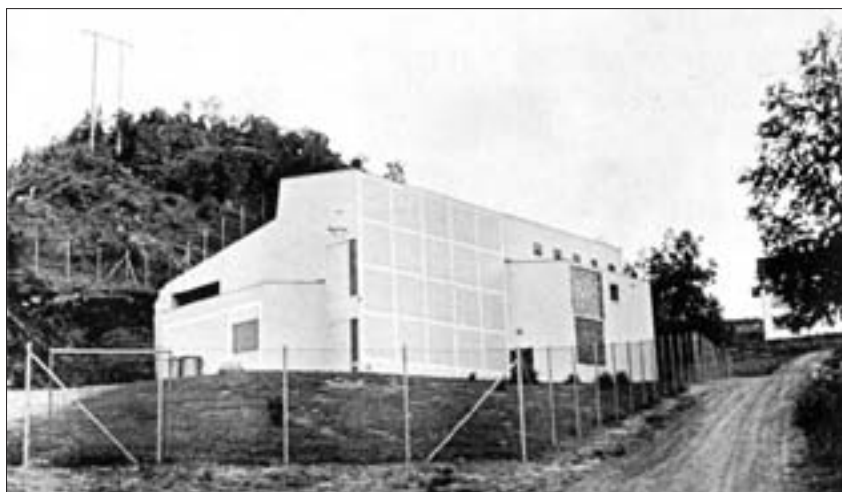
Heggen transformatorstasjon noen år etter driftsettelsen. Foto: Vågsfjord Kraftselskap
