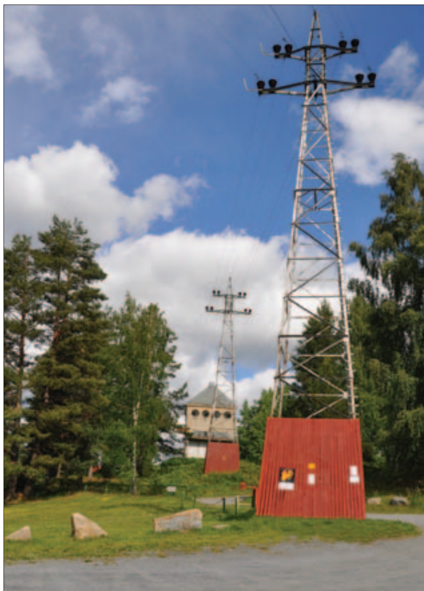
Ledningen Hakavik – Asker gjennom Buskerud på vei mot Sundet koblingshus. Foto: Henning Weyergang-Nielsen, NVE
