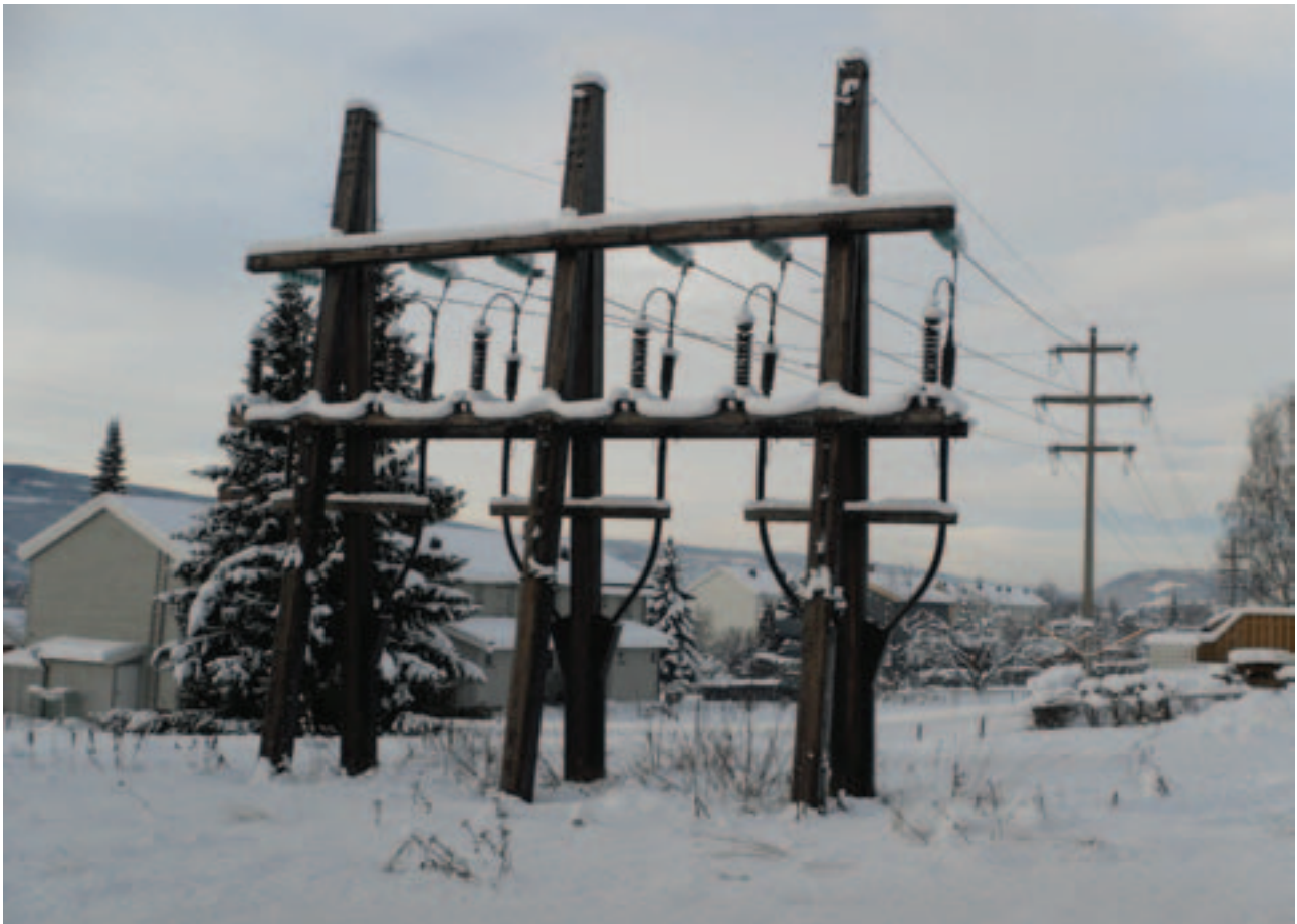
I forbindelse med OL på Lillehammer ble deler av en eldre 66-kilovolts betongmastledning revet for å gi plass til OL-anleggene. Ledningen ble i stedet lagt som jordkabel forbi Håkons hall og Kristins hall. Endemastene med kabelmuffer ble bygget i limtre for å harmonere med betongmastene. Bildet er tatt ved Håkons hall sett mot nord. Foto: Knut Stabell
