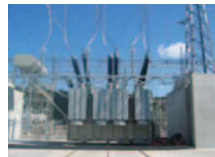
Transformatorer finnes i svært ulike størrelser, fra små stolpetransformatorer på distribusjonsnettsnivå til store 420-kilovolts transformatorer på sentralnettsnivå. Foto t.v.: Sissel Riibe, NVE, foto t.h.: Statnett
