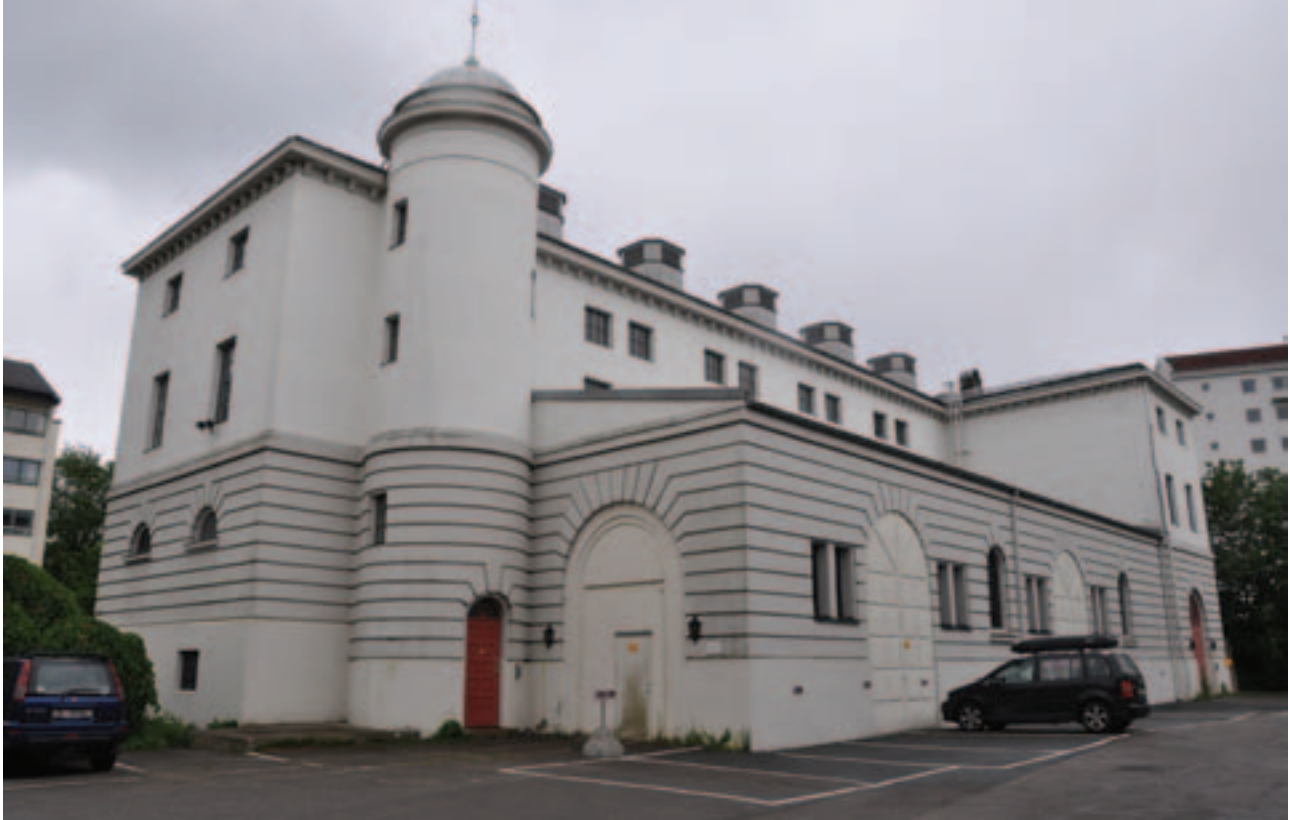
Skøyen transformatorstasjon i Oslo er tegnet av arkitekt Thorvald Astrup og ble satt i drift i 1922. Foto: Henning Weyergang-Nielsen, NVE
