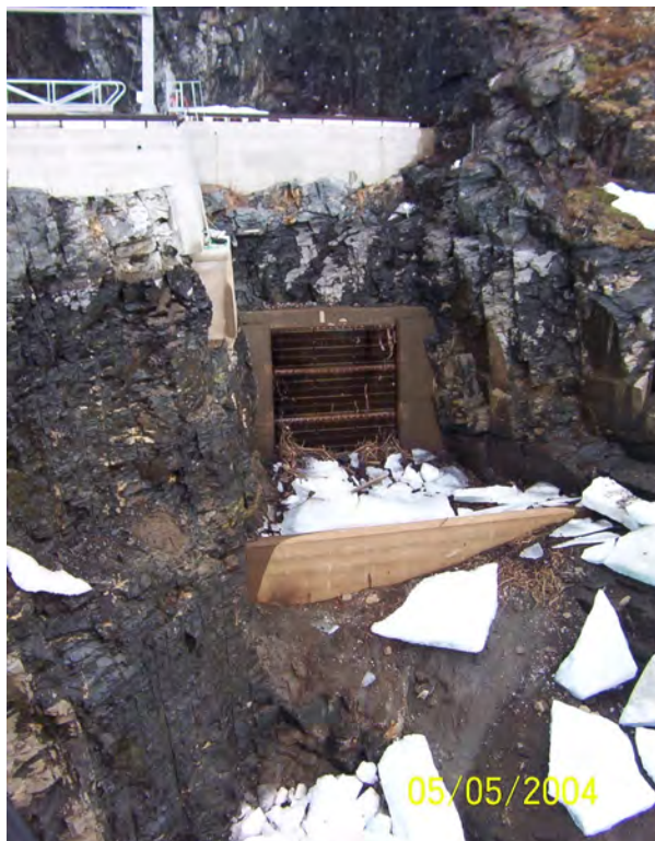
Figur 21 Øvre inntak i fjellet like oppstrøms Altadammen 5.5.2004. Foto Arve Tvede, Statkraft
