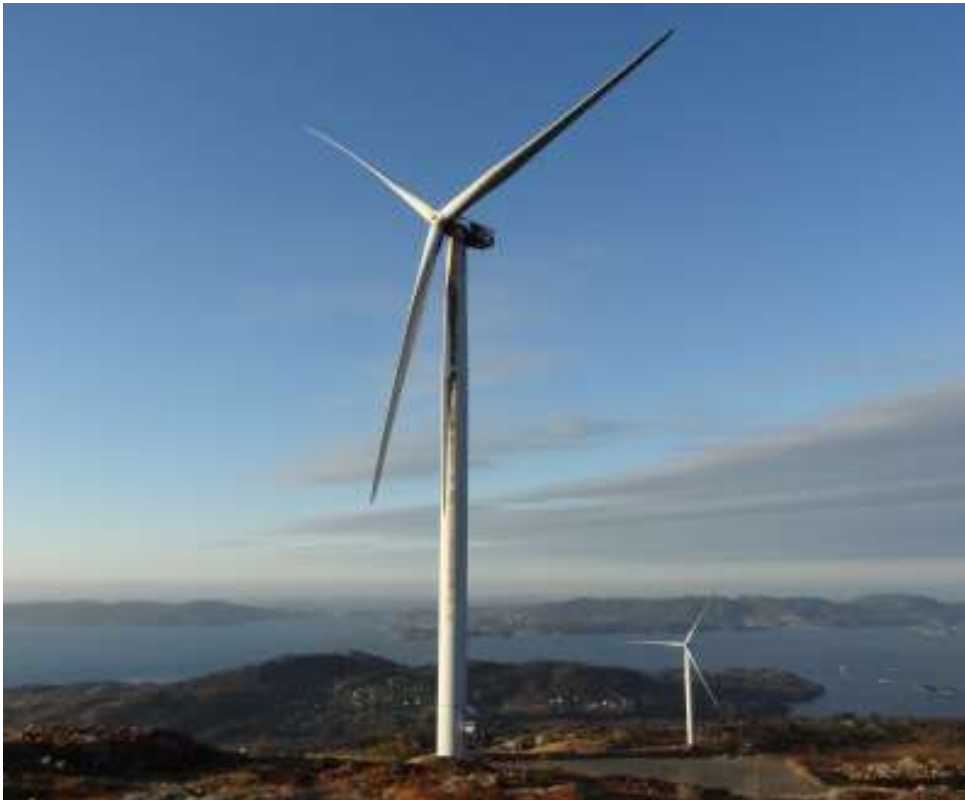
Figur 6: I 2015 ble én vindturbin i Midtfjellet vindkraftverk skadet da det begynte å brenne i vindturbinen. Foto: Midtfjellet Vindkraftverk AS.
