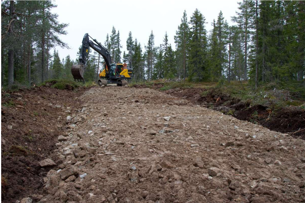
Figur 2: Bygging av vei i skogsterreg i Raskiftet vindkraftverk i Hedmark. Foto: NVE/Olav Haaverstad.
