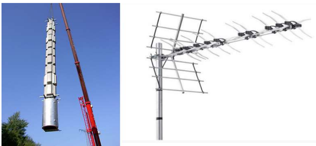
Bilde 2: Montering av en rundtstrålende DVB-T senderantenne (til venstre) og en typisk direktiv mottakerantenne for DVB-T (til høyre) (Kilder: http://www.kathrein.de/content/index.cfm/presse.view?id=1123&language=en og https://www.rikstv.no/produkter/utstyr/stor-antenne/ nedlastet: 27.02.2018).
