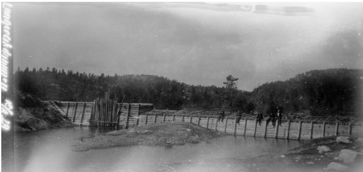
Første byggefase av reguleringsdammen (Bygd 1912 – 1914 i 1929) (Conrad Holteng/NVE)
