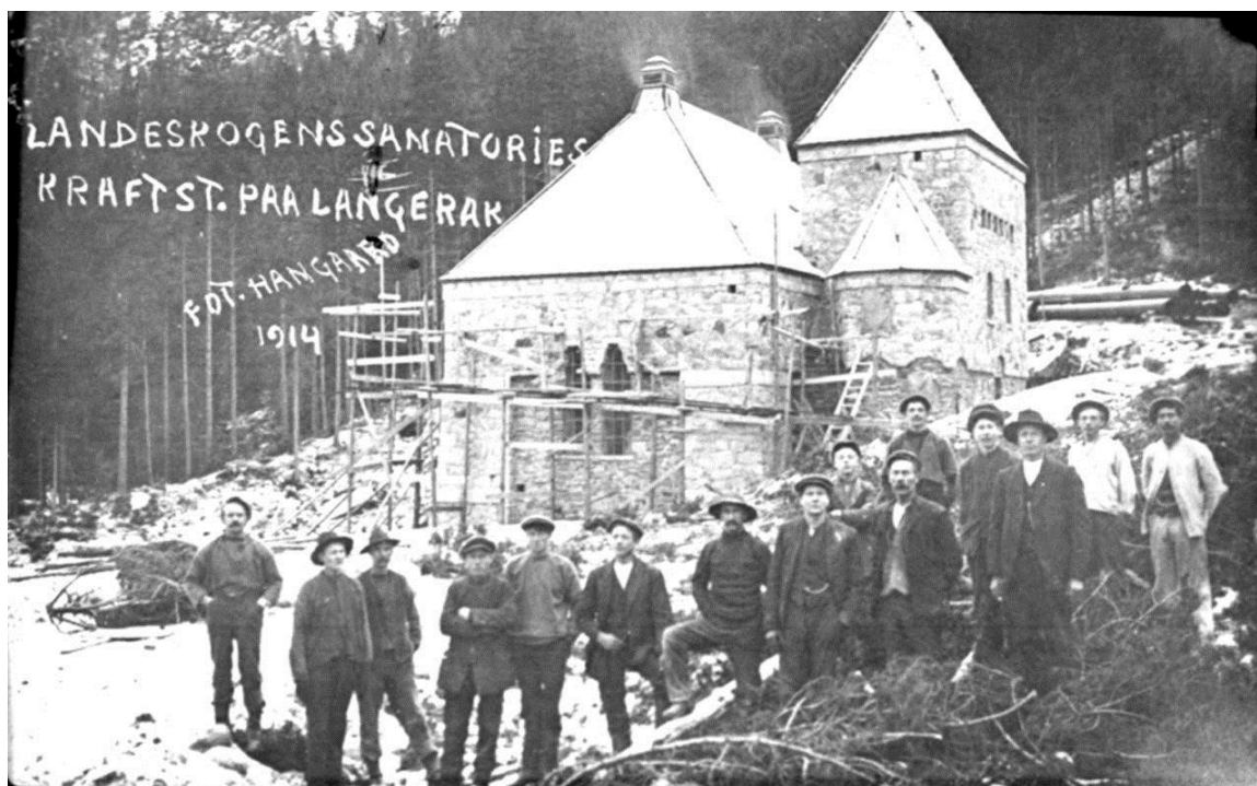
Langeraks kraftstasjon under utbygging 1914 – 1916 (Hangaard 1914)
