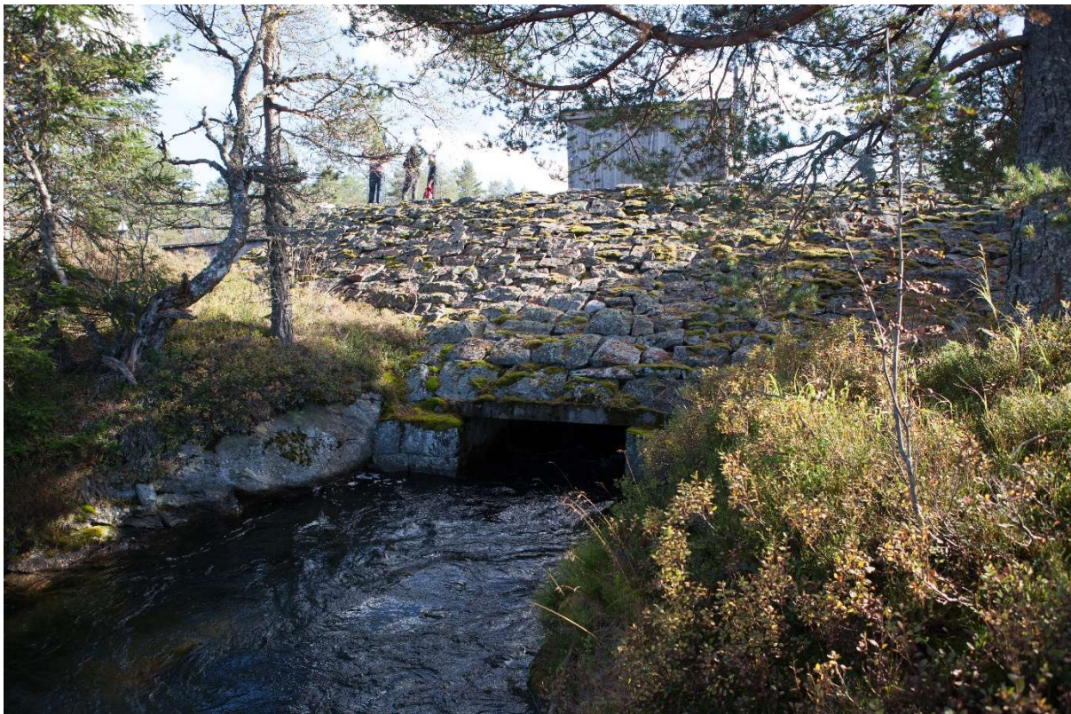
Utløpskanal på luftsiden med 0,25 betongplate over utløpet (se under) (Stig Storheil/NVE 2016)
