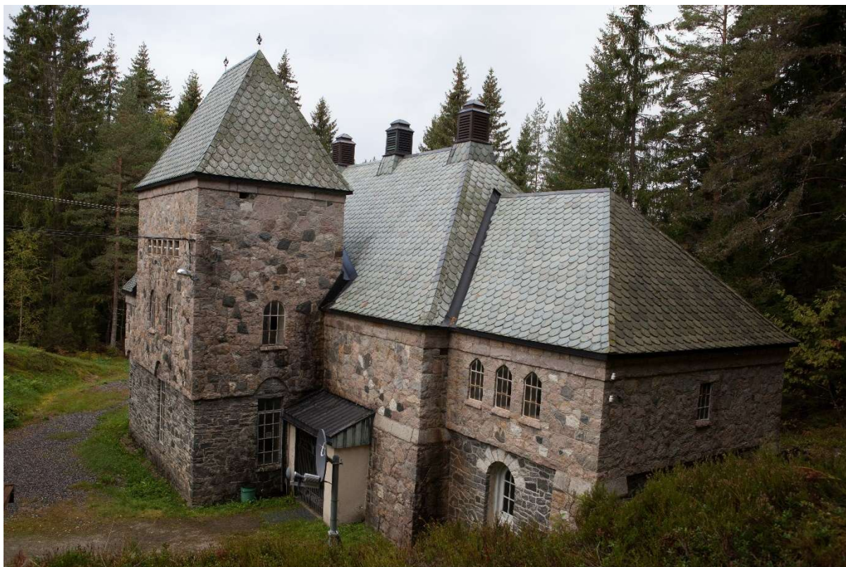
Longerak kraftstasjon (Stig Storheil/NVE 2016)
