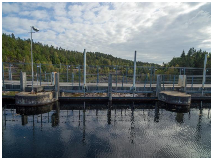
Haugsjø dam fotografert oppstrøms.
