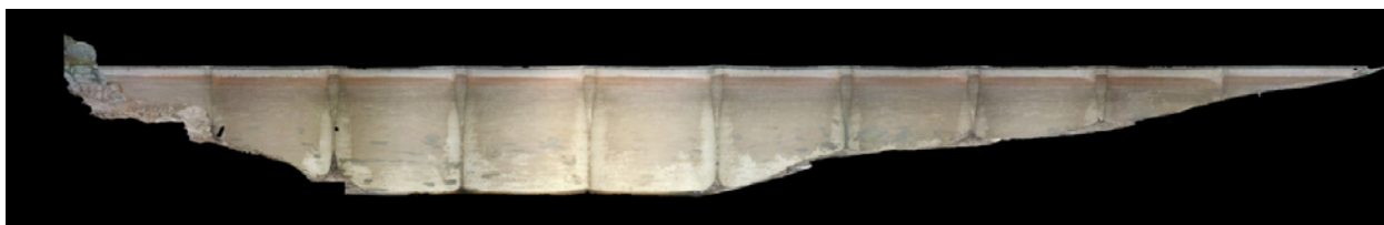
Fig. 4. Dam Nåvatn III, fotogrammetri av dammens vannside. Foto: NVE/Koordinat AS.
