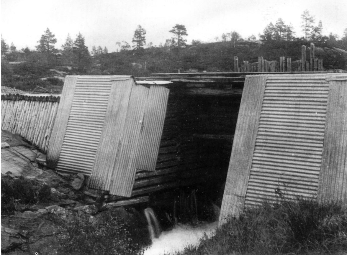
Utløpskanal til første fasen ca. 1930 (NVE)
