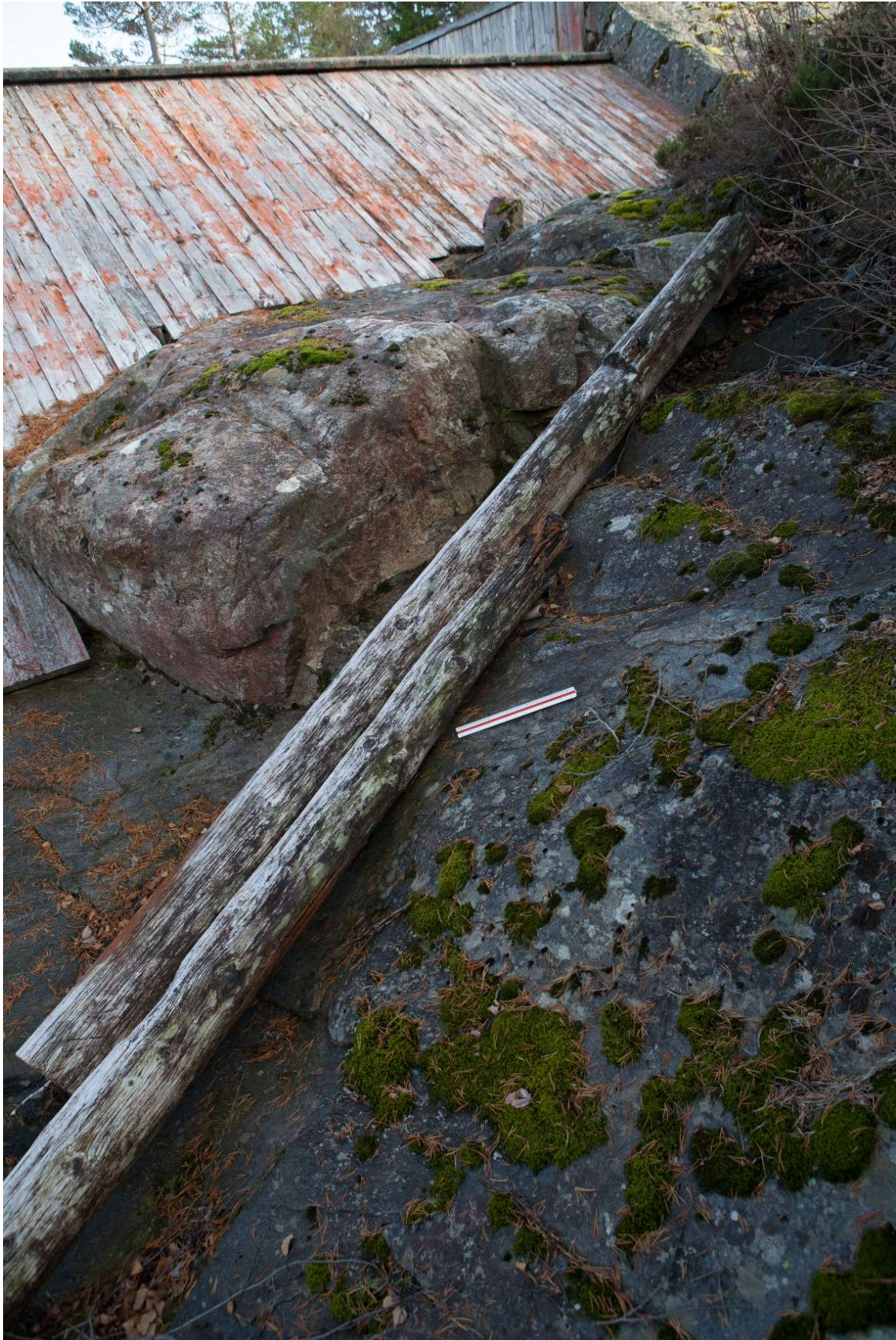
Avkappede stokker antagelig fra reparasjon i 1972-73 (Stig Storheil/NVE 2016)
