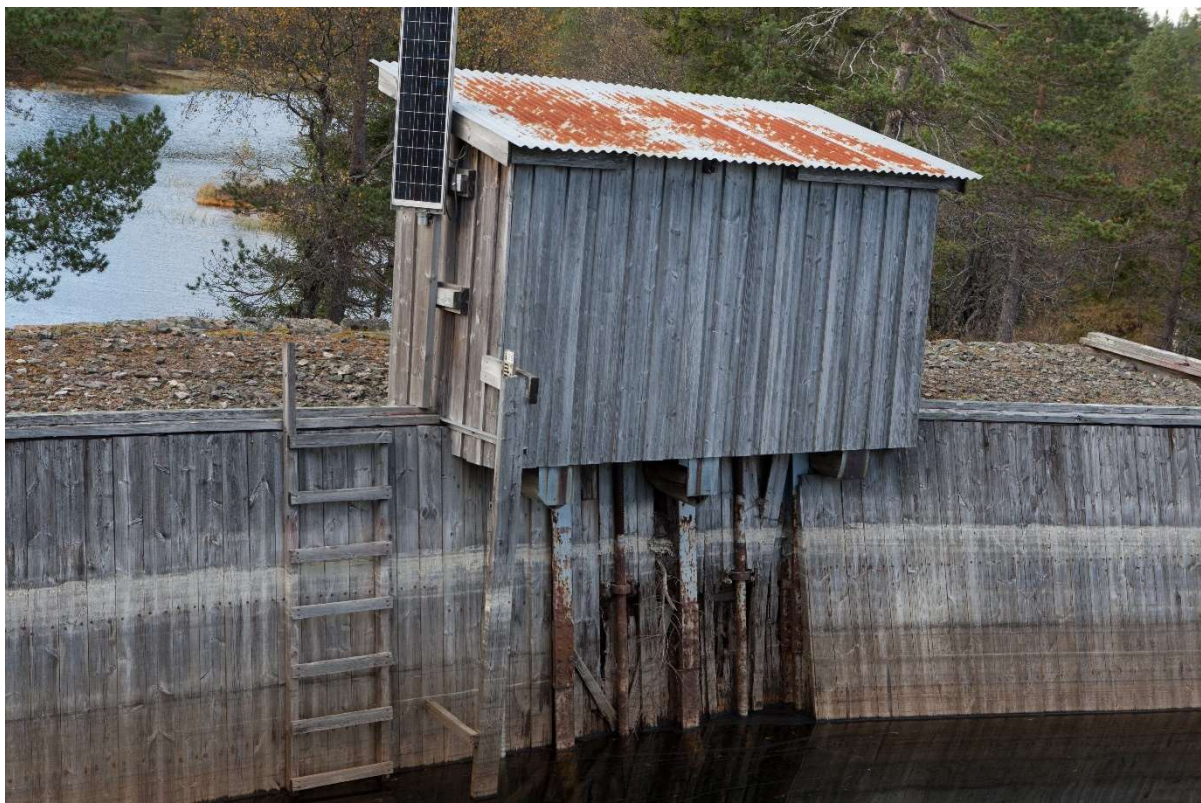
Inntak på vannsiden av Langeraksvatn dam (Stig Storheil/NVE 2016)
