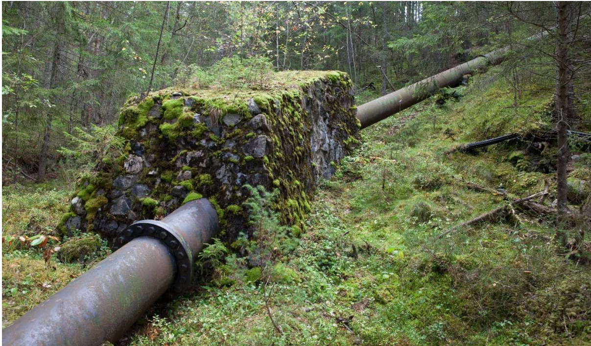
Rørgata (ovenfor) og fotogrammetri resultater av rørgata på neste side. (Stig Storheil/NVE 2016)
