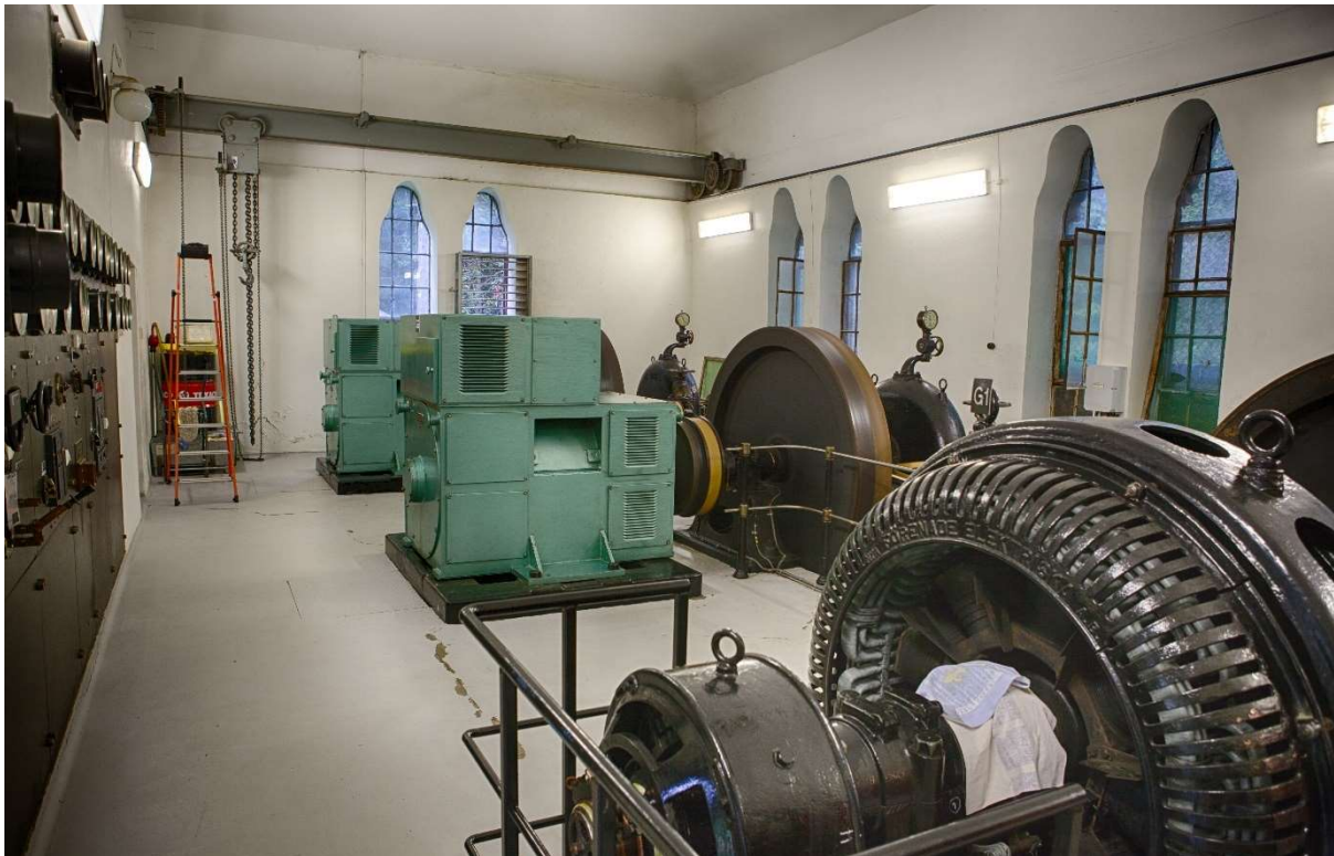
Maskinrommet og bilder av generator under utbygging (på neste side) (Stig Storheil/NVE 2016 og Conrad Holteng/NVE)
