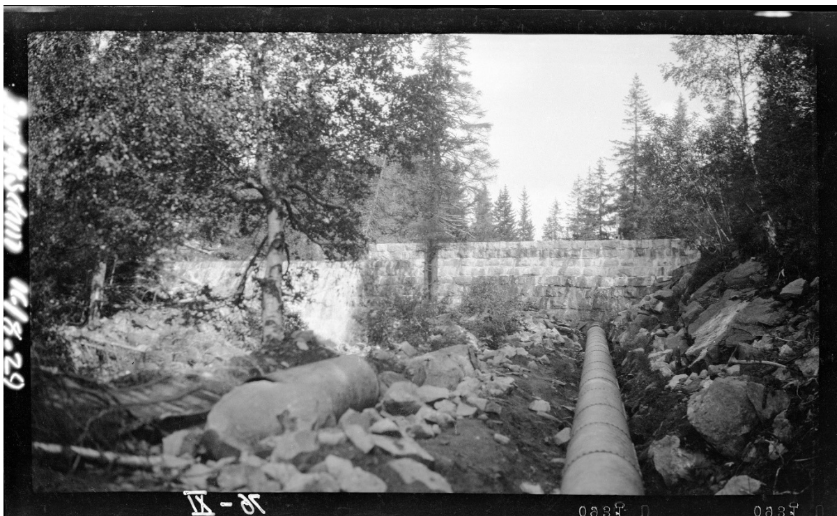
Inntaksdammen og rørgata under utbygging 1914 – 1916 (Conrad Holteng/NVE)
