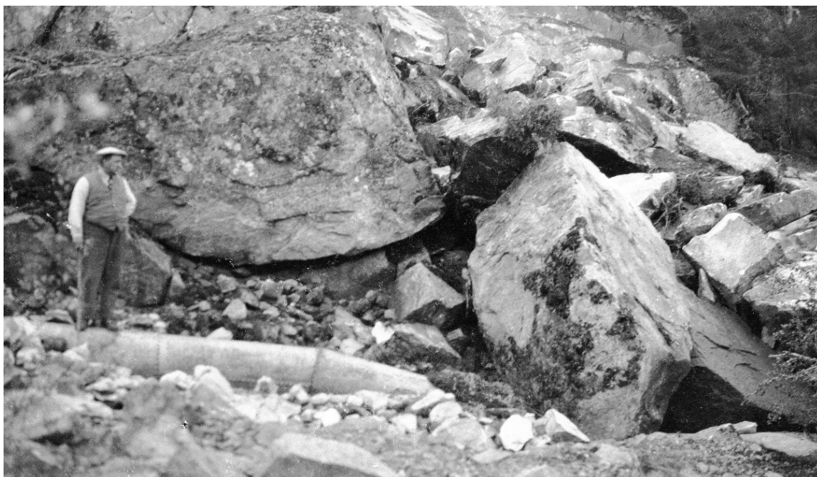
Reparasjon av brudd i rørgata ca. 1929. (Conrad Holteng/NVE)
