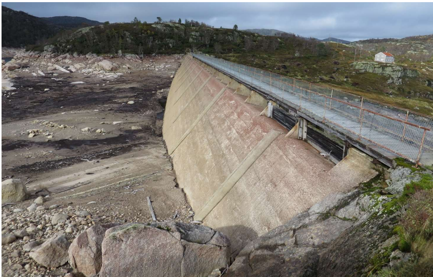
Illustrasjon 7 Nåvatn II - Platedam mellom Nåvatn I og III mot sør. Foto: Stig Storheil, 2016, NVE.
