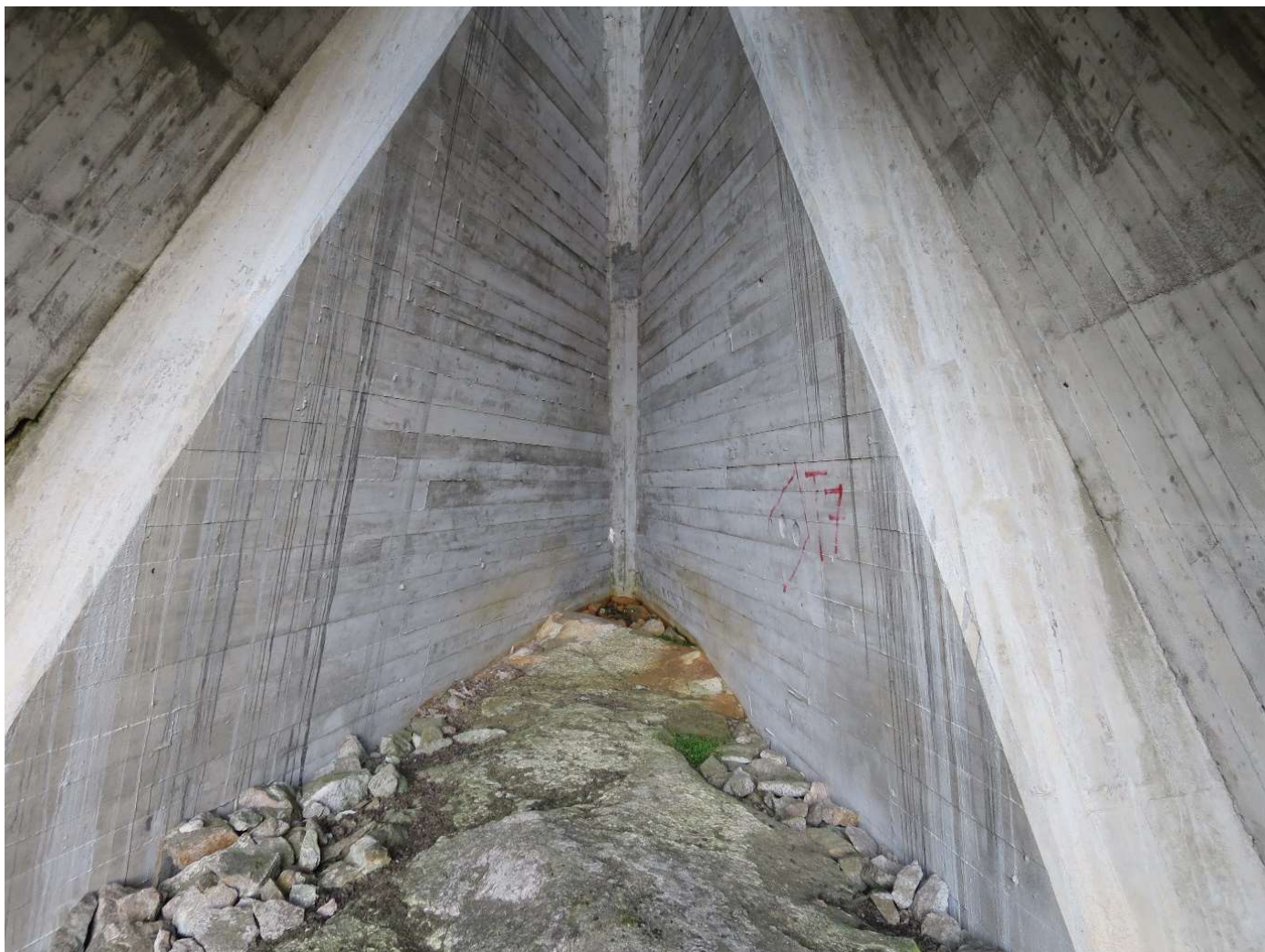
Illustrasjon 9 Detaljer av avtrykk fra forskalling på luftsiden av Nåvatn III mot vest (Stig Storheil, 2016, NVE)
