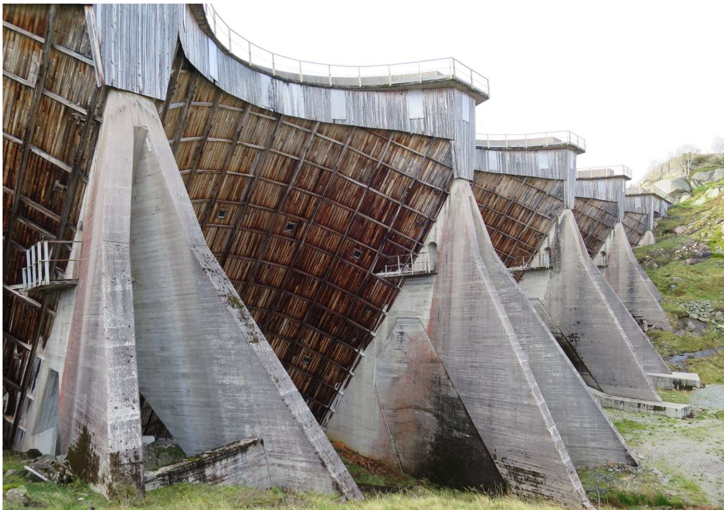
Illustrasjon 6 Flerbuer på Nåvatn III mot nord. Foto: Stig Storheil, 2016, NVE.
