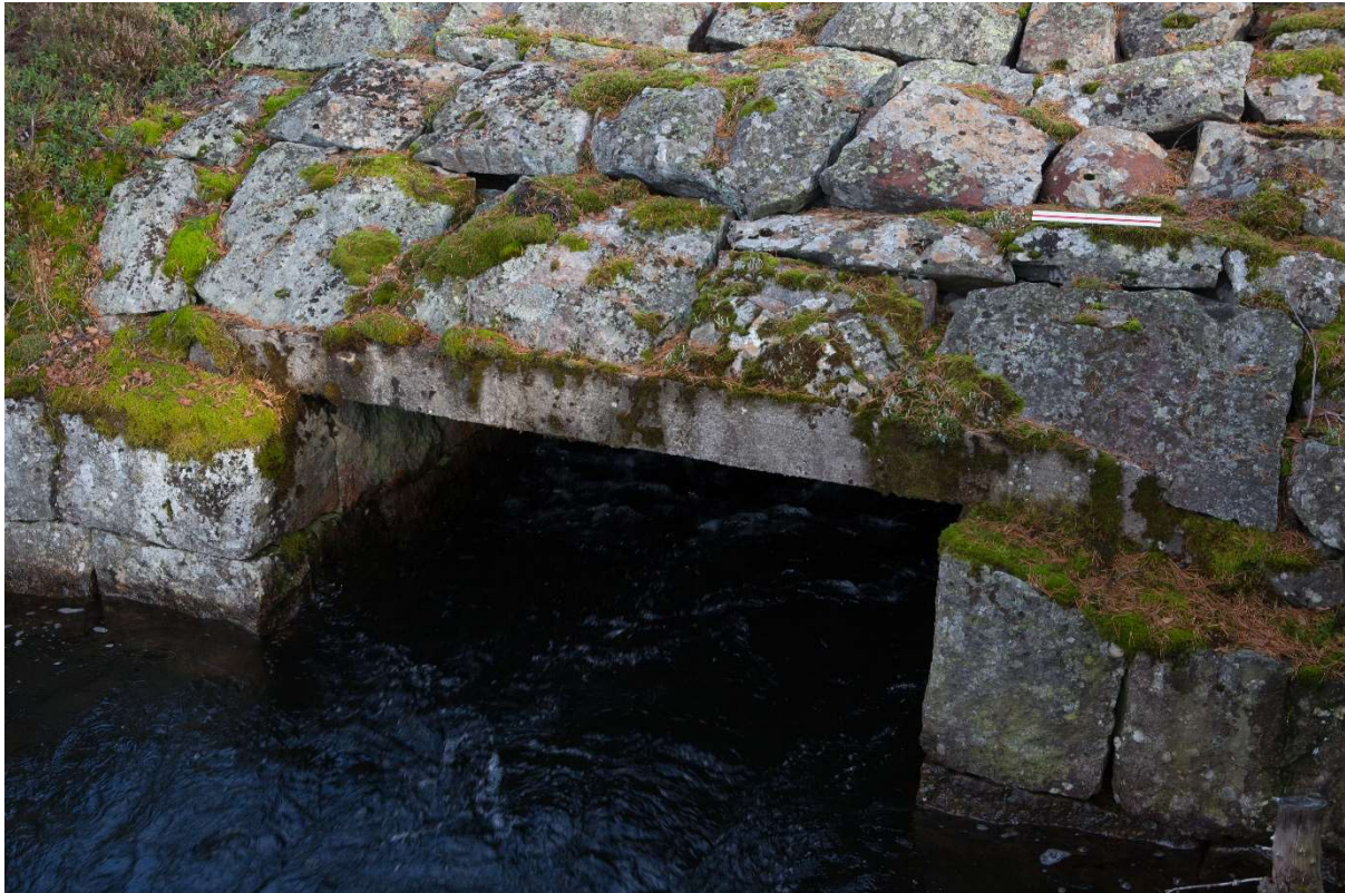
Detalj av utløpskanalen (Stig Storheil/NVE 2016)
