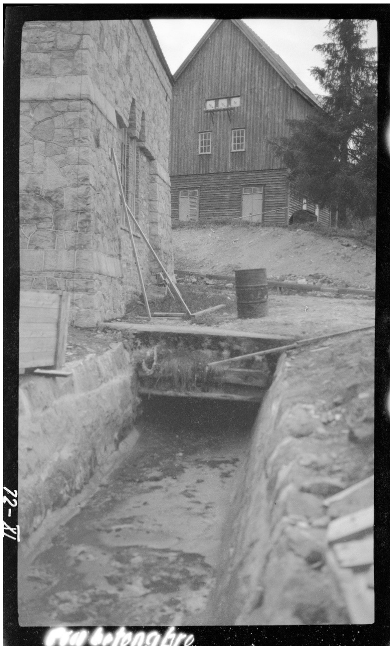
Utbygging av kanalen i 1914 -16 (Conrad Holteng NVE)
