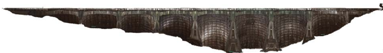
Fig. 5. Dam Nåvatn III, laserskanning av dammens luftside. Foto: NVE/Koordinat AS.
