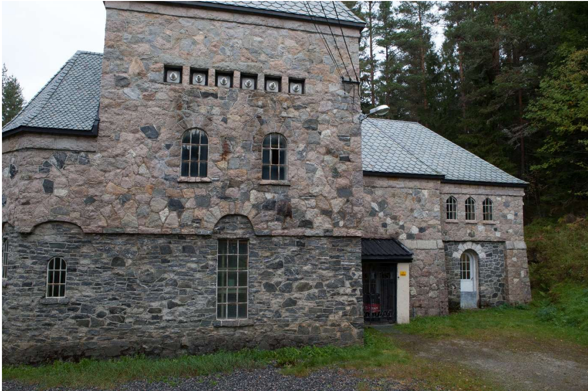
Longerak kraftstasjon (Stig Storheil/NVE 2016)
