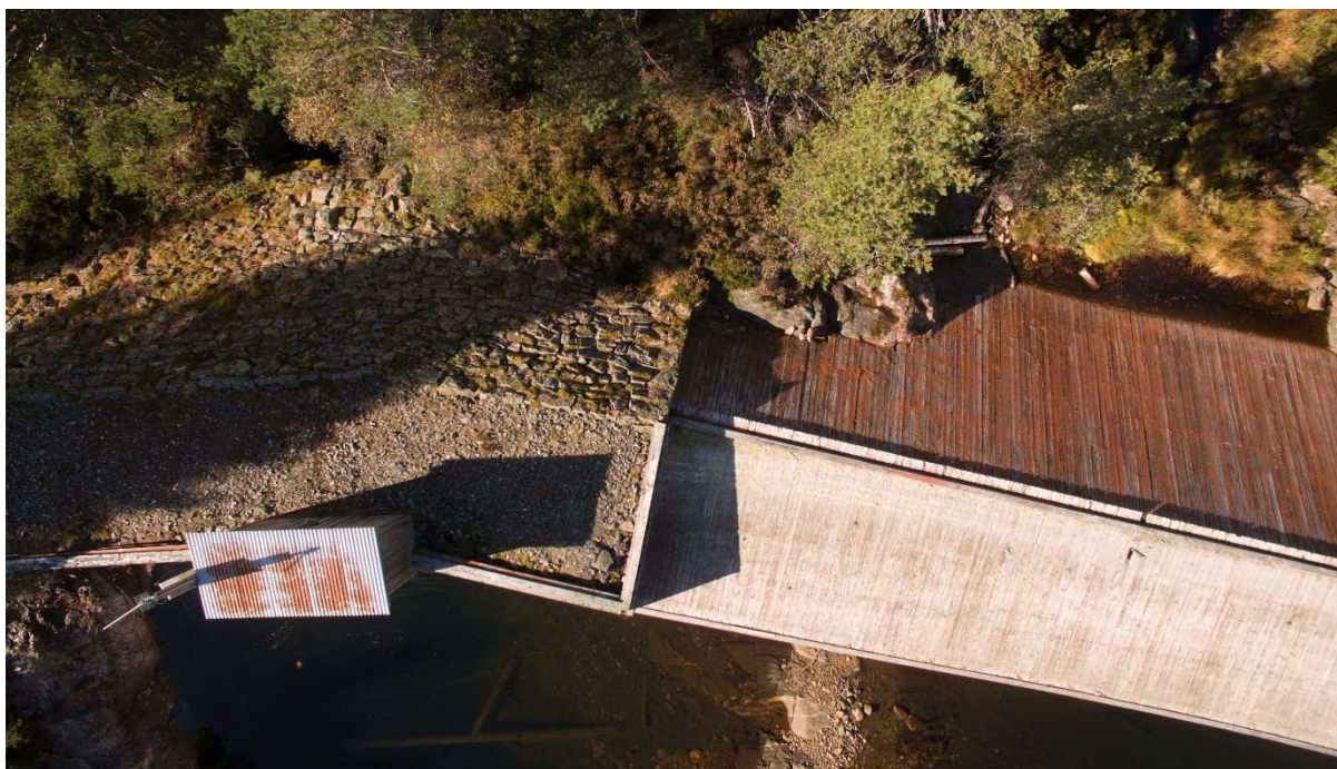
Dam oversiktsbilde (Dag Endre Oppedal/Tom Davies/NVE 2016)
