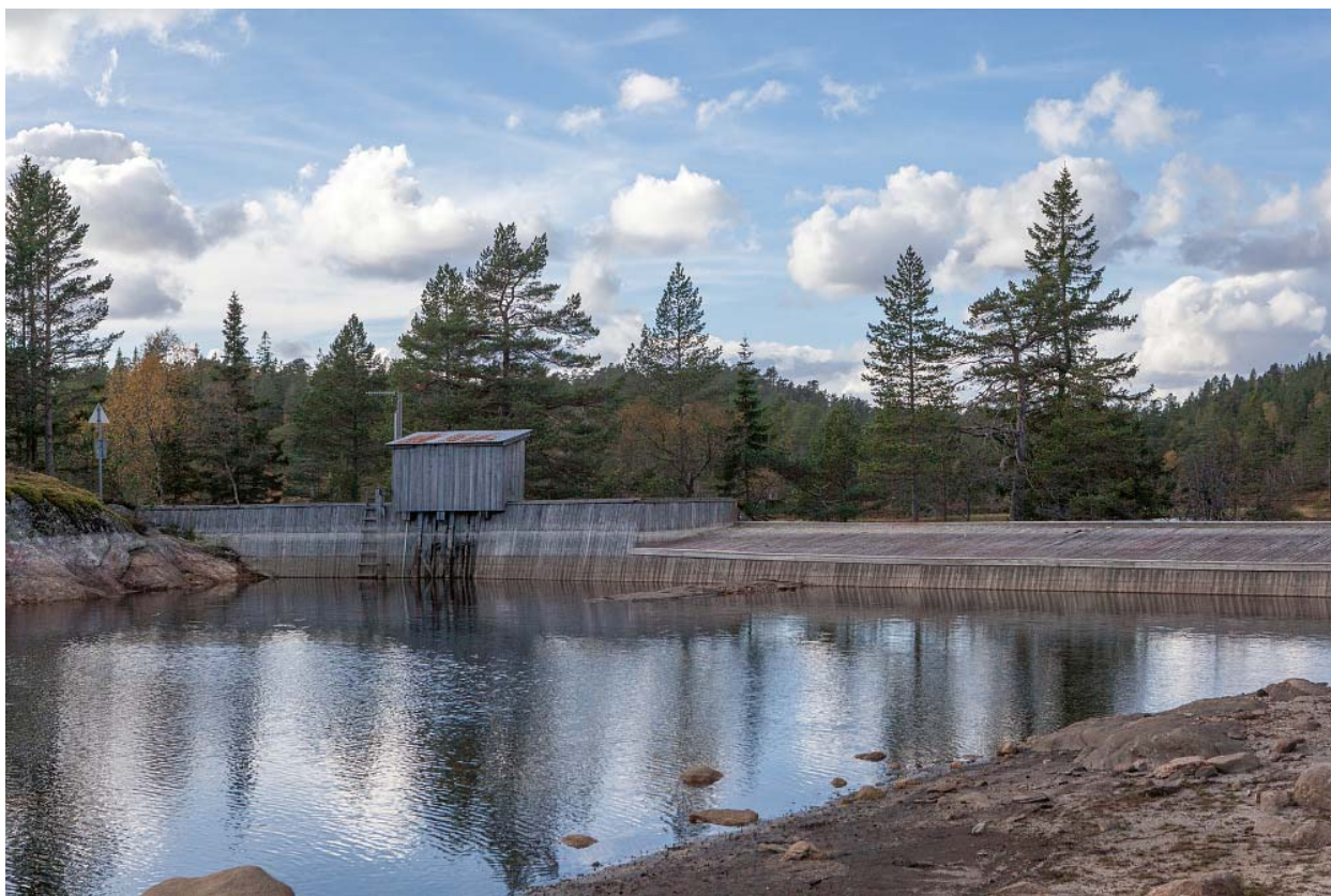
Fig 1. Langeraksvatn dam. Foto: NVE/Stig Storheil.
