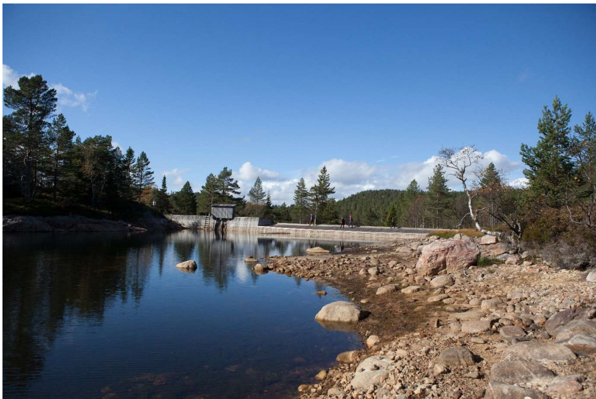
Langeraksvatn dam fra vannsiden (Stig Storheil/NVE 2016)
