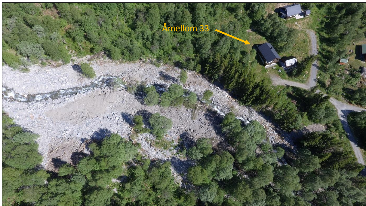
Figur 7: Dronefoto som viser skredavsetninger på øvre del av vifta ved Landlaupet. Hytta på Åmellom 33 nærmest skredavsetningene. Foto mot sørøst.
