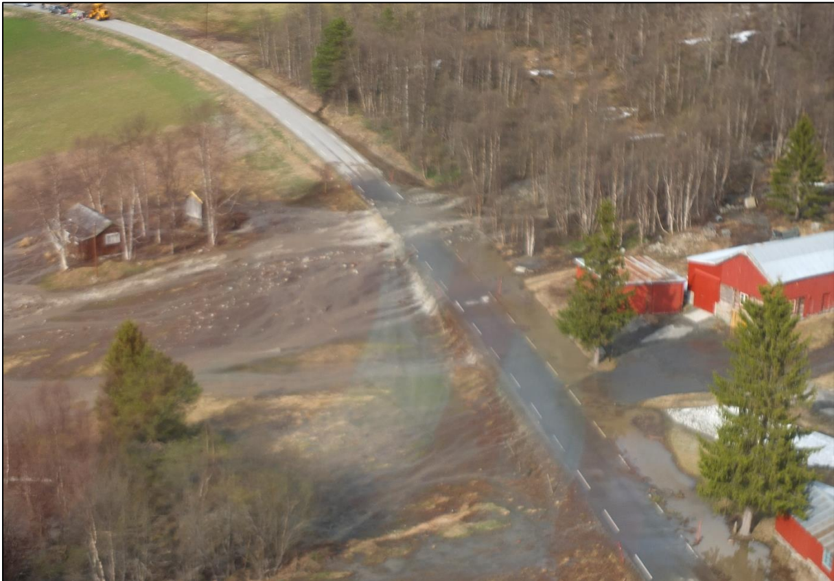
Figur 8: Storlidalsvegen og massestrømmen over denne, kort tid etter skredhendelsen. Foto: Gunne Håland, SVV. Foto mot nord.
