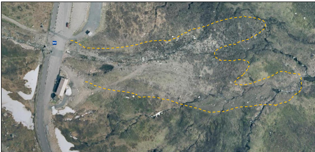
Figur 30: Flyfoto fra 2002, med spor etter nylig sørpeskred. Gul linje viser grovt estimert utløpsområde, der det er avsatt løsmasser. Fra kart.finn.no.
