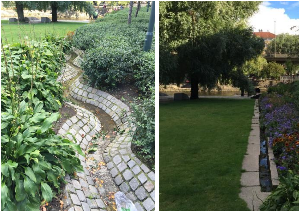
Figur 5-8. Kanaler for oppsamling av overvann i Vaterlandsparken, Oslo. Foto: Kim H. Paus/Asplan Viak. Grønne tak og grønne vegger
