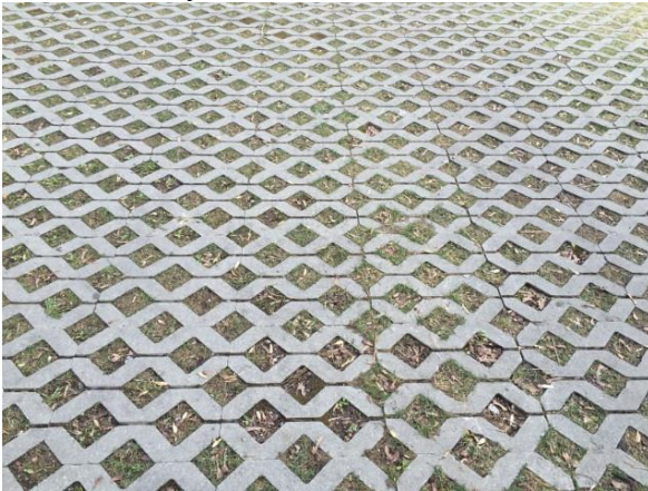
Figur 5-10. Eksempel på permeabel flate. Gressarmering i Nobels gate, Oslo. Foto: Kim H. Paus/Asplan Viak.
