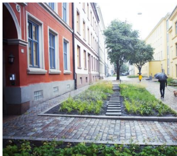
Figur 5-11. Regnbed i Deichmans gate, Oslo. Foto: Åse Holte/Asplan Viak.
