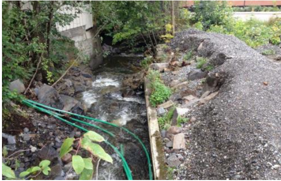
Figur 9-13. Erosjonsskader i Skurva etter flomhendelsen i juli 2014. Foto: Steinar Myrabø. (Olsen m.fl. (2015))
