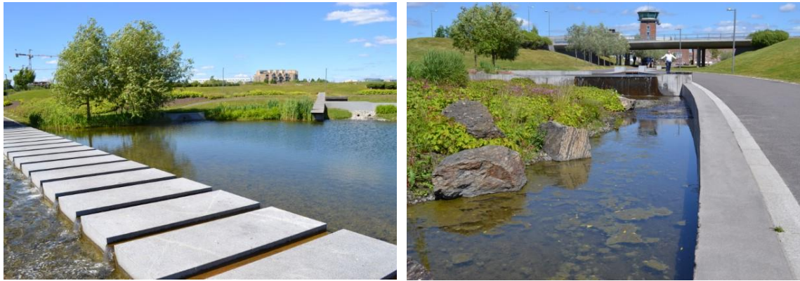
Figur 5-13. Eksempel på fordrøyning av overvann. Nansenparken, Fornebu. Foto: Kim H. Paus/Asplan Viak.
