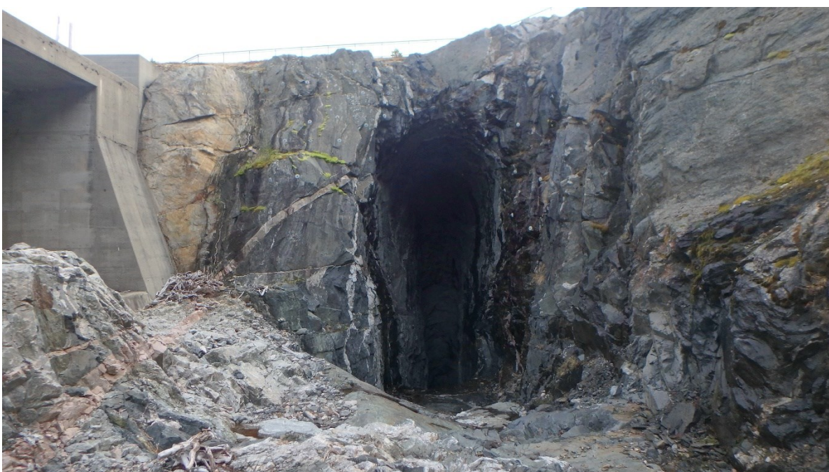
Figur 4-16: Innløp til sjakt ved Vatnedalsvatn
