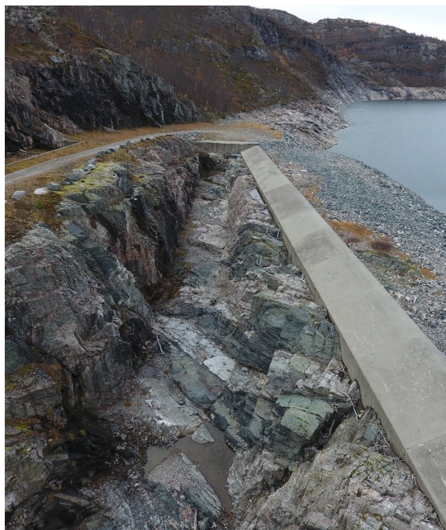
Figur 4-6. Flomløpet ved Vatnedalsvatn
