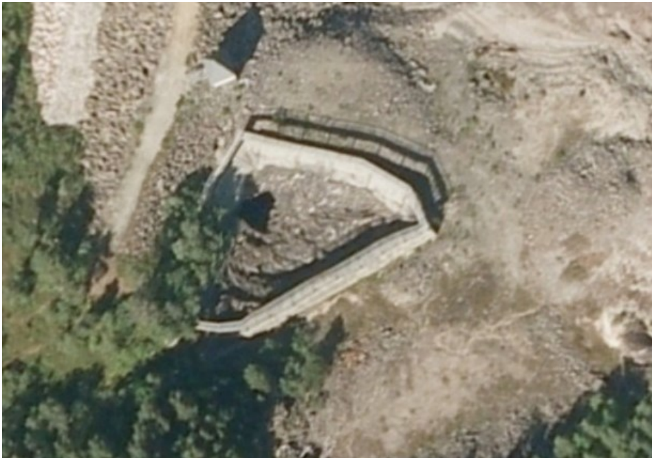
Figur 5-9. Flyfoto av flomløpet ved Vasslivatn før ombygging
