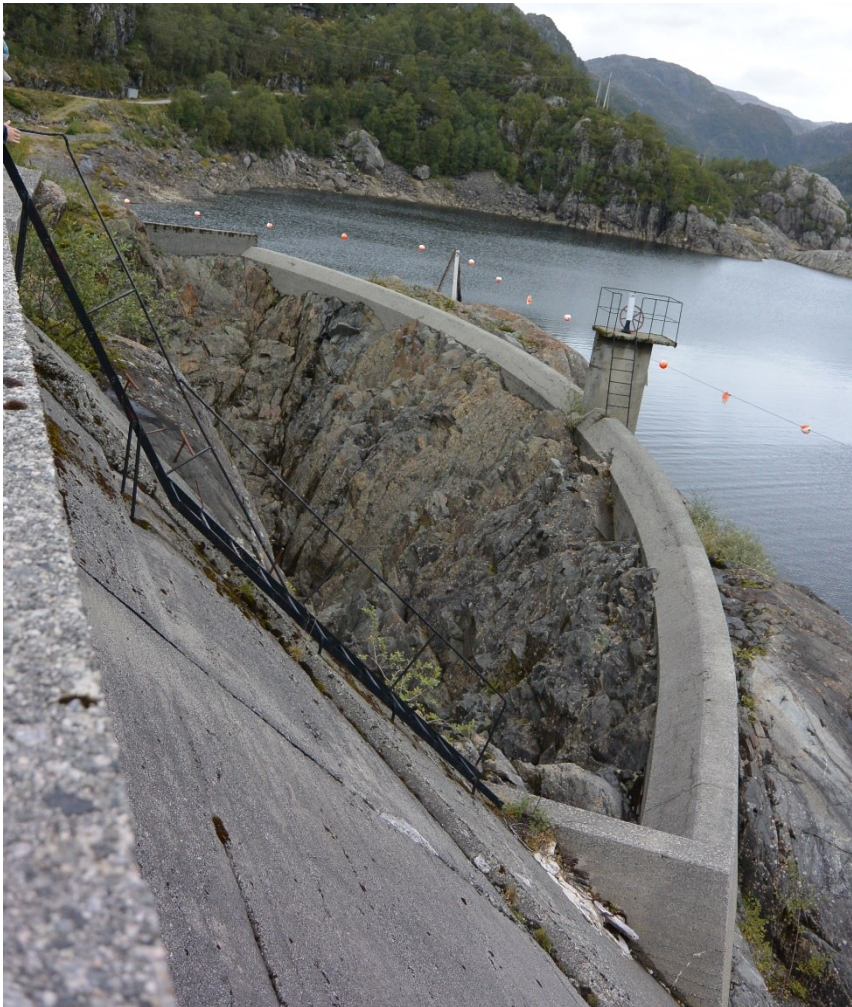
Figur 4-3: Flomløpet ved Staffivatn har en buet overløpsterskel hvor samlekanalen er formet som en trakt rett ned i tunnelen.
