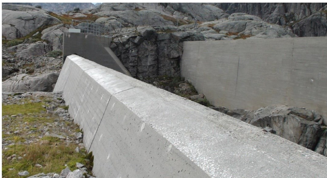
Figur 4-2: Flomløpet ved Mysevatn har en rett avrundet overløpsterskel med påstøp.
